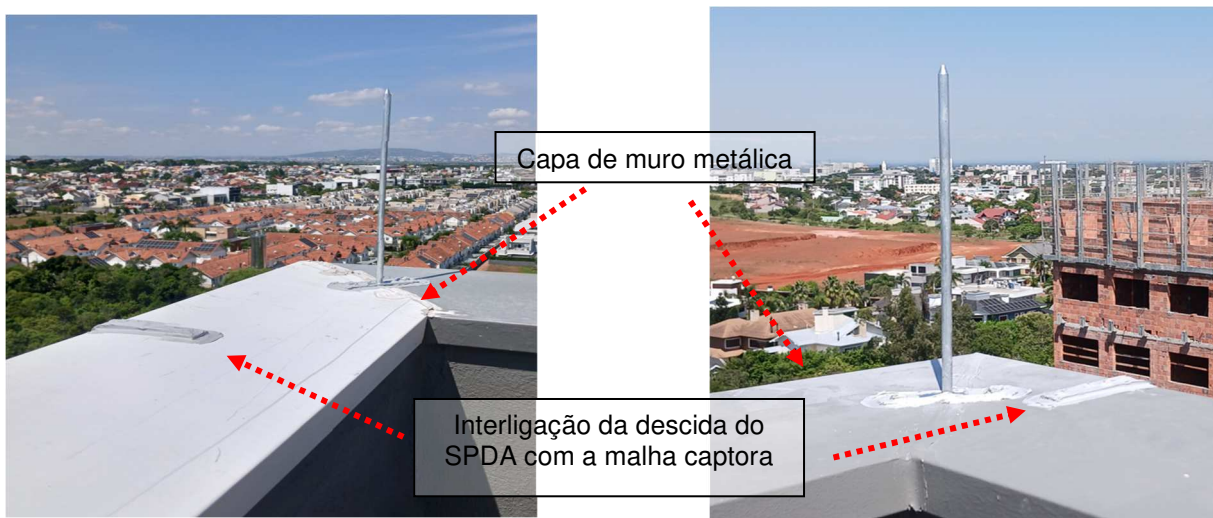
Figuras 57 e 58: Terminais aéreos 30cm instalados e interligação da descida do SPDA em cota mais baixa da cobertura com a malha captora natural (capa de muro).
