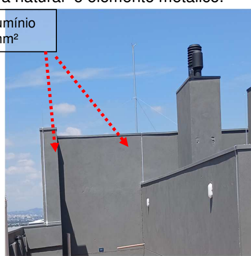
Figuras 43 e 44: Terminal aéreo 30cm instalado// Interligação executada em desnível de altura entre a malha captora natural e a convencional.
