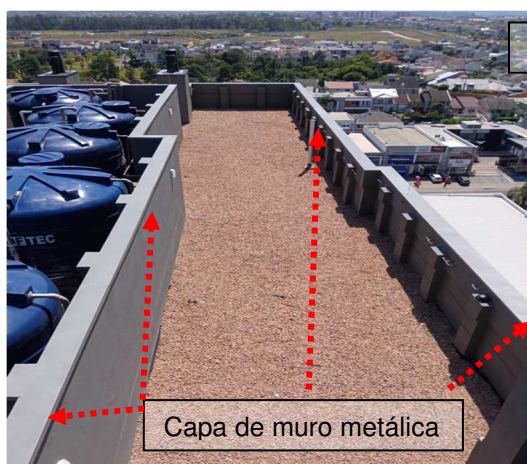
Figuras 51 e 52: Terminais aéreos 30cm instalados em cota mais baixa da cobertura sobre a malha captora natural (capa de muro).
