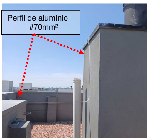
Figuras 41 e 42: Terminais aéreos 30cm instalados// Interligação executada em desnível de altura entre a malha captora natural e elemento metálico.
