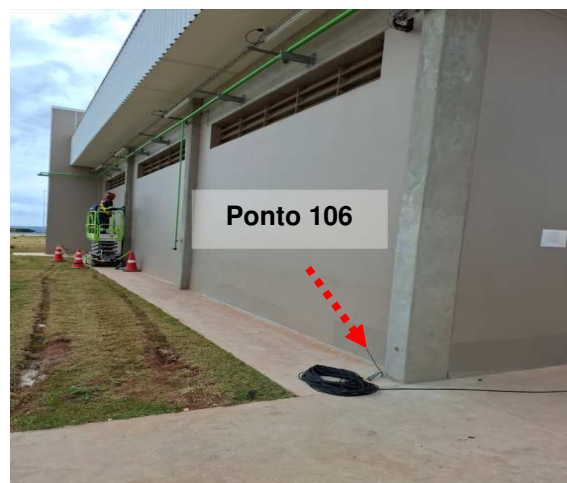
Figuras 77 e 78: Ponto 106 // Medição 105 – Descida do SPDA – Prédio U
