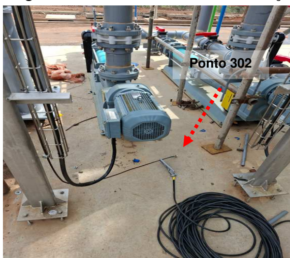
Figuras 199 e 200: Ponto 302 // Medição 298 – Aterramento via pipe-rack de motor-PTAR
