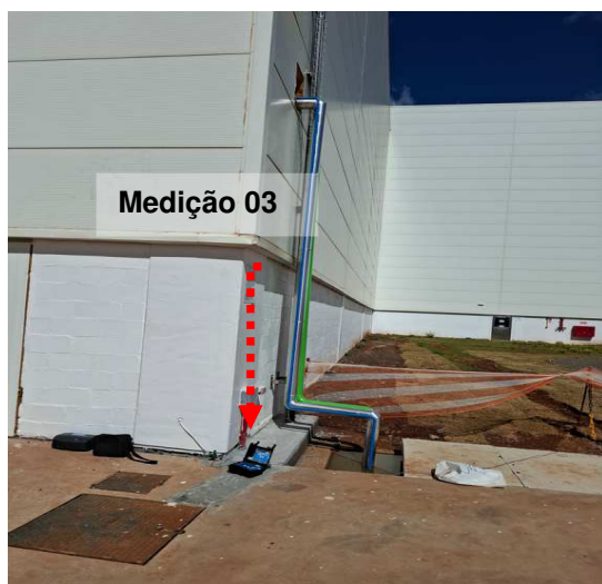
Figuras 262 e 263: Local (descida do SPDA) e Sentido da medição 03 – ÁREA C.
