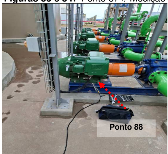
Figuras 55 e 56: Ponto 88 / Medição 87 - Aterramento via pipe-rack motor bomba d'água.
