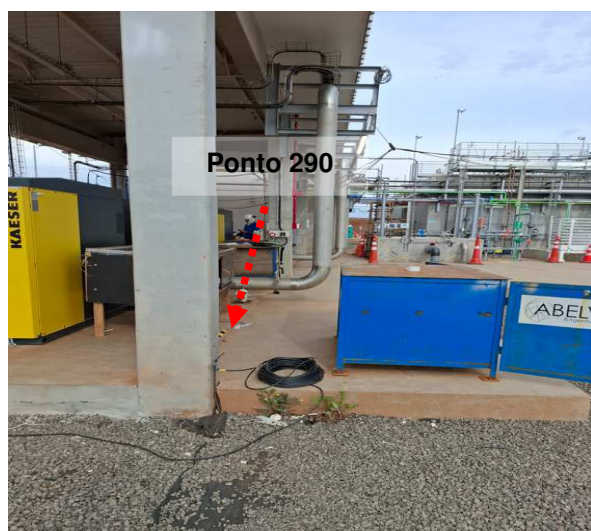
Figuras 189 e 190: Ponto 290 // Medição 285 – Descida do SPDA – PTAR.
