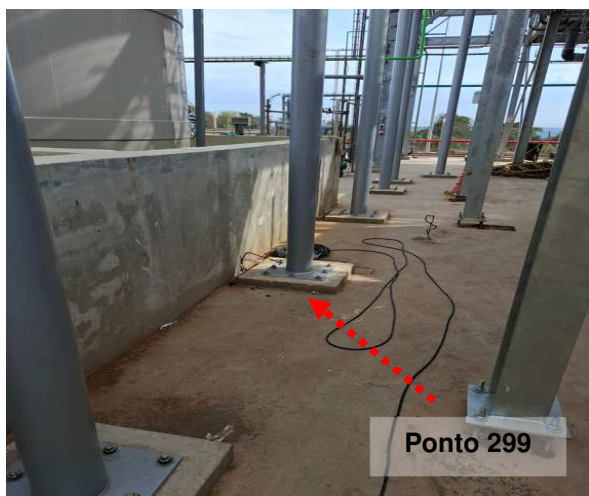
Figuras 195 e 196: Ponto 298 / Medição 299 - Ponto aterramento estrutura metálica - PTAR
