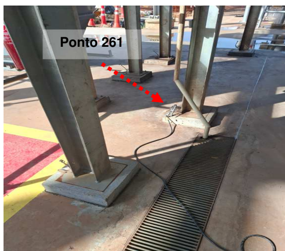
Figuras 171 e 172: Ponto 261 / Medição 258 – Ponto aterramento pilar Pipe rack Área P.
