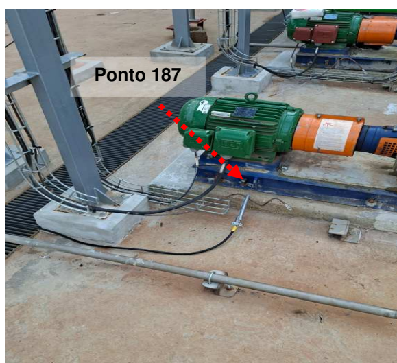
Figuras 139 e 140: Ponto 187 // Medição 184 – Aterramento via pipe-rack motor - Área P
