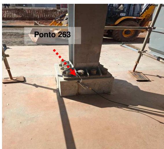
Figuras 173 e 174: Ponto 263 / Medição 260 – Ponto aterramento pilar Pipe rack Área P.
