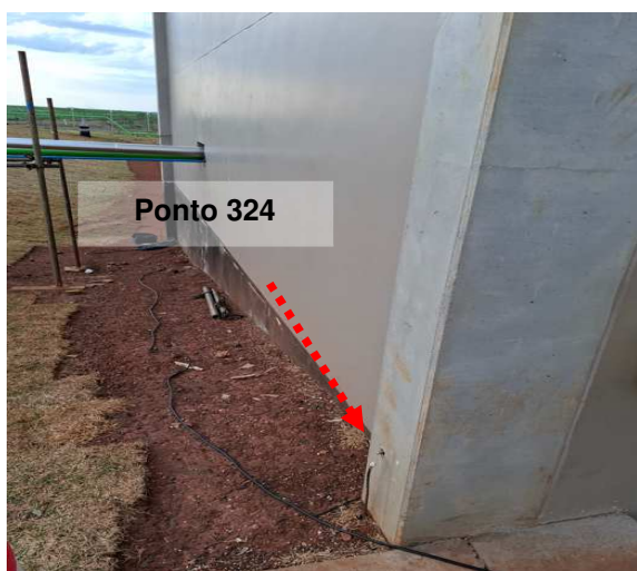
Figuras 223 e 224: Ponto 324 // Medição 318 – Descida do SPDA – Prédio S
