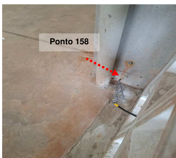
Figuras 115 e 116: Ponto 158 // Medição 156 – Descida do SPDA – Área E
