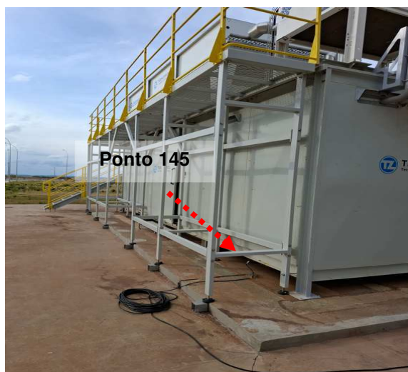
Figuras 103 e 104: Ponto 145 // Medição 144 – Aterramento estrutura – Área leste.
