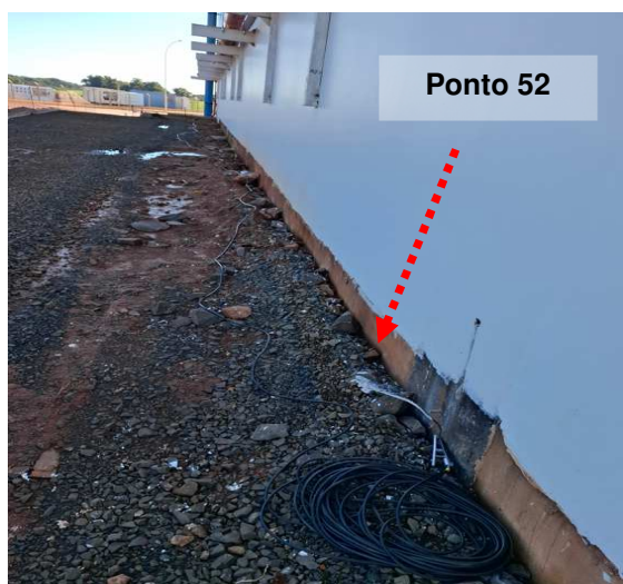
Figuras 27 e 28: Ponto 52 // Medição 52 – Descida do SPDA – Produto acabado
