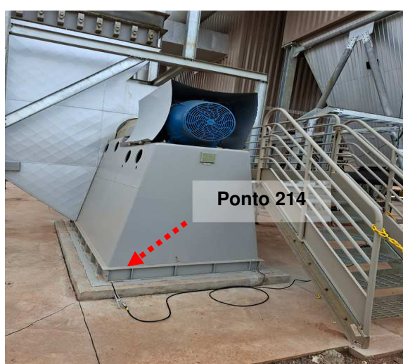
Figuras 151 e 152: Ponto 214 / Medição 211 – Ponto aterramento - Exaustor – Área P.
