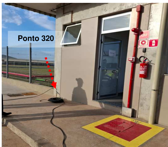
Figuras 219 e 220: Ponto 320 // Medição 315- Descida do SPDA – Portaria H
