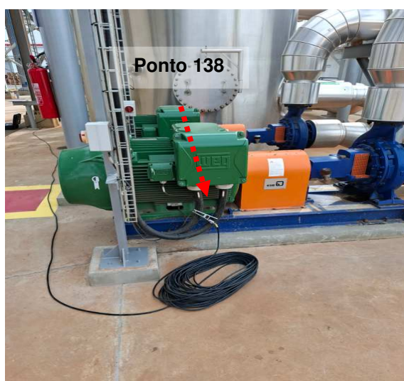
Figuras 97 e 98: Ponto 138 // Medição 137 – Aterramento via pipe-rack motor área leste.
