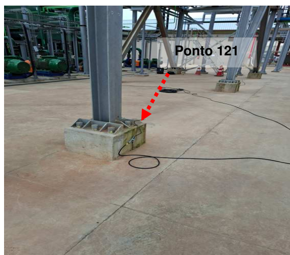
Figuras 89 e 90: Ponto 121 /Medição 120 –Ponto aterramento pilar metálico Pipe rack.
