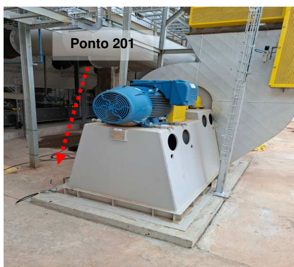
Figuras 145 e 146: Ponto 201/ Medição 198 Ponto aterramento ventilador diluição Área P.
