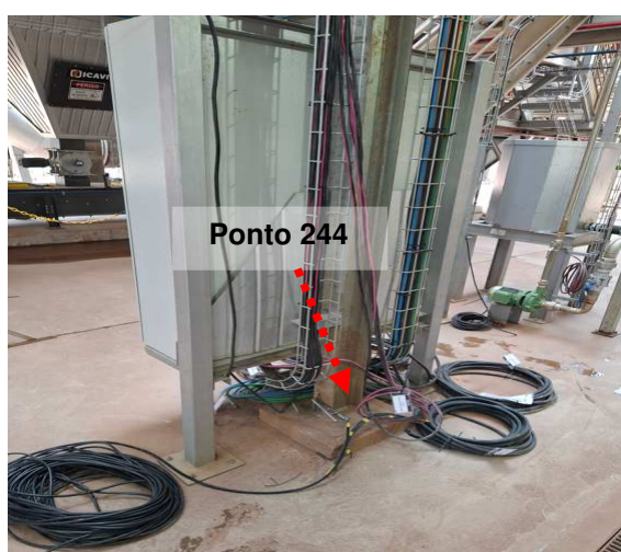
Figuras 167 e 168: Ponto 244 / Medição 241 – Ponto aterramento pilar Pipe rack Área P.
