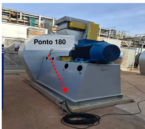
Figuras 133 e 134: Ponto 180 // Medição 180 – Aterramento estrutura metálica – Área N
