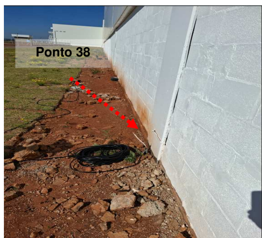
Figuras 17 e 18: Ponto 38 // Medição 38 – Descida do SPDA – Produto acabado
