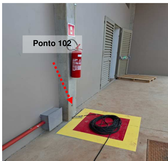
Figuras 71 e 72: Ponto 102 // Medição 101 – Descida do SPDA – Prédio U
