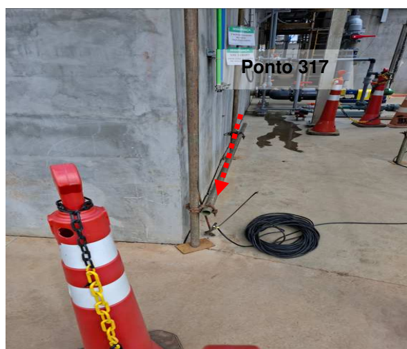
Figuras 215 e 216: Ponto 317 // Medição 313 – Espera da descida do SPDA – PTAR
