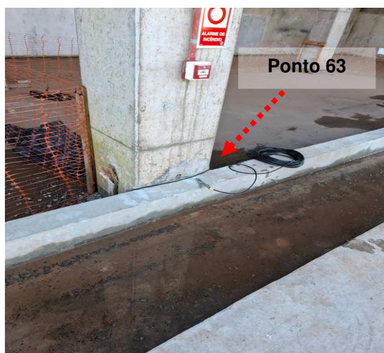
Figuras 33 e 34: Ponto 63 // Medição 63 – Descida do SPDA – Produção
