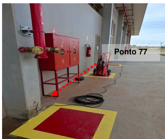
Figuras 41 e 42: Ponto 77 // Medição 76 – Descida do SPDA – Prédio M
