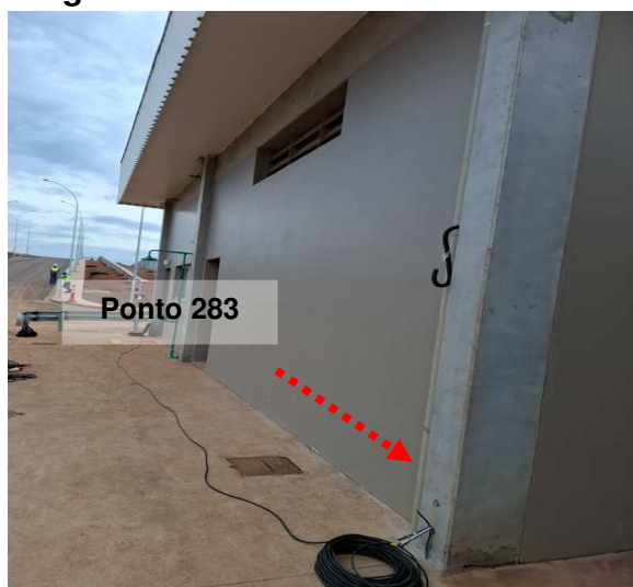
Figuras 181 e 182: Ponto 283 // Medição 278 – Descida do SPDA – PTAR.
