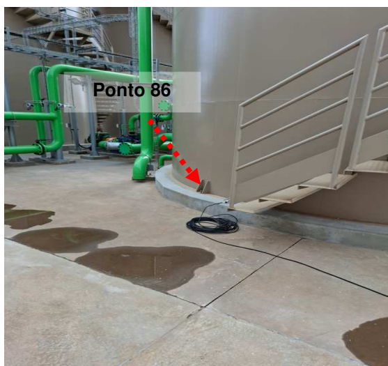
Figuras 51 e 52: Ponto 86 // Medição 85 – Aterramento estrutura caixa d'água potável.
