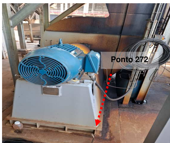
Figuras 177 e 178: Ponto 272 // Medição 268 – Descida do SPDA – Área P, Ventilador.
