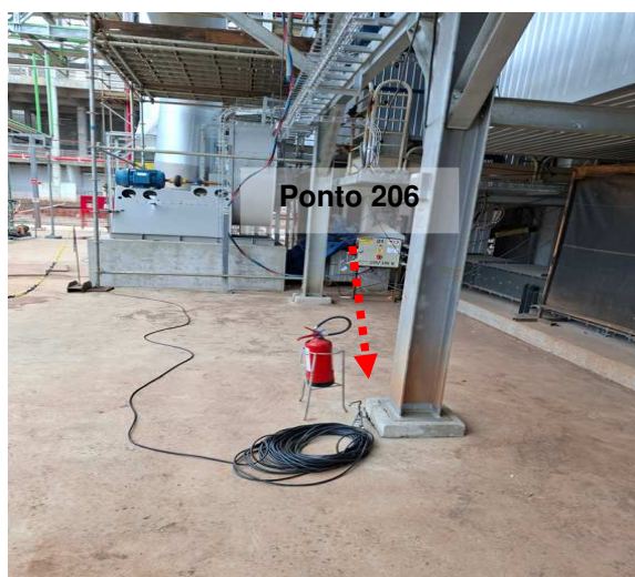
Figuras 147 e 148: Ponto 206 / Medição 203 – Ponto aterramento pilar Pipe rack Área P.
