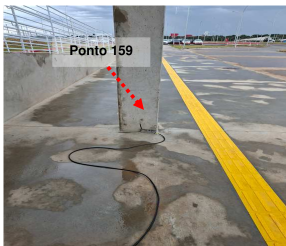
Figuras 117 e 118: Ponto 161 // Medição 159 – Descida do SPDA – Área Z
