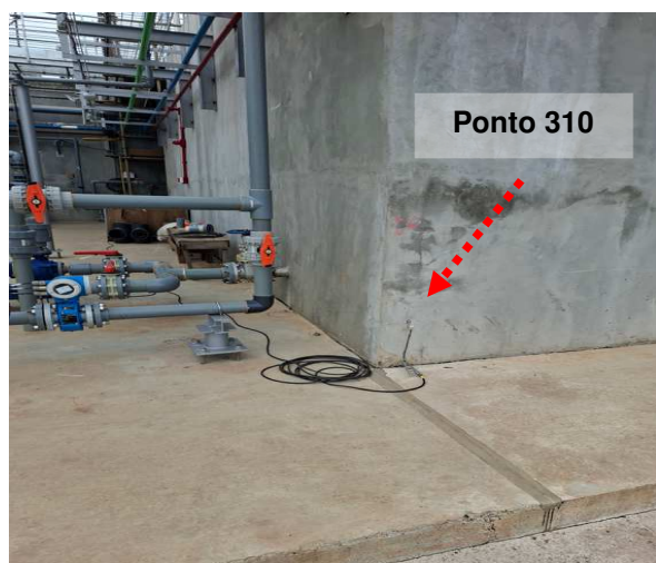
Figuras 207 e 208: Ponto 310 // Medição 306 – Espera da descida do SPDA – PTAR
