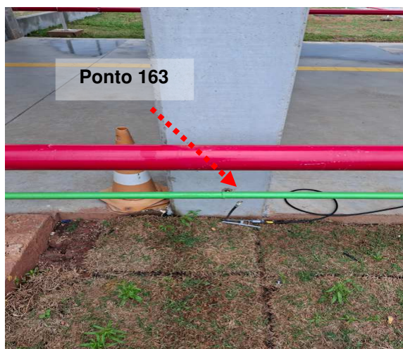
Figuras 119 e 120: Ponto 163 // Medição 161 – Descida do SPDA – Área Z
