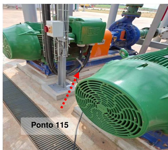
Figuras 85 e 86: Ponto 115 // Medição 114 – Aterramento via pipe-rack de motor.
