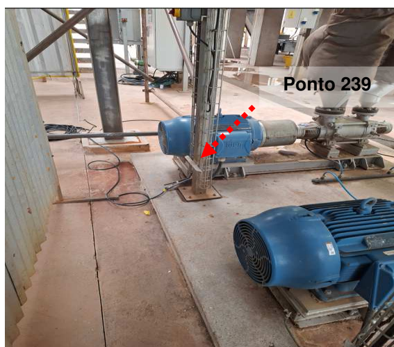
Figuras 165 e 166: Ponto 239 / Medição 236 / Aterramento de motor via Pipe rack - Área P
