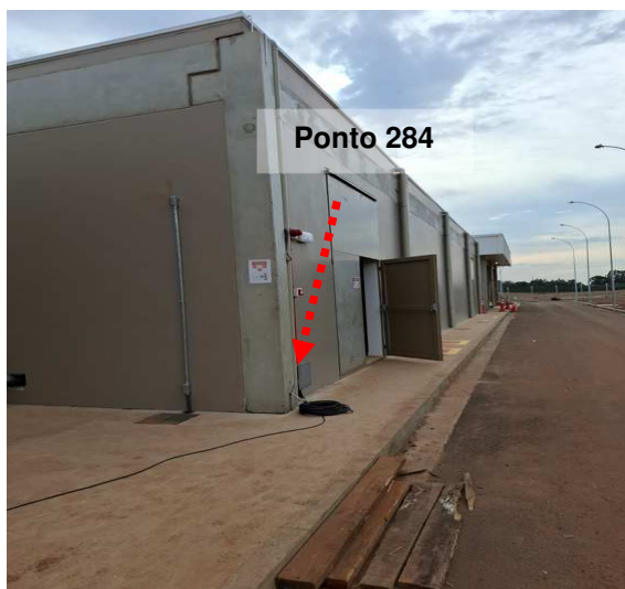
Figuras 183 e 184: Ponto 284 // Medição 279 – Descida do SPDA – PTAR.
