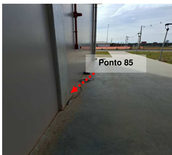
Figuras 49 e 50: Ponto 85 // Medição 84 – Descida do SPDA – Prédio M
