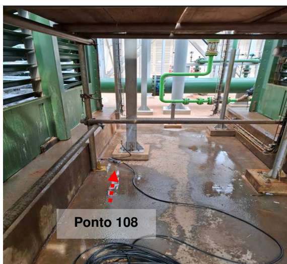
Figuras 81 e 82: Ponto 108 / Medição 107- Aterramento estrutura -Torre de resfriamento
