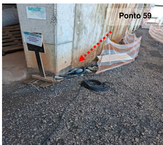
Figuras 31 e 32: Ponto 59 // Medição 59 – Descida do SPDA – Produção
