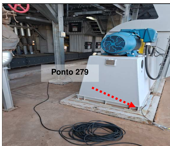
Figuras 179 e 180: Ponto 279 // Medição 275 – Descida do SPDA – Área P, Ventilador.
