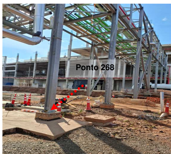
Figuras 175 e 176: Ponto 268 // Medição 265 -Ponto aterramento pilar Pipe rack Área P
