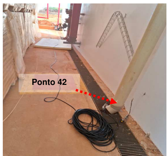
Figuras 19 e 20: Ponto 42 // Medição 42 – Descida do SPDA – Produto acabado
