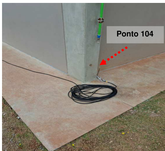
Figuras 75 e 76: Ponto 104 // Medição 103 – Descida do SPDA – Prédio U
