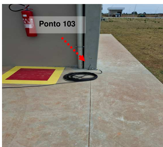
Figuras 73 e 74: Ponto 103 // Medição 102 – Descida do SPDA – Prédio U
