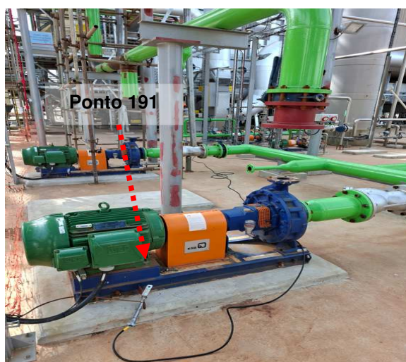
Figuras 141 e 142: Ponto 191 // Medição 188 – Aterramento via pipe-rack motor - Área P
