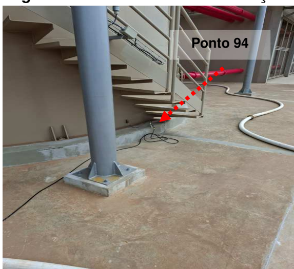
Figuras 61 e 62: Ponto 94 // Medição 93 – Aterramento tanque - Caixa d'água potável.
