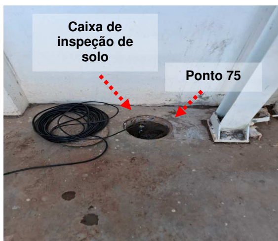
Figuras 39 e 40: Ponto 75 // Medição 75 – Descida do SPDA – Matéria prima
