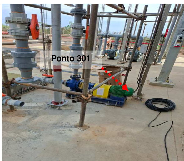
Figuras 197 e 198: Ponto 301 // Medição 297 – Aterramento via pipe-rack de motor-PTAR.
