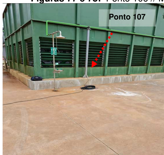
Figuras 79 e 80: Ponto 107/Medição 106 /Aterramento estrutura -Torre de resfriamento
