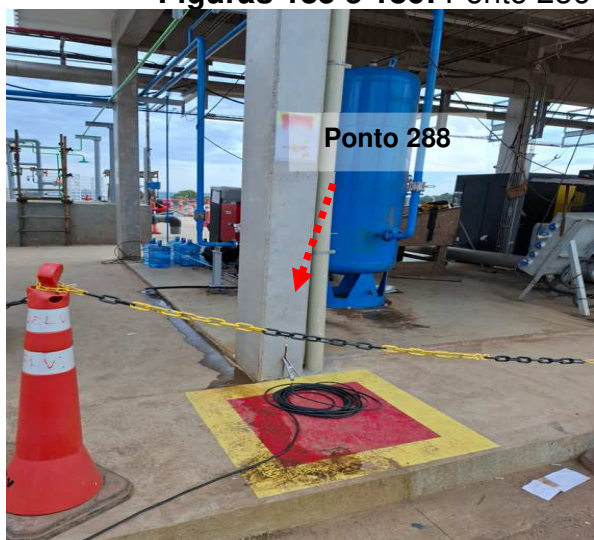
Figuras 187 e 188: Ponto 288 // Medição 283 – Descida do SPDA – PTAR.
