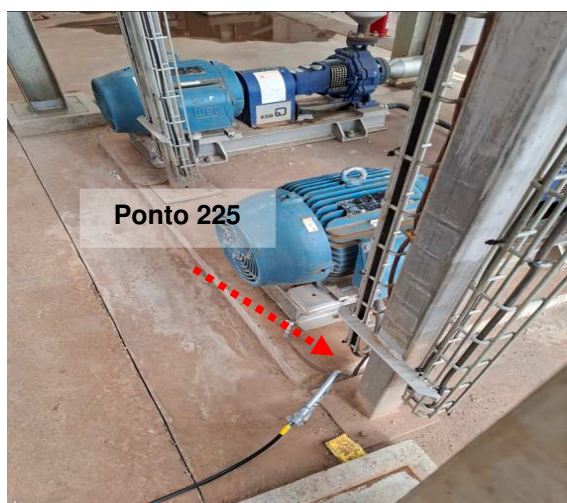
Figuras 159 e 160: Ponto 225 / Medição 222 – Aterramento via pipe rack motor – Área P.
