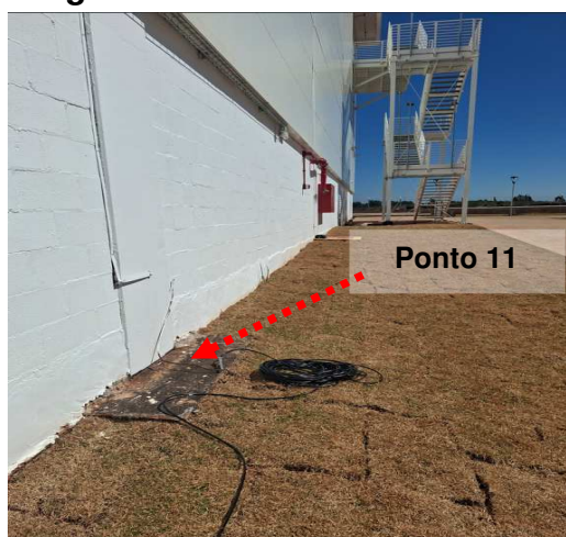
Figuras 07 e 08: Ponto 11 // Medição 11 – Descida do SPDA – Matéria prima
