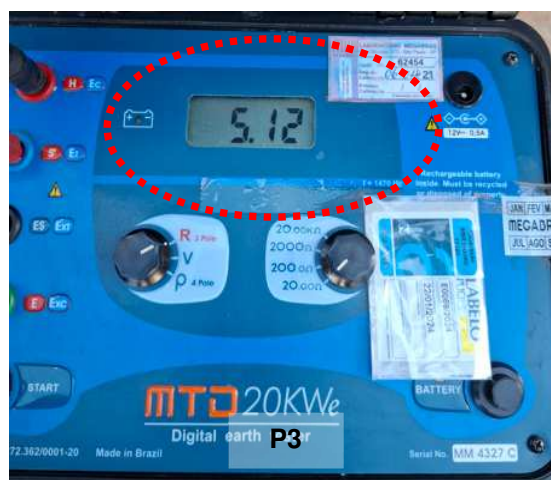
Figuras 306: Valores das medições em (P3) – PRÉDIO P.
