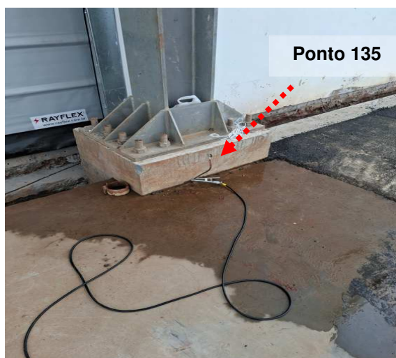
Figuras 95 e 96: Ponto 135 // Medição 134 - Ponto aterramento pilar metálico Pipe rack.
