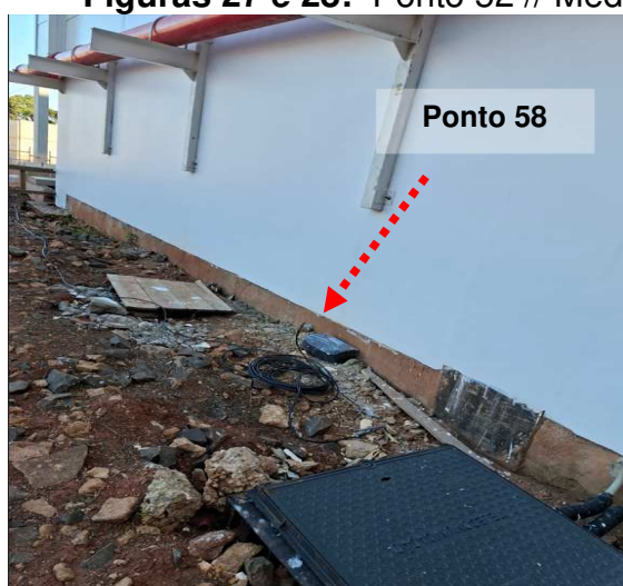
Figuras 29 e 30: Ponto 58 // Medição 58 – Descida do SPDA – Produto acabado
