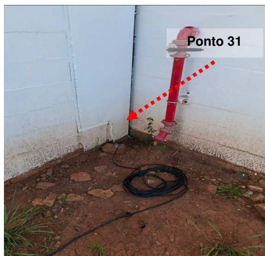
Figuras 15 e 16: Ponto 31 // Medição 31 – Descida do SPDA – Produção
