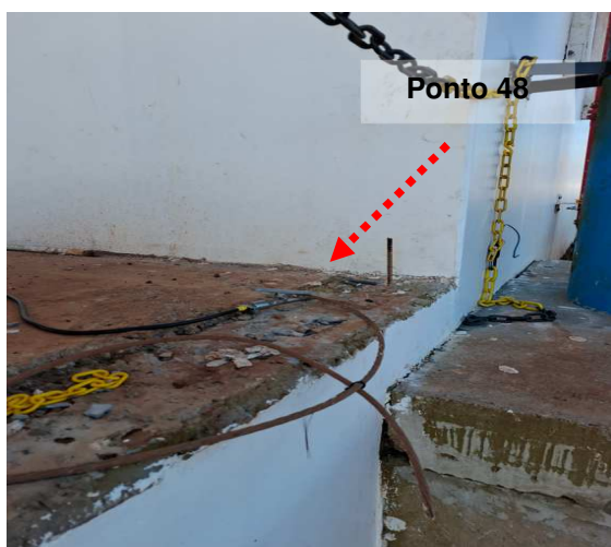
Figuras 23 e 24: Ponto 48 // Medição 48 – Descida do SPDA – Produto acabado
