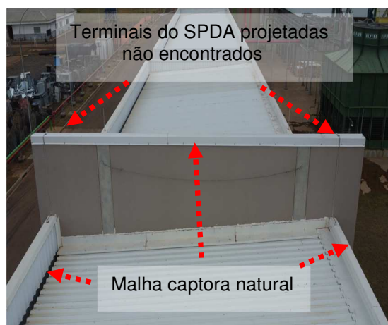
Figuras 167 e 168: Terminais aéreos projetados do SPDA não encontradas.
