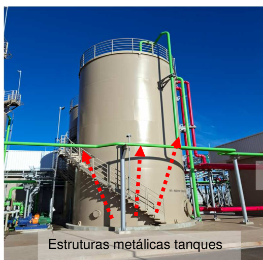
Figuras 399 e 400: Sistema captor e descidas naturais.
