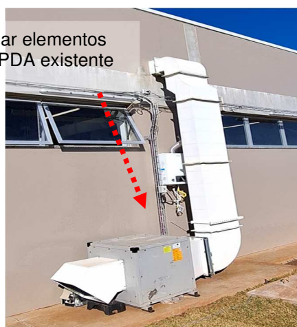
Figuras 136 e 137: Aterrar/interligar elementos metálicos ao SPDA ao existente.
