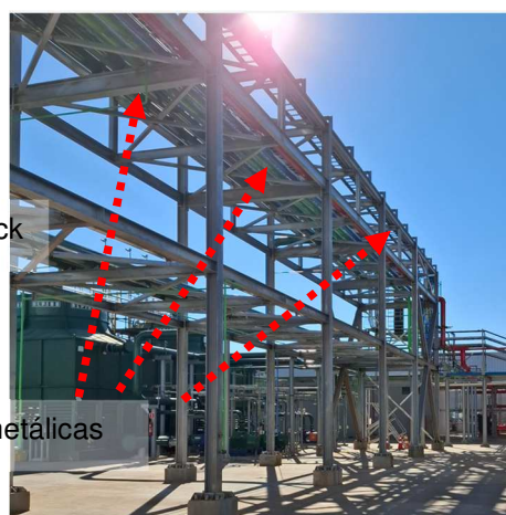
Figuras 403 e 404: Sistema captor e descidas naturais.
