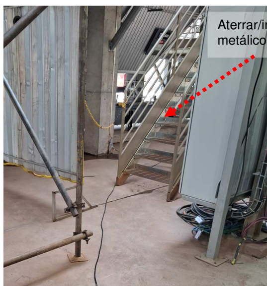
Figuras 300 e 301: Aterrar/interligar estrutura metálica ao SPDA existente.
