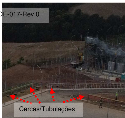
Figuras 528 e 529: Cercas – Tubulações não em planta (Incorporar ao SPDA).
