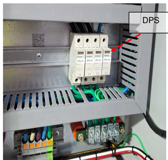
Figuras 548 e 549: DPS instalado em painel elétrico da Caldeira-Biomassa - Prédio P.
