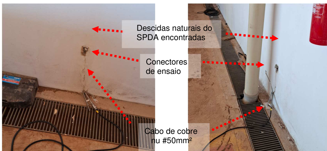
Figuras 31 e 32: Descidas do SPDA encontradas nesta inspeção visual.
