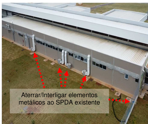
Figuras 142 e 143: Aterrar/interligar elementos metálicos ao SPDA ao existente.
