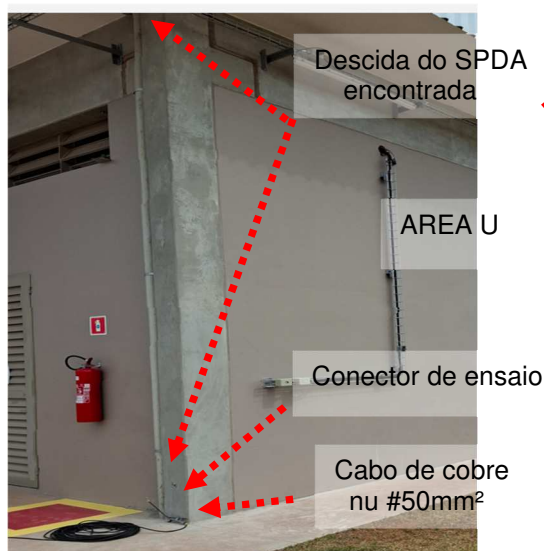
Figuras 173 e 174: Descida do SPDA instalada no prédio de Inflamáveis/Químicos.
