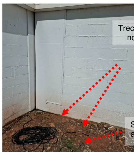
Figuras 63 e 64: Trechos da malha de aterramento exposta no piso.
