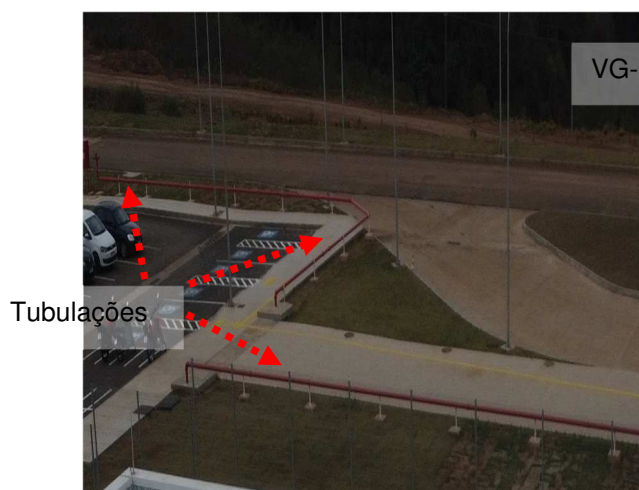
Figuras 532 e 533: Cercas – Tubulações não constante em planta (Incorporar ao SPDA).
