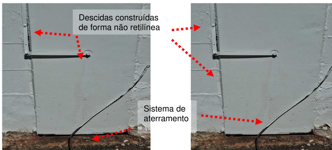
Figuras 50 e 51: Derivações das descidas do construídos de forma não retilínea.
