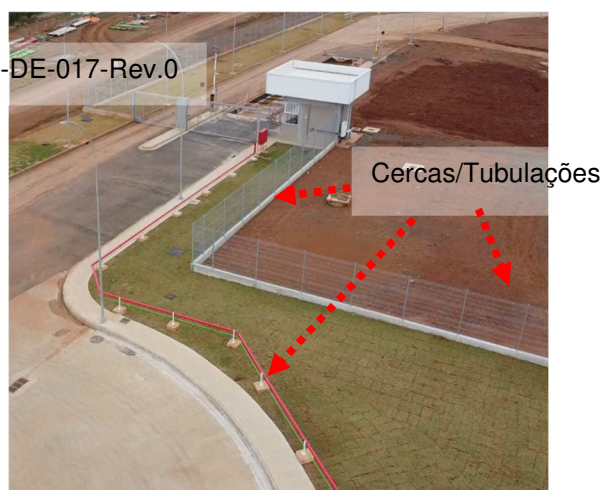
Figuras 532 e 533: Cercas – Tubulações não constante em planta (Incorporar ao SPDA).
