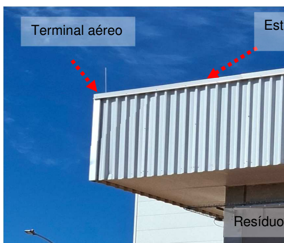
Figuras 348 e 349: Sistema captor natural / Terminais aéreos.
