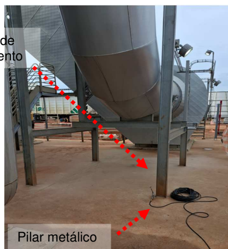
Figuras 280 e 281: Pontos de aterramento encontrados não constantes em planta.
