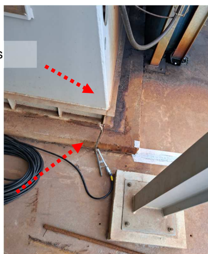
Figuras 284 e 285: Pontos de aterramento encontrados não constantes em planta.
