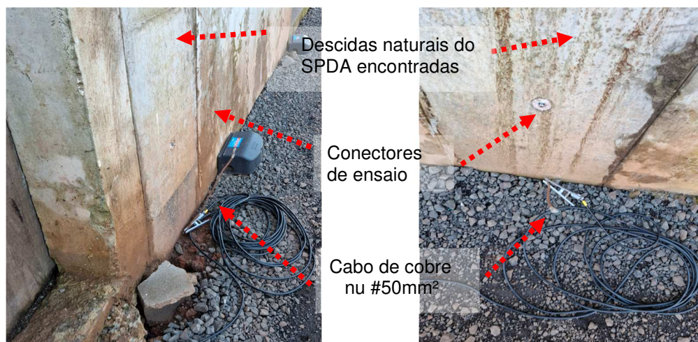
Figuras 39 e 40: Descidas do SPDA encontradas nesta inspeção visual.
