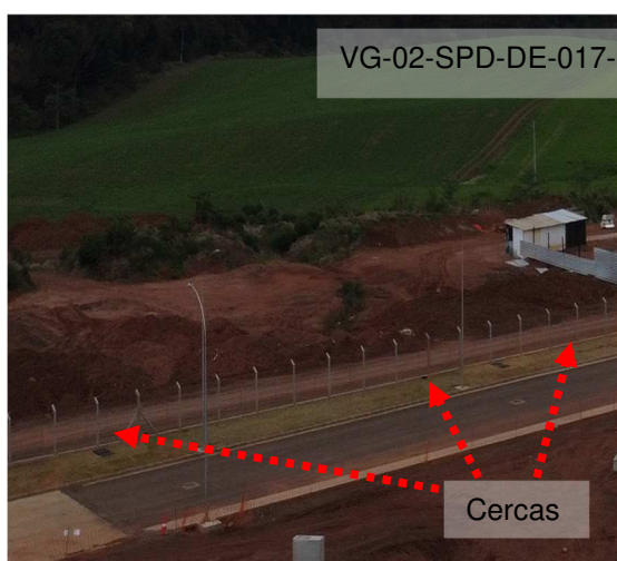
Figuras 524 e 525: Cercas – Tubulações não constante em planta (Incorporar ao SPDA).
