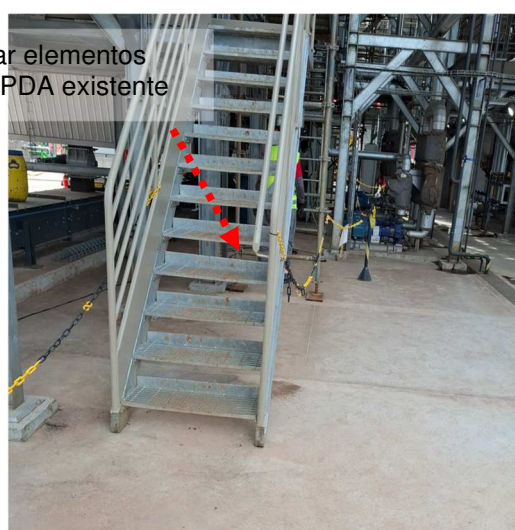
Figuras 298 e 299: Aterrar/interligar as estruturas metálicas ao SPDA existente.
