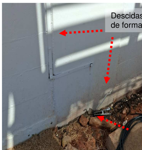
Figuras 54 e 55: Derivações das descidas do construídos de forma não retilínea.
