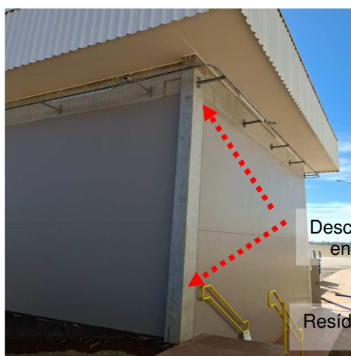
Figuras 350 e 351: Descida do SPDA projetada encontrada nesta inspeção.
