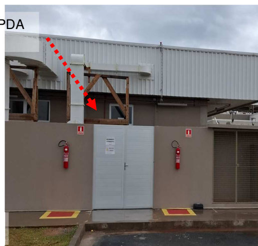
Figuras 102 e 103: 02 (duas) descidas do SPDA projetadas não encontradas.
