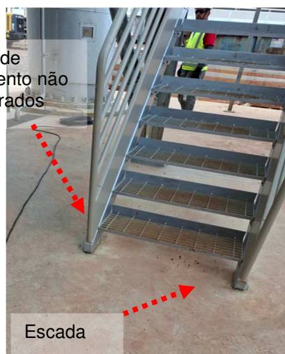
Figuras 286 e 287: Pontos de aterramento constantes em planta não encontrados.
