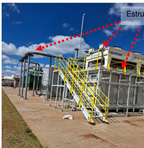
Figuras 413 e 414: Sistema captor e descidas naturais.
