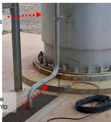
Figuras 282 e 283: Pontos de aterramento encontrados não constantes em planta.
