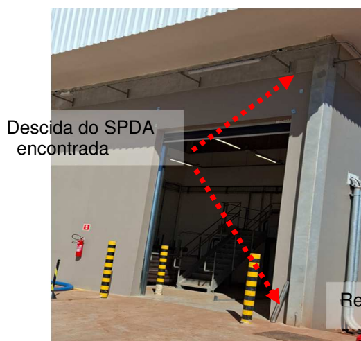
Figuras 354 e 355: Descida do SPDA projetada encontrada nesta inspeção.
