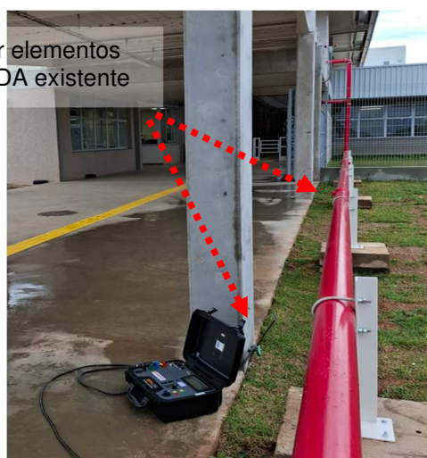
Figuras 134 e 135: Aterrar/interligar elementos metálicos ao SPDA existente.
