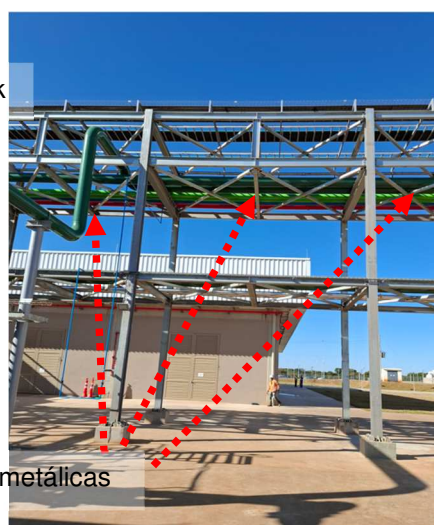
Figuras 405 e 406: Sistema captor e descidas naturais.
