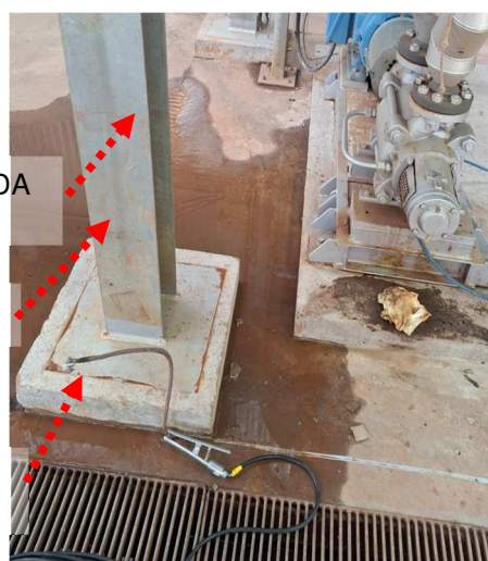
Figuras 274 e 275: Descidas naturais do SPDA encontradas nesta inspeção.
