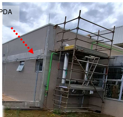
Figuras 104 e 105: 02 (duas) descidas do SPDA projetadas não encontradas.
