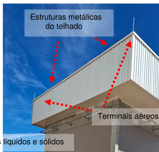
Figuras 346 e 347: Sistema captor natural / Terminais aéreos.
