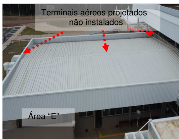
Figuras 89 e 90: Sistema captor – Terminais aéreos projetados não instalados - Áreas E e G.
