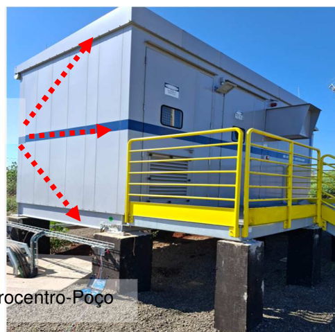
Figuras 496 e 497: Descida natural do SPDA, empregando as próprias estruturas metálicas.
