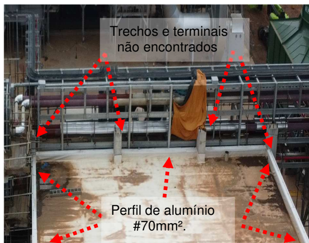
Figuras 309 e 310: Sistema captor/ Terminais aéreos/ Malha perfil de alumínio #70mm².
