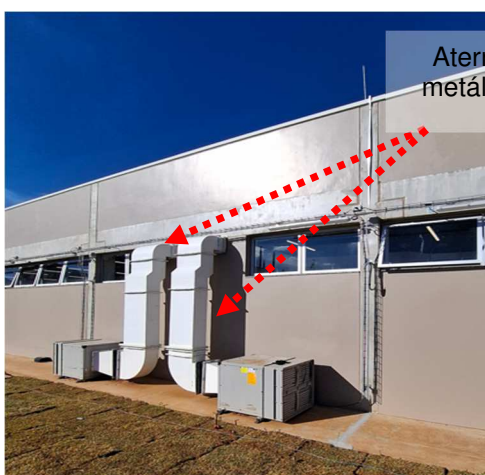
Figuras 136 e 137: Aterrar/interligar elementos metálicos ao SPDA ao existente.
