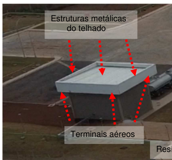
Figuras 346 e 347: Sistema captor natural / Terminais aéreos.
