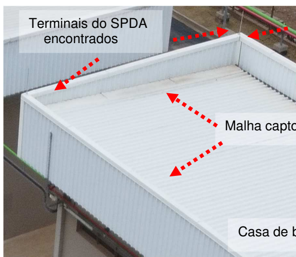
Figuras 374 e 375: Sistema captor natural / Terminais aéreos.
