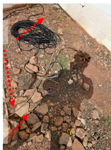
Figuras 63 e 64: Trechos da malha de aterramento exposta no piso.
