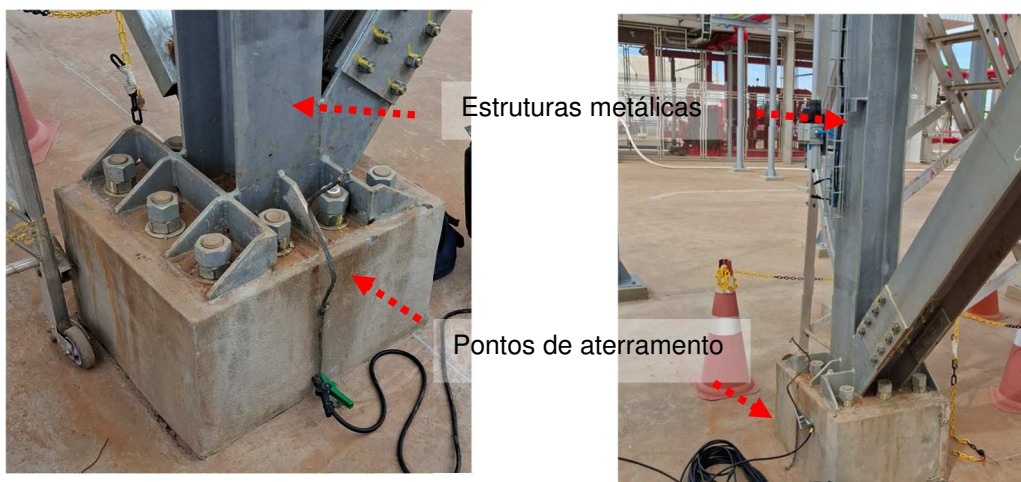
Figuras 457 e 458: Pontos de aterramento encontrados junto a base das estruturas.
