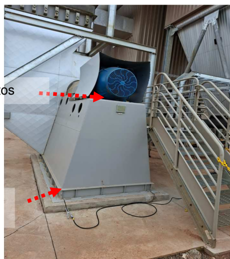
Figuras 278 e 279: Pontos de aterramento encontrados não constantes em planta.
