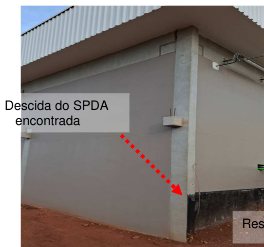
Figuras 356 e 357: Descida do SPDA projetada encontrada nesta inspeção.
