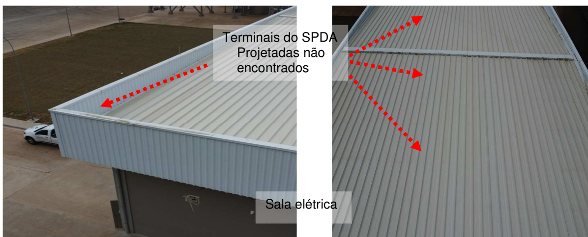
Figuras 145 e 146: Terminals aéreos projetados do SPDA não encontradas.
