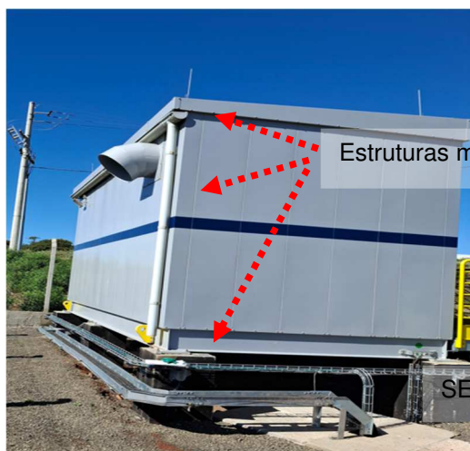
Figuras 496 e 497: Descida natural do SPDA, empregando as próprias estruturas metálicas.
