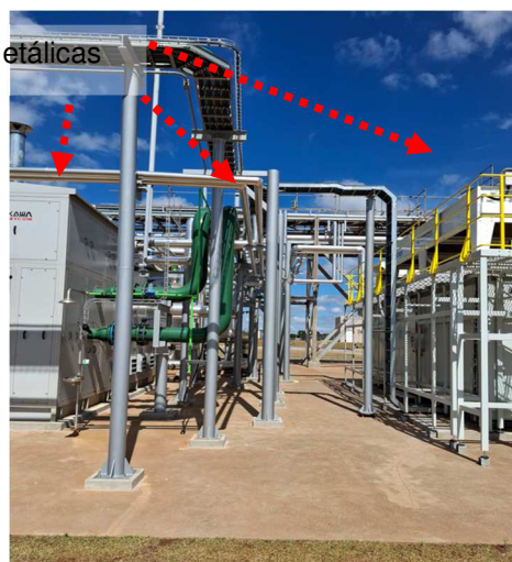
Figuras 413 e 414: Sistema captor e descidas naturais.
