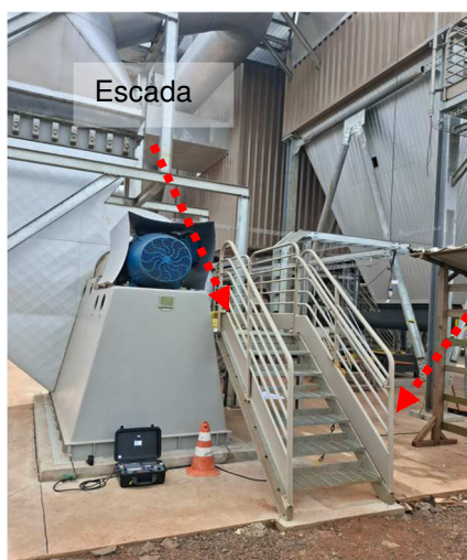
Figuras 286 e 287: Pontos de aterramento constantes em planta não encontrados.
