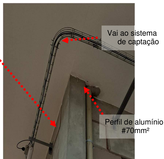
Figuras 173 e 174: Descida do SPDA instalada no prédio de Inflamáveis/Químicos.
