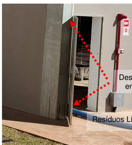
Figuras 352 e 353: Descida do SPDA projetada encontrada nesta inspeção.
