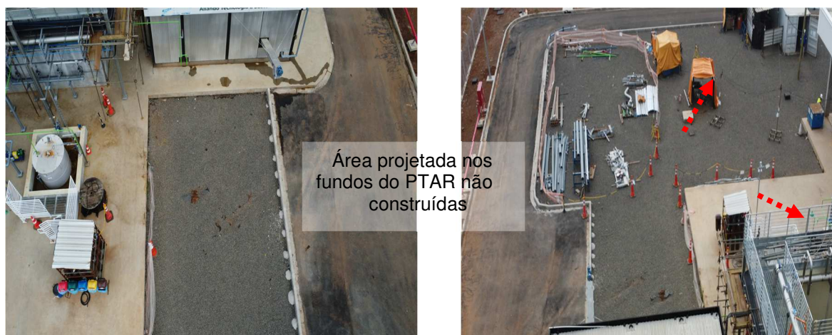
Figuras 200 e 201: Áreas projetadas nos fundos do PTAR não construídas.
