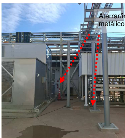
Figuras 337 e 338: Aterrar/interligar estruturas metálicas ao SPDA existente.
