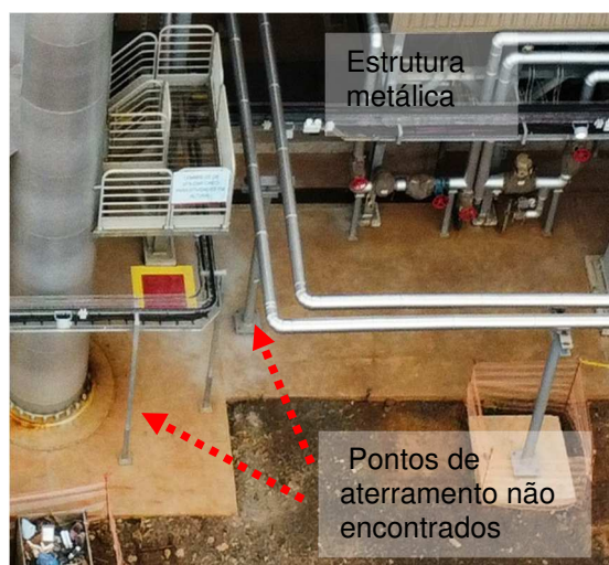
Figuras 290 e 291: Pontos de aterramento constantes em planta não encontrados.
