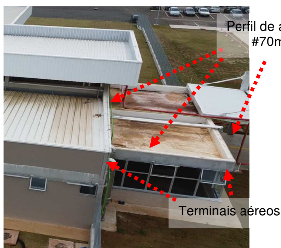
Figuras 81 e 82: Sistema captor existente -Cobertura áreas "Z" e "D".
