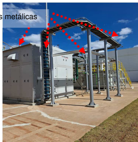
Figuras 415 e 416: Sistema captor e descidas naturais.
