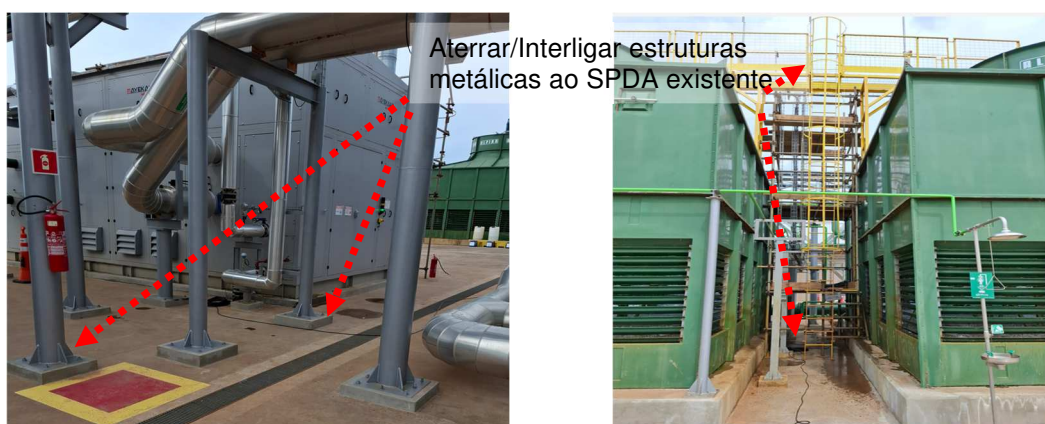
Figuras 464 e 465: Aterrar/interligar elementos metálicos ao SPDA existente.
