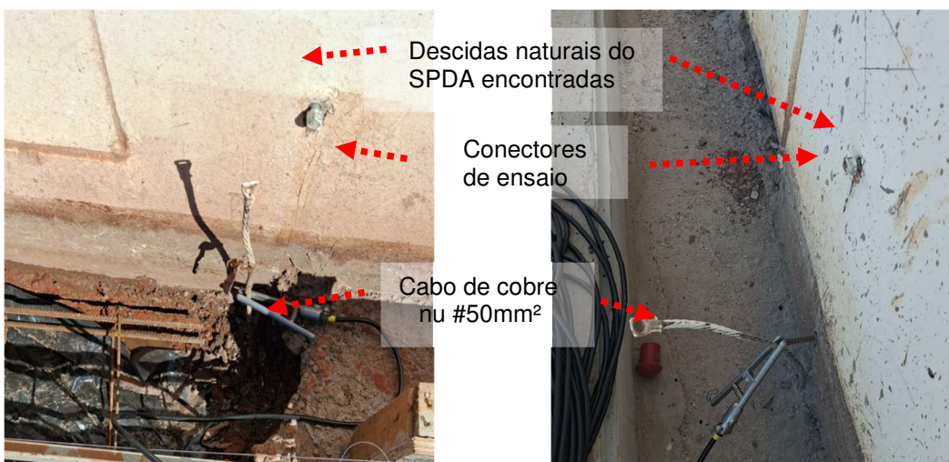
Figuras 27 e 28: Descidas do SPDA encontradas nesta inspeção visual.
