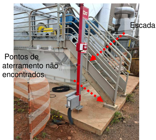
Figuras 288 e 289: Pontos de aterramento constantes em planta não encontrados.
