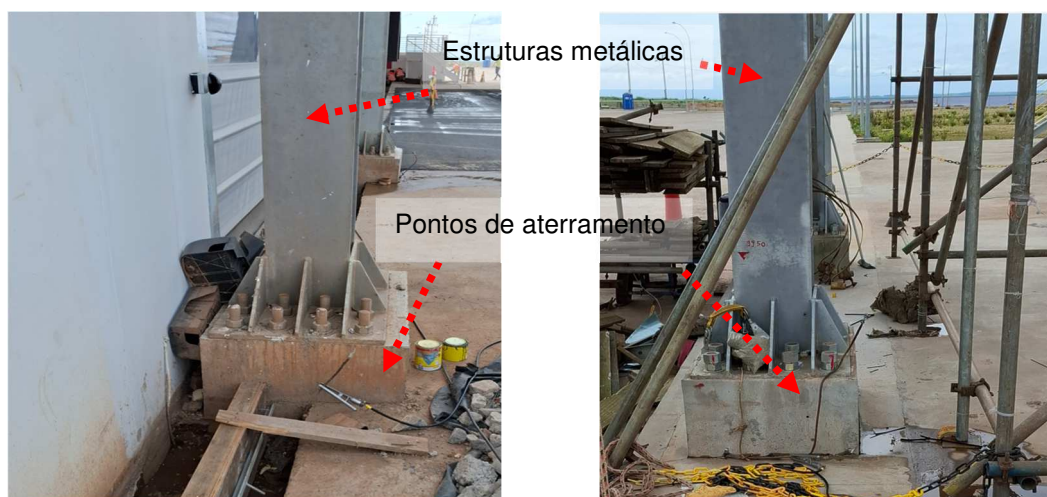
Figuras 449 e 450: Pontos de aterramento encontrados junto a base das estruturas.
