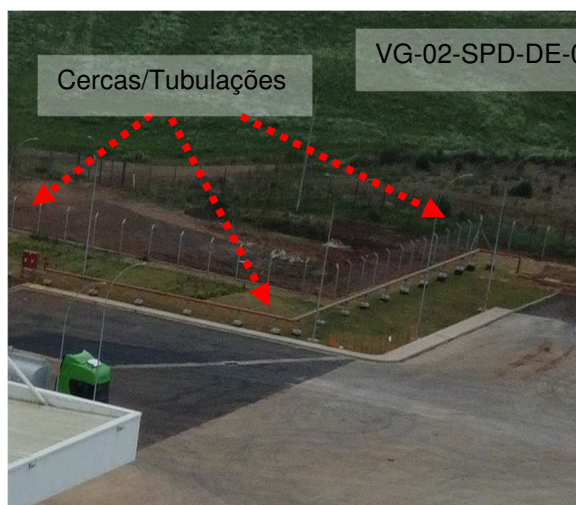
Figuras 525 e 527: Cercas – Tubulações não constante em planta (Incorporar ao SPDA).
