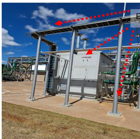
Figuras 415 e 416: Sistema captor e descidas naturais.
