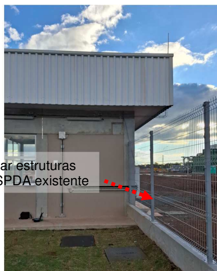
Figuras 477 e 478: Aterrar/interligar elementos metálicos ao SPDA existente.
