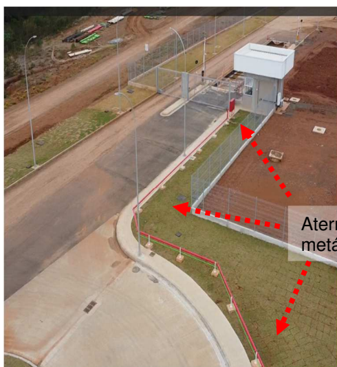
Figuras 477 e 478: Aterrar/interligar elementos metálicos ao SPDA existente.
