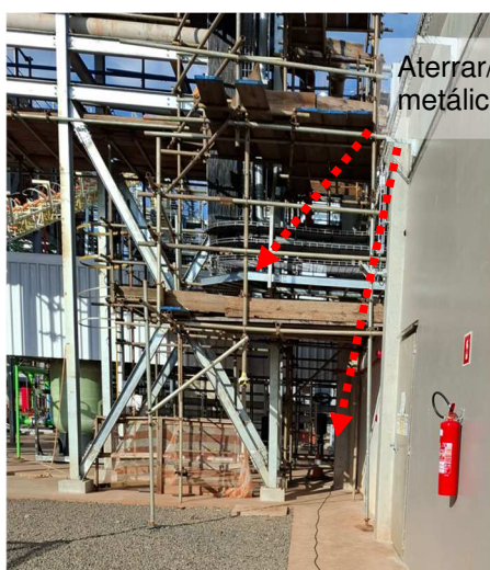
Figuras 335 e 336: Aterrar/interligar estruturas metálicas ao SPDA existente.
