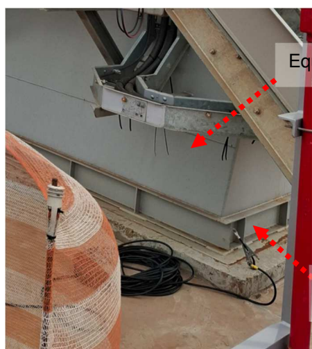
Figuras 282 e 283: Pontos de aterramento encontrados não constantes em planta.
