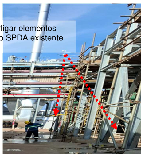
Figuras 343 e 344: Aterrar/interligar estruturas metálicas ao SPDA existente.
