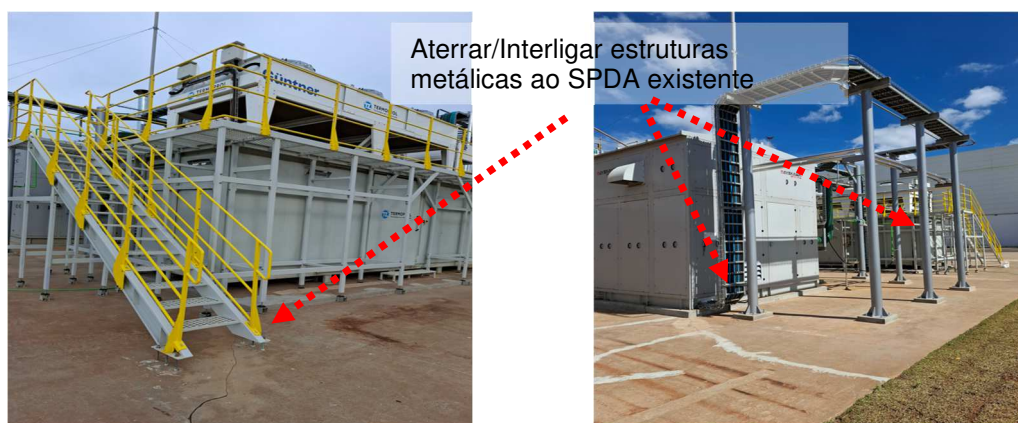
Figuras 462 e 463: Aterrar/interligar elementos metálicos ao SPDA existente.
