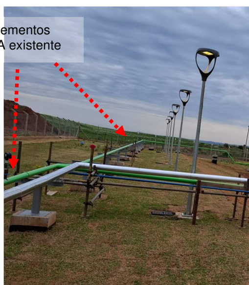
Figuras 371 e 372: Aterrar/interligar estruturas metálicas ao SPDA existente.
