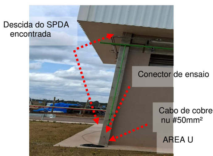
Figuras 171 e 172: Descida do SPDA instalada no prédio de Inflamáveis/Químicos.
