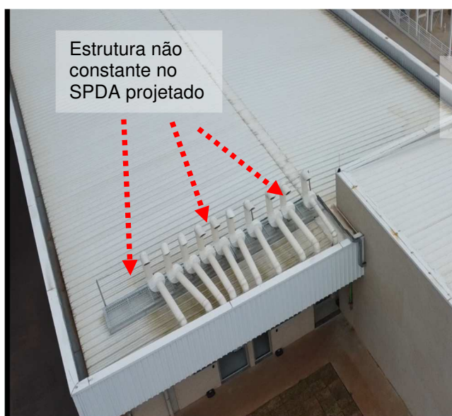
Figuras 93 e 94: Sistema captor – Estruturas não constantes no SPDA projetado.
