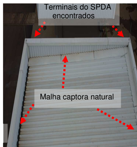
Figuras 169 e 170: Terminais aéreos do SPDA instalados.
