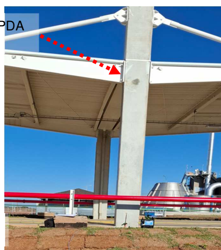
Figuras 106 e 107: 02 (duas) descidas do SPDA projetadas não encontradas.
