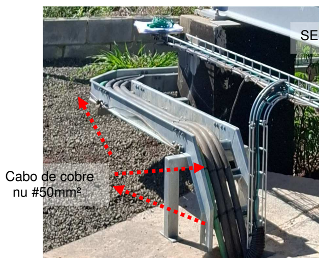
Figuras 504 e 505: Trecho de malha de aterramento em leito não constante em planta.
