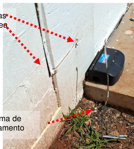
Figuras 54 e 55: Derivações das descidas do construídos de forma não retilínea.
