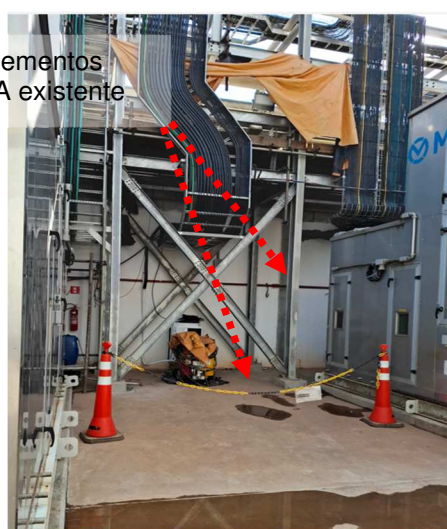
Figuras 337 e 338: Aterrar/interligar estruturas metálicas ao SPDA existente.
