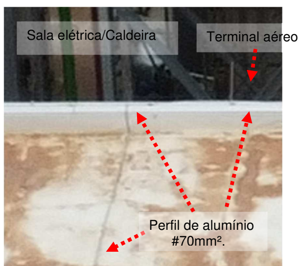
Figuras 307 e 308: Sistema captor/ Terminais aéreos/ Malha perfil de alumínio #70mm².
