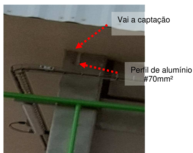
Figuras 171 e 172: Descida do SPDA instalada no prédio de Inflamáveis/Químicos.
