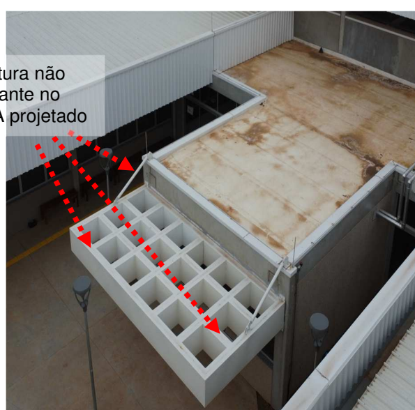
Figuras 93 e 94: Sistema captor – Estruturas não constantes no SPDA projetado.
