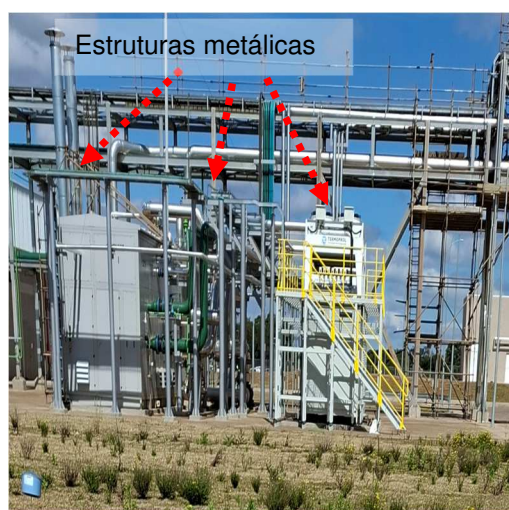
Figuras 417 e 418: Sistema captor e descidas naturais.
