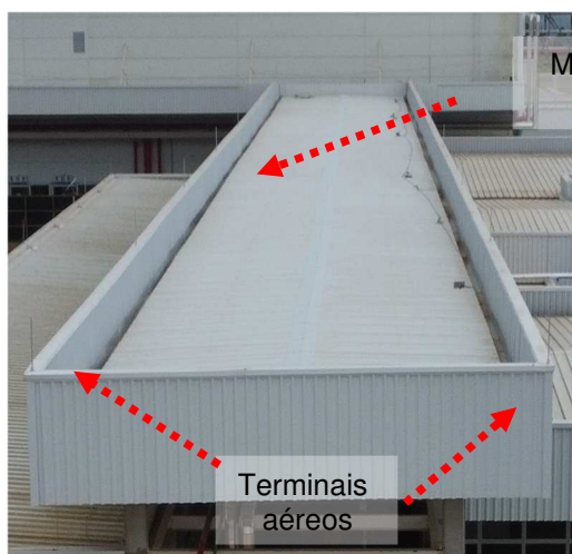
Figuras 75 e 76: Sistema captor existente - Cobertura área "Z".
