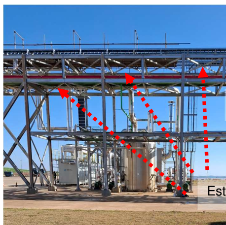
Figuras 403 e 404: Sistema captor e descidas naturais.
