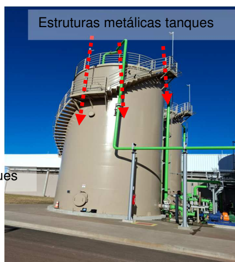
Figuras 399 e 400: Sistema captor e descidas naturais.
