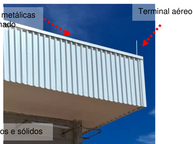
Figuras 348 e 349: Sistema captor natural / Terminais aéreos.
