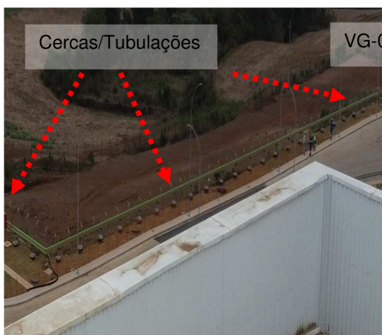
Figuras 528 e 529: Cercas – Tubulações não em planta (Incorporar ao SPDA).
