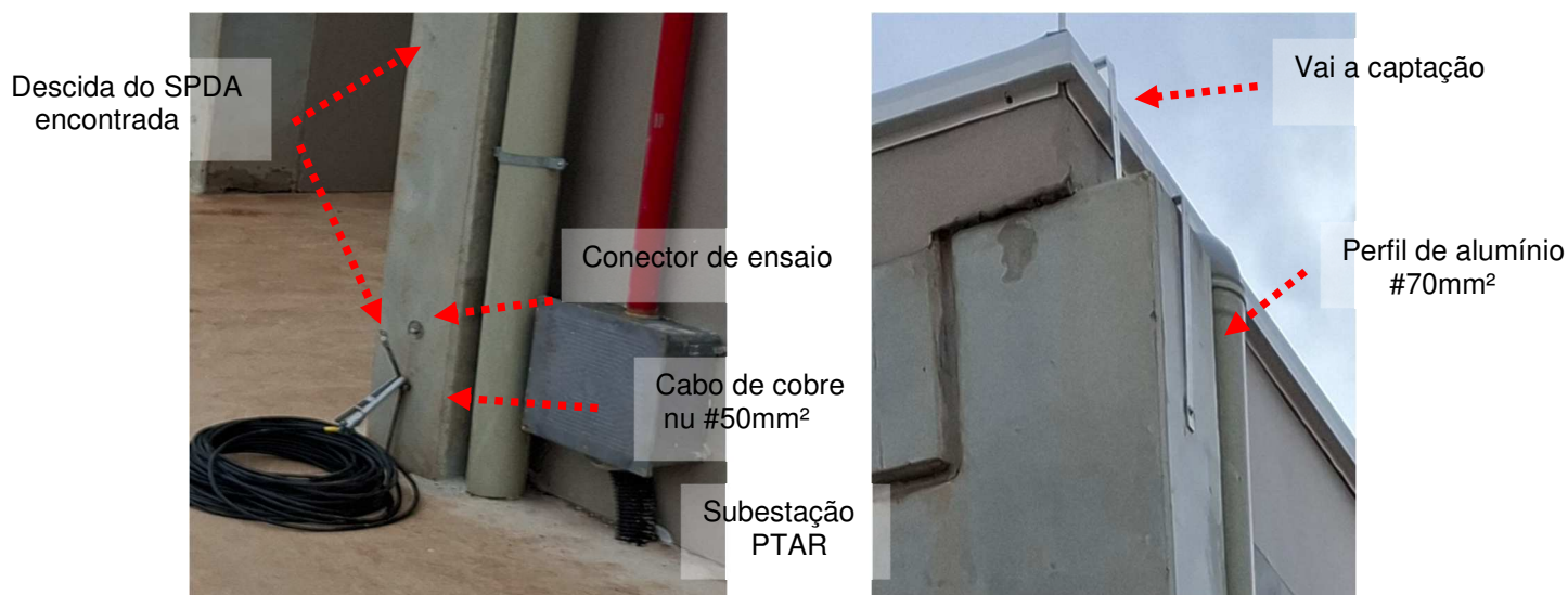
Figuras 208 e 209: Descida do SPDA instalada no prédio da Subestação PTAR
