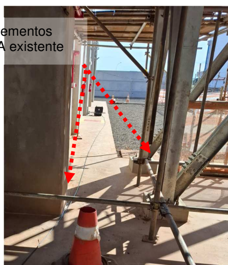
Figuras 335 e 336: Aterrar/interligar estruturas metálicas ao SPDA existente.
