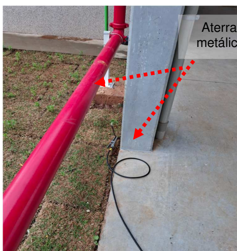
Figuras 134 e 135: Aterrar/interligar elementos metálicos ao SPDA existente.
