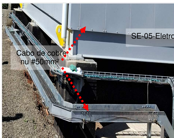
Figuras 506 e 507: Trecho de malha de aterramento em leito não constante em planta.
