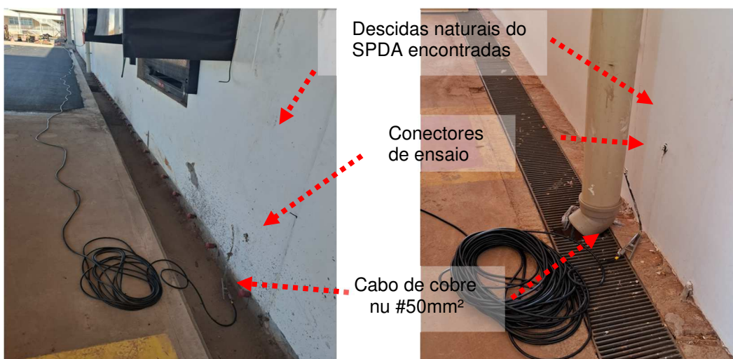
Figuras 29 e 30: Descidas do SPDA encontradas nesta inspeção visual.
