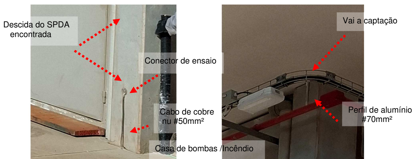
Figuras 380 e 381: Descida do SPDA instalada no prédio de Casas de Bombas/Incêndio.
