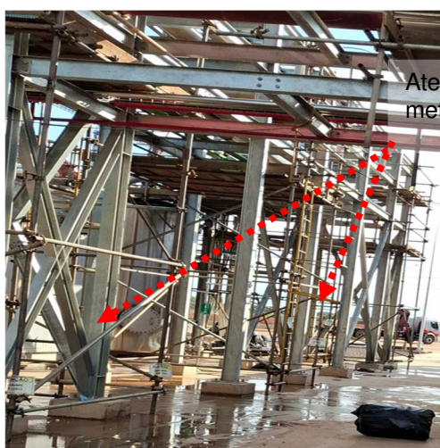
Figuras 343 e 344: Aterrar/interligar estruturas metálicas ao SPDA existente.
