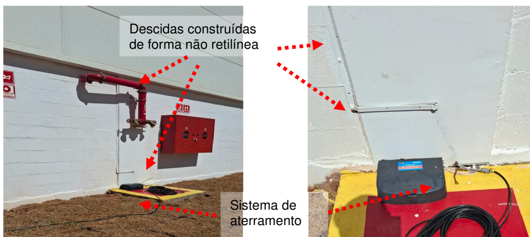
Figuras 52 e 53: Derivações das descidas do construídos de forma não retilínea.
