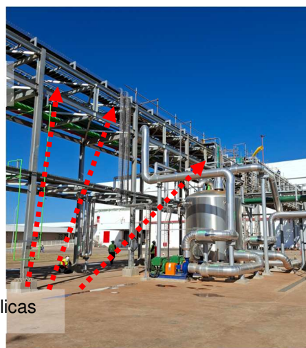
Figuras 401 e 402: Sistema captor e descidas naturais.
