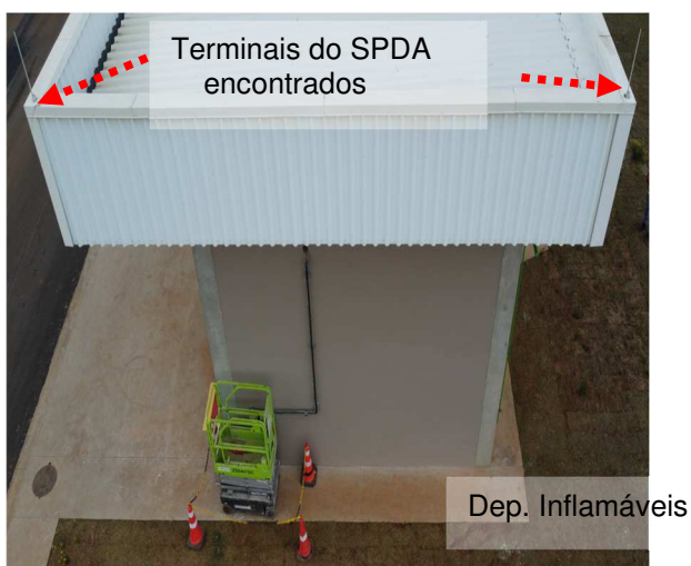
Figuras 169 e 170: Terminais aéreos do SPDA instalados.
