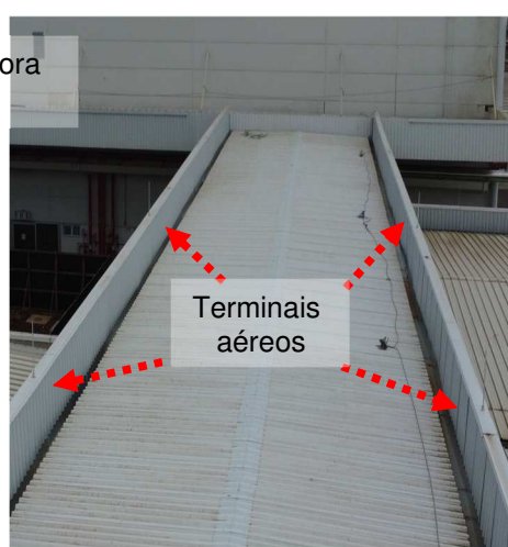
Figuras 75 e 76: Sistema captor existente - Cobertura área "Z".
