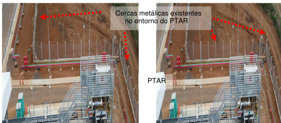
Figuras 246 e 247: Estruturas metálicas com aterramento projetado não visualizado.
