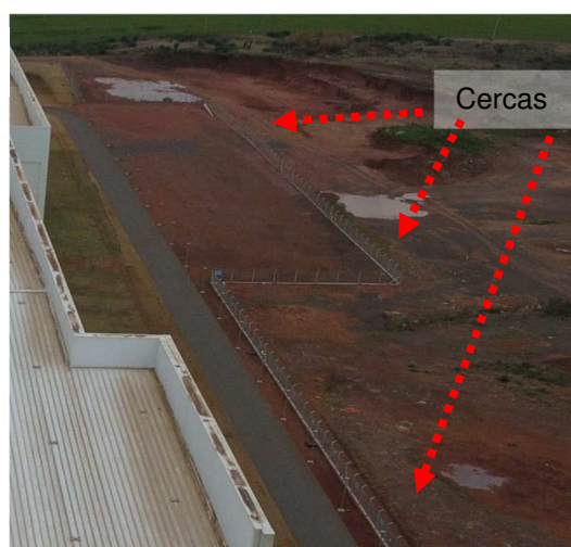
Figuras 524 e 525: Cercas – Tubulações não constante em planta (Incorporar ao SPDA).
