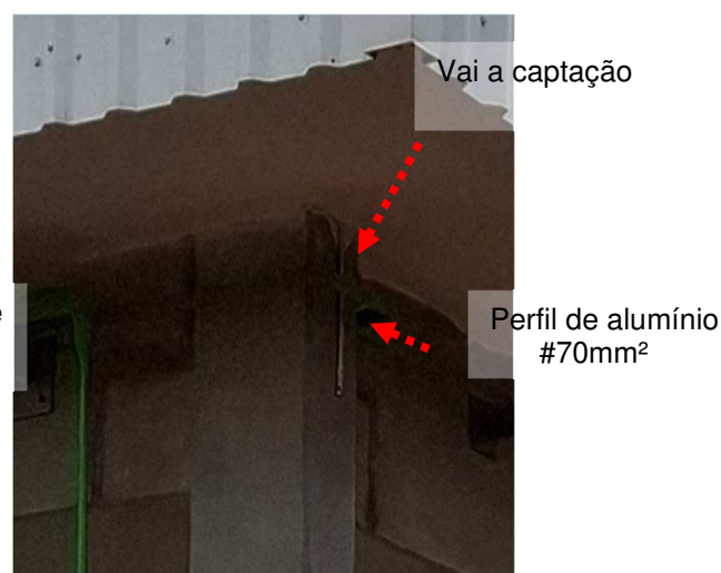
Figuras 204 e 205: Descida do SPDA instalada no prédio do PTAR
