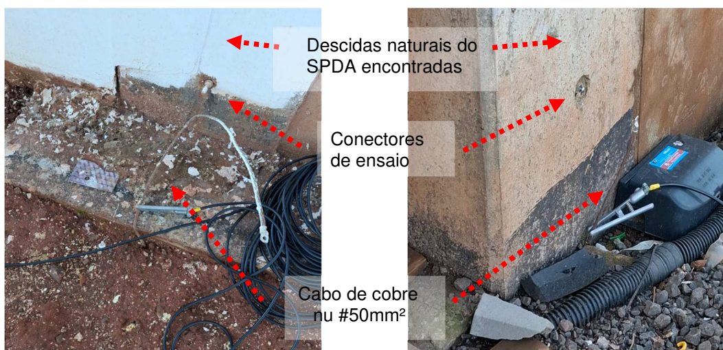
Figuras 37 e 38: Descidas do SPDA encontradas nesta inspeção visual.
