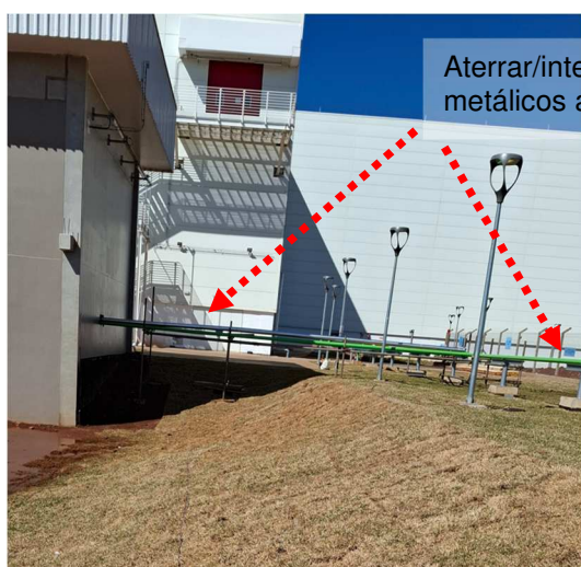
Figuras 369 e 370: Aterrar/interligar estruturas metálicas ao SPDA existente.
