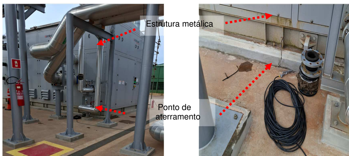
Figuras 425 e 426: Pontos de aterramento encontrados junto a base das estruturas.
