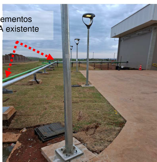
Figuras 369 e 370: Aterrar/interligar estruturas metálicas ao SPDA existente.
