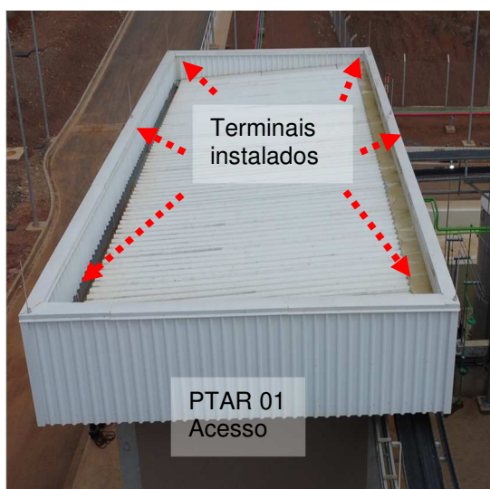
Figuras 180 e 181: Dois (02) terminais aéreos a mais instalados em relação ao projeto.
