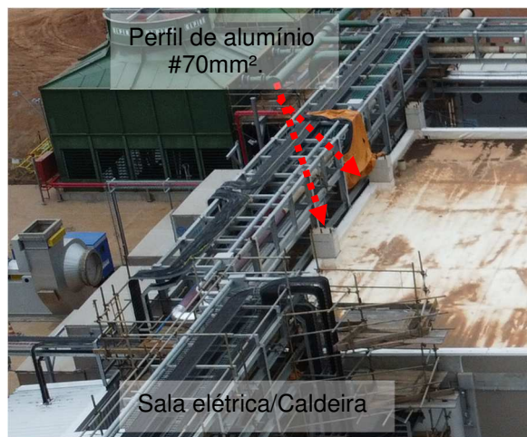
Figuras 309 e 310: Sistema captor/ Terminais aéreos/ Malha perfil de alumínio #70mm².
