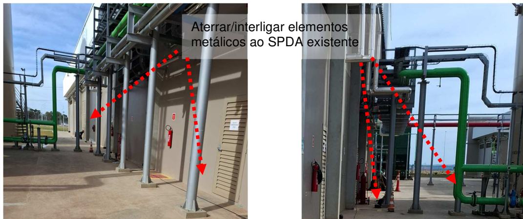
Figuras 164 e 165: Aterrar/interligar bases das estruturas do pipe-rack ao SPDA existente.
