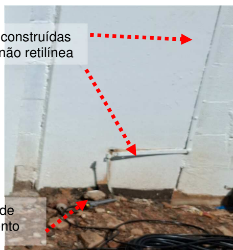
Figuras 56 e 57: Derivações das descidas do construídos de forma não retilínea.
