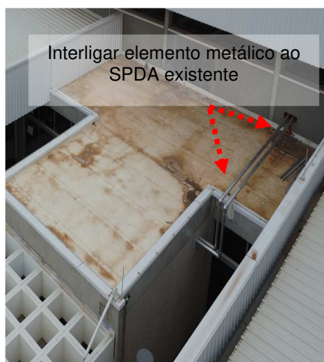
Figuras 142 e 143: Aterrar/interligar elementos metálicos ao SPDA ao existente.
