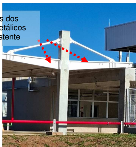
Figuras 132 e 133: Interligar vãos da cobertura metálica ao SPDA existente.
