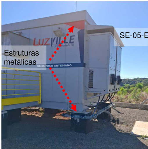
Figuras 498 e 499: Descida natural do SPDA, empregando as próprias estruturas metálicas
