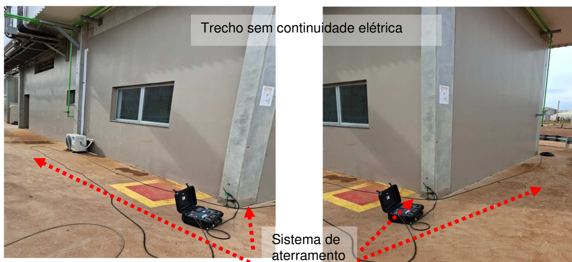
Figuras 254 e 255: Sistema de aterramento -Trecho sem continuidade elétrica.
