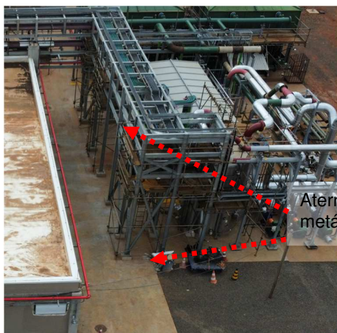
Figuras 341 e 342: Aterrar/interligar estruturas metálicas ao SPDA existente.
