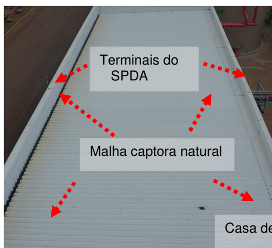
Figuras 376 e 377: Sistema captor natural / Terminais aéreos.
