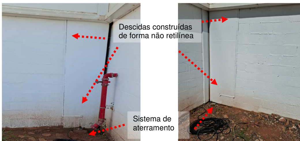
Figuras 60 e 61: Derivações das descidas do construídos de forma não retilínea.
