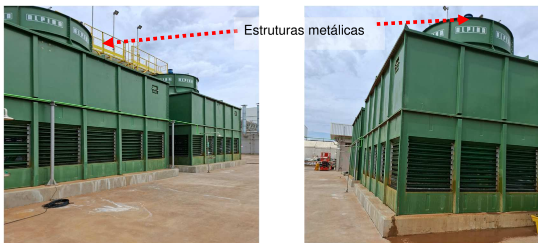
Figuras 421 e 422: Sistema captor e descidas naturais.
