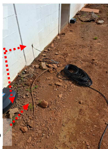
Figuras 65 e 66: Trechos da malha de aterramento exposta no piso.
