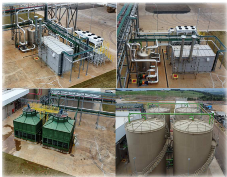
Figura 394: Torre de resfriamento /Chiller
