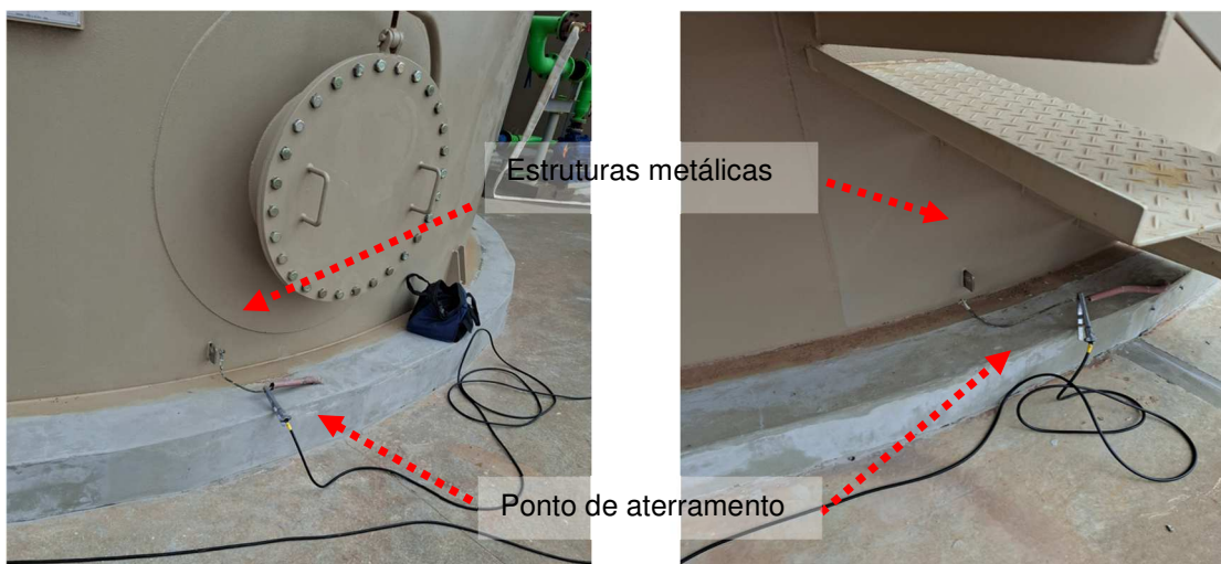
Figuras 447 e 448: Pontos de aterramento encontrados junto a base das estruturas.
