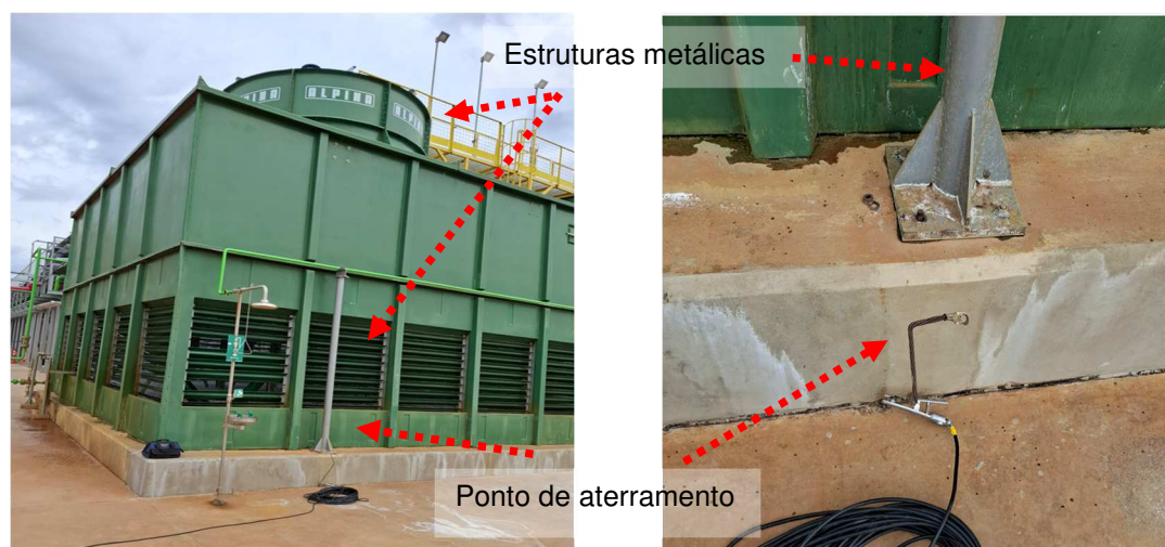
Figuras 433 e 434: Pontos de aterramento encontrados junto a base das estruturas.
