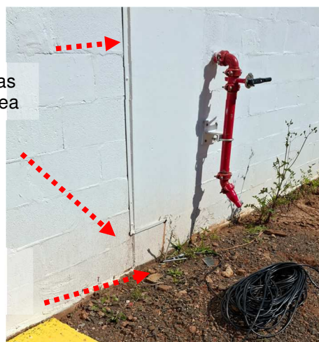
Figuras 58 e 59: Derivações das descidas do construídos de forma não retilínea.
