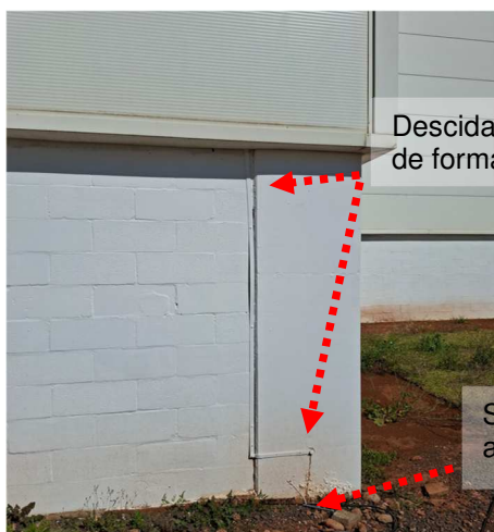
Figuras 58 e 59: Derivações das descidas do construídos de forma não retilínea.
