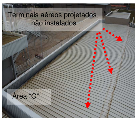
Figuras 89 e 90: Sistema captor – Terminais aéreos projetados não instalados - Áreas E e G.
