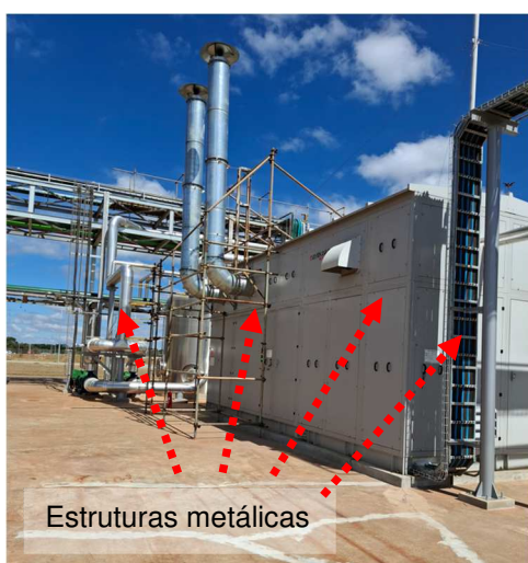
Figuras 417 e 418: Sistema captor e descidas naturais.
