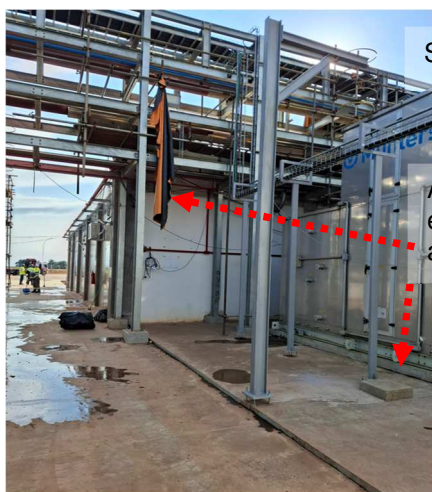
Figuras 339 e 340: Aterrar/interligar estruturas metálicas ao SPDA existente.
