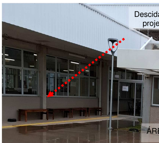
Figuras 102 e 103: 02 (duas) descidas do SPDA projetadas não encontradas.
