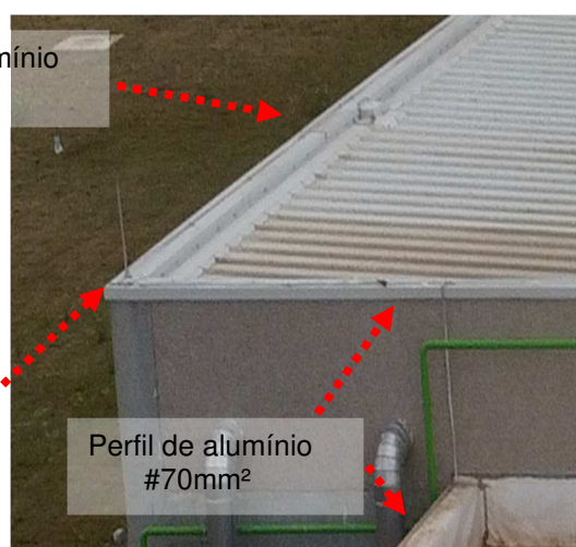
Figuras 81 e 82: Sistema captor existente -Cobertura áreas "Z" e "D".
