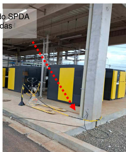
Figuras 75 e 76: Descidas do SPDA visualizadas nesta inspeção no PTAR.
