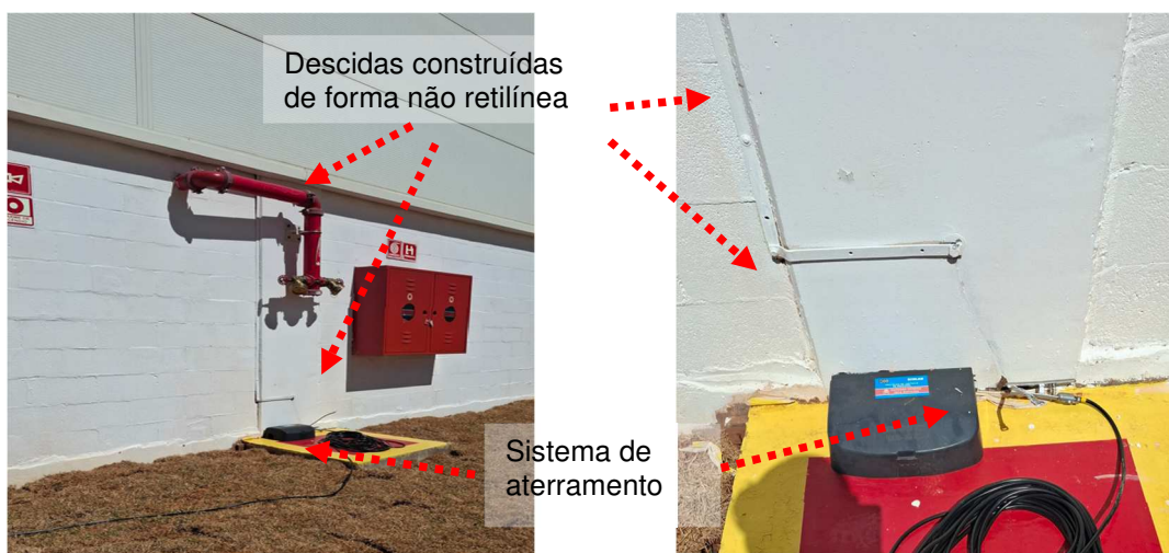
Figuras 24 e 25: Derivações das descidas do construídos de forma não retilínea.
