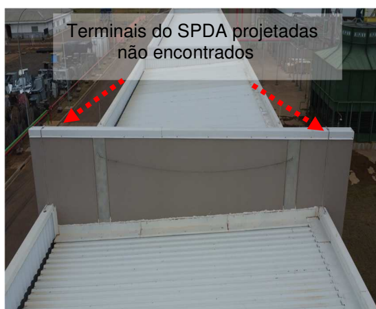
Figuras 64 e 65: Terminais aéreos projetados do SPDA não encontradas.
