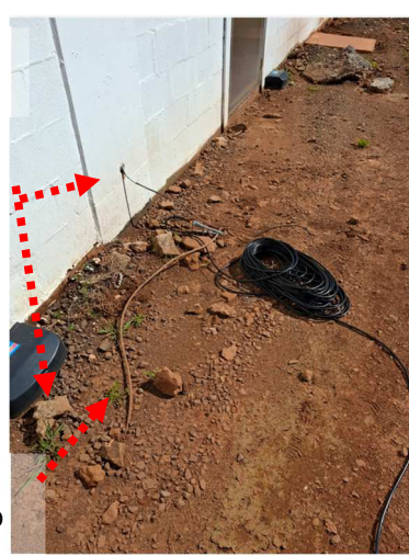
Figuras 37 e 38: Trechos da malha de aterramento exposta no piso.
