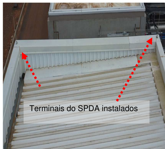
Figuras 73 e 74: Seis (06) terminais aéreos sobre a malha captora natural no PTAR.
