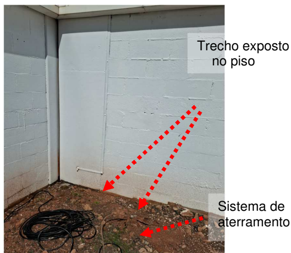
Figuras 35 e 36: Trechos da malha de aterramento exposta no piso.
