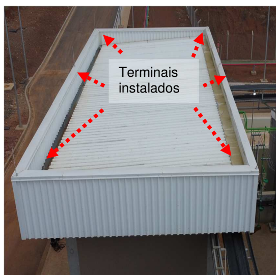
Figuras 67 e 68: Dois (02) terminais aéreos a mais instalados em relação ao projetado.
