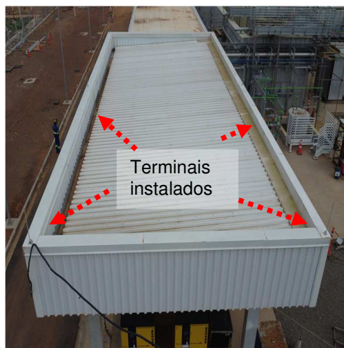
Figuras 73 e 74: Seis (06) terminais aéreos sobre a malha captora natural no PTAR.
