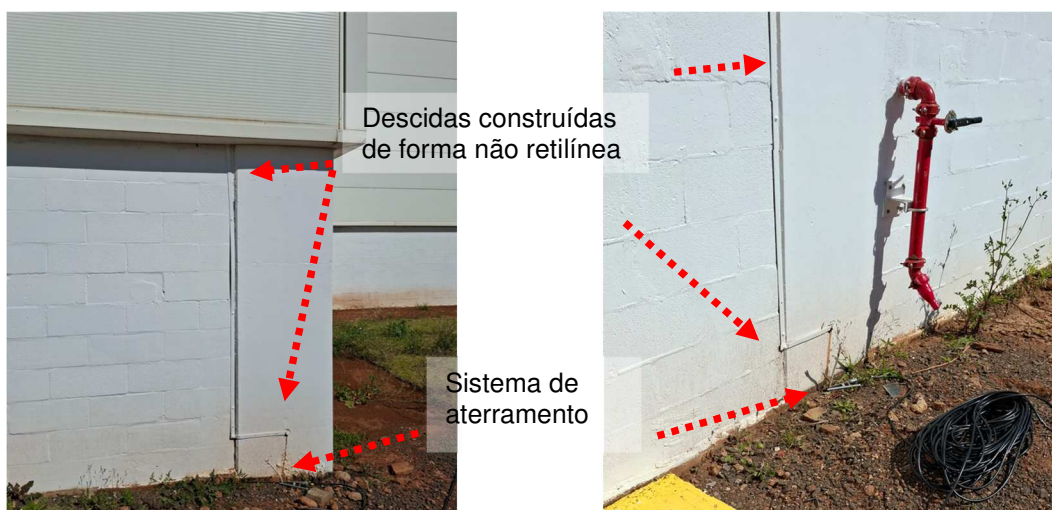
Figuras 30 e 31: Derivações das descidas do construídos de forma não retilínea.
