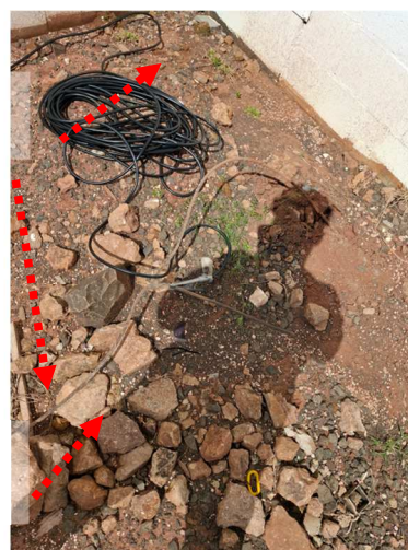
Figuras 35 e 36: Trechos da malha de aterramento exposta no piso.
