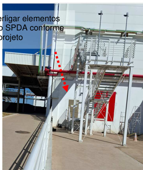
Figuras 40 e 41: Aterrar/interligar elementos metálicos ao SPDA conforme projeto
