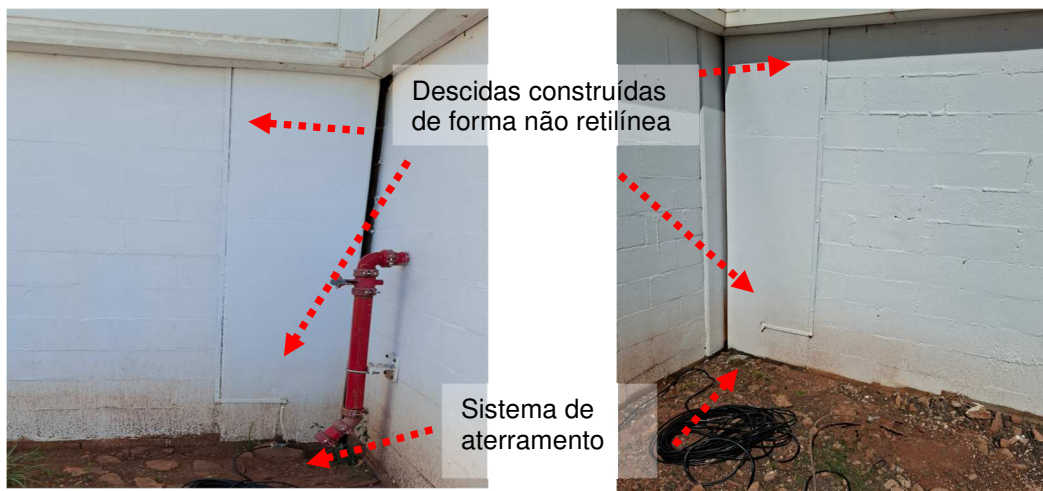
Figuras 32 e 33: Derivações das descidas do construídos de forma não retilínea.
