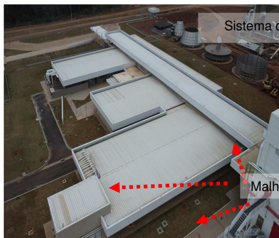
Figuras 43 e 44: Sistema captor existente neste local.
