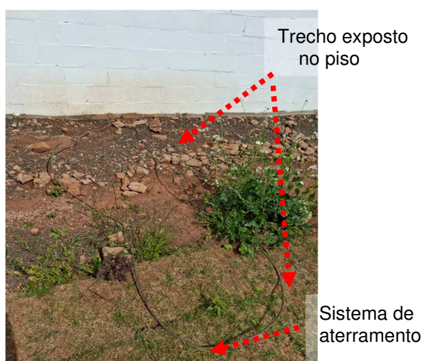
Figuras 37 e 38: Trechos da malha de aterramento exposta no piso.
