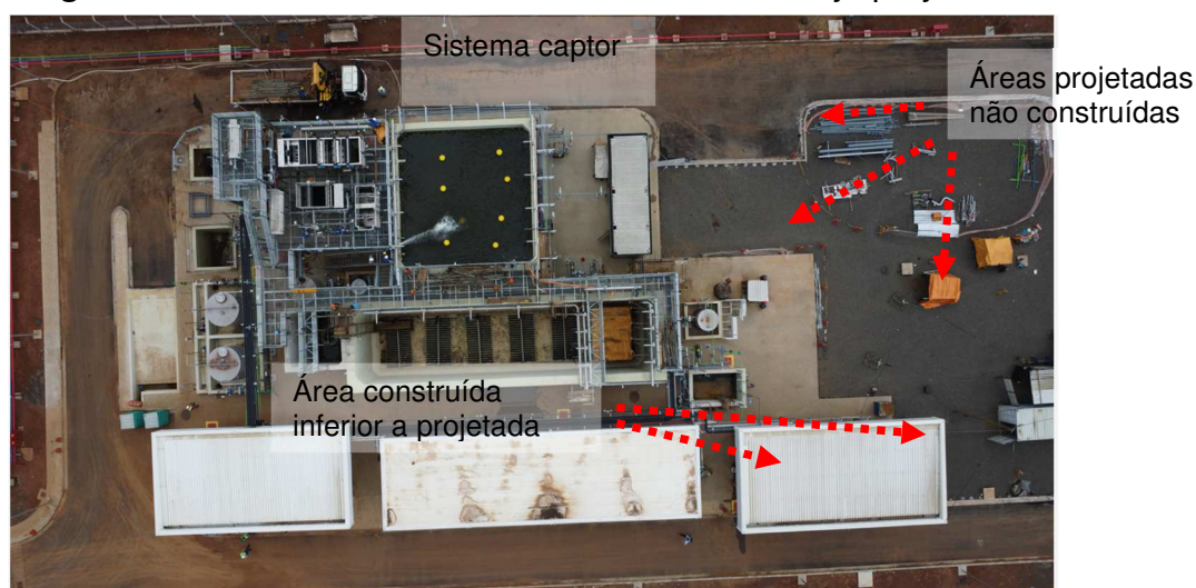
Figura 72: Áreas não construídas, inferior ao arranjo projetado.
