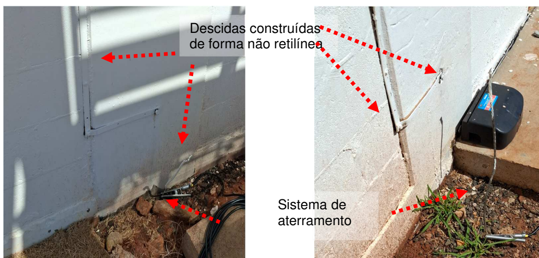
Figuras 26 e 27: Derivações das descidas do construídos de forma não retilínea.
