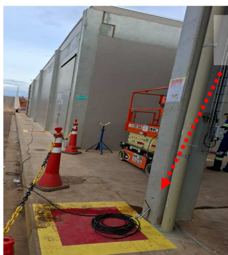
Figuras 75 e 76: Descidas do SPDA visualizadas nesta inspeção no PTAR.
