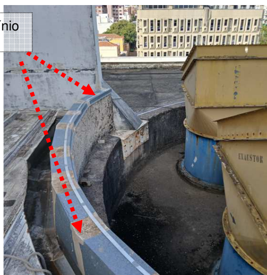
Figuras 11 e 12: Malha captora construída no entorno das estruturas
