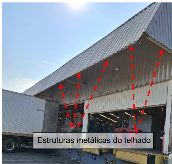
Figuras 84 e 85: Sistema Captor natural- Estruturas metálica do telhado.
