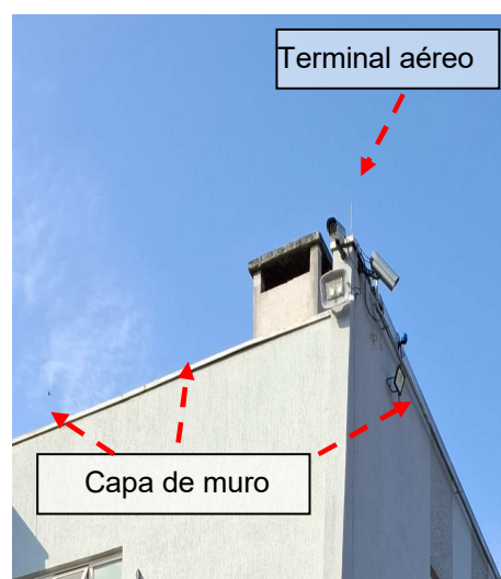
Figuras 55 e 56: Sistema de Captação – Prédio do Refeitório
