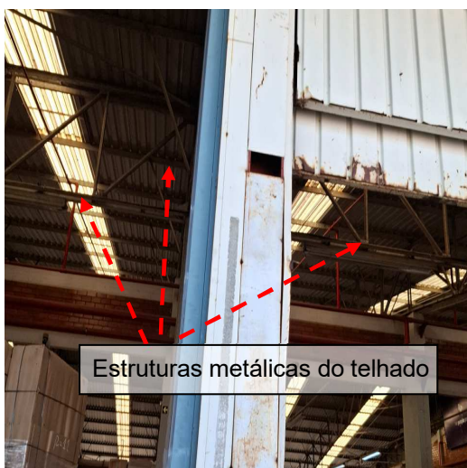
Figuras 82 e 83: Sistema Captor - Estruturas metálica do telhado.
