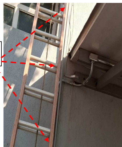
Figuras 63 e 64: Sistema de descidas convencionais– Prédio do Refeitório.
