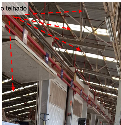
Figuras 80 e 81: Sistema Captor natural – Estruturas metálicas do telhado.
