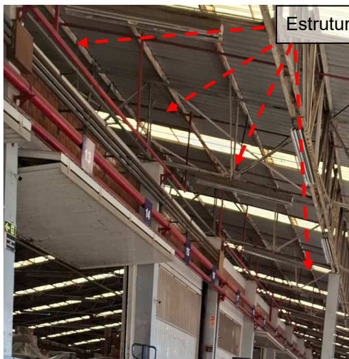
Figuras 80 e 81: Sistema Captor natural – Estruturas metálicas do telhado.
