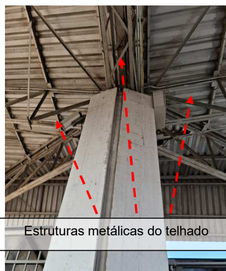
Figuras 59 e 60: Sistema de Captação – Prédio da Portaria
