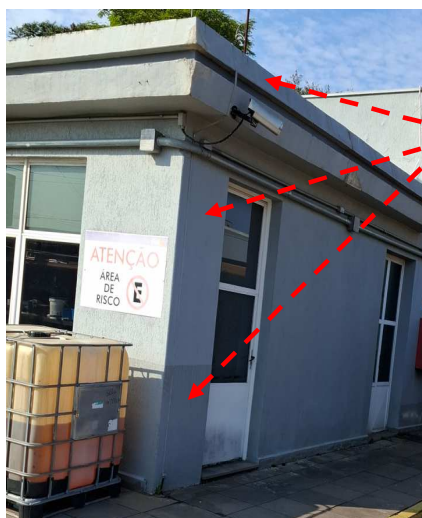
Figuras 61 e 62: Sistema de descidas convencionais – Prédio do Refeitório
