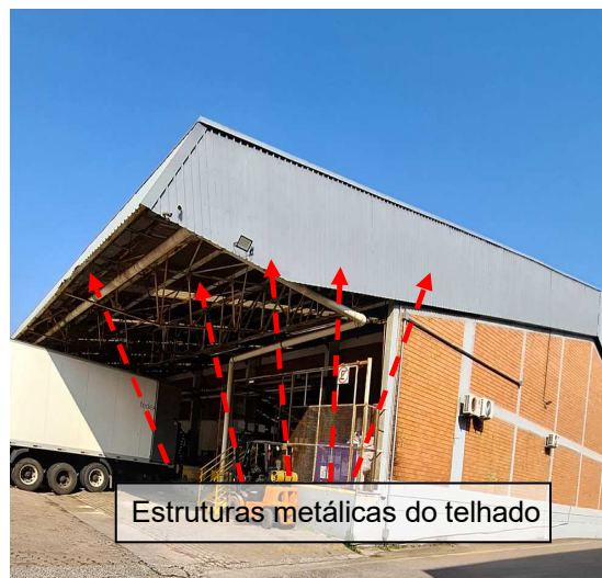
Figuras 84 e 85: Sistema Captor natural- Estruturas metálica do telhado.
