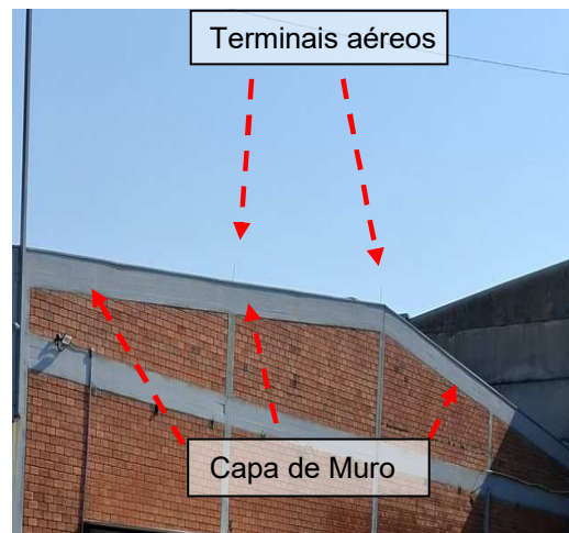
Figuras 03 e 04: Sistema de captação – Manutenção / Oficina
