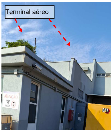
Figuras 53 e 54: Sistema de Captação – Prédio do Refeitório
