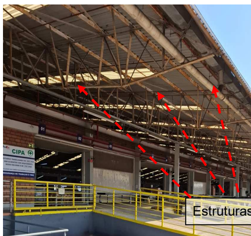
Figuras 78 e 79: Sistema Captor natural – Estruturas metálicas do telhado.
