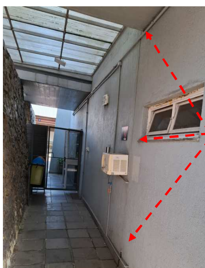
Figuras 65 e 66: Sistema de descidas – Prédio do Refeitório / Prédio da Portaria.
