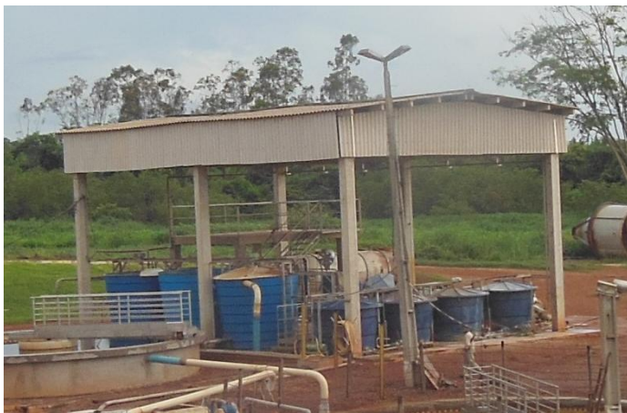
Figura 12: Área do Pavilhão do ETE
