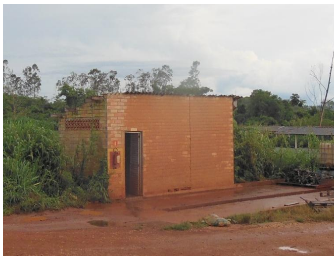
Figura 23: Área do Lavador de Caminhão
