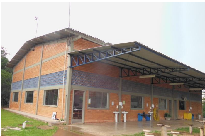
Figura 07: Área do Refeitório
