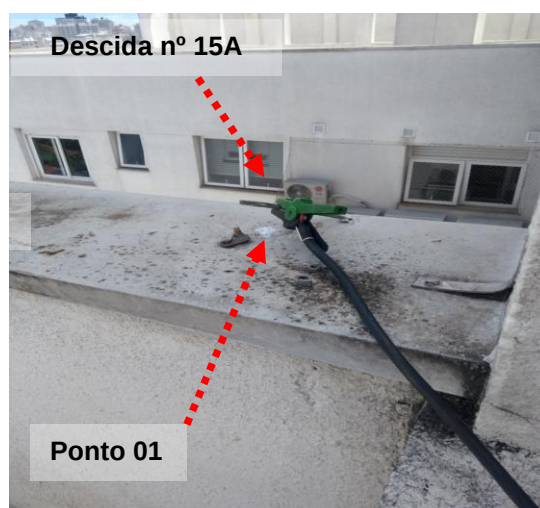
Figuras 29 e 30: Referência Ponto 01 (Descida nº 15 A do SPDA na cobertura) // (Torre 02).
