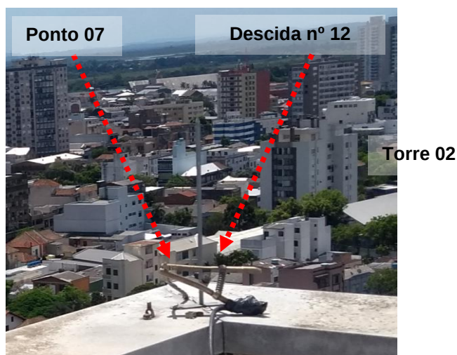
Figuras 41 e 42: Ponto 07 (Descida nº 12 do SPDA na cobertura) // Medição 07 - (Torre 02).
