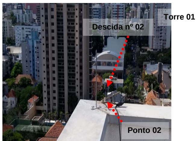
Figuras 09 e 10: Ponto 02 (Descida nº 02 do SPDA) na cobertura // Medição 02 - (Torre 01).
