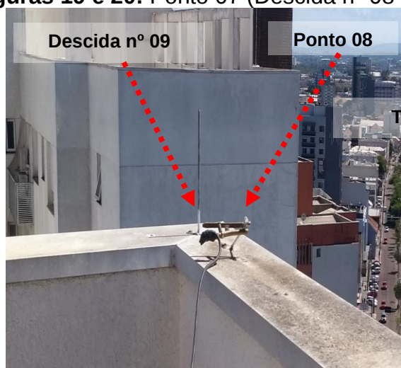
Figuras 21 e 22: Ponto 08 (Descida nº 09 do SPDA na cobertura) // Medição 08 - (Torre 01).
