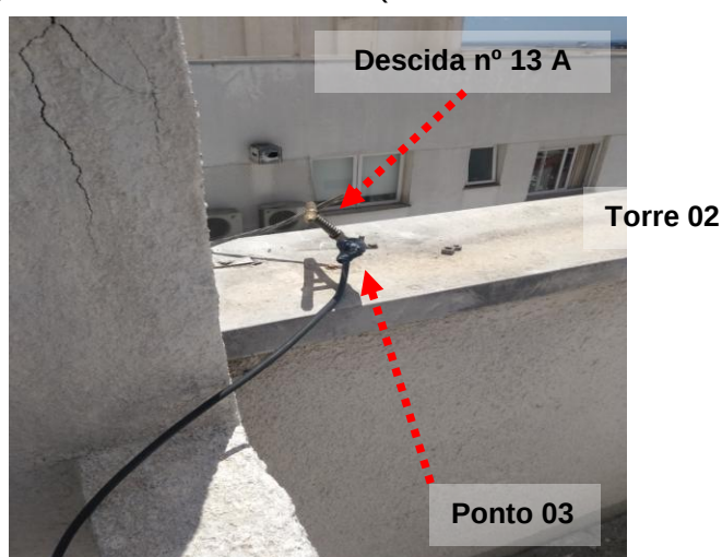
Figuras 33 e 34: Ponto 03 ( Descida nº 13A do SPDA na cobertura) // Medição 03 - (Torre 02).
