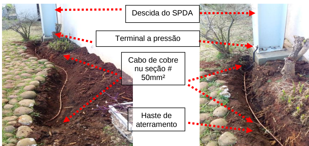
Figuras 31 e 32: Malha de aterramento implantada em cabo de cobre secção 50mm 2 .
