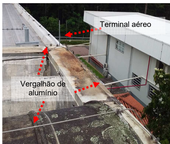
Figuras 145 e 146: Sistema captor existente e terminais aéreos– RS7.
