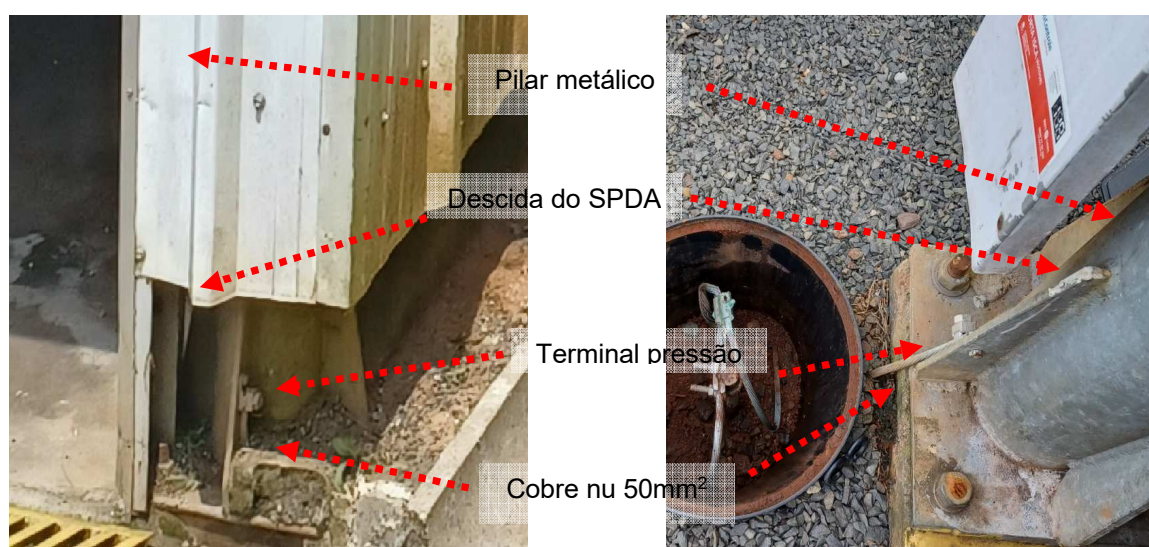
Figuras 270 e 271: Sistema de descidas naturais existentes – Controle de Resíduos
