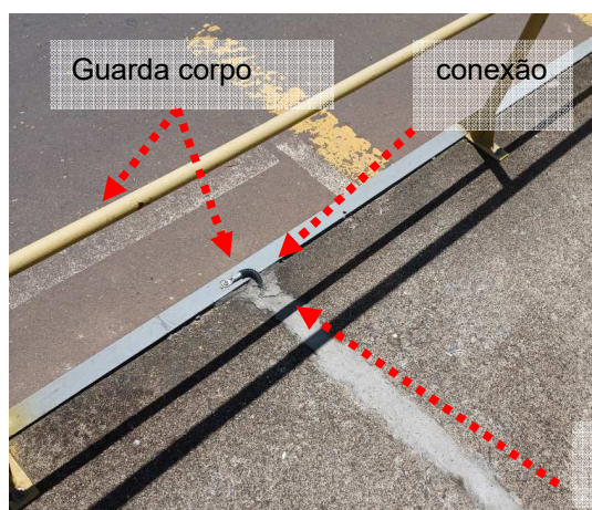
Figuras 187 e 188: Sistema de aterramento
