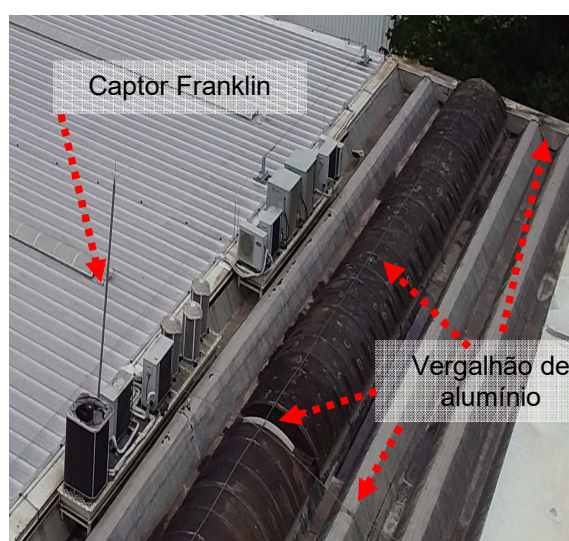
Figuras 141 e 142: Sistema captor existente – RS7.
