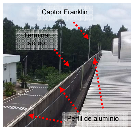
Figuras 103 e 104: Sistema captora convencional existente – Pavilhão Não Tecidos.
