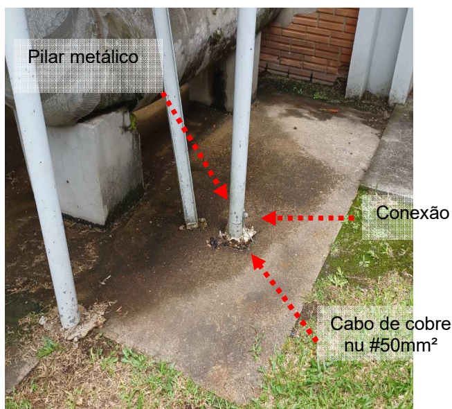
Figuras 125 e 126: Sistema de aterramento
