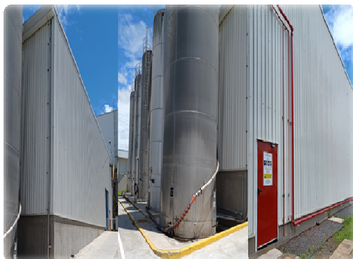
Figura 288: Ampliação Prédio RS7.
