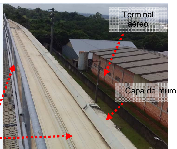
Figuras 206 e 207: Sistema de captor existente – RS6.
