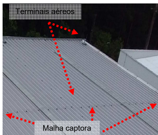
Figuras 291 e 292: Sistema captor existente – Ampliação Prédio RS7.
