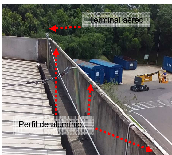
Figuras 103 e 104: Sistema captora convencional existente – Pavilhão Não Tecidos.
