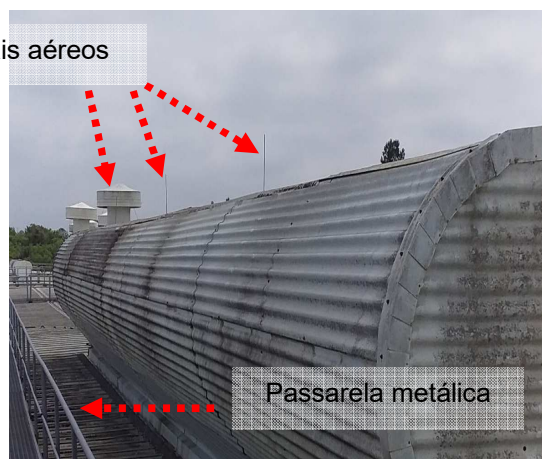
Figuras 216 e 217: Sistema de captor existente – RS6.
