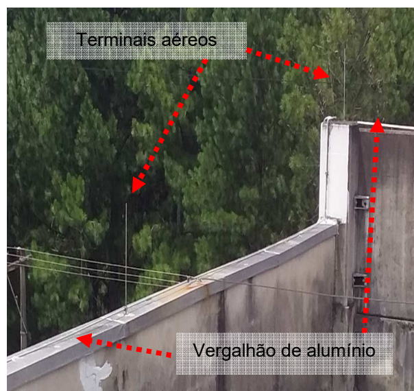
Figuras 55 e 56: Sistema captor existente – Subestação FNT
