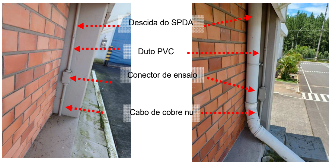
Figuras 171 e 172: Sistema de Descidas convencionais – RS7
