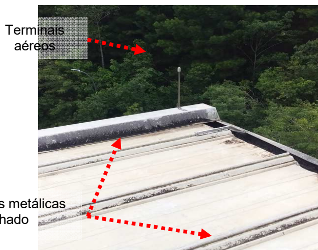
Figuras 210 e 211: Sistema de captor existente – RS6.
