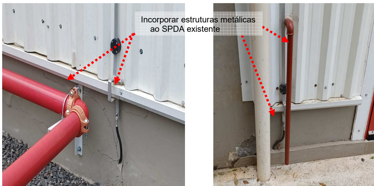
Figuras 315 e 316: Equalizar, incorporando estruturas metálicas próximas às descidas do SPDA existente.
