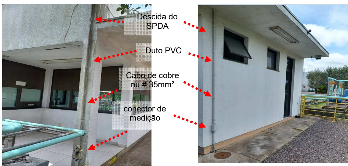
Figuras 05 e 06: Sistema de descidas – Portaria.
