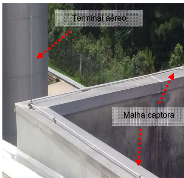
Figuras 55 e 56: Sistema captor existente – Subestação FNT
