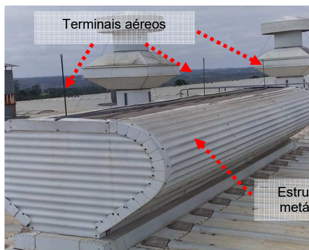
Figuras 218 e 219: Sistema de captor existente – RS6.
