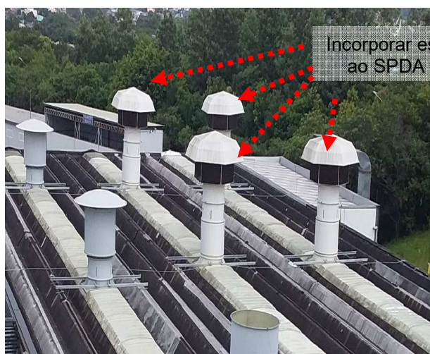
Figuras 195 e 196: Incorporar estruturas ao SPDA existente na cobertura da edificação.
