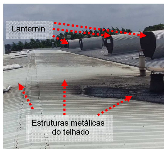
Figuras 109 e 110: Sistema captor natural existente – Pavilhão Não Tecidos.
