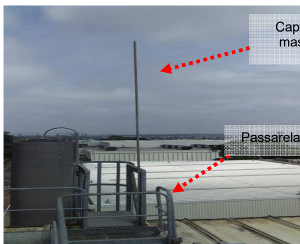
Figuras 212 e 213: Sistema de captor existente – RS6.
