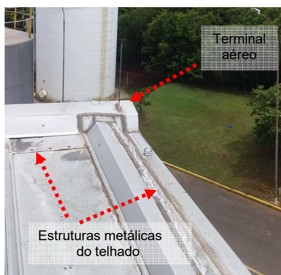
Figuras 93 e 94: Sistema captor existente – Pavilhão Não Tecidos.
