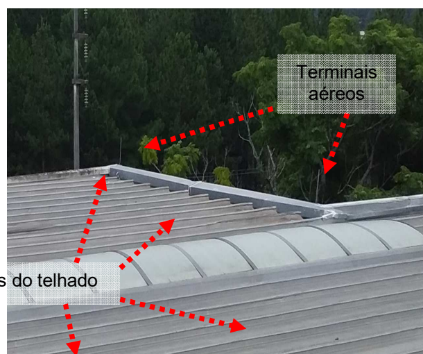
Figuras 147 e 148: Sistema captor natural existente e terminais aéreos – RS7.
