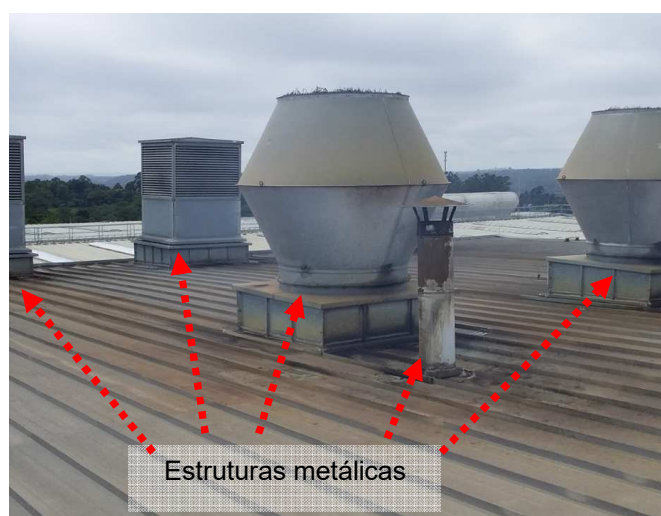
Figuras 161 e 162: Sistema captor natural existente – RS7.
