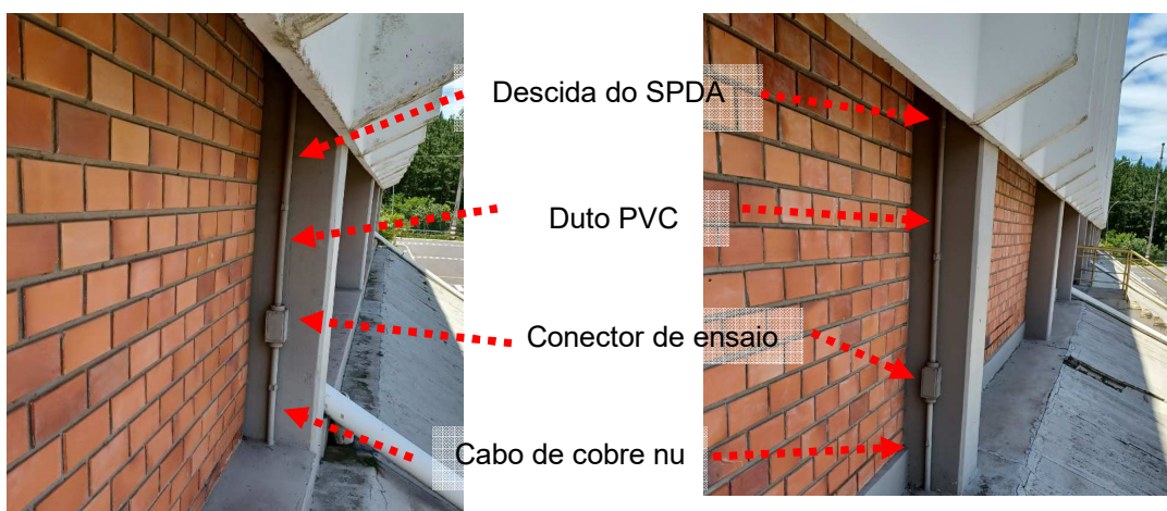
Figuras 173 e 174: Sistema de Descidas convencionais– RS7
