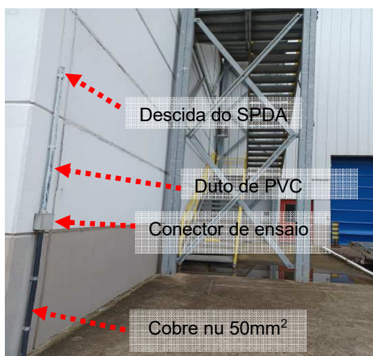
Figuras 232 e 233: Sistema de descidas convencionais e naturais existentes – RS6.
