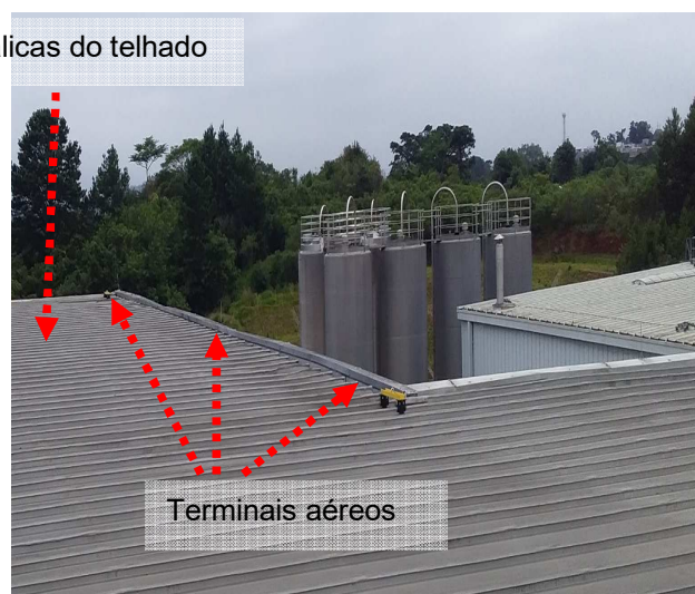
Figuras 165 e 166: Sistema captor natural existente e terminais aéreos– RS7.
