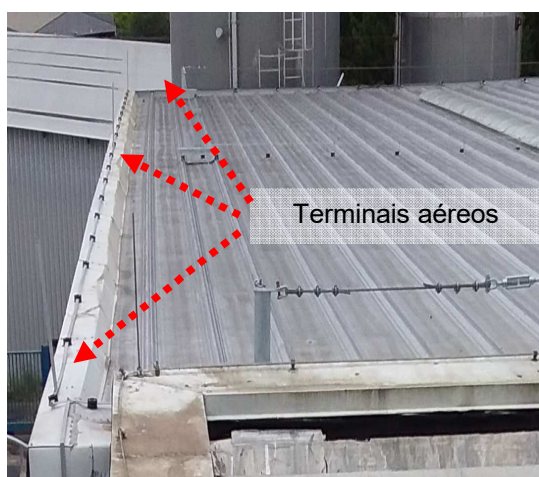
Figuras 291 e 292: Sistema captor existente – Ampliação Prédio RS7.
