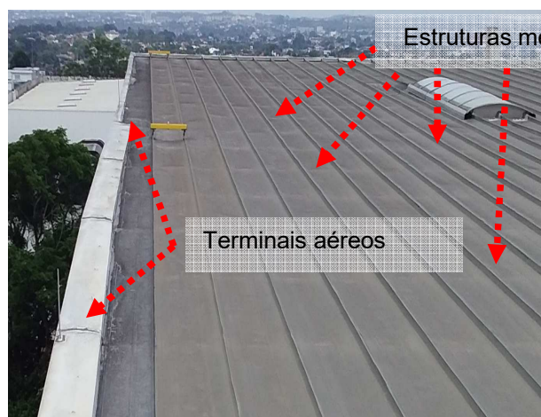
Figuras 159 e 160: Sistema captor natural e terminais aéreos existentes – RS7.
