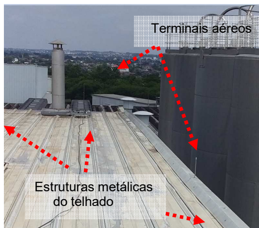
Figuras 204 e 205: Sistema de captor existente – RS6.
