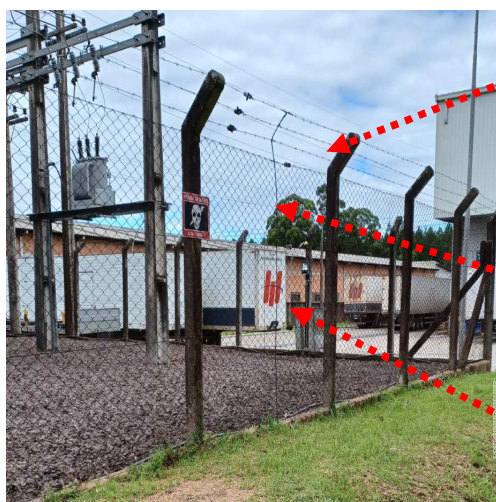
Figuras 327 e 328: Sistema de aterramento
