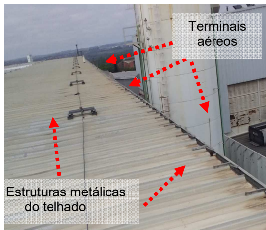
Figuras 204 e 205: Sistema de captor existente – RS6.
