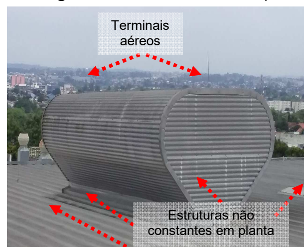
Figuras 149 e 150: Sistema captor existente e terminais aéreos– RS7
