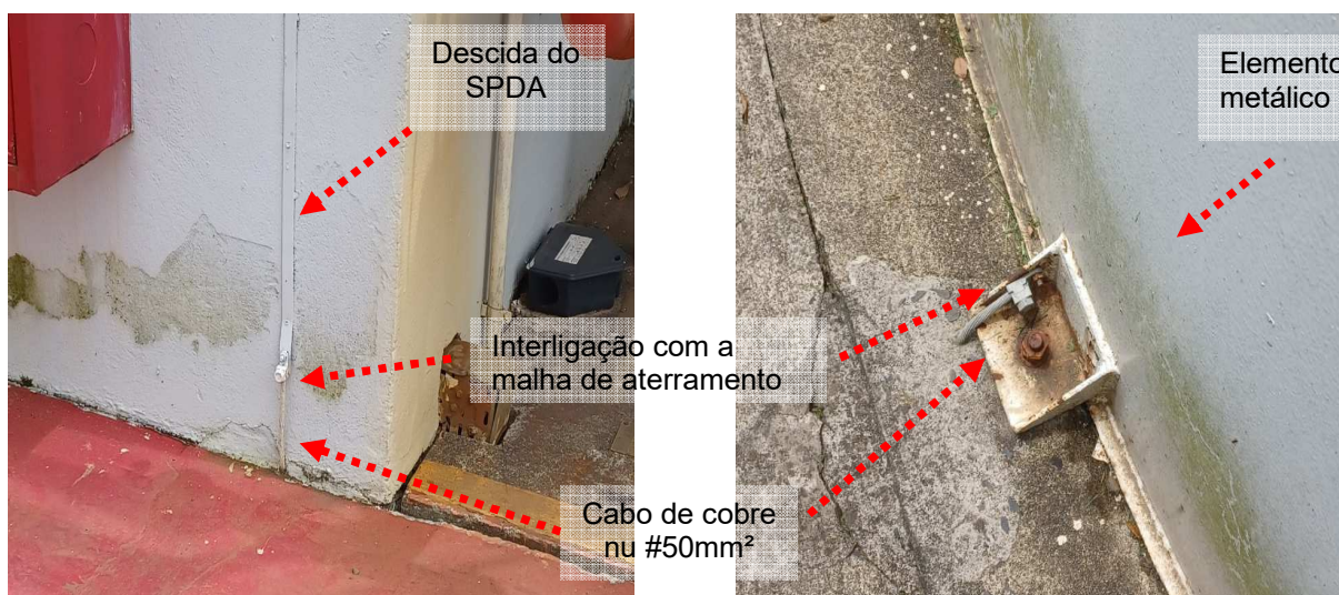
Figuras 41 e 42: Interligação da malha de aterramento com a descida do SPDA e elemento metálico (Tanque).
