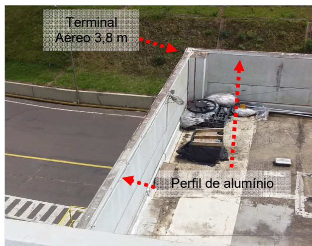
Figuras 200 e 201: Sistema de captor existente – RS6.
