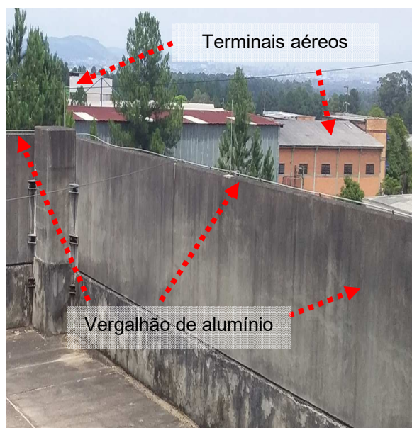
Figuras 57 e 58: Sistema captor existente – Subestação FNT
