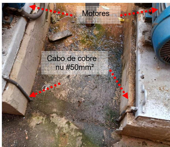
Figuras 129 e 130: Sistema de aterramento
