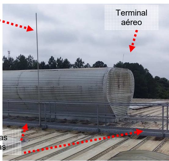
Figuras 214 e 215: Sistema de captor existente – RS6.
