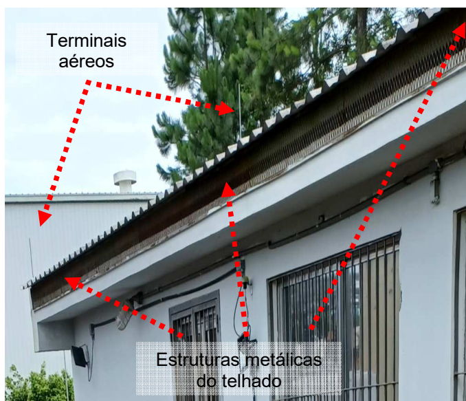
Figuras 16 e 17: Sistema captor existente – Sala de Painéis
