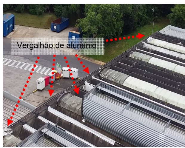
Figuras 149 e 150: Sistema captor existente e terminais aéreos– RS7
