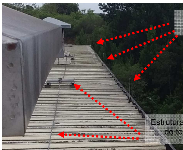
Figuras 210 e 211: Sistema de captor existente – RS6.
