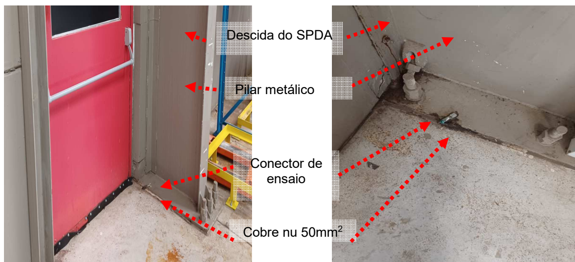
Figuras 238 e 239: Sistema de descidas naturais existentes – RS6.
