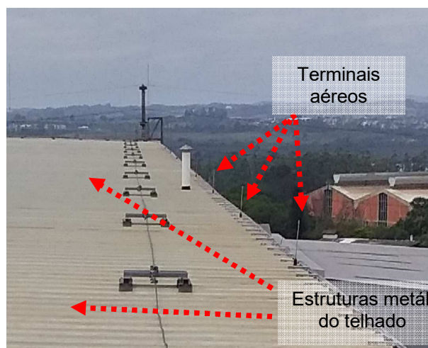
Figuras 206 e 207: Sistema de captor existente – RS6.
