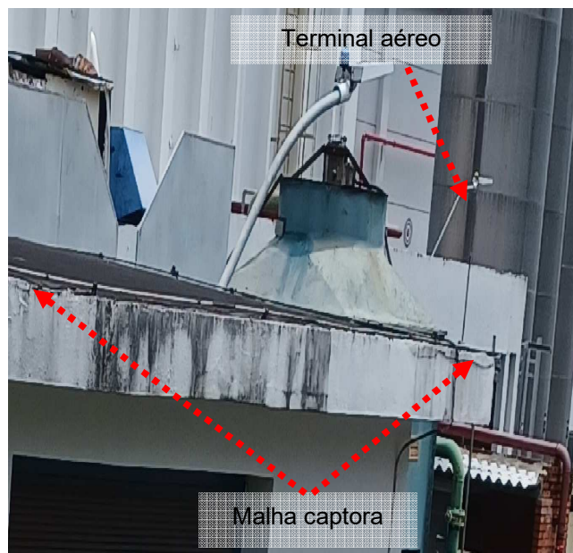
Figuras 44 e 45: Sistema captor existente – Subestação DU
