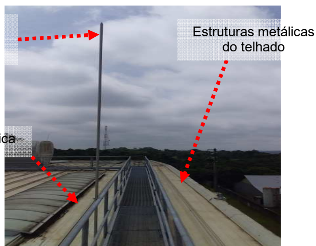
Figuras 212 e 213: Sistema de captor existente – RS6.
