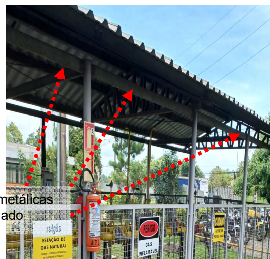
Figuras 274 e 275: Malha captora natural - Estruturas metálicas do telhado
