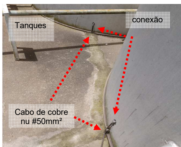
Figuras 131 e 132: Sistema de aterramento
