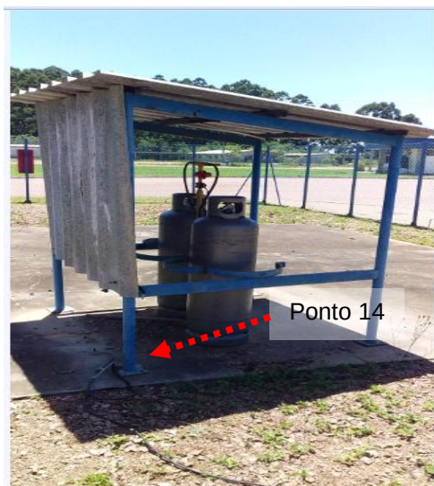
Figuras 28 e 29: Ponto 14- Ponto aterramento de estrutura (Pilar gás) - Medição 13.
