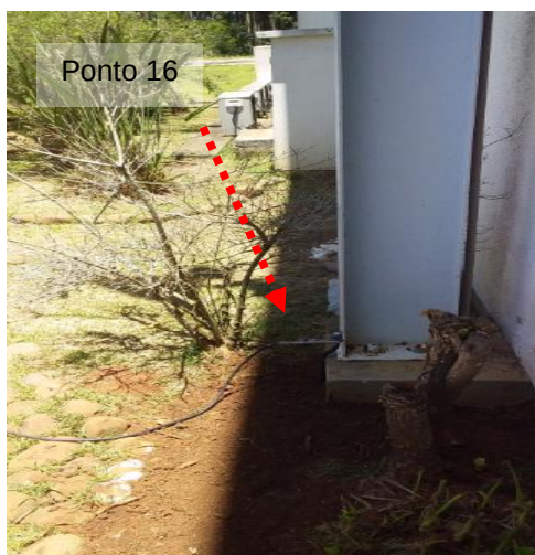
Figuras 30 e 31: Ponto 16- Aterramento pilar/Estoque de Produção (Descida SPDA) - Medição 14.
