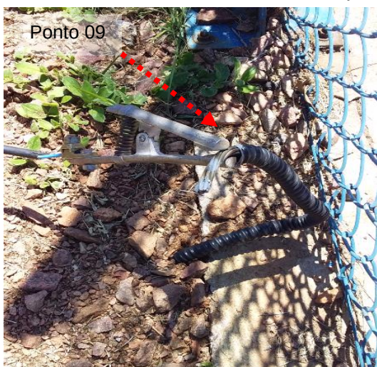
Figuras 18 e 19: Ponto 09- (Ponto aterramento cerca- Área Gás) - Medição 08.
