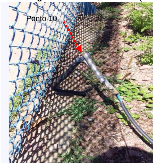
Figuras 20 e 21: Ponto 10-(Ponto aterramento cerca- Área Gás) - Medição 09.
