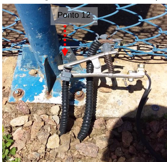
Figuras 24 e 25: Ponto 12- Ponto aterramento de estrutura (Pilar gás) - Medição 11.
