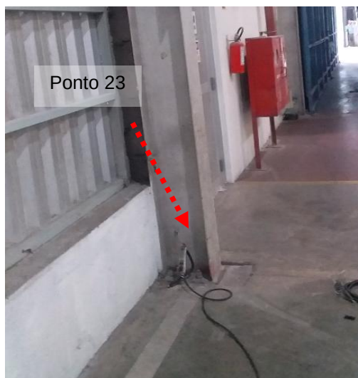
Figuras 40 e 41: Ponto 23- Atterramento Pilar/Estoque de Produção (Descida SPDA) - Medição 19.
