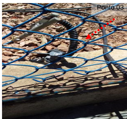
Figuras 06 e 07: Ponto 03 (Ponto aterramento cerca- Área Gás) – Medição 02
