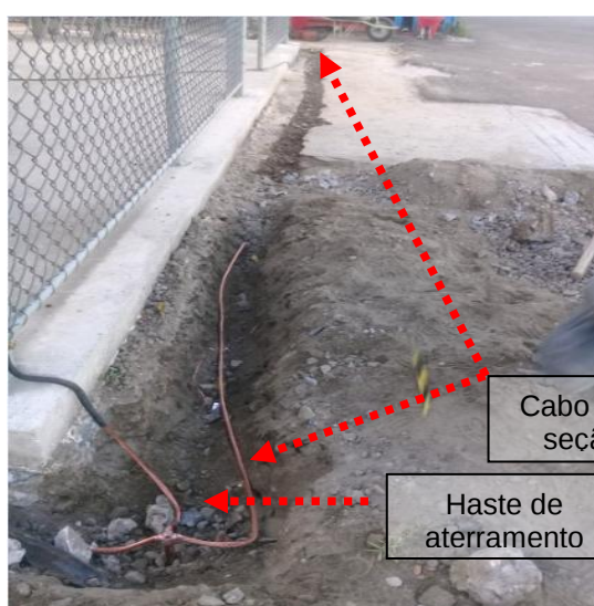
Figuras 84 e 85: Malha de aterramento implantada em cobre nu seção # 50mm 2 .
