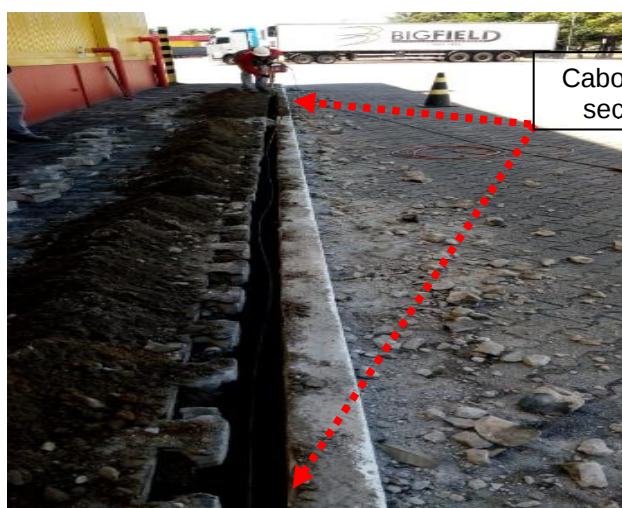
Figuras 284 e 285: Malha de aterramento implantada em cobre no seção # 50mm 2 .
