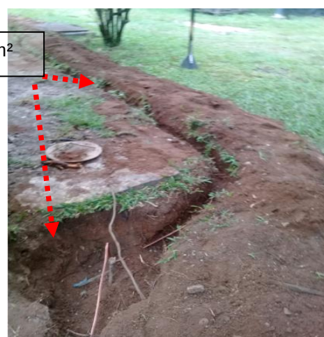
Figuras 25 e 26: Malha de aterramento através de cabo de core nu #50mm 2 .
