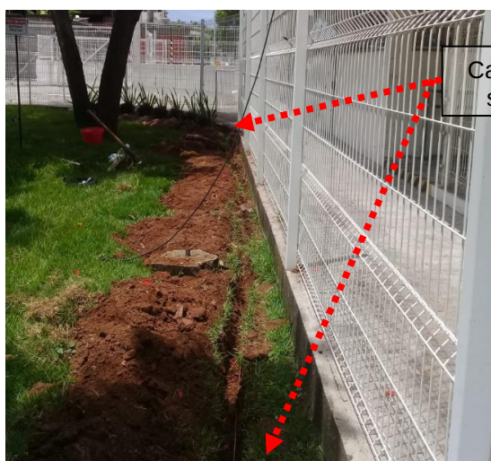
Figuras 132 e 133: Malha de aterramento implantada em cobre nu seção # 50mm 2 .
