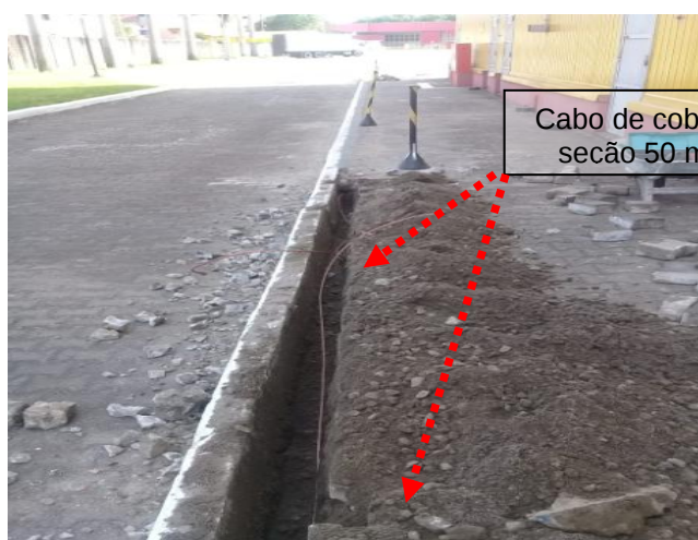
Figuras 268 e 269: Malha de aterramento implantada em cobre nu seção # 50mm 2 .
