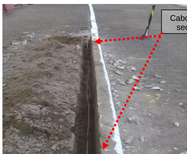
Figuras 262 e 263: Malha de aterramento implantada em cobre nu seção # 50mm 2 .
