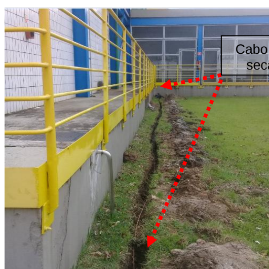
Figuras 63 e 64: Malha de aterramento implantada em cobre nu seção # 50mm 2 .
