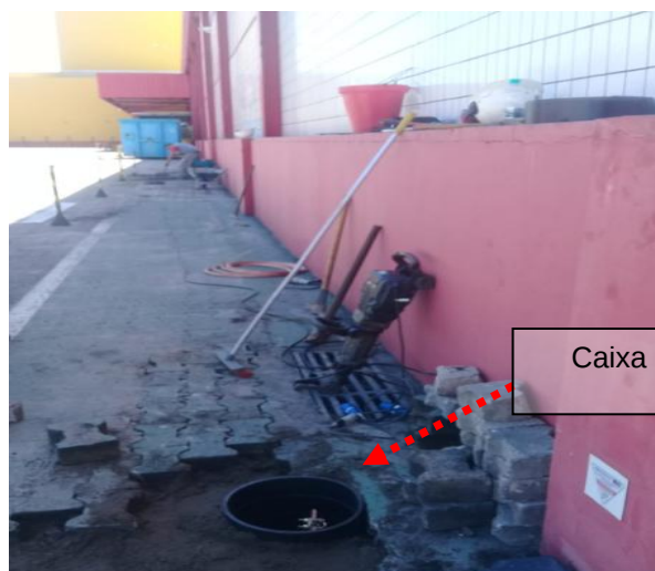
Figuras 296 e 297: Malha de aterramento implantada em cobre no seção # 50mm 2 .
