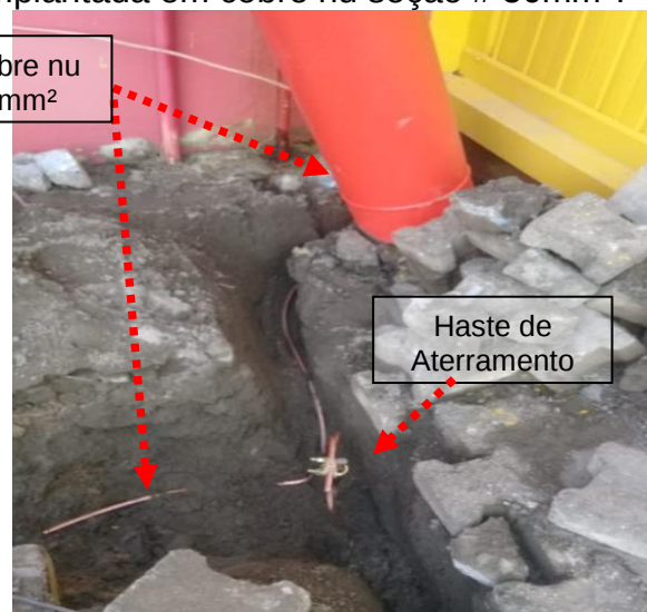
Figuras 252 e 253: Malha de aterramento implantada em cobre nu seção # 50mm 2 .
