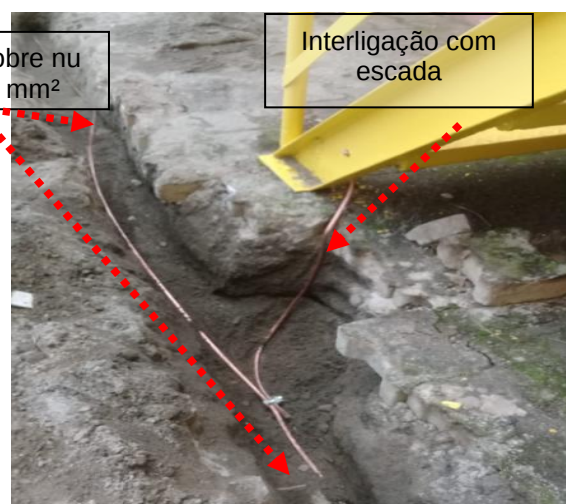
Figuras 250 e 251: Malha de aterramento implantada em cobre nu seção # 50mm 2 .
