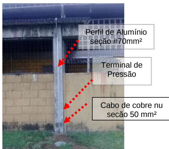
Figura 95: Descida convencional Implantada em Perfil de Alumínio seção 70mm 2 .
