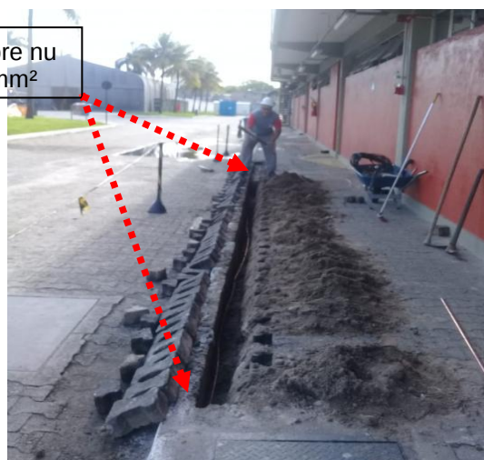
Figuras 167 e 168: Malha de aterramento implantada em cobre no seção # 50mm 2 .
