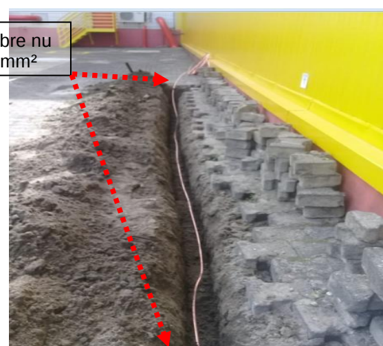
Figuras 256 e 257: Malha de aterramento implantada em cobre nu seção # 50mm 2 .
