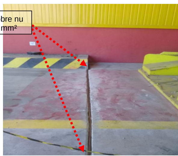
Figuras 288 e 289: Malha de aterramento implantada em cobre no seção # 50mm 2 .
