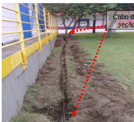
Figuras 59 e 60: Malha de aterramento implantada em cobre nu seção # 50mm 2 .
