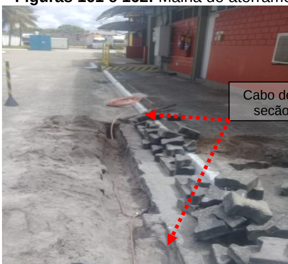
Figuras 163 e 164: Malha de aterramento implantada em cobre nu seção # 50mm 2 .
