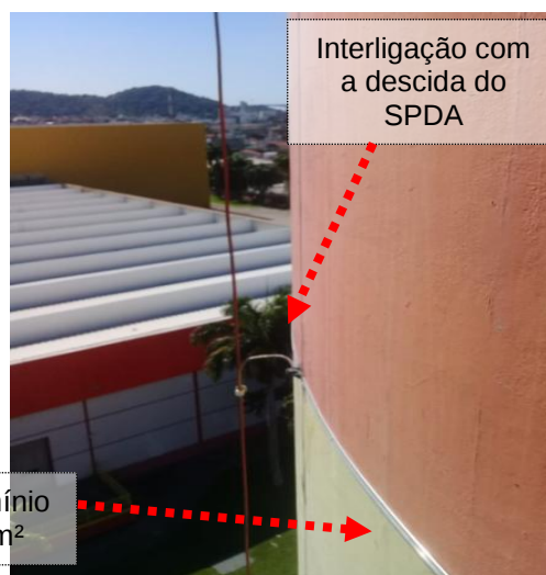
Figuras 208 e 209: Instalação de anéis de cintamento conf. tabela 04 da NBR 5419-3:2015
