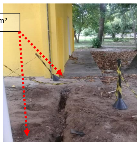
Figuras 31 e 32: Malha de aterramento através de cabo de core nu #50mm².
