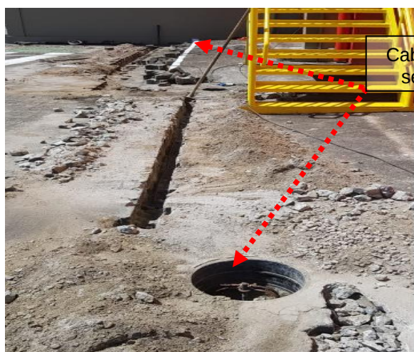
Figuras 193 e 194: Malha de aterramento implantada em cobre nu seção # 50mm 2 .
