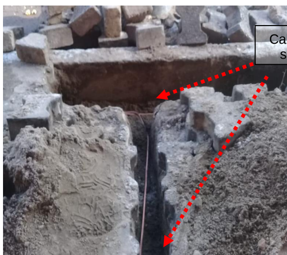
Figuras 169 e 170: Malha de aterramento implantada em cobre no seção # 50mm 2 .
