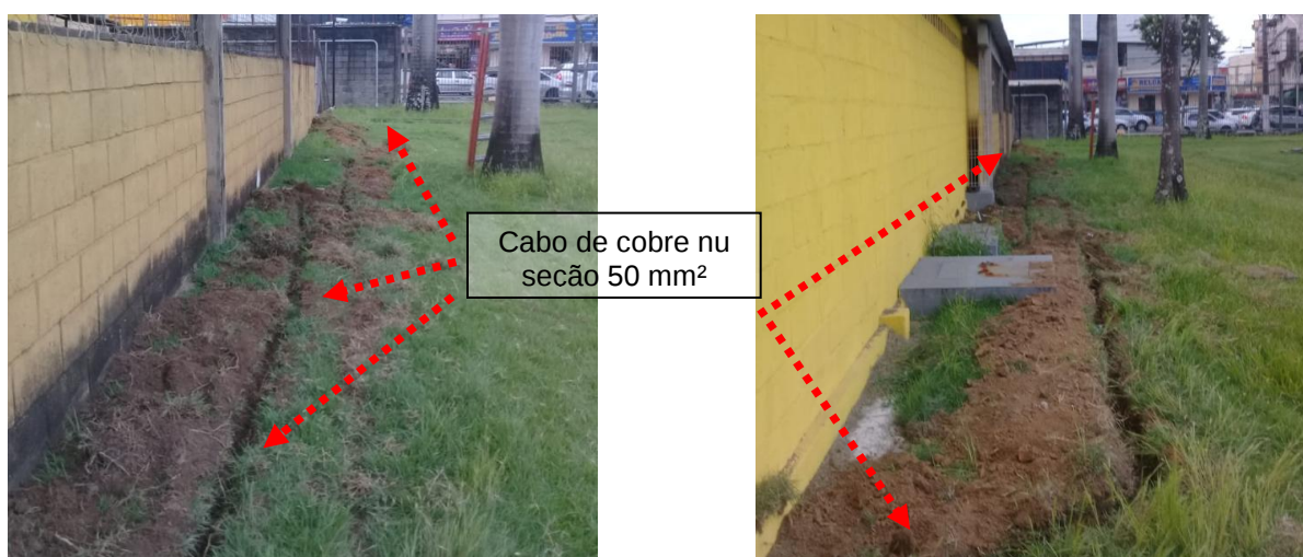
Figuras 100 e 101: Malha de aterramento implantada em cobre nu seção # 50mm 2 .
