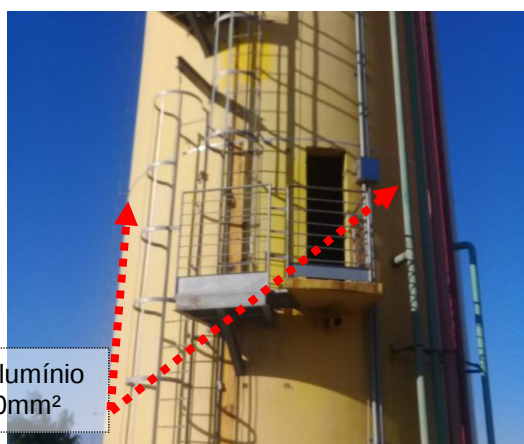
Figuras 204 e 205: Instalação de anéis de cintamento conf. tabela 04 da NBR 5419-3:2015
