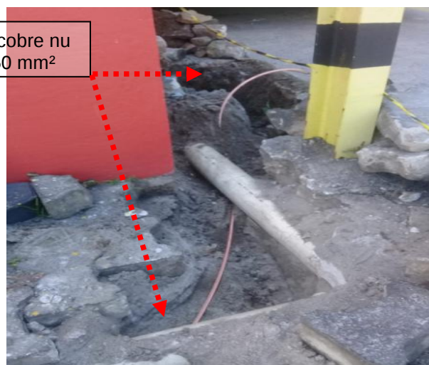
Figuras 286 e 287: Malha de aterramento implantada em cobre no seção # 50mm 2 .
