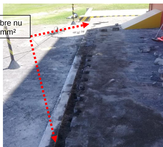
Figuras 260 e 261: Malha de aterramento implantada em cobre nu seção # 50mm 2 .
