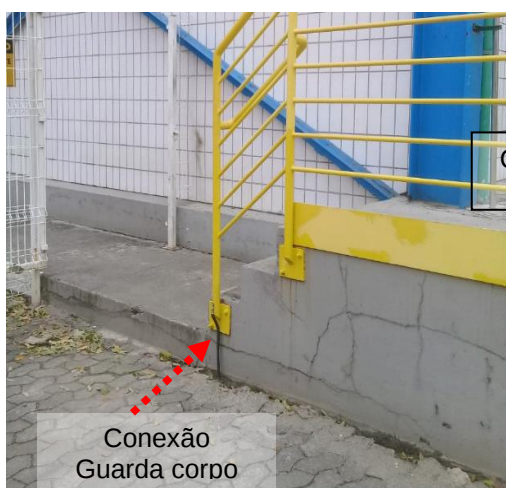
Figuras 65 e 66: Malha de aterramento implantada em cobre nu seção # 50mm 2 .
