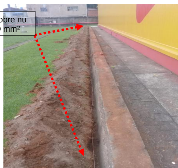
Figuras 270 e 271: Malha de aterramento implantada em cobre nu seção # 50mm 2 .
