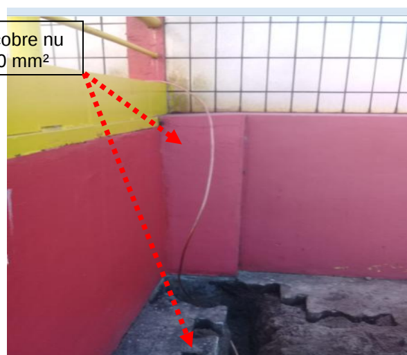
Figuras 298 e 299: Malha de aterramento implantada em cobre no seção # 50mm 2 .
