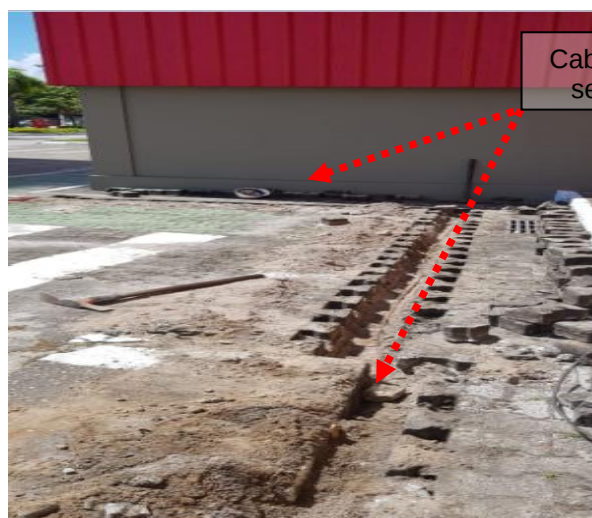
Figuras 191 e 192: Malha de aterramento implantada em cobre nu seção # 50mm 2 .
