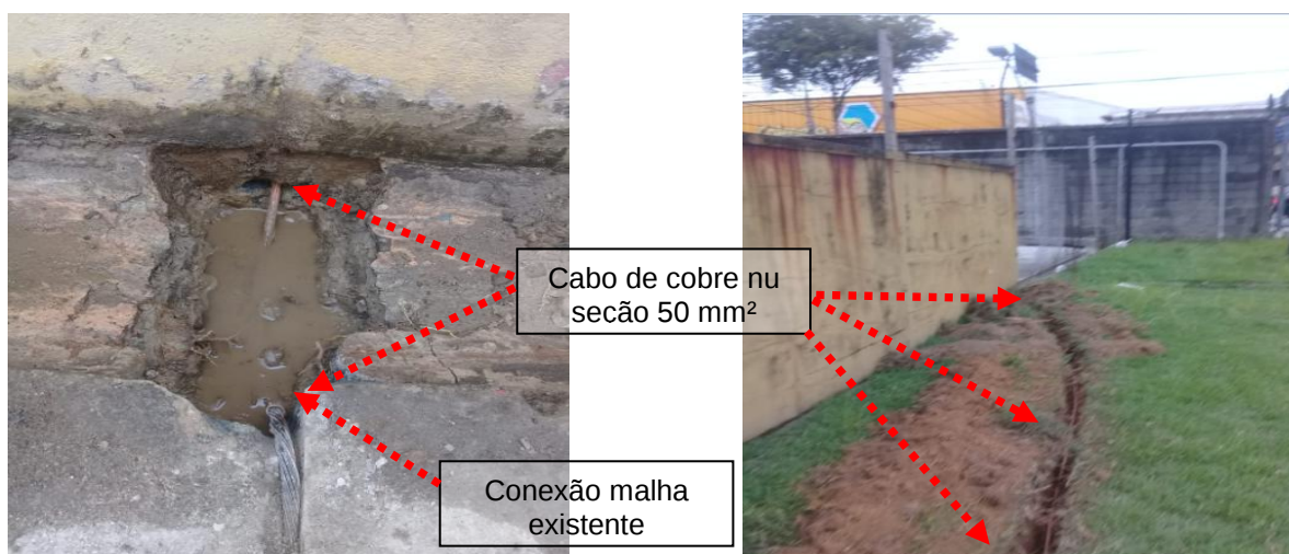
Figuras 96 e 97: Malha de aterramento implantada em cobre nu seção # 50mm 2 .
