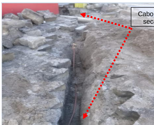
Figuras 286 e 287: Malha de aterramento implantada em cobre no seção # 50mm 2 .
