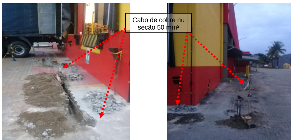
Figuras 153 e 154: Malha de aterramento implantada em cobre nu seção # 50mm 2 .
