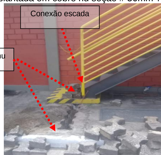
Figuras 163 e 164: Malha de aterramento implantada em cobre nu seção # 50mm 2 .
