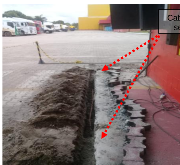
Figuras 195 e 196: Malha de aterramento implantada em cobre nu seção # 50mm 2 .
