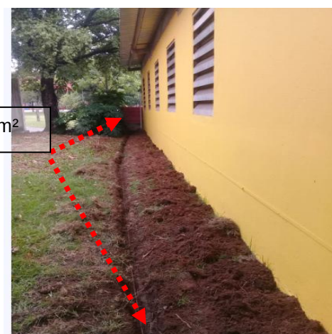
Figuras 23 e 24: Caixa de solo/Malha de aterramento através de cabo de core nu #50mm 2 .
