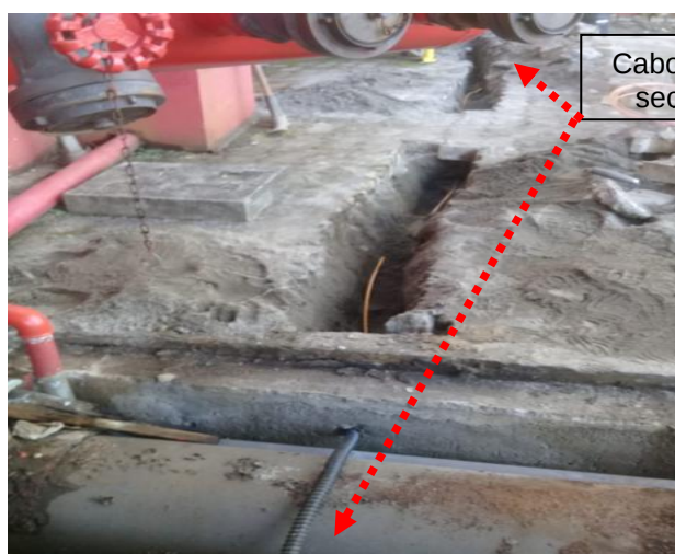
Figuras 250 e 251: Malha de aterramento implantada em cobre nu seção # 50mm 2 .
