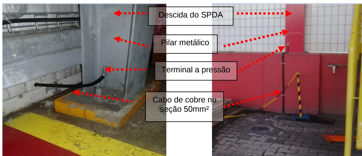
Figuras 226 e 227: Descidas naturais implantadas - Pilares metálicos.
