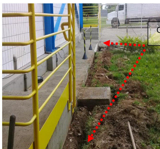
Figuras 67 e 68: Malha de aterramento implantada em cobre nu seção # 50mm 2 .
