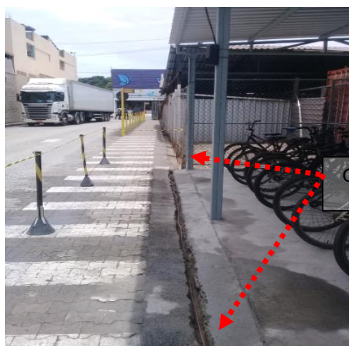
Figuras 80 e 81: Malha de aterramento implantada em cobre nu seção # 50mm 2 .
