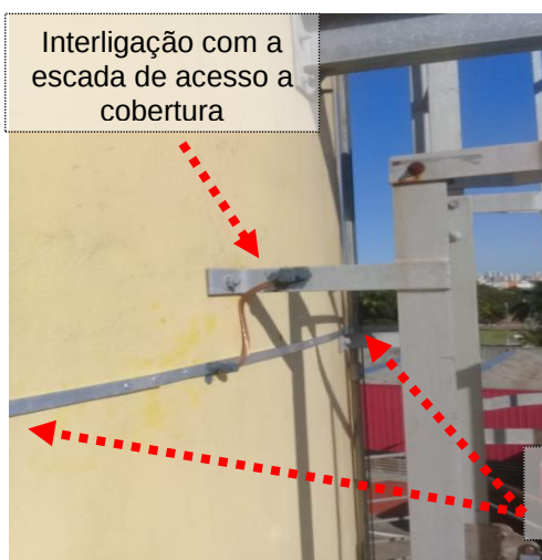
Figuras 206 e 207: Instalação de anéis de cintamento conf. tabela 04 da NBR 5419-3:2015.
