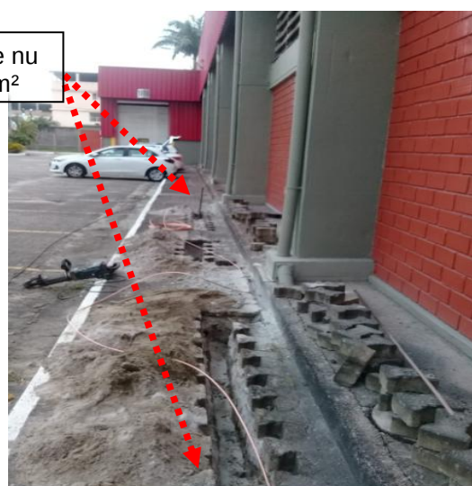
Figuras 185 e 186: Malha de aterramento implantada em cobre nu seção # 50mm 2 .
