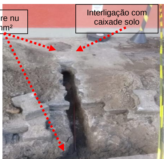
Figuras 171 e 172: Malha de aterramento implantada em cobre no seção # 50mm 2 .
