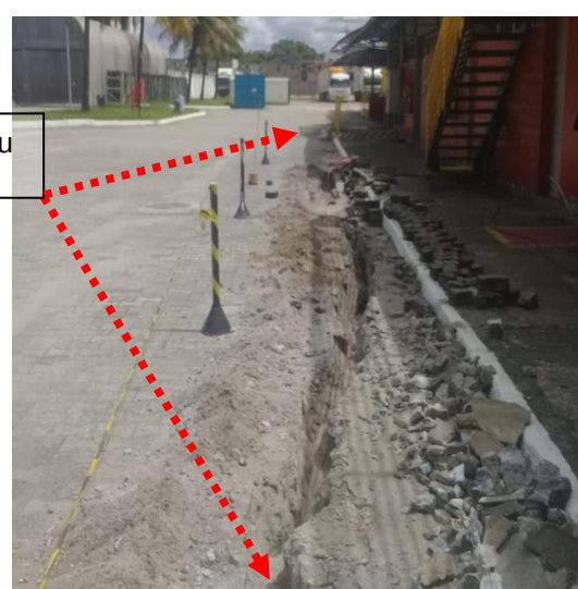
Figuras 165 e 166: Malha de aterramento implantada em cobre nu seção # 50mm 2 .
