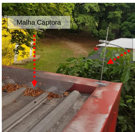
Figuras 36 e 37: Terminais aéreos em aço galvanizado de 60 cm fixados sobre a malha captora da edificação.
