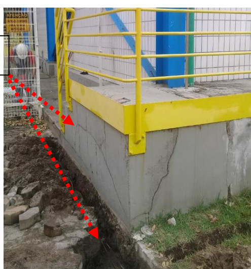
Figuras 63 e 64: Malha de aterramento implantada em cobre nu seção # 50mm 2 .
