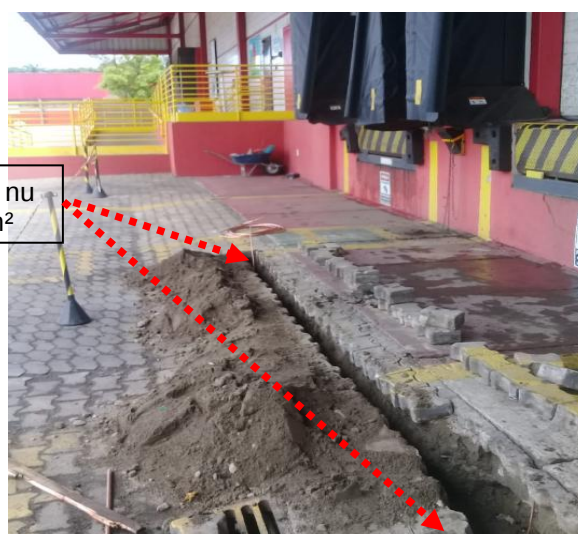
Figuras 242 e 243: Malha de aterramento implantada em cobre nu seção # 50mm 2 .
