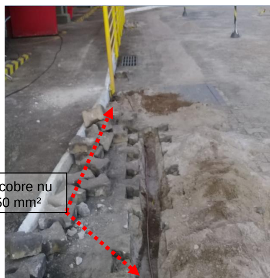
Figuras 155 e 156: Malha de aterramento implantada em cobre nu seção # 50mm 2 .
