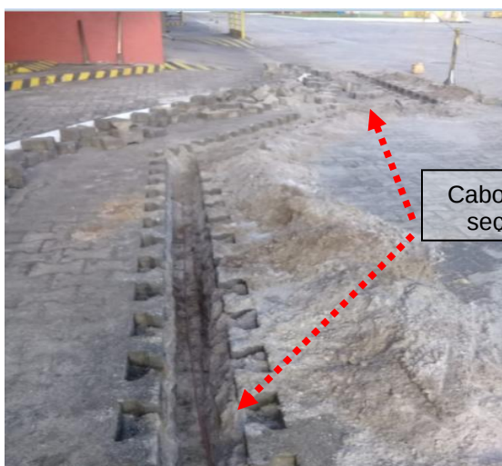
Figuras 159 e 160: Malha de aterramento implantada em cobre nu seção # 50mm 2 .
