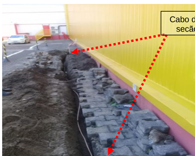
Figuras 258 e 259: Malha de aterramento implantada em cobre nu seção # 50mm 2 .
