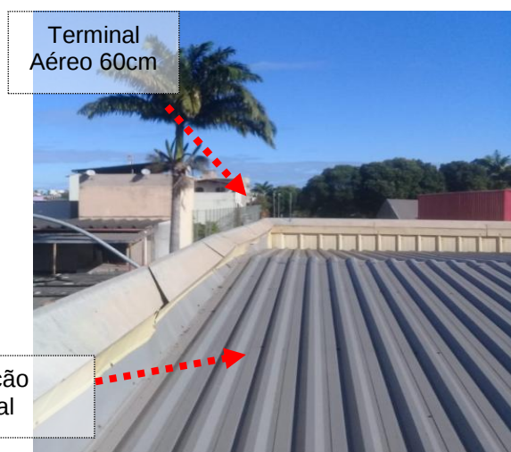
Figuras 109 e 110: Terminais aéreos em aço galvanizado de 60 cm fixado na captação
