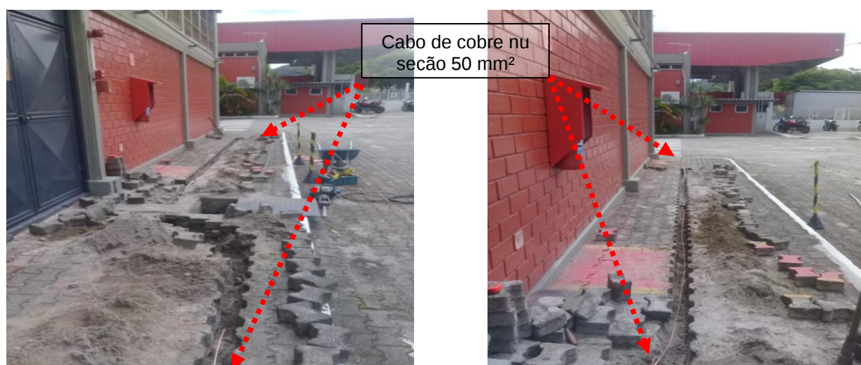
Figuras 177 e 178: Malha de aterramento implantada em cobre nu seção # 50mm 2 .
