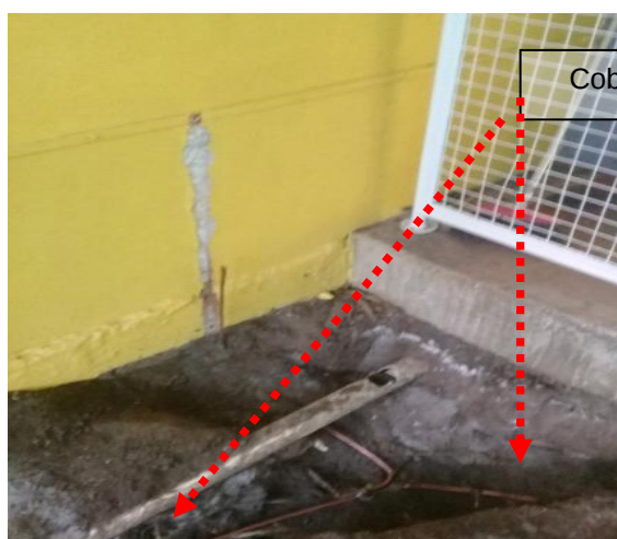
Figuras 31 e 32: Malha de aterramento através de cabo de core nu #50mm².
