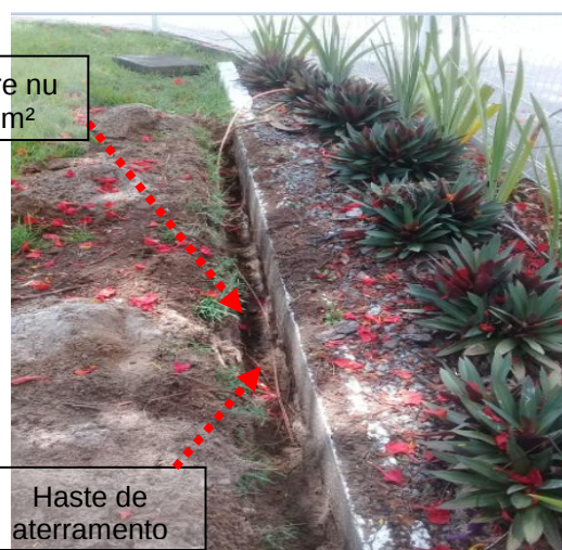
Figuras 132 e 133: Malha de aterramento implantada em cobre nu seção # 50mm 2 .
