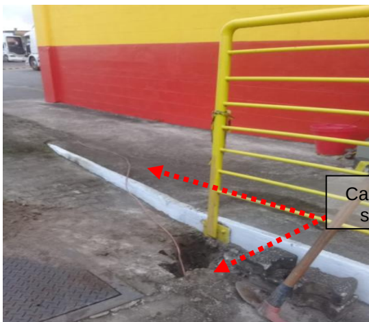
Figuras 157 e 158: Malha de aterramento implantada em cobre nu seção # 50mm 2 .
