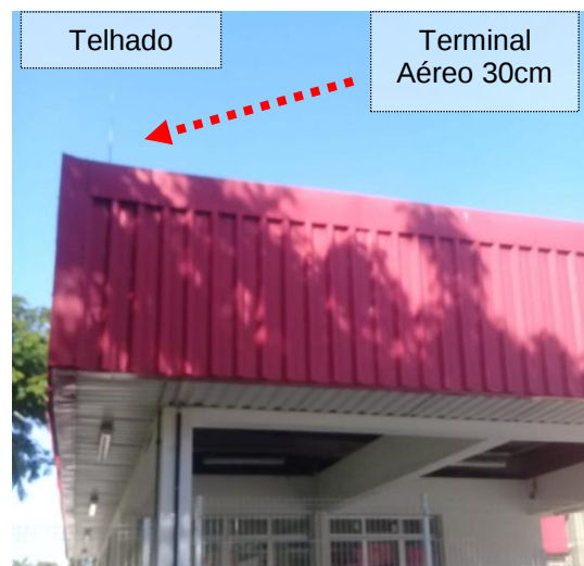
Figuras 120 e 121: Terminais aéreos em aço galvanizado de 30 cm fixados diretamente sobre as estruturas metálicas do telhado da instalação.
