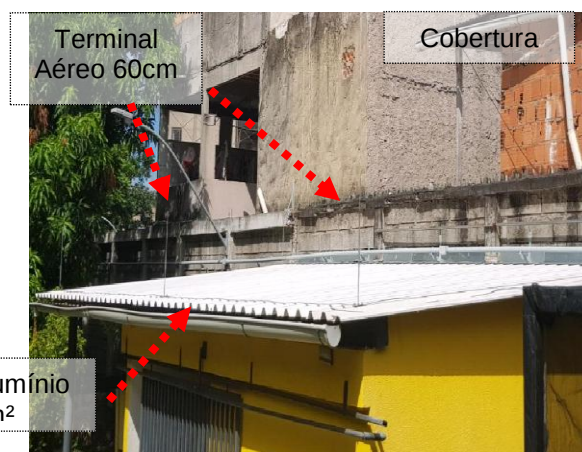
Figuras 06 e 07: Terminais aéreos em aço galvanizado de 60 cm fixados sobre perfil de alumínio de seção 70mm² na cobertura da edificação.
