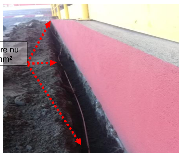
Figuras 236 e 237: Malha de aterramento implantada em cobre no seção # 50mm 2 .
