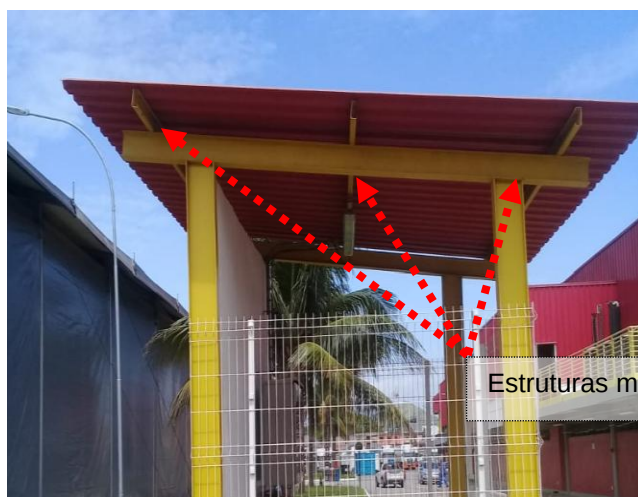
Figuras 303 e 304: Sistema Captor natural através das estruturas metálicas do telhado.
