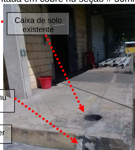
Figuras 106 e 107: Malha de aterramento implantada em cobre nu seção # 50mm 2 .
