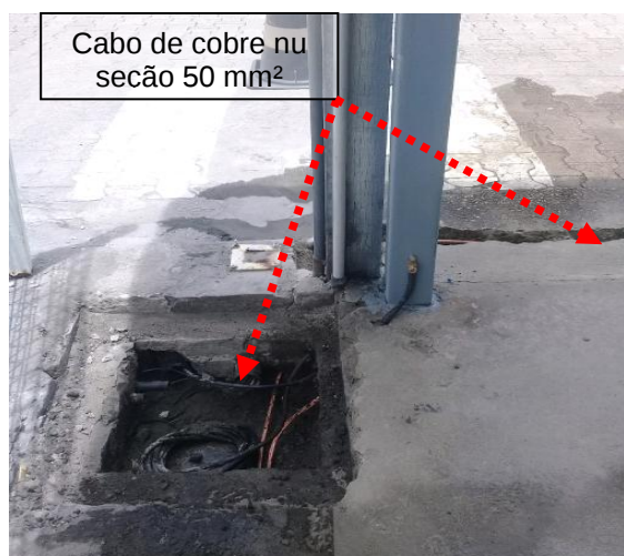
Figuras 82 e 83: Malha de aterramento implantada em cobre nu seção # 50mm 2 .
