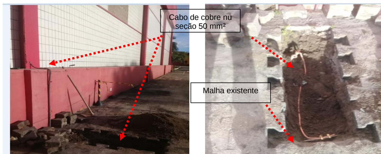
Figuras 292 e 293: Malha de aterramento implantada em cobre nu seção # 50mm 2 .
