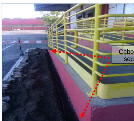
Figuras 238 e 239: Malha de aterramento implantada em cobre no seção # 50mm 2 .
