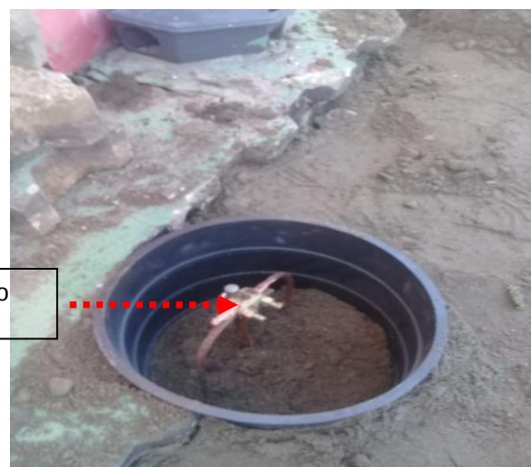
Figuras 296 e 297: Malha de aterramento implantada em cobre no seção # 50mm 2 .
