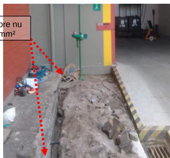
Figuras 187 e 188: Malha de aterramento implantada em cobre nu seção # 50mm 2 .
