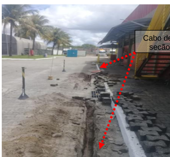
Figuras 165 e 166: Malha de aterramento implantada em cobre nu seção # 50mm 2 .
