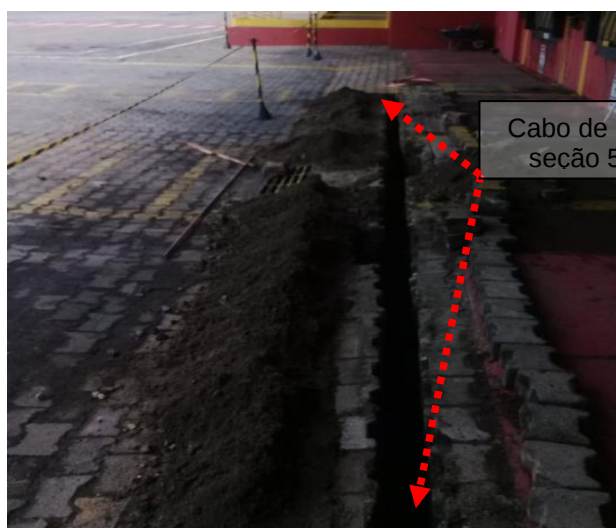
Figuras 244 e 245: Malha de aterramento implantada em cobre nu seção # 50mm 2 .
