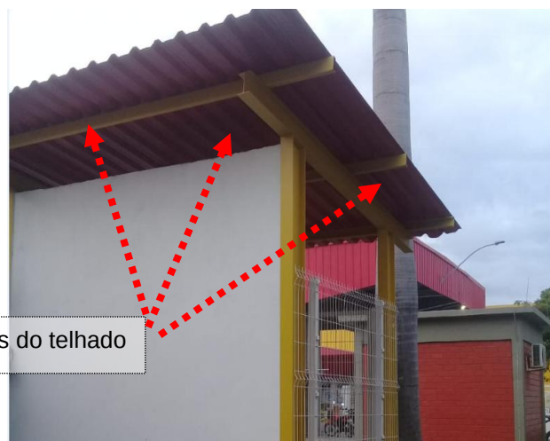
Figuras 303 e 304: Sistema Captor natural através das estruturas metálicas do telhado.
