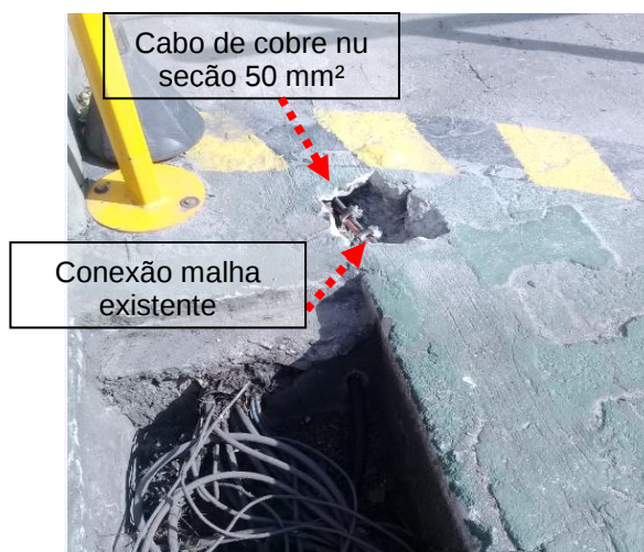
Figuras 82 e 83: Malha de aterramento implantada em cobre nu seção # 50mm 2 .
