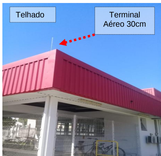
Figuras 120 e 121: Terminais aéreos em aço galvanizado de 30 cm fixados diretamente sobre as estruturas metálicas do telhado da instalação.
