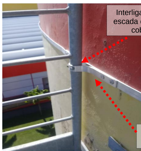
Figuras 208 e 209: Instalação de anéis de cintamento conf. tabela 04 da NBR 5419-3:2015
