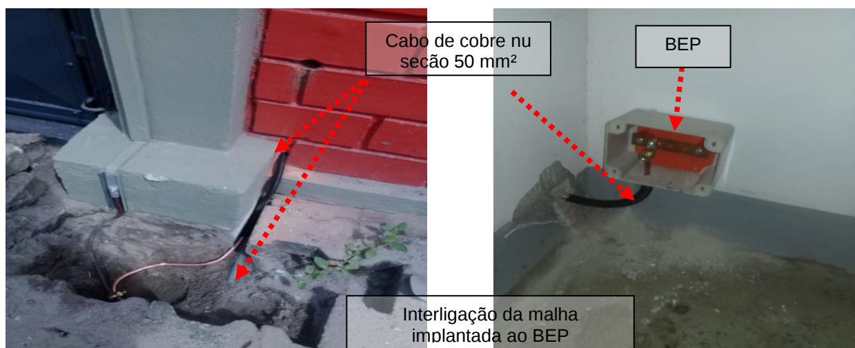
Figuras 201 e 202: Malha de aterramento implantada em cobre nu seção # 50mm 2 .
