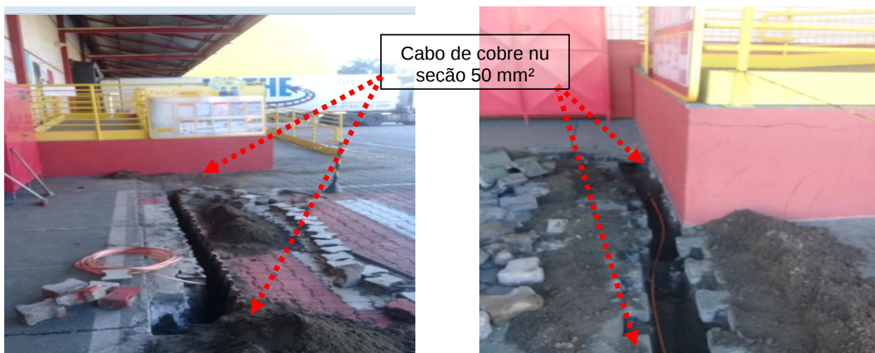
Figuras 232 e 233: Malha de aterramento implantada em cobre nu seção # 50mm 2 .
