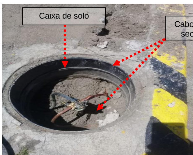
Figuras 260 e 261: Malha de aterramento implantada em cobre nu seção # 50mm 2 .
