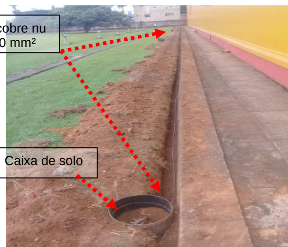
Figuras 274 e 275: Malha de aterramento implantada em cobre nu seção # 50mm 2 .
