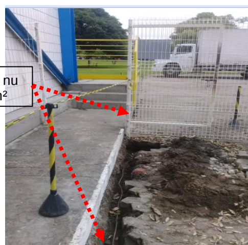
Figuras 65 e 66: Malha de aterramento implantada em cobre nu seção # 50mm 2 .
