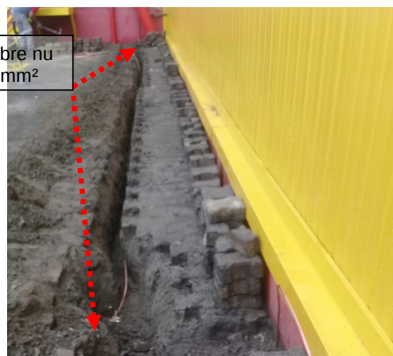
Figuras 254 e 255: Malha de aterramento implantada em cobre nu seção # 50mm 2 .
