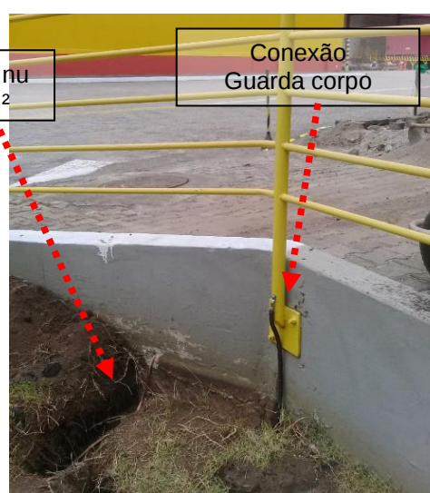
Figuras 51 e 52: Malha de aterramento implantada em cobre nu seção # 50mm 2 .
