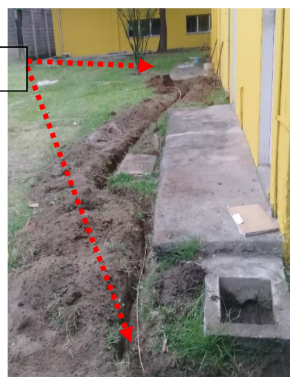
Figuras 27 e 28: Malha de aterramento através de cabo de core nu #50mm 2 .
