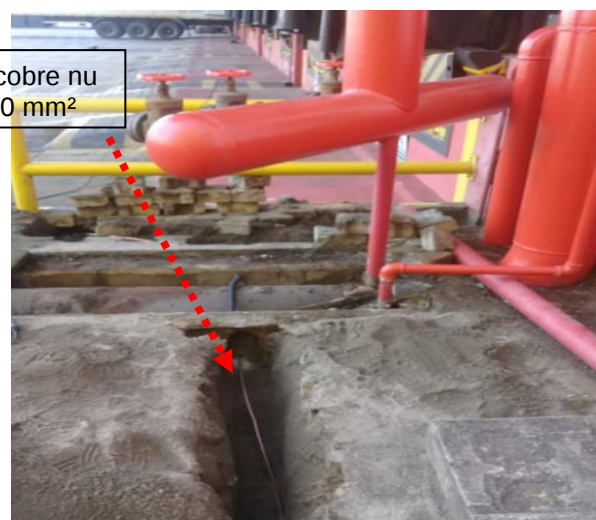
Figuras 248 e 249: Malha de aterramento implantada em cobre nu seção # 50mm 2 .
