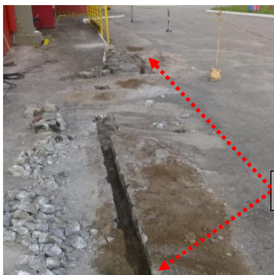
Figuras 155 e 156: Malha de aterramento implantada em cobre nu seção # 50mm 2 .
