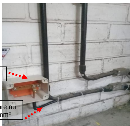
Figuras 300 e 301: BEP's – Interligação com a malha implantada.
