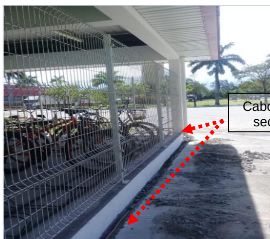
Figuras 130 e 131: Malha de aterramento implantada em cobre nu seção # 50mm 2 .
