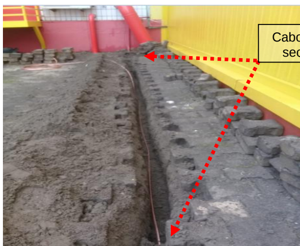
Figuras 254 e 255: Malha de aterramento implantada em cobre nu seção # 50mm 2 .
