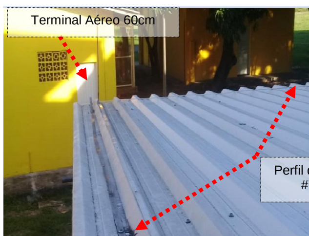
Figuras 10 e 11: Terminais aéreos com 60cm de altura fixados sobre perfil de alumínio de seção 70mm² na cobertura da edificação.
