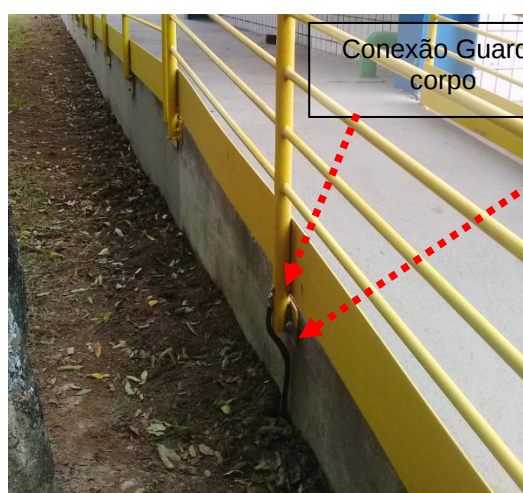
Figuras 49 e 50: Malha de aterramento implantada em cobre nu seção # 50mm 2 .
