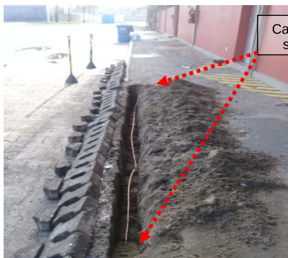
Figuras 167 e 168: Malha de aterramento implantada em cobre no seção # 50mm 2 .
