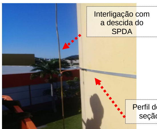
Figuras 204 e 205: Instalação de anéis de cintamento conf. tabela 04 da NBR 5419-3:2015
