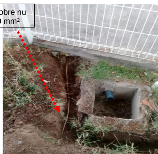
Figuras 136 e 137: Malha de aterramento implantada em cobre nu seção # 50mm 2 .
