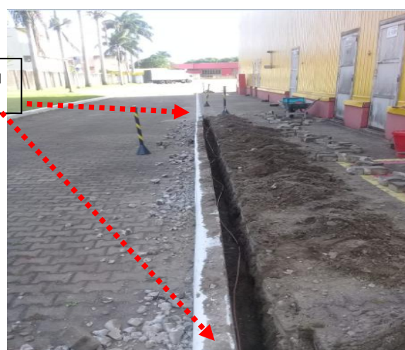
Figuras 268 e 269: Malha de aterramento implantada em cobre nu seção # 50mm 2 .
