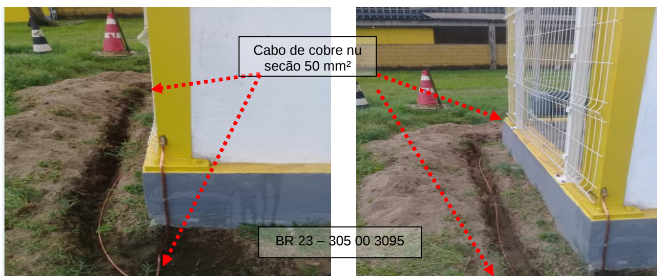
Figuras 341 e 342: Malha de aterramento implantada em cobre nu seção # 50mm 2 .
