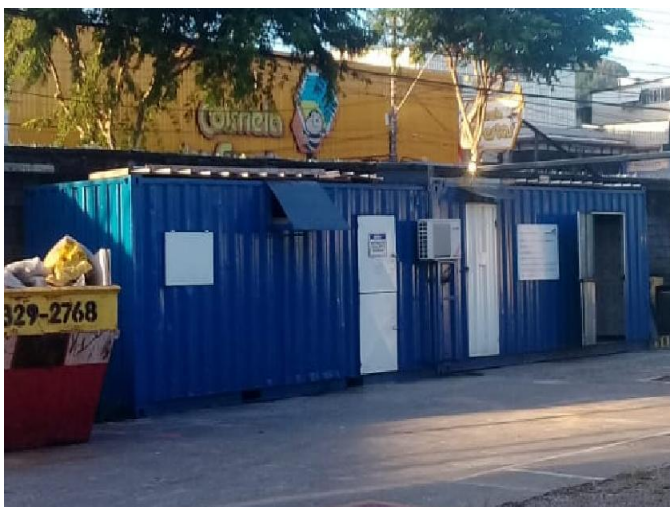
Figura 70: Canteiro de obras 01
