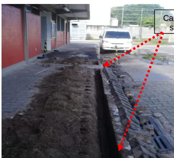
Figuras 171 e 172: Malha de aterramento implantada em cobre no seção # 50mm 2 .
