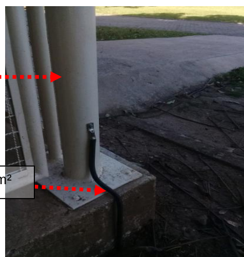
Figuras 33 e 34: Interligação da malha de aterramento através de cabo de core nu #50mm² a estruturas existentes no entorno da instalação.
