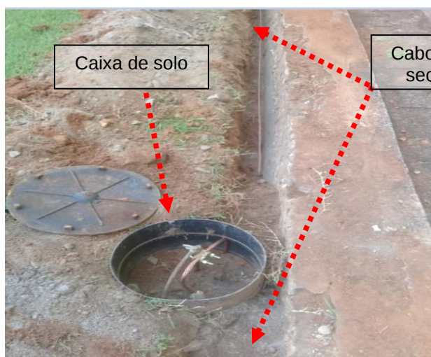
Figuras 272 e 273: Malha de aterramento implantada em cobre nu seção # 50mm 2 .
