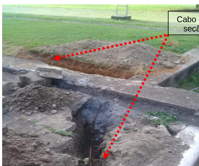
Figuras 270 e 271: Malha de aterramento implantada em cobre nu seção # 50mm 2 .
