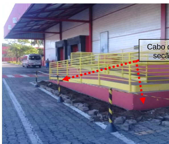
Figuras 236 e 237: Malha de aterramento implantada em cobre no seção # 50mm 2 .
