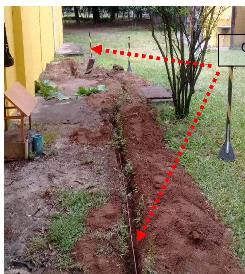
Figuras 27 e 28: Malha de aterramento através de cabo de core nu #50mm 2 .
