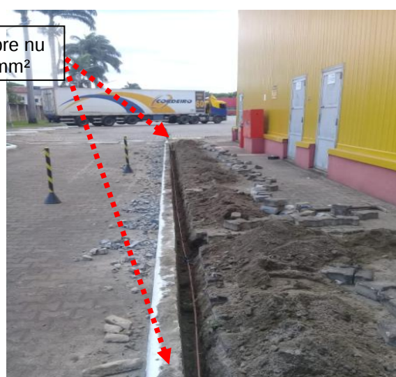
Figuras 264 e 265: Malha de aterramento implantada em cobre nu seção # 50mm 2 .
