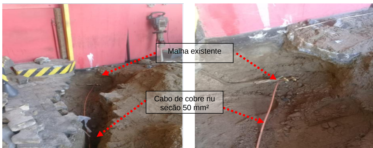
Figuras 290 e 291: Malha de aterramento implantada em cobre nu seção # 50mm 2 .
