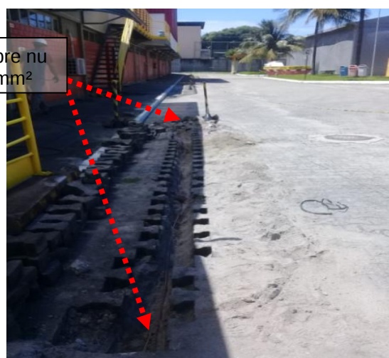
Figuras 161 e 162: Malha de aterramento implantada em cobre nu seção # 50mm 2 .
