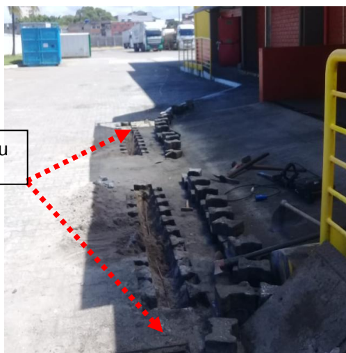
Figuras 159 e 160: Malha de aterramento implantada em cobre nu seção # 50mm 2 .
