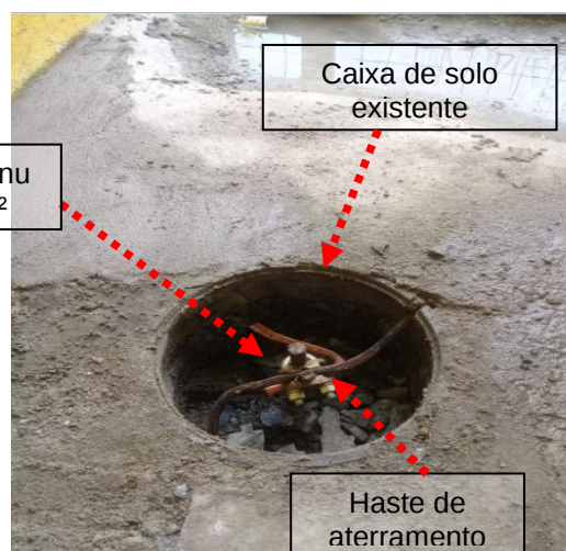
Figuras 102 e 103: Malha de aterramento implantada em cobre nu seção # 50mm 2 .
