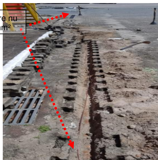
Figuras 191 e 192: Malha de aterramento implantada em cobre nu seção # 50mm 2 .
