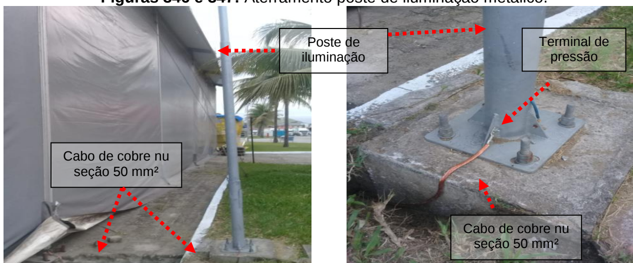
Figuras 348 e 349: Aterramento poste de iluminação metálico.
