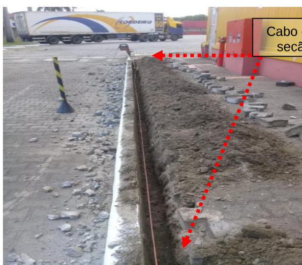
Figuras 264 e 265: Malha de aterramento implantada em cobre nu seção # 50mm 2 .
