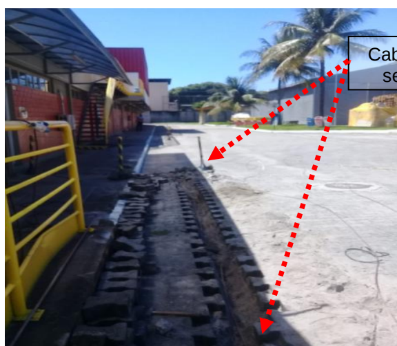
Figuras 161 e 162: Malha de aterramento implantada em cobre nu seção # 50mm 2 .
