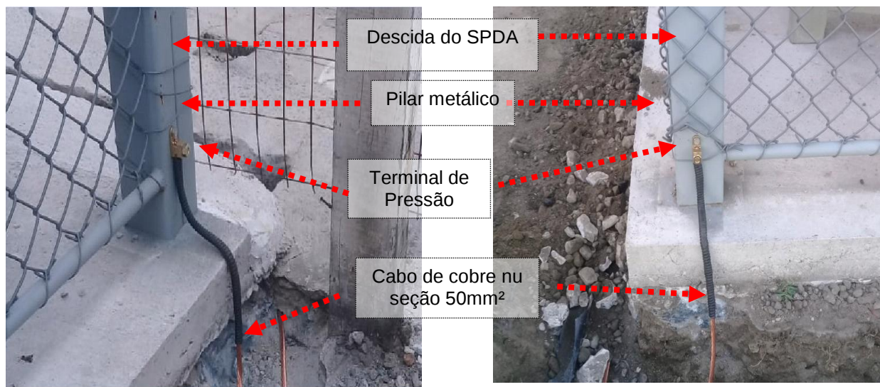
Figuras 78 e 79: Descida natural implantada através dos pilares metálicos da edificação.
