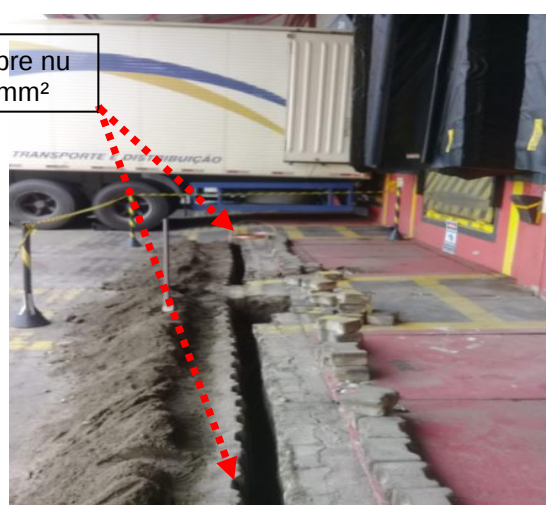
Figuras 246 e 247: Malha de aterramento implantada em cobre nu seção # 50mm 2 .
