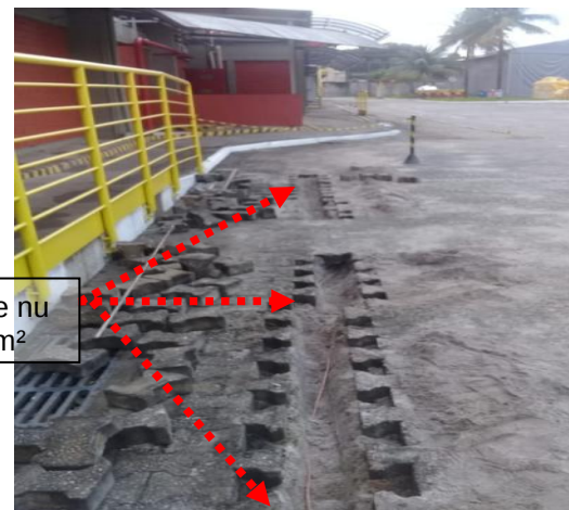
Figuras 157 e 158: Malha de aterramento implantada em cobre nu seção # 50mm 2 .
