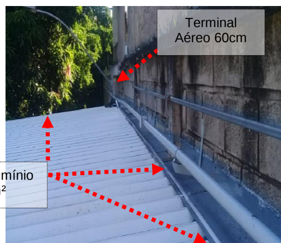
Figuras 10 e 11: Terminais aéreos com 60cm de altura fixados sobre perfil de alumínio de seção 70mm² na cobertura da edificação.
