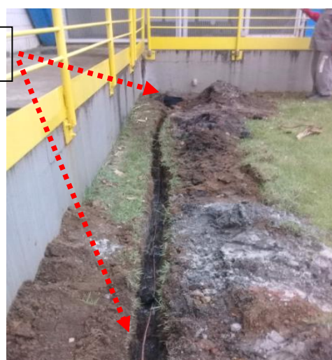
Figuras 61 e 62: Caixa de solo - Malha de aterramento cobre nu seção # 50mm 2 .
