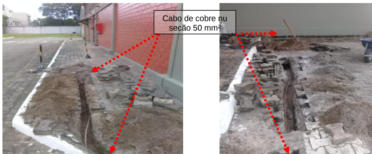
Figuras 179 e 180: Malha de aterramento implantada em cobre nu seção # 50mm 2 .
