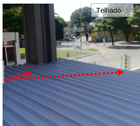
Figuras 113 e 114: Terminal aéreo em aço galvanizado de 30 cm e malha captora em perfil de alumínio #70mm 2 distribuída no entorno do telhado em cota mais baixa.
