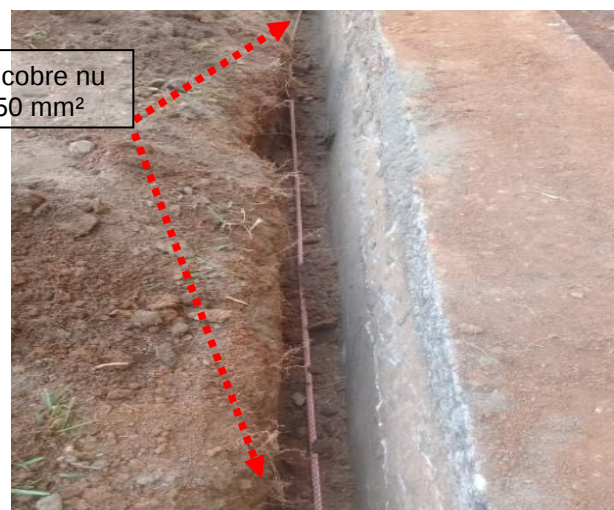
Figuras 272 e 273: Malha de aterramento implantada em cobre nu seção # 50mm 2 .
