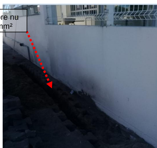
Figuras 138 e 139: Malha de aterramento implantada em cobre nu seção # 50mm 2 .
