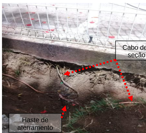
Figuras 134 e 135: Malha de aterramento implantada em cobre nu seção # 50mm 2 .
