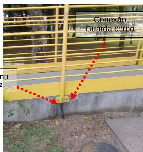
Figuras 47 e 48: Caixa de solo / Conexão guarda corpo em cobre nu seção # 50mm 2 .
