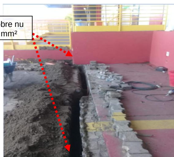
Figuras 240 e 241: Malha de aterramento implantada em cobre no seção # 50mm 2 .
