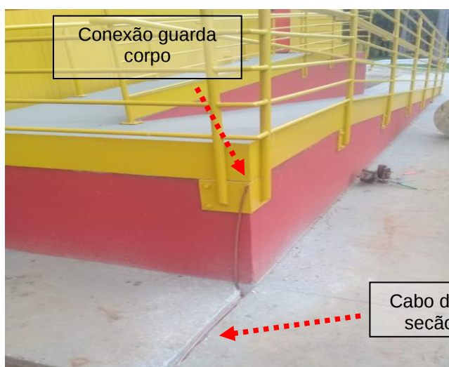
Figuras 276 e 277: Malha de aterramento implantada em cobre nu seção # 50mm 2 .
