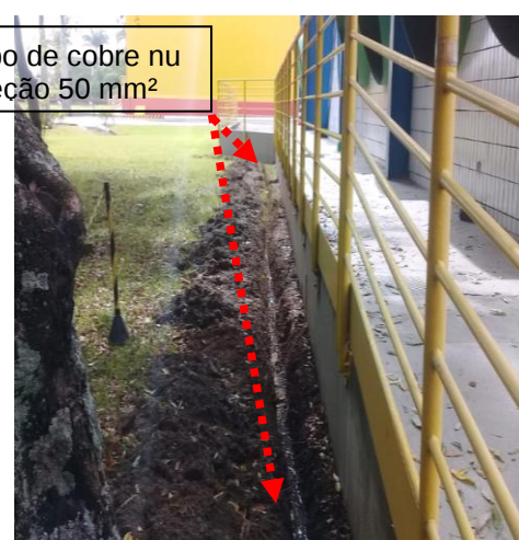
Figuras 49 e 50: Malha de aterramento implantada em cobre nu seção # 50mm 2 .
