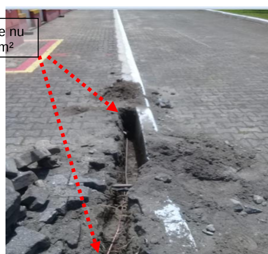
Figuras 258 e 259: Malha de aterramento implantada em cobre nu seção # 50mm 2 .
