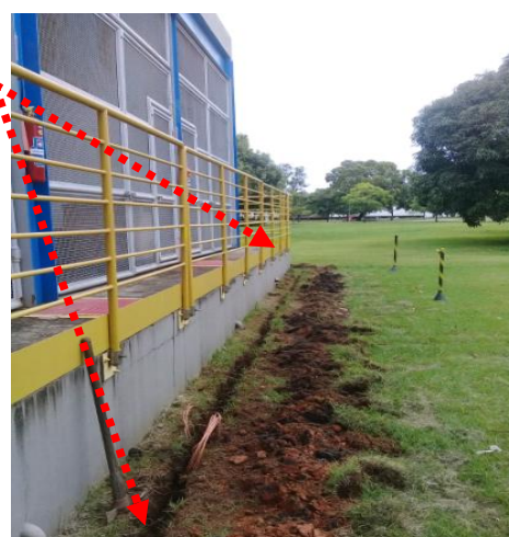
Figuras 59 e 60: Malha de aterramento implantada em cobre nu seção # 50mm 2 .
