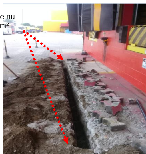
Figuras 195 e 196: Malha de aterramento implantada em cobre nu seção # 50mm 2 .
