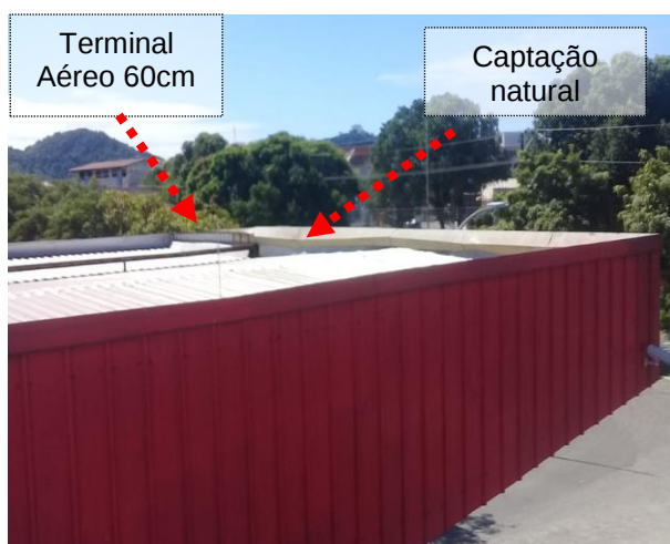
Figuras 111 e 112: Terminais aéreos em aço galvanizado de 60 cm fixado na captação
