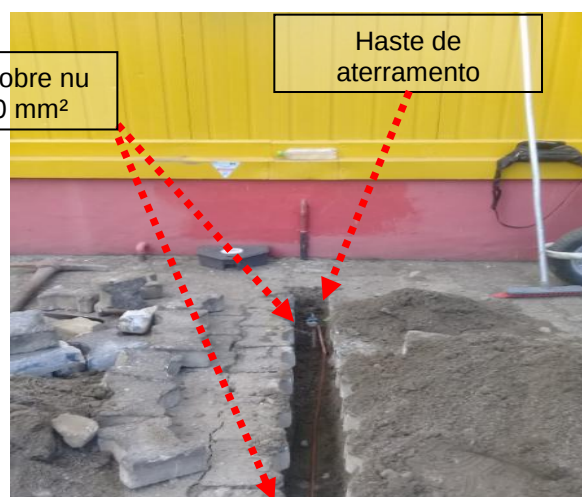
Figuras 266 e 267: Malha de aterramento implantada em cobre nu seção # 50mm 2 .
