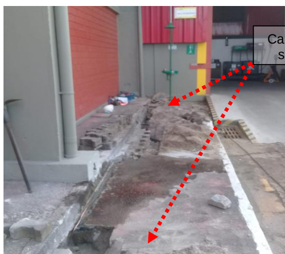
Figuras 187 e 188: Malha de aterramento implantada em cobre nu seção # 50mm 2 .
