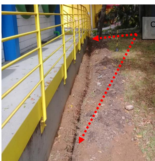
Figuras 51 e 52: Malha de aterramento implantada em cobre nu seção # 50mm 2 .
