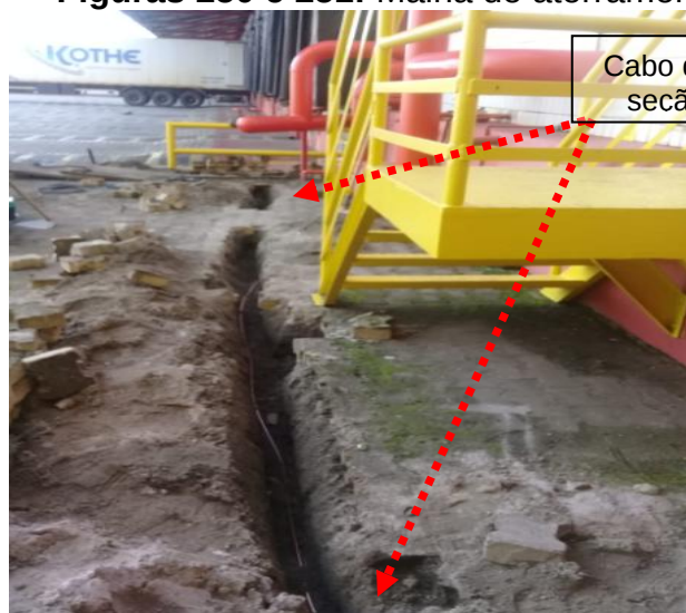
Figuras 252 e 253: Malha de aterramento implantada em cobre nu seção # 50mm 2 .
