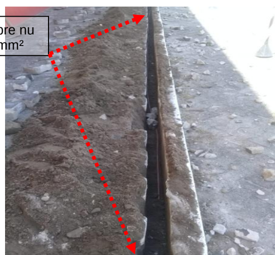
Figuras 262 e 263: Malha de aterramento implantada em cobre nu seção # 50mm 2 .
