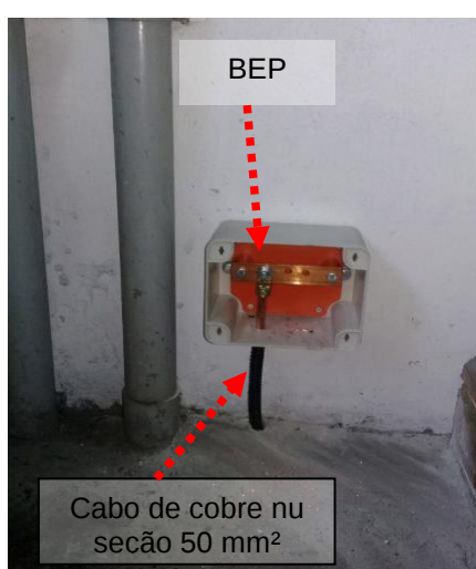
Figura 69: Instalação de Barra de Equipotencialização (BEP)
