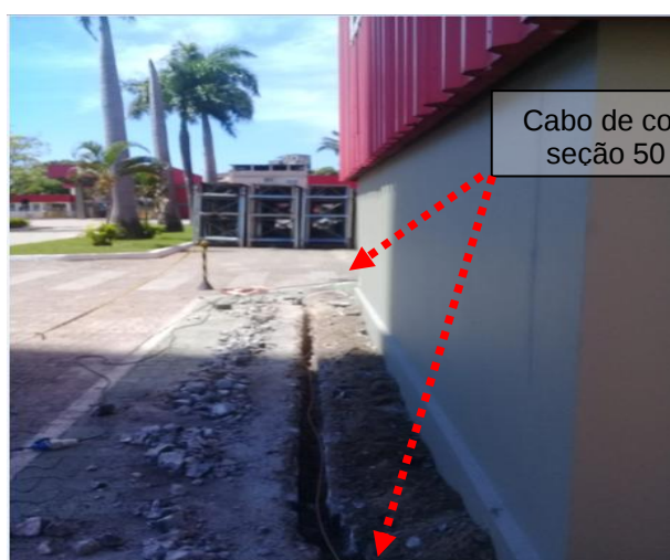
Figuras 189 e 190: Malha de aterramento implantada em cobre nu seção # 50mm 2 .
