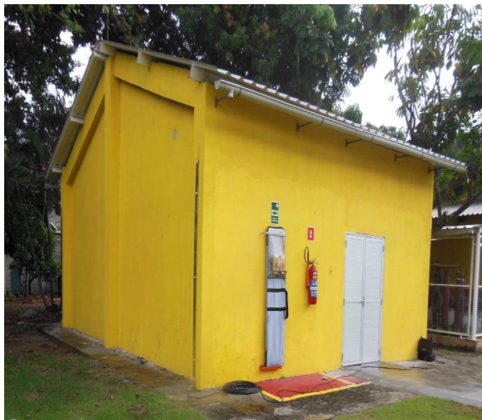
Figura 02: Sala de materiais - Manutenção
