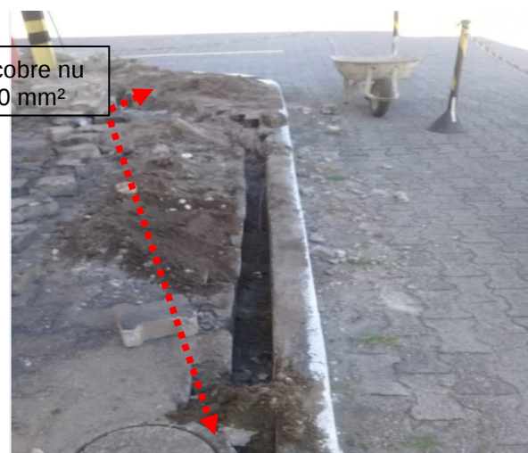
Figuras 284 e 285: Malha de aterramento implantada em cobre no seção # 50mm 2 .
