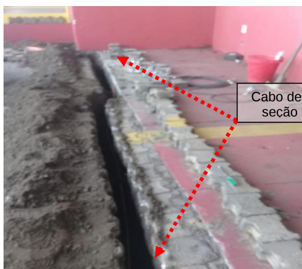
Figuras 242 e 243: Malha de aterramento implantada em cobre nu seção # 50mm 2 .
