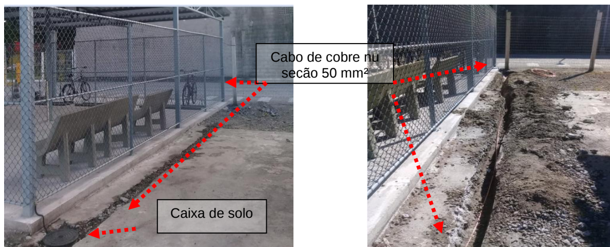
Figuras 88 e 89: Malha de aterramento implantada em cobre nu seção # 50mm 2 .
