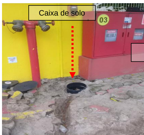
Figuras 23 e 24: Caixa de solo/Malha de aterramento através de cabo de core nu #50mm 2 .
