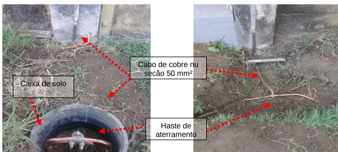
Figuras 98 e 99: Malha de aterramento implantada em cobre nu seção # 50mm 2 .
