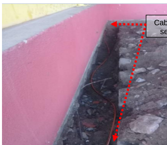
Figuras 240 e 241: Malha de aterramento implantada em cobre no seção # 50mm 2 .
