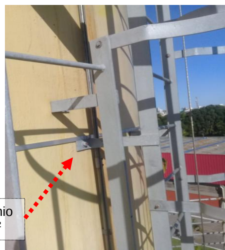
Figuras 206 e 207: Instalação de anéis de cintamento conf. tabela 04 da NBR 5419-3:2015.
