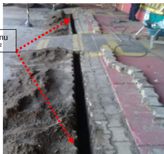
Figuras 244 e 245: Malha de aterramento implantada em cobre nu seção # 50mm 2 .
