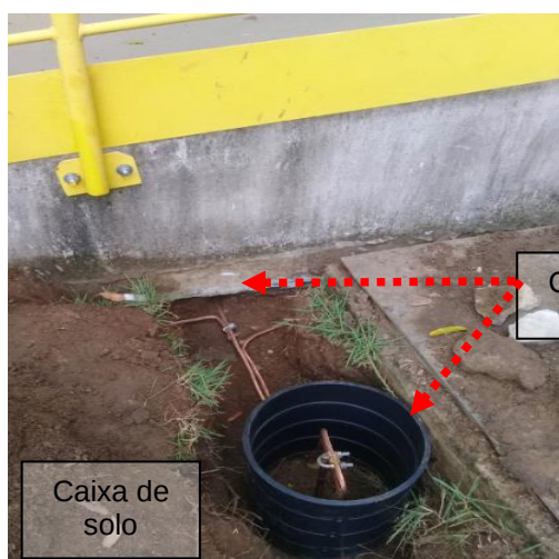
Figuras 47 e 48: Caixa de solo / Conexão guarda corpo em cobre nu seção # 50mm 2 .
