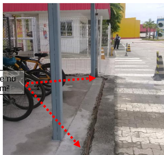
Figuras 80 e 81: Malha de aterramento implantada em cobre nu seção # 50mm 2 .
