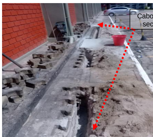
Figuras 185 e 186: Malha de aterramento implantada em cobre nu seção # 50mm 2 .
