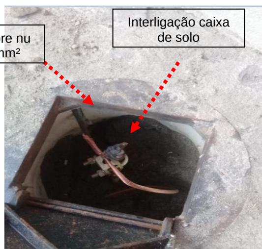
Figuras 169 e 170: Malha de aterramento implantada em cobre no seção # 50mm 2 .
