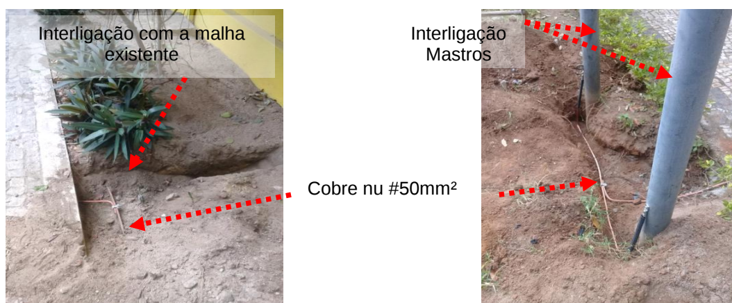
Figuras 40 e 41: Incorporação de estruturas metálicas ao SPDA existente.
