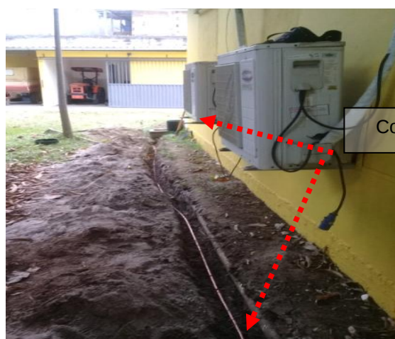
Figuras 29 e 30: Malha de aterramento através de cabo de core nu #50mm².
