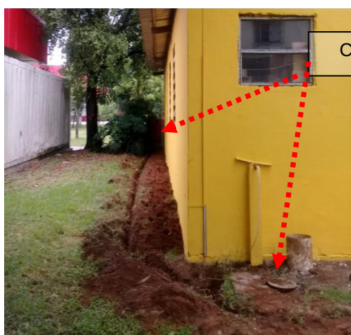
Figuras 25 e 26: Malha de aterramento através de cabo de core nu #50mm 2 .
