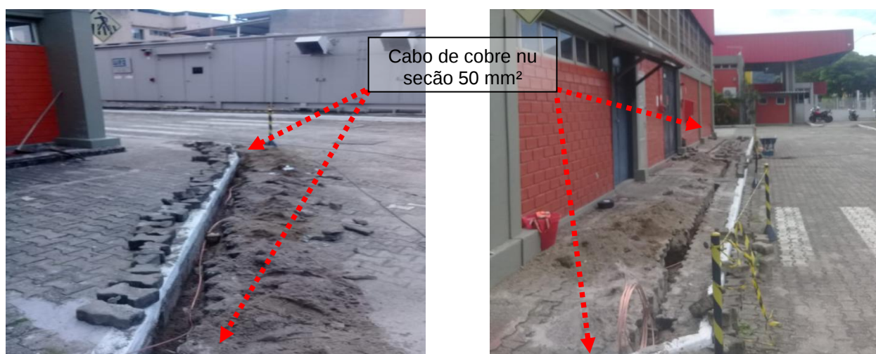
Figuras 175 e 176: Malha de aterramento implantada em cobre nu seção # 50mm 2 .
