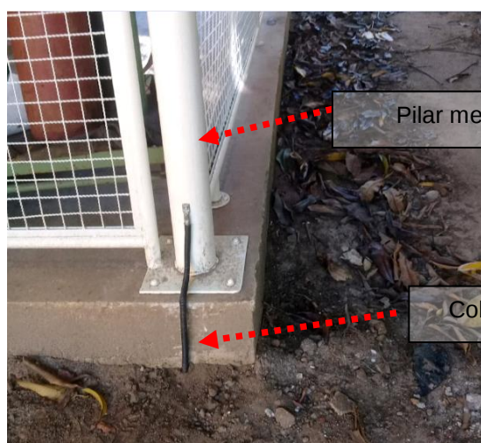
Figuras 33 e 34: Interligação da malha de aterramento através de cabo de core nu #50mm² a estruturas existentes no entorno da instalação.
