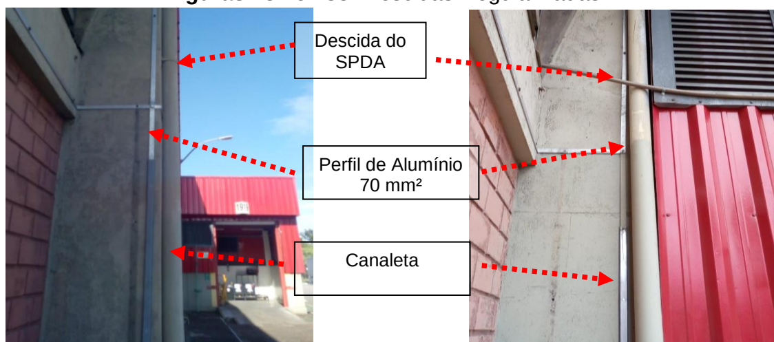
Figuras 134 e 135: Descidas Regularizadas
