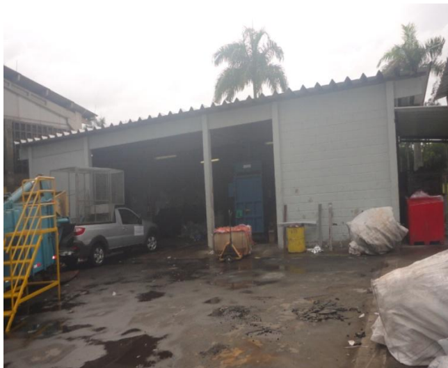
Figura 68: Área 09 – Armazém de Material 01
