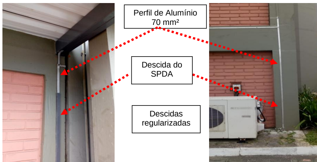
Figuras 88 e 89: Regularização de descida do SPDA em perfil de Alumínio 70 mm²
