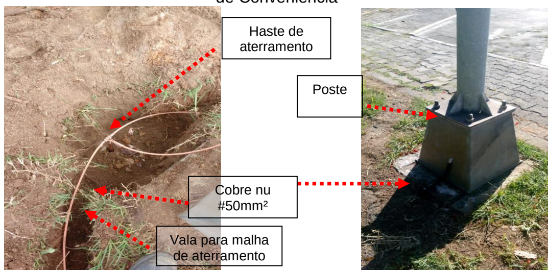
Figuras 111 e 112: Interligação da malha construída com poste de iluminação
