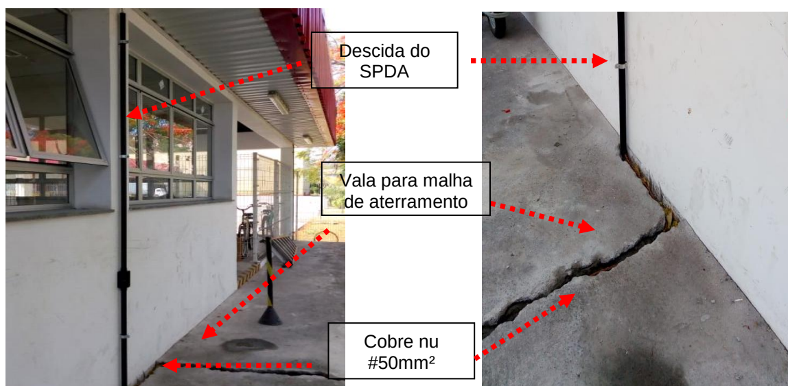
Figuras 105 e 106: Trechos da malha de aterramento construído no anexo portaria 01
