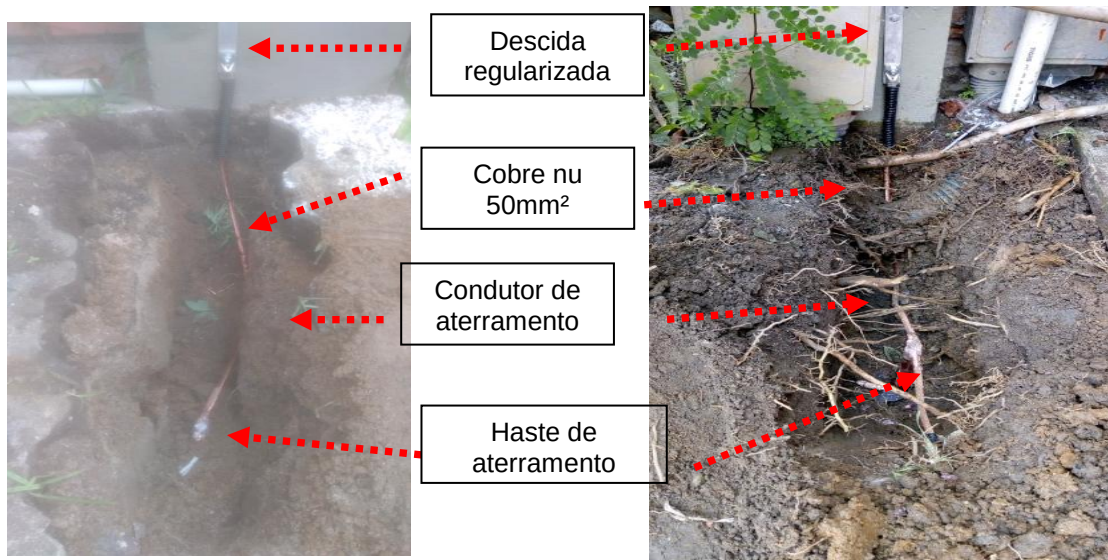
Figuras 94 e 95: trecho malha de aterramento construída na portaria 01
