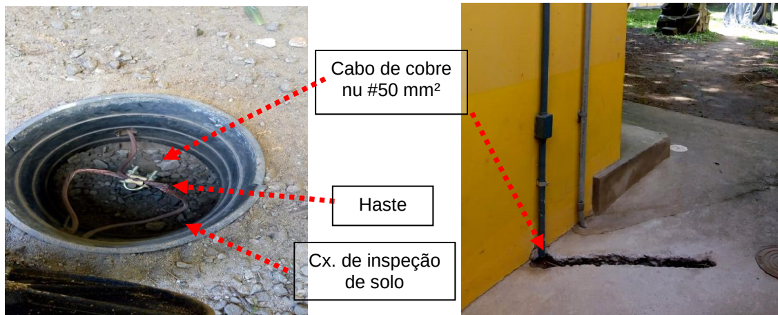
Figuras 36 e 37: Cx. de inspeção de solo – Interligação descida c/ a malha de aterramento
