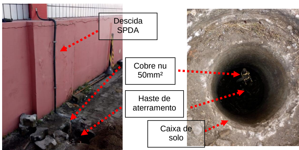
Figuras 204 e 205: Sistema de aterramento como construído/ Revitalização das conexões
