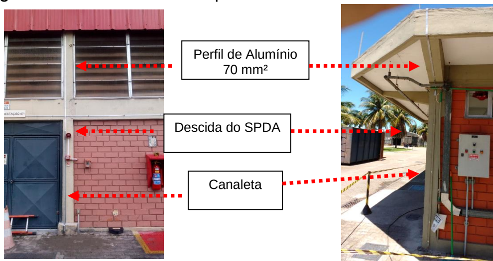
Figuras 130 e 131: Descidas implantadas em Perfil de Alumínio #70 mm²
