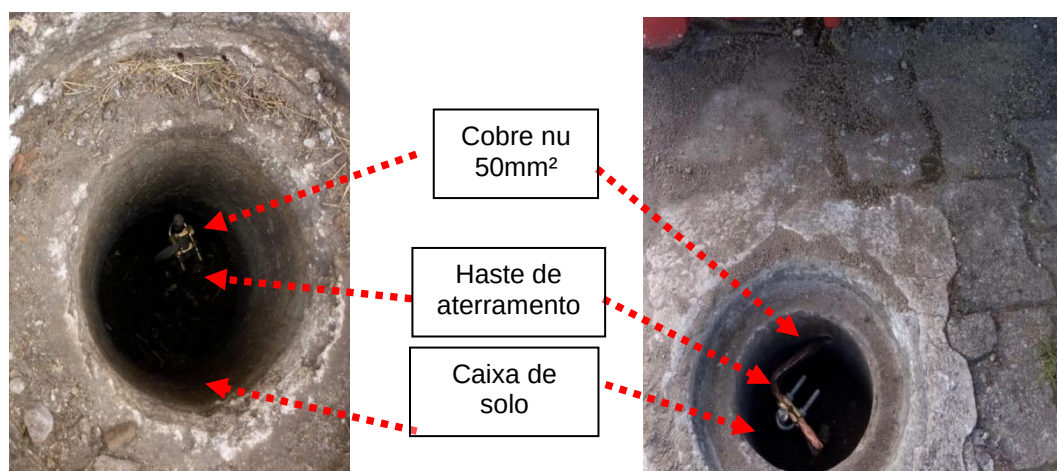
Figuras 206 e 207: Revitalização das conexões nas Caixas de inspeção de solo
