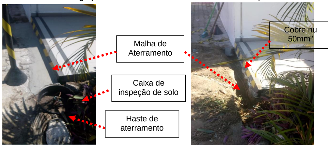
Figuras 183 e 184: Trecho de malha implantada entre a caixa de solo e a malha existente.
