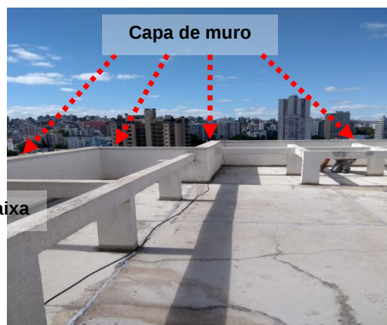
Figuras 14 e 15: Malha captora natural - Capas de muro instaladas no entorno da cobertura da edificação, em cota mais baixa.
