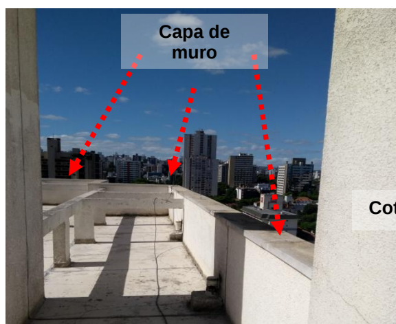
Figuras 14 e 15: Malha captora natural - Capas de muro instaladas no entorno da cobertura da edificação, em cota mais baixa.
