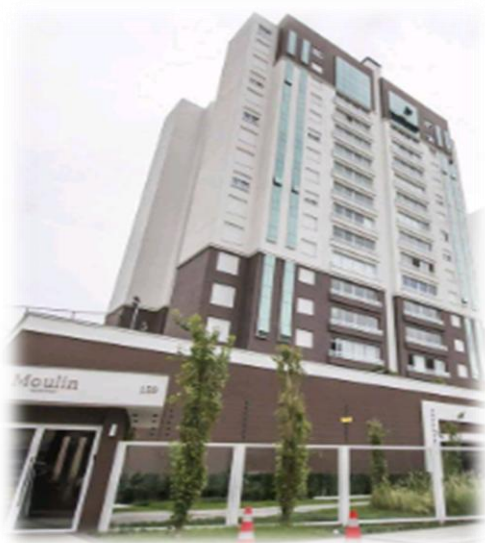
Figura 02: Fachada da edificação
