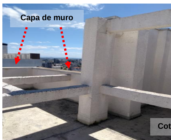
Figuras 12 e 13: Malha captora natural - Capas de muro instaladas no entorno da cobertura da edificação, em cota mais baixa.
