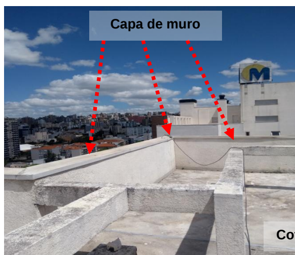
Figuras 41 e 42: Malha captora natural - Capas de muro instaladas no entorno da cobertura da edificação, em cota mais baixa.
