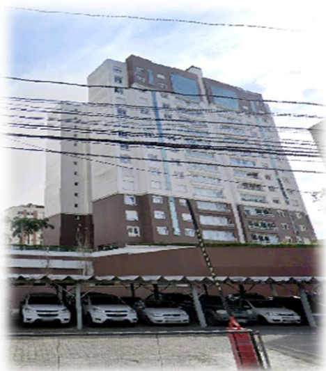
Figura 27: Fachada da edificação
