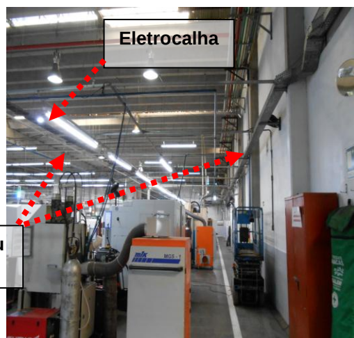
Figuras 05 e 06: Passagem dos cabos seção # 50 mm 2 pelo leito das eletrocalhas.
