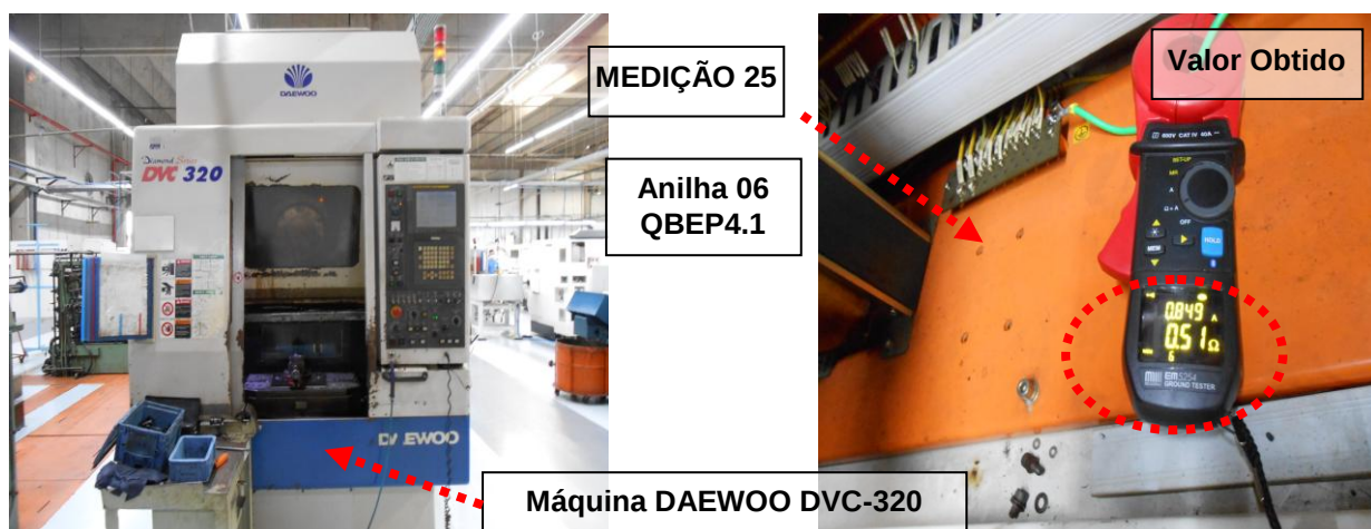
Figuras 100 e 101: Local e valor das Medições de resistência de aterramento – Usinagem.
