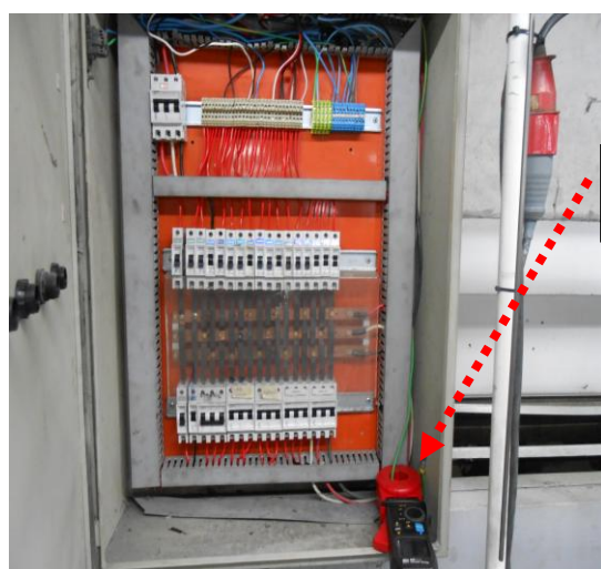
Figuras 142 e 143: Local e valor das Medições de resistência de aterramento – Montagem.
