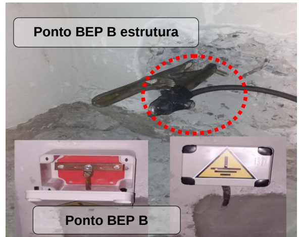
Figuras 05 e 06: Ponto BEP B localizado no térreo lado interno da estrutura;
