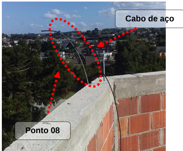
Figuras 23 e 24: Ponto 08 – Descida do SPDA // Medição 08.
