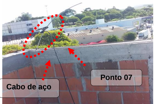
Figuras 21 e 22: Ponto 07 – Descida do SPDA // Medição 07.
