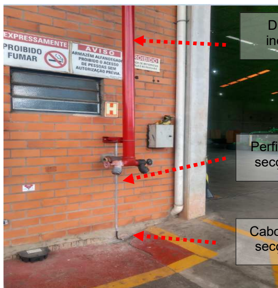
Figuras 106 e 107: Equalização / Implantação trecho perfil de alumínio e cabo de cobre nu.
