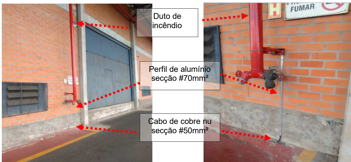
Figuras 114 e 115: Equalização / Implantação trecho perfil de alumínio e cabo de cobre nu.
