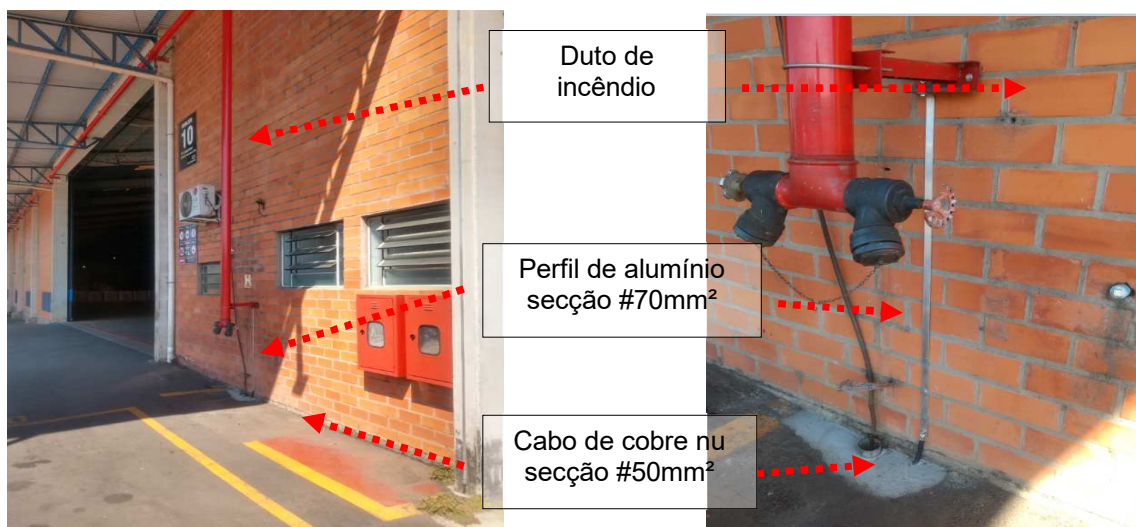
Figuras 95 e 96: Equalização / Implantação trecho perfil de alumínio e cabo de cobre nu.
