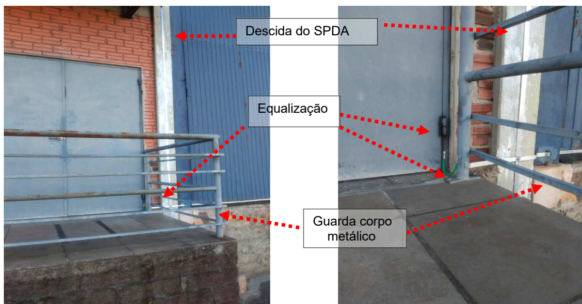
Figuras 19 e 20: Equalização / Implantação de trecho de cabo de cobre isolado #16mm 2
