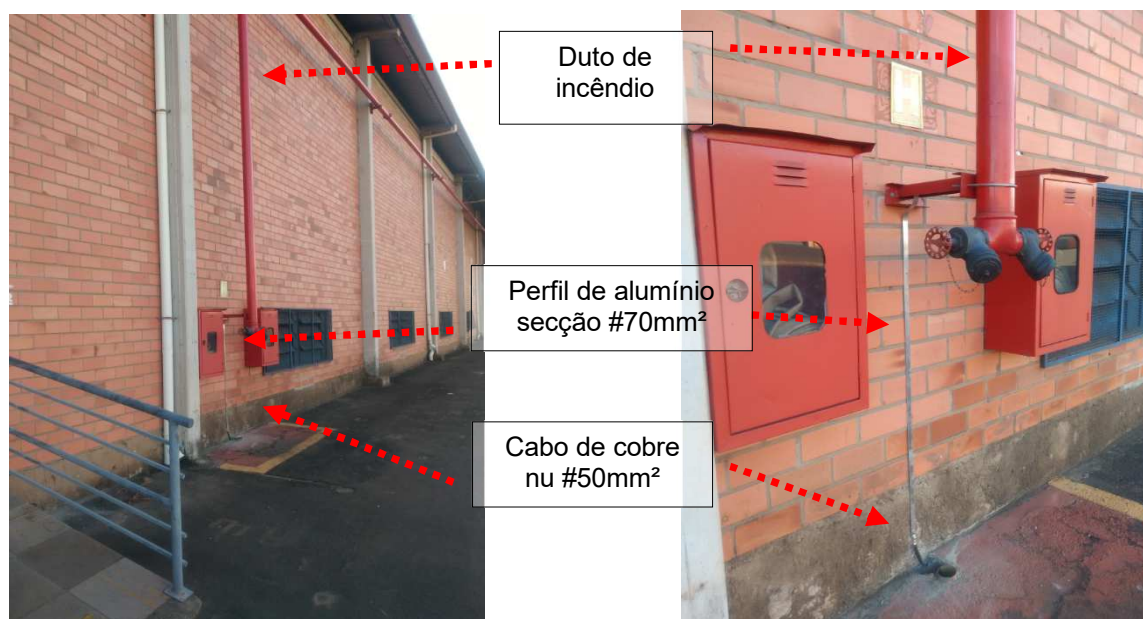
Figuras 81 e 82: Equalização / Implantação trecho perfil de alumínio e cabo de cobre nu.
