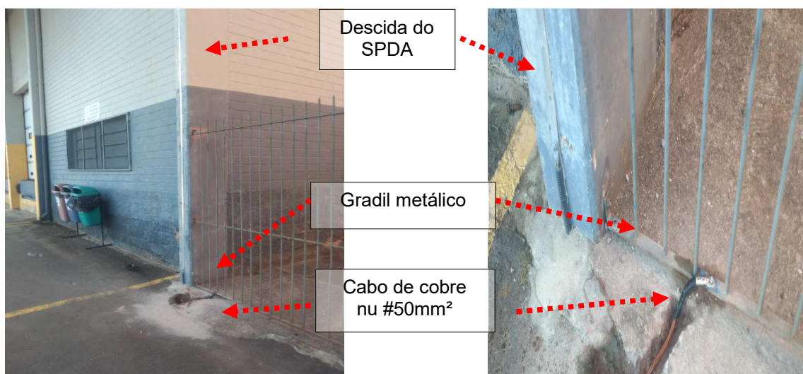
Figuras 43 e 44: Equalização / Implantação de trecho cabo de cobre nu.
