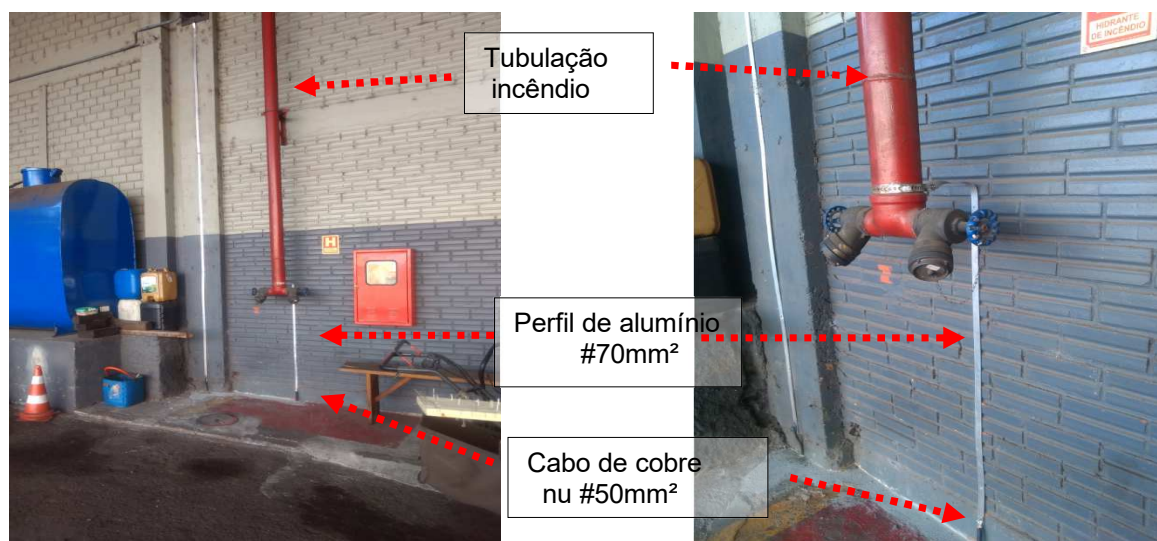
Figuras 13 e 14: Equalização / Implantação de trecho de cabo de cobre nu #50mm²
