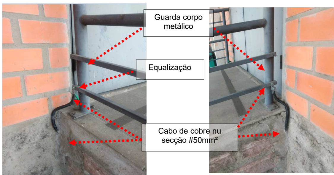
Figuras 103 e 104: Equalização / Implantação trecho em cabo de cobre nu #50mm².
