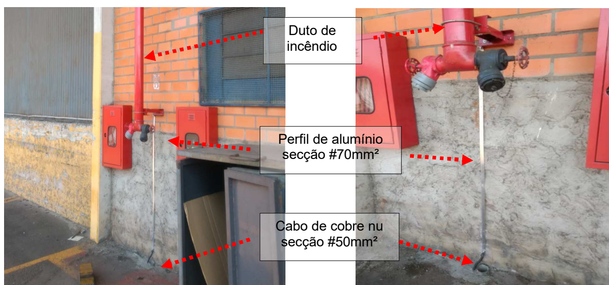
Figuras 99 e 100: Equalização / Implantação trecho perfil de alumínio e cabo de cobre nu.
