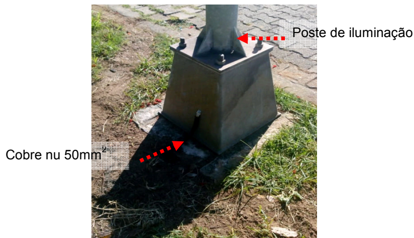
Figura 259: Interligação malha de aterramento com estrutura metálica - Poste
