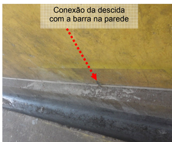
Figura 108: Marcenaria – Ofic. Empilhadeira – Sist. de aterramento Incorporar descida dentro do anel de aterramento através de cobre nu#50mm²
