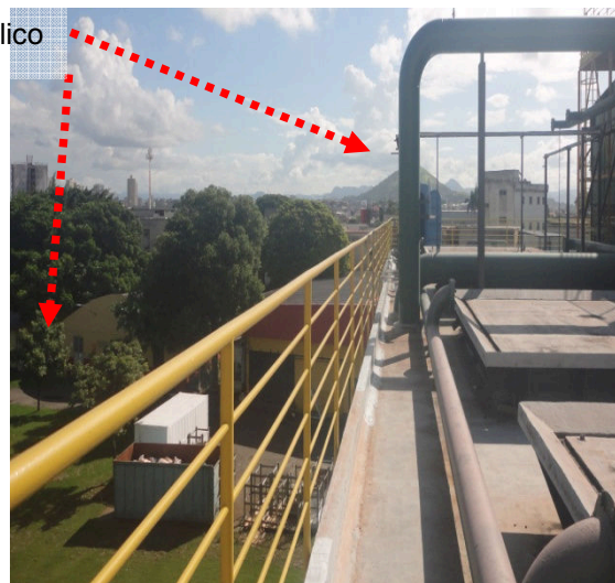
Figuras 47 e 48: Sistema captor natural existente na Central de água gelada
