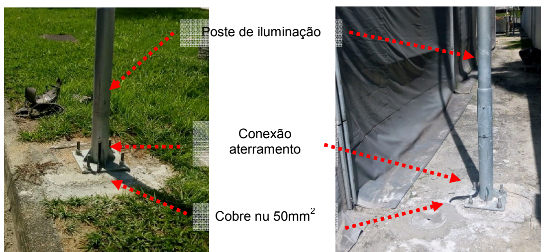
Figuras 246 e 247: Galpão de Lona – Sist. de aterramento – Interligação postes
