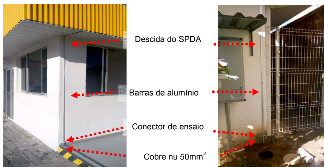
Figuras 253 e 254: Sistema de descidas existentes no Centro de Conveniência
