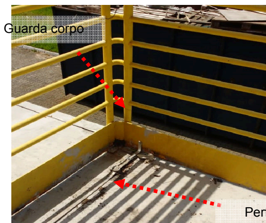
Figuras 175 e 176: Sistema de captação existente no armazém 04.
