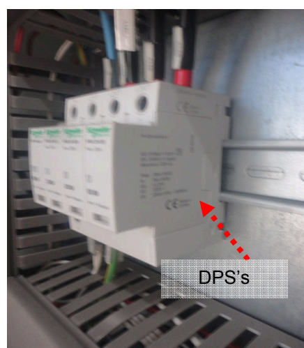
Figuras 231 e 232: DPS 's existentes em Painel de alimentação do Castelo de Água
