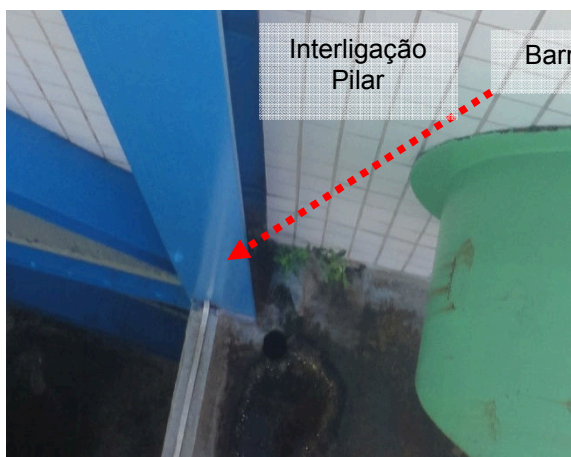
Figuras 43 e 44: Interligações - Sistema captor existente na Subestação
