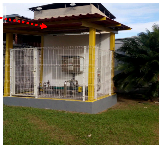
Figuras 117 e 118: Aterrar estrutura metálica – Estação de fluentes
