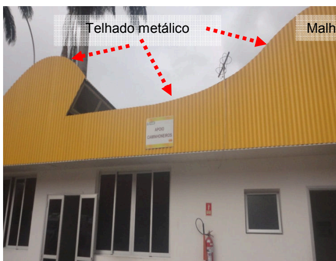
Figuras 251 e 252: Sistema captor existente no Centro de Conveniência.
