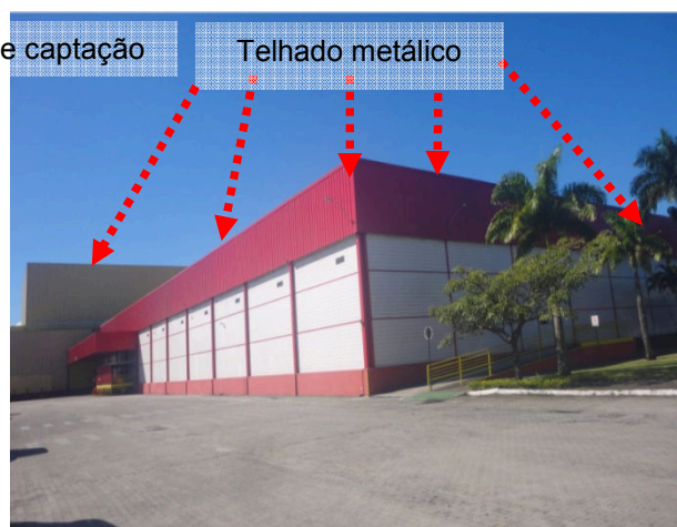
Figuras 272 e 273: Sistema captor existente no Armazém Vertical.
