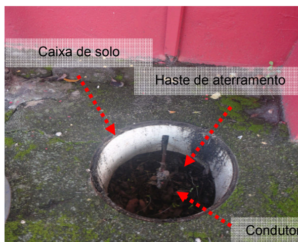
Figuras 19 e 20: Sistema Aterramento – Oficina de Manutenção / Arquivo
