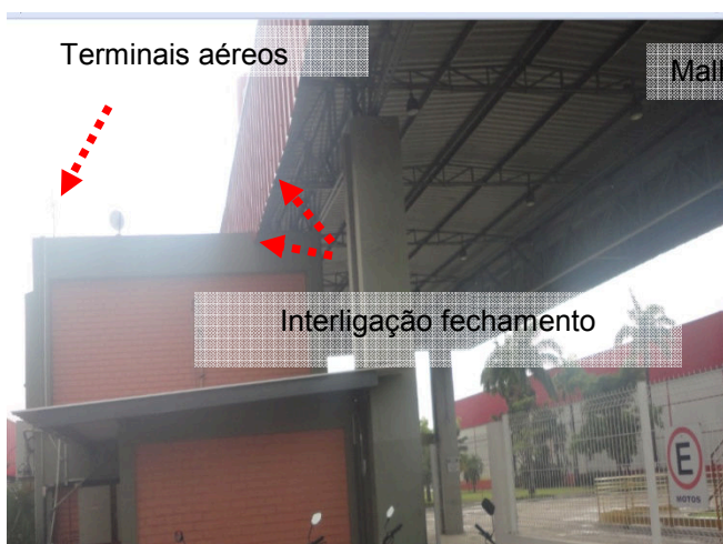
Figuras 131 e 132: Sistema captor existente na Portaria 01.
