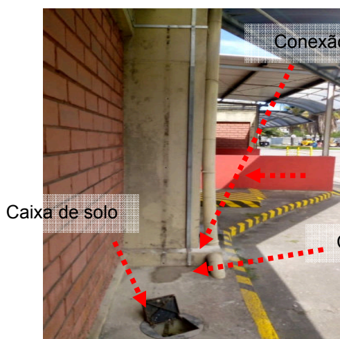
Figuras 197 e 198: Armazém 04 – Sist. de aterramento – Caixa de solo /Conexão estrutura
