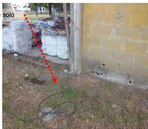
Figuras 90 e 91: Sistema Aterramento — Sala de Materiais I - Caixa de solo
