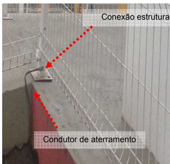
Figuras 73 e 74: Sistema Aterramento – Portaria 02 – Interligação da malha de aterramento c/ elementos metálicos
