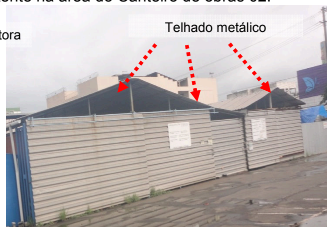
Figuras 79 e 80: Sistema captor existente na área do Canteiro de obras 02.
