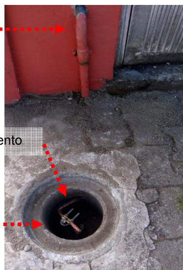
Figuras 282 e 283: Armazém vertical – Sist. de aterramento – Caixa de solo
