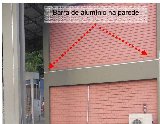
Figuras 149 e 150: Portaria 01– Sist. de aterramento –Barra de alumínio na parede
