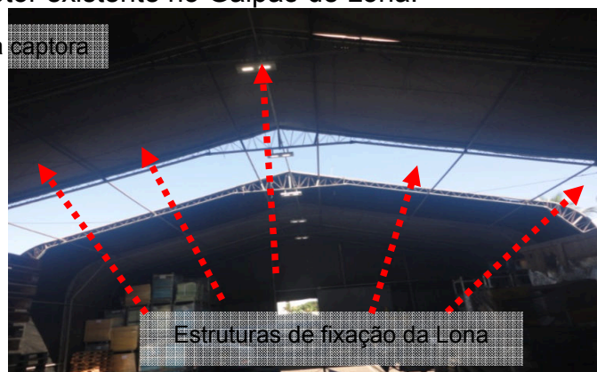
Figuras 236 e 237: Sistema captor existente no Galpão de Lona.
