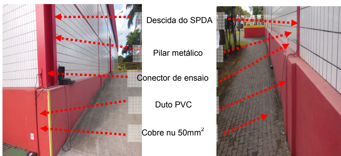
Figuras 276 e 277: Sistema de descidas existentes no Armazém vertical
