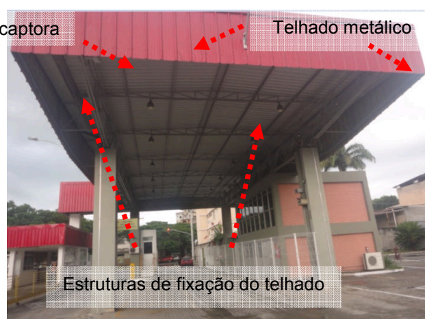
Figuras 127 e 128: Sistema captor existente na Portaria 01.
