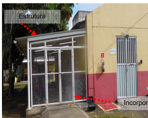
Figuras 23 e 24: Aterrar/Interligar estrutura metálica ao SPDA
