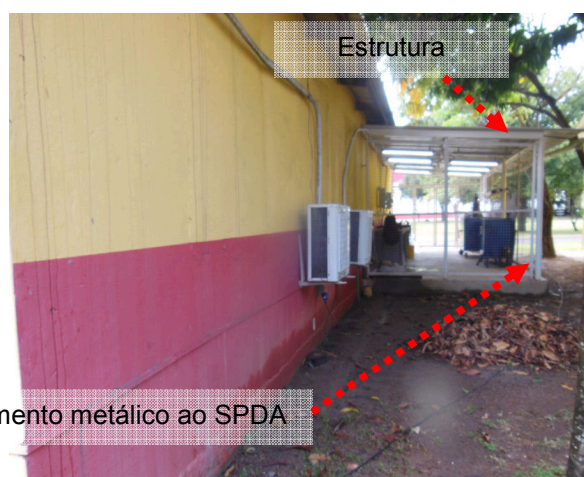
Figuras 23 e 24: Aterrar/Interligar estrutura metálica ao SPDA
