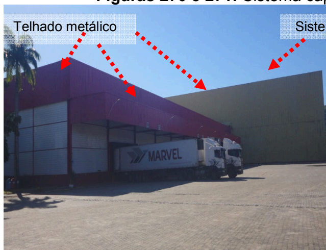
Figuras 272 e 273: Sistema captor existente no Armazém Vertical.
