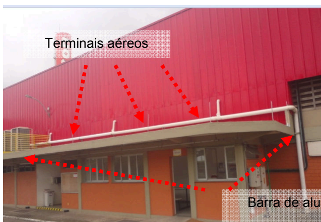
Figuras 159 e 160: Sistema de captação existente no armazém 04.
