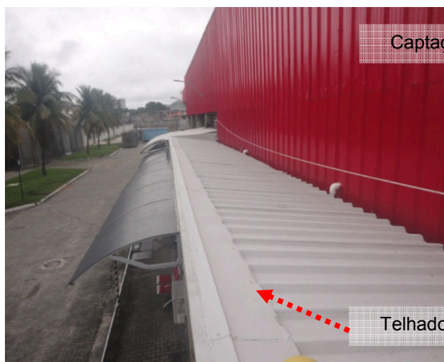
Figuras 161 e 162: Sistema de captação existente no armazém 04.
