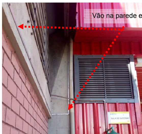
Figuras 199 e 200: Armazém 04– Sist. de aterramento – Barra na parede
