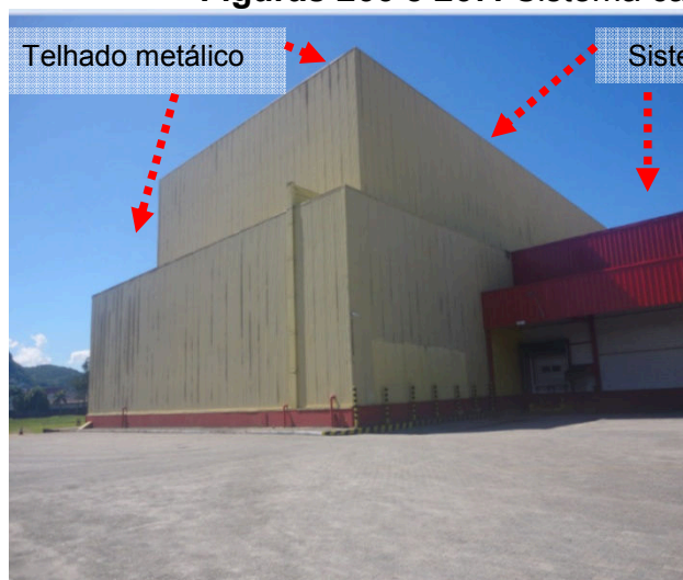
Figuras 268 e 269: Sistema captor existente no Armazém Vertical.
