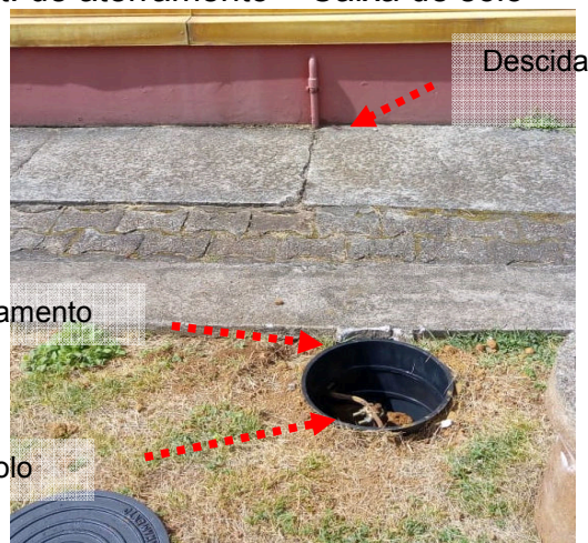
Figuras 286 e 287: Armazém Vertical – Sist. de aterramento– Caixa de solo
