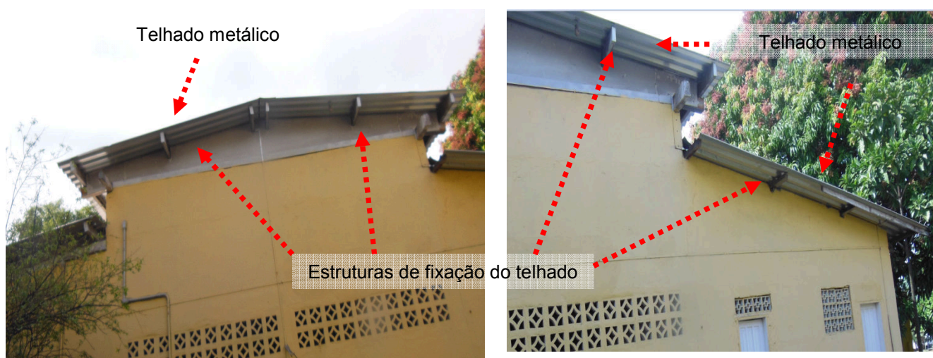
Figuras 15 e 16: Sistema captor existente na Oficina de Manutenção / Arquivo
