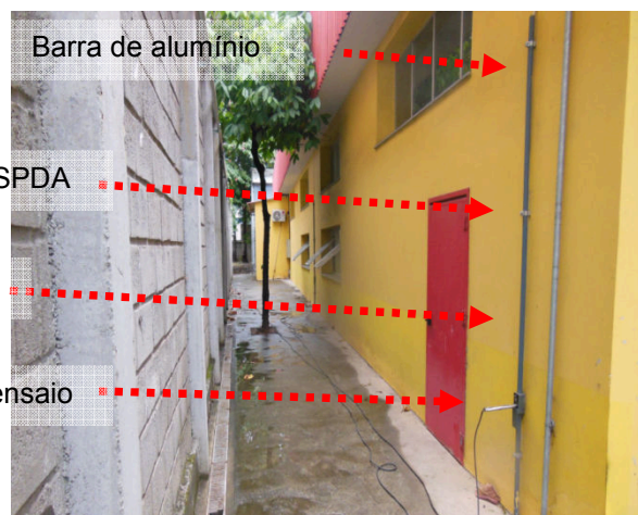
Figuras 28 e 29: Sistema de descidas convencionais na Sala de Materiais – Engenharia
