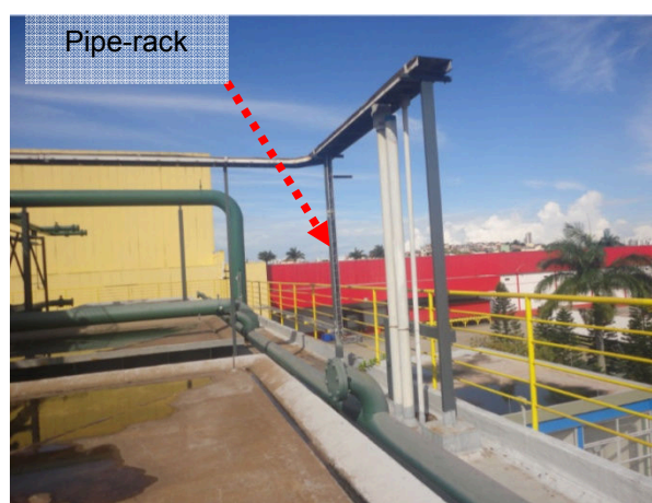
Figuras 53 e 54: Sistema captor natural existente na Central de água gelada
