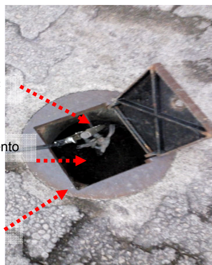
Figuras 195 e 196: Armazém 04– Sist. de aterramento – Caixa de solo
