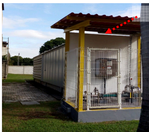
Figuras 117 e 118: Aterrar estrutura metálica – Estação de fluentes
