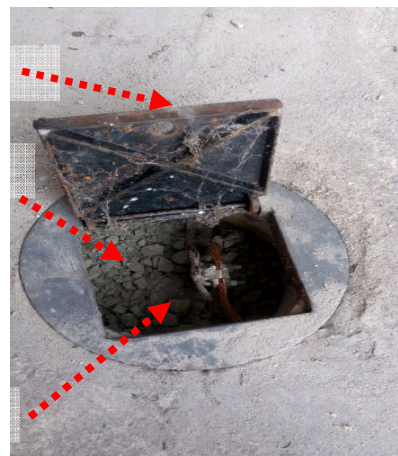
Figuras 193 e 194: Armazém 04 – Sist. de aterramento – Caixa de solo
