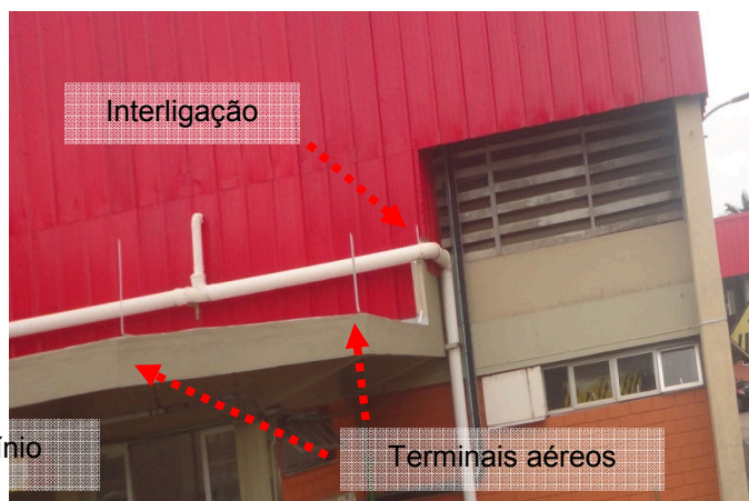
Figuras 159 e 160: Sistema de captação existente no armazém 04.
