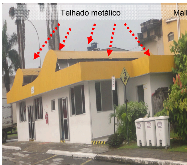
Figuras 249 e 250: Sistema captor existente no Centro de Conveniência.
