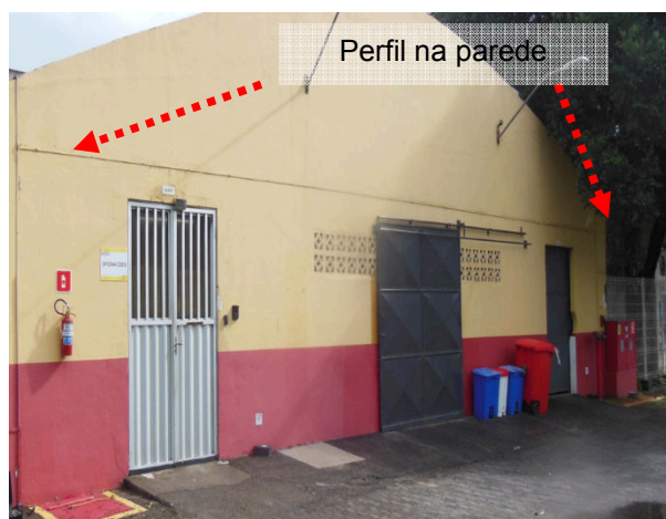
Figuras 21 e 22: Sistema Aterramento – Oficina de Manutenção / Arquivo
