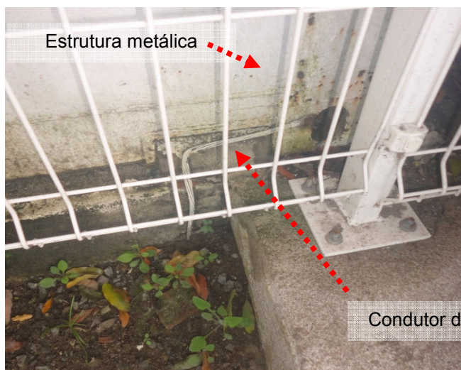
Figuras 34 e 35: Sistema Aterramento — Sala de Materiais – Engenharia -Caixa de solo
