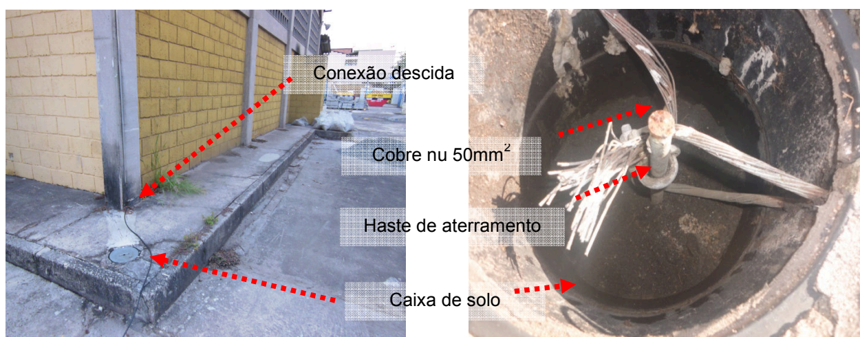
Figuras 106 e 107: Marcenaria – Ofic. Empilhadeira – Sist. de aterramento – Caixa de solo
