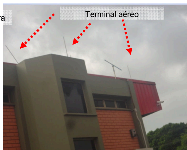
Figuras 133 e 134: Sistema captor existente na Portaria 01.
