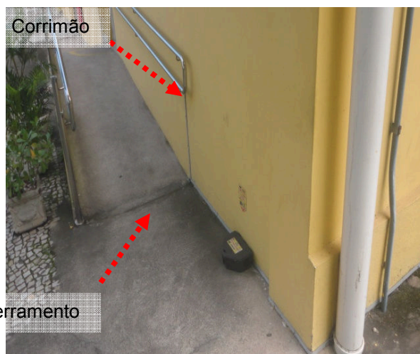
Figuras 34 e 35: Sistema Aterramento — Sala de Materiais – Engenharia -Caixa de solo
