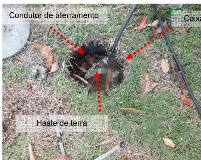
Figuras 90 e 91: Sistema Aterramento — Sala de Materiais I - Caixa de solo
