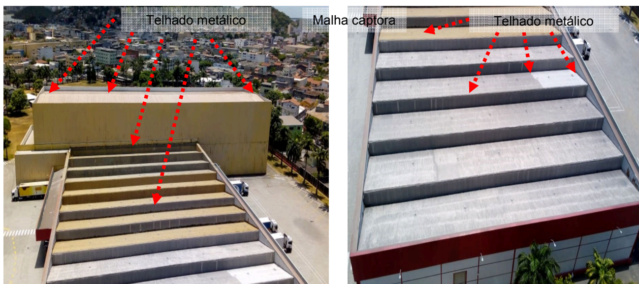
Figuras 262 e 263: Sistema captor existente no Armazém Vertical.
