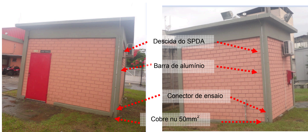
Figuras 122 e 123: Sistema de descidas existente na área da Central de Telefonia
