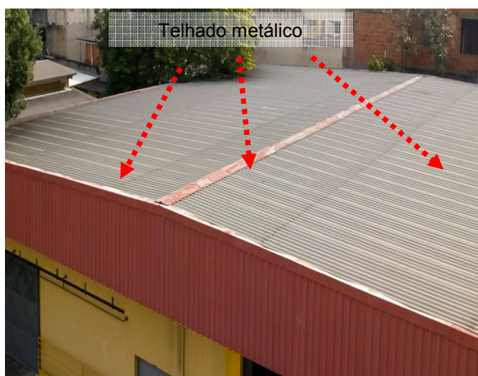
Figuras 26 e 27: Sistema captor existente na Sala de Materiais - Engenharia
