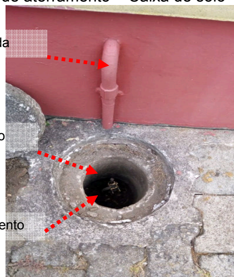
Figuras 284 e 285: Armazém Vertical – Sist. de aterramento – Caixa de solo
