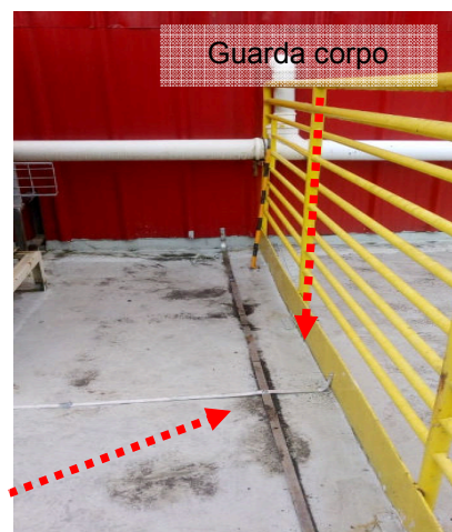
Figuras 175 e 176: Sistema de captação existente no armazém 04.
