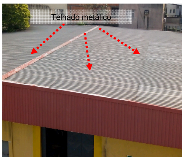
Figuras 26 e 27: Sistema captor existente na Sala de Materiais - Engenharia
