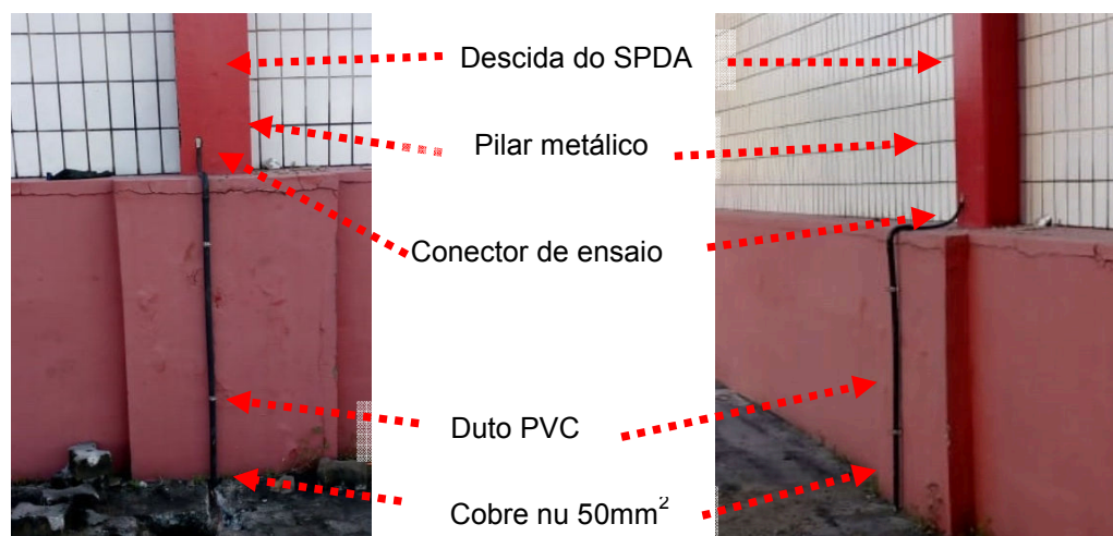
Figuras 278 e 279: Sistema de descidas existentes no Armazém vertical
