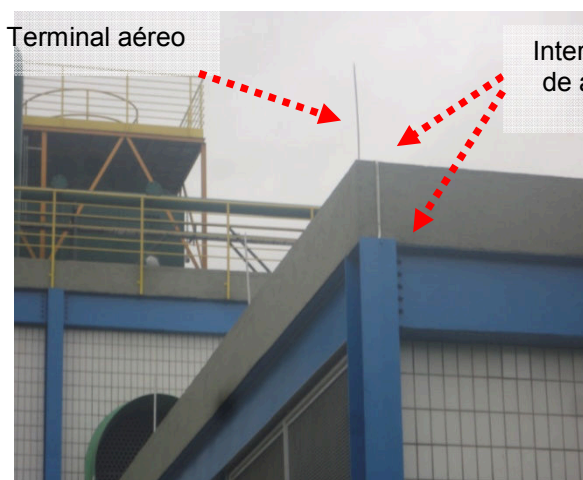
Figuras 45 e 46: Interligações - Sistema captor existente na Subestação
