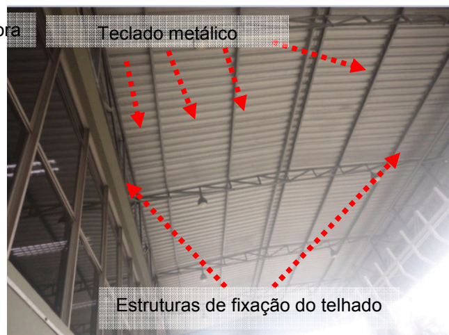
Figuras 129 e 130: Sistema captor existente na Portaria 01.
