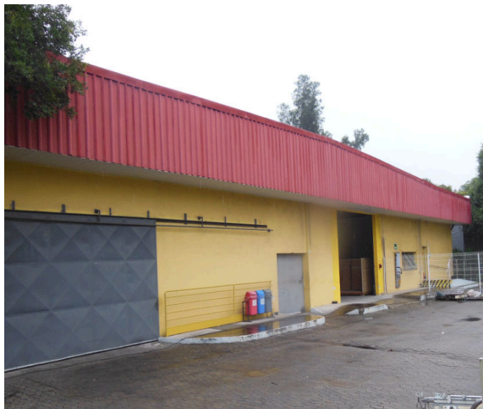
Figura 25: Sala de Materiais - Engenharia
