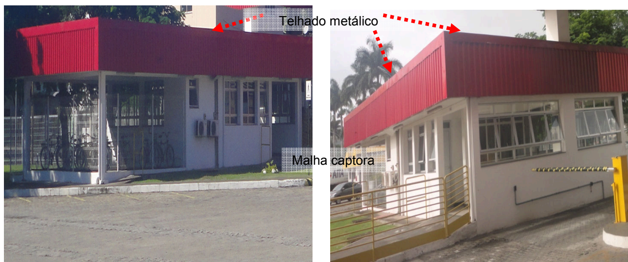
Figuras 152 e 153: Anexo Portaria 01 - Estruturas metálicas do metálico
