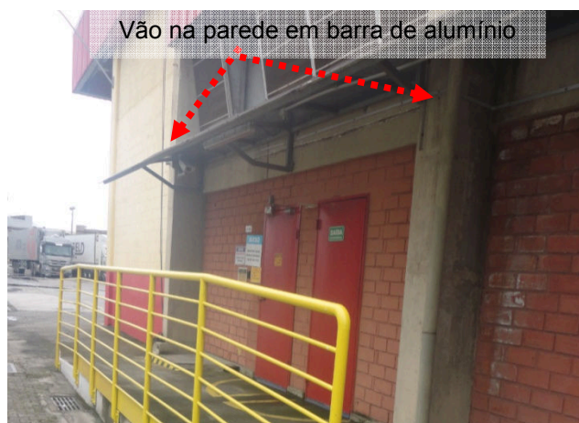
Figuras 201 e 202: Armazém 04 – Sist. de aterramento – Barra na parede
