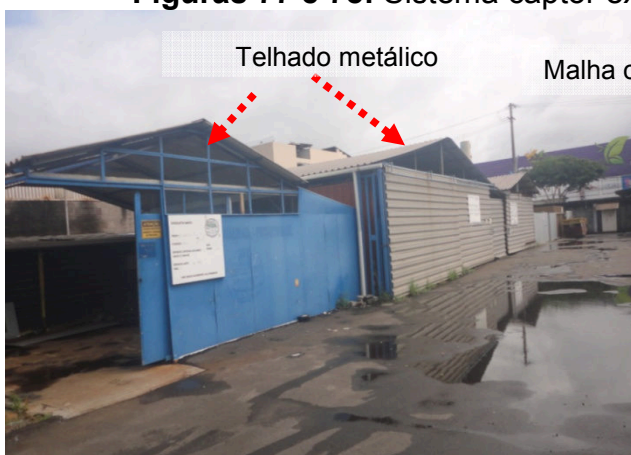
Figuras 79 e 80: Sistema captor existente na área do Canteiro de obras 02.
