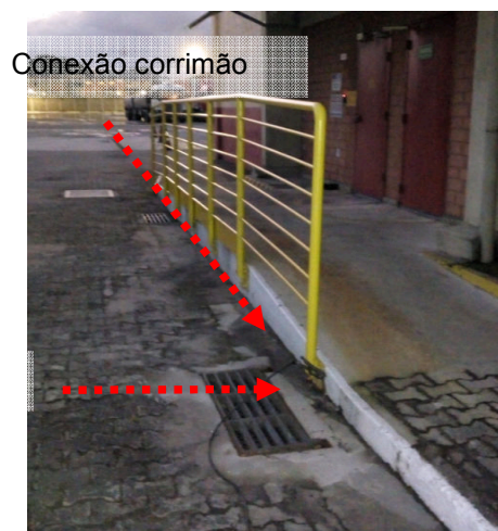
Figuras 197 e 198: Armazém 04 – Sist. de aterramento – Caixa de solo /Conexão estrutura
