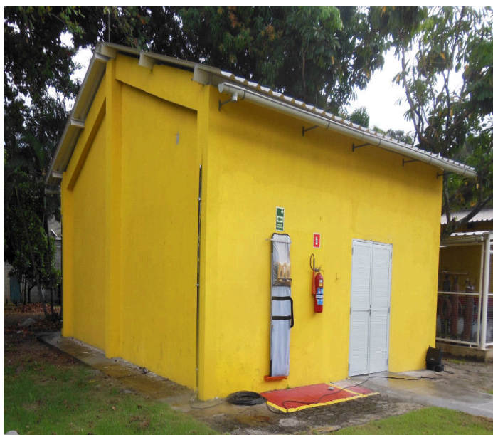
Figura 02: Sala de materiais - Manutenção
