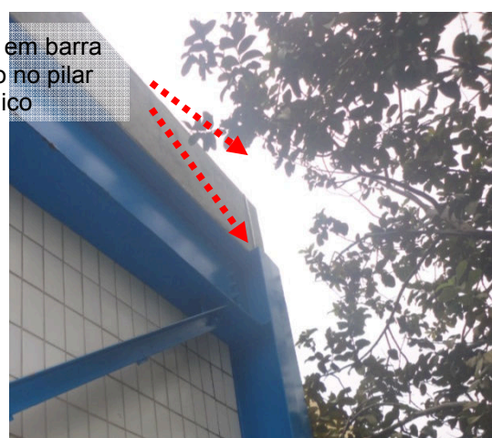
Figuras 45 e 46: Interligações - Sistema captor existente na Subestação
