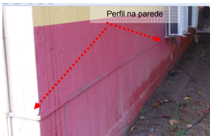
Figuras 21 e 22: Sistema Aterramento – Oficina de Manutenção / Arquivo
