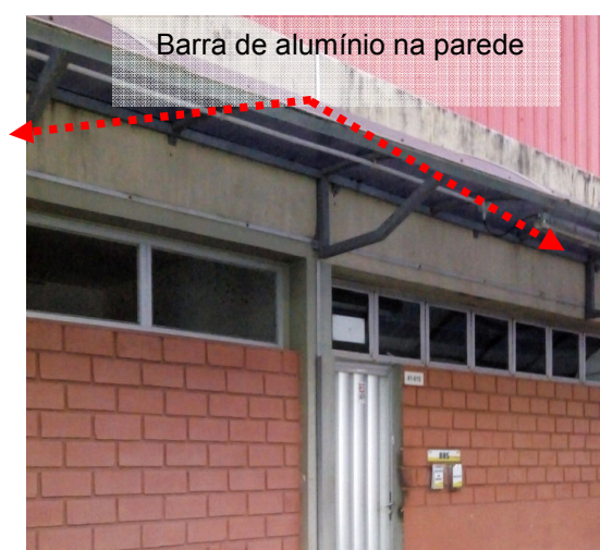
Figuras 203 e 204: Armazém 04– Sist. de aterramento – Barra de alumínio na parede
