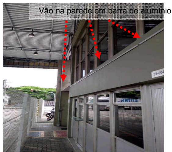
Figuras 147 e 148: Portaria 01– Sist. de aterramento – Caixa de solo –Barra na parede
