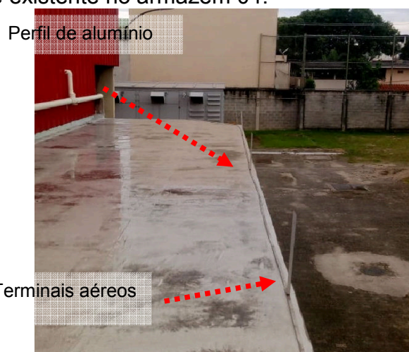
Figuras 165 e 166: Sistema de captação existente no armazém 04.
