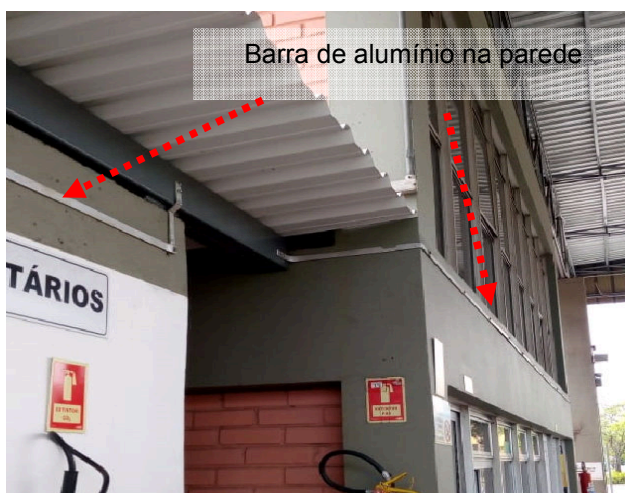
Figuras 149 e 150: Portaria 01– Sist. de aterramento –Barra de alumínio na parede
