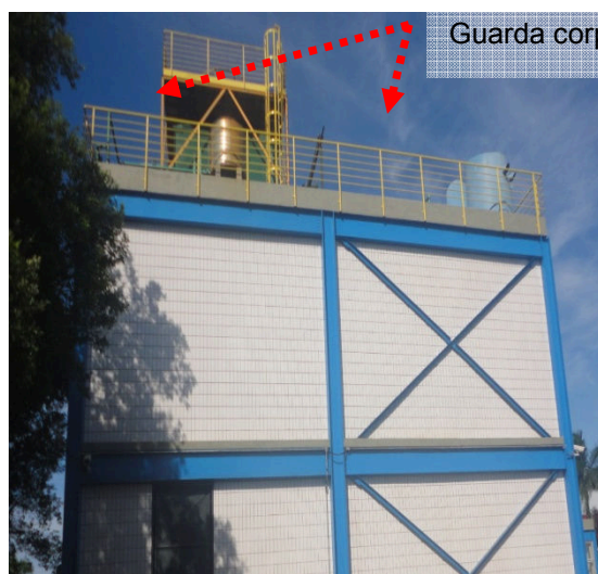
Figuras 47 e 48: Sistema captor natural existente na Central de água gelada
