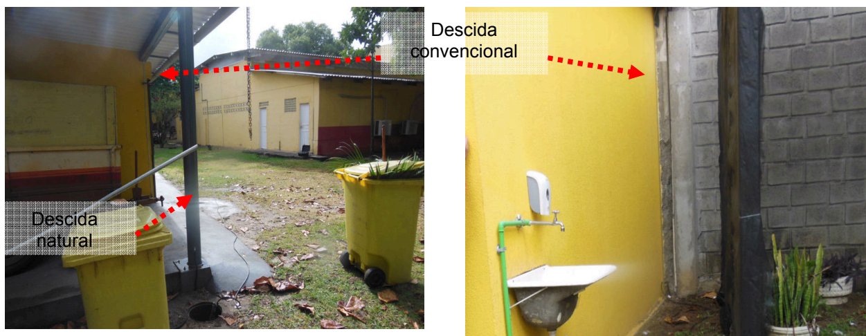
Figuras 10 e 11: Sistema de descida existente no setor de jardinagem.
