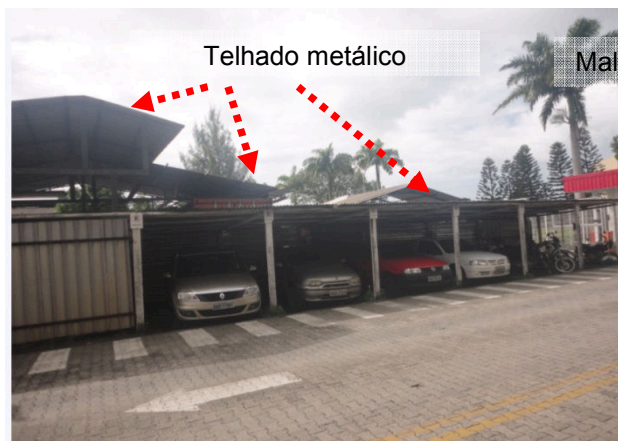
Figuras 77 e 78: Sistema captor existente na área do Canteiro de obras 02.
