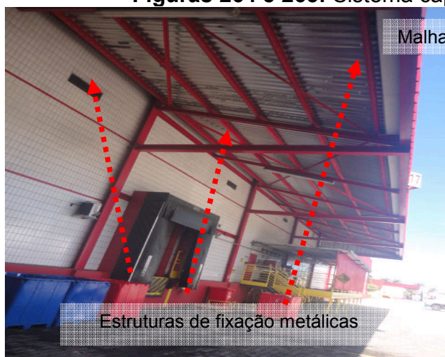
Figuras 266 e 267: Sistema captor existente no Armazém Vertical.
