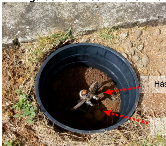
Figuras 286 e 287: Armazém Vertical – Sist. de aterramento– Caixa de solo
