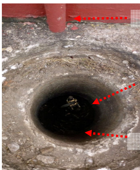
Figuras 282 e 283: Armazém vertical – Sist. de aterramento – Caixa de solo
