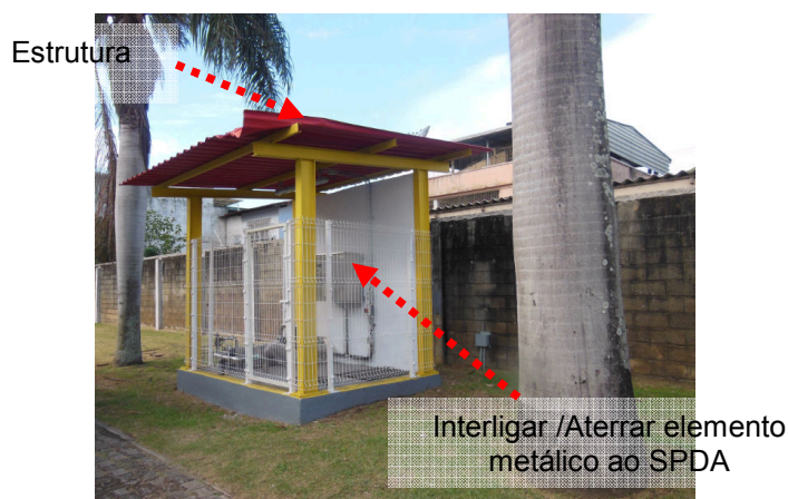
Figura 260: Aterrar estrutura
