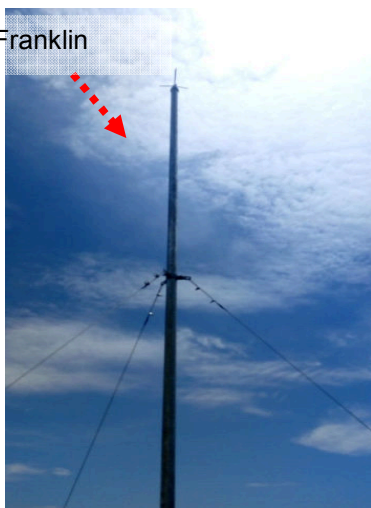
Figuras 215 e 216: Sistema captor existente – Castelo de água
