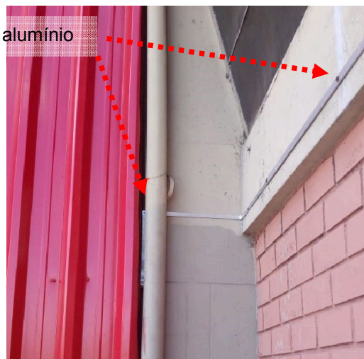
Figuras 199 e 200: Armazém 04– Sist. de aterramento – Barra na parede
