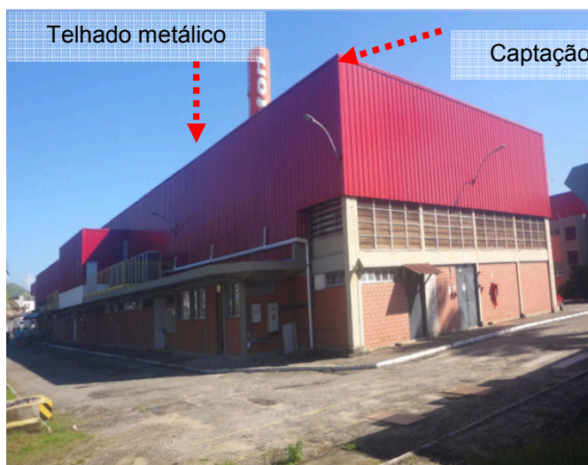
Figuras 167 e 168: Sistema de captação existente no armazém 04.
