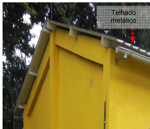
Figuras 03 e 04: Sistema captor existente na Sala de materiais – Manutenção.
