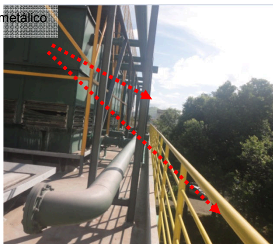
Figuras 49 e 50: Sistema captor natural existente na Central de água gelada
