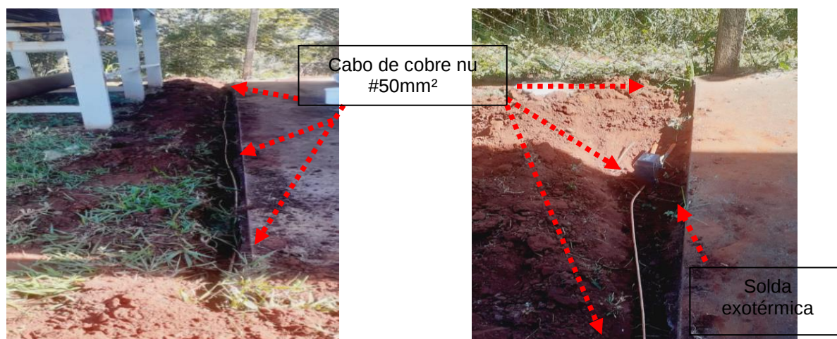
Figuras 283 e 284: Malha de aterramento construída na área do depósito de cinzas.
