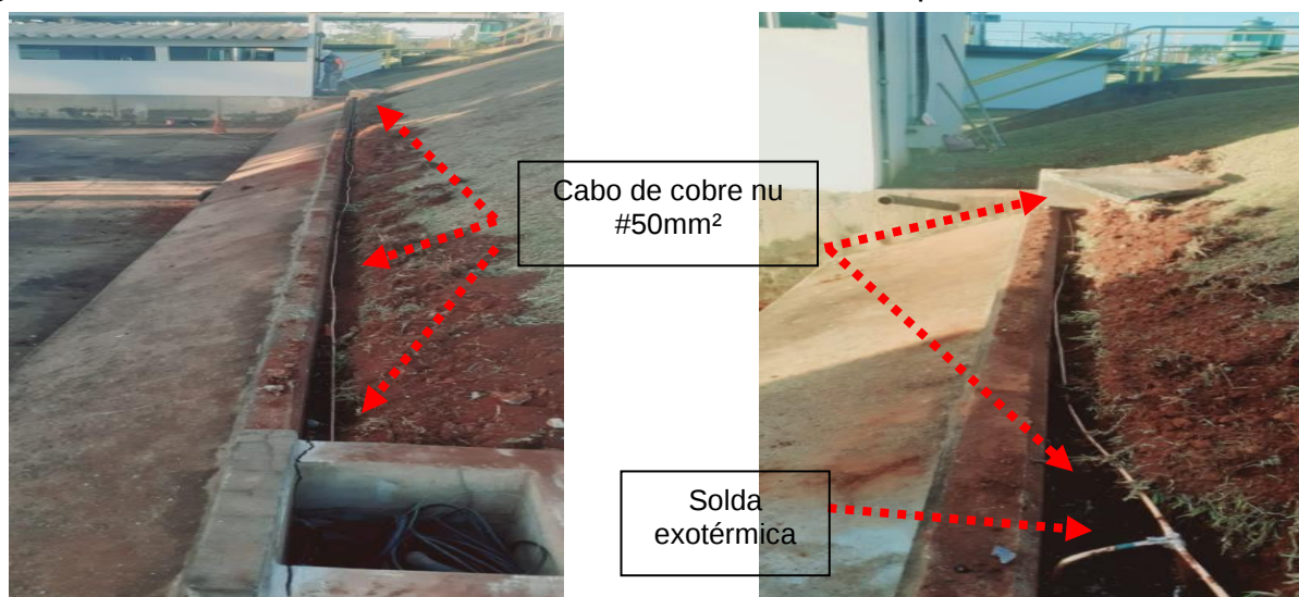
Figuras 263 e 264: Malha de aterramento construída nos tanques de armazenamento de água.
