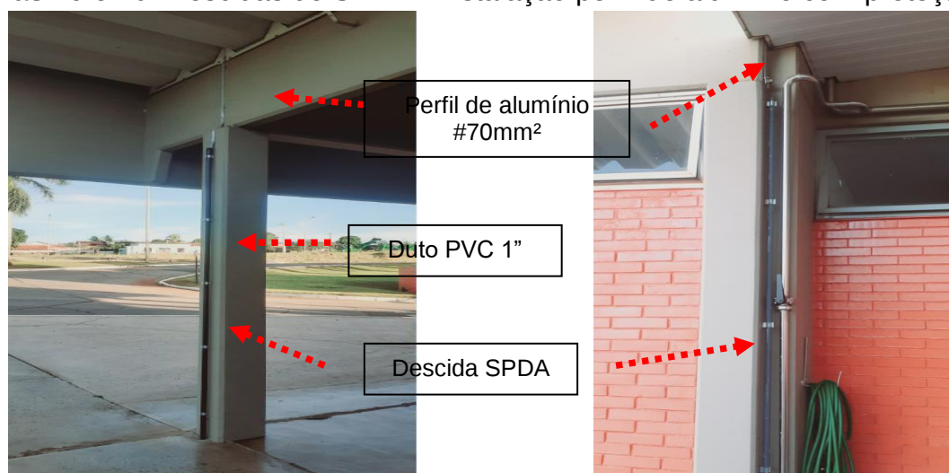
Figuras 21 e 22: Descidas do SPDA - Instalação perfil de alumínio com proteção duto PVC.
