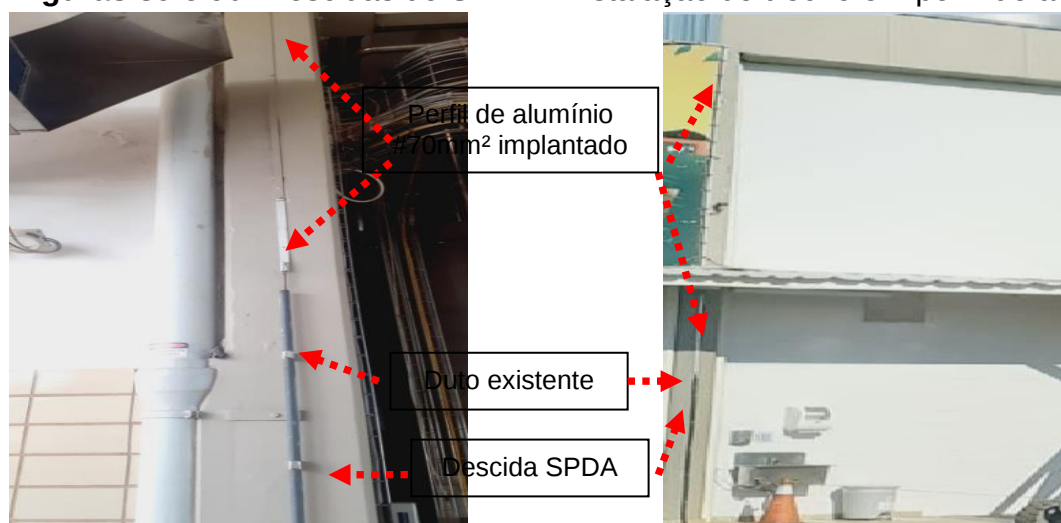
Figuras 91 e 92: Descidas do SPDA - Instalação de trecho em perfil de alumínio.
