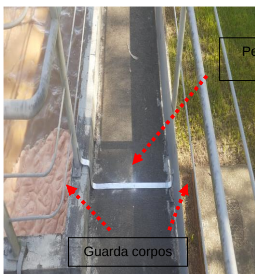
Figuras 297 e 298: Instalação de perfil de alumínio interligando os guarda corpos no ETA.
