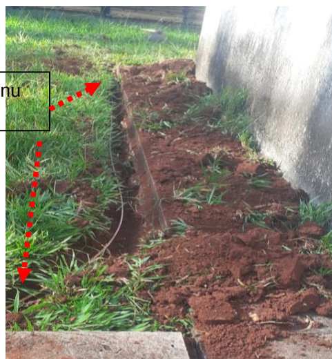
Figuras 197 e 198: Malha de aterramento construída na área de central de Resíduos.
