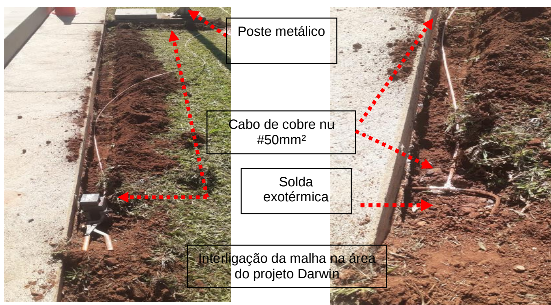
Figuras 309 e 310: Interligação construída entre a malha de aterramento de Poste de iluminação com a existente na área do projeto Darwin.
