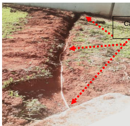
Figuras 234 e 235: Malha de aterramento construída na estação de tratamento de água
