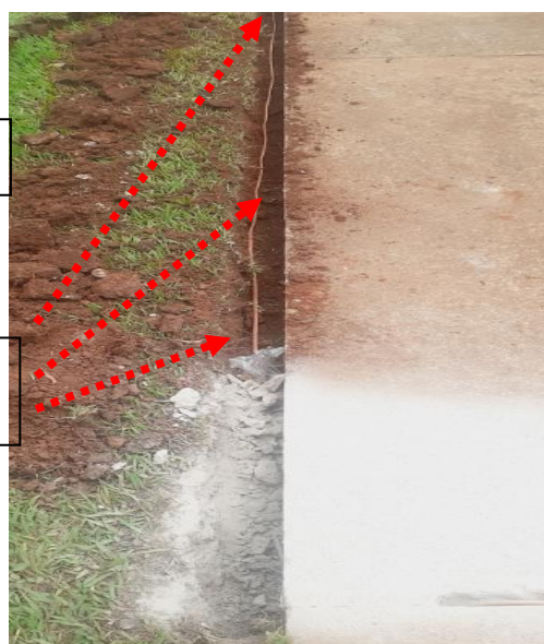
Figuras 03 e 04: Trecho da malha construída em cabo de cobre nu #50mm 2 .
