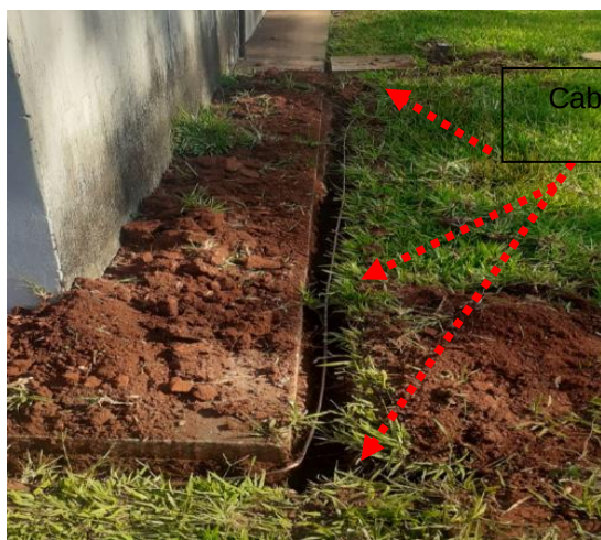
Figuras 199 e 200: Malha de aterramento construída na área de central de Resíduos.
