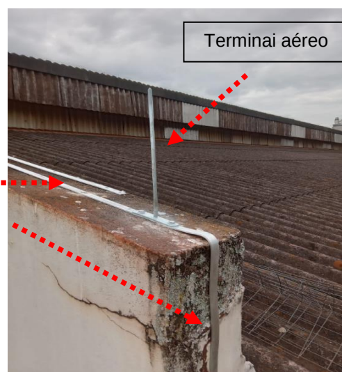
Figuras 125 e 126: Implantação de malha captora e terminais sobre a platibanda em alvenaria.
