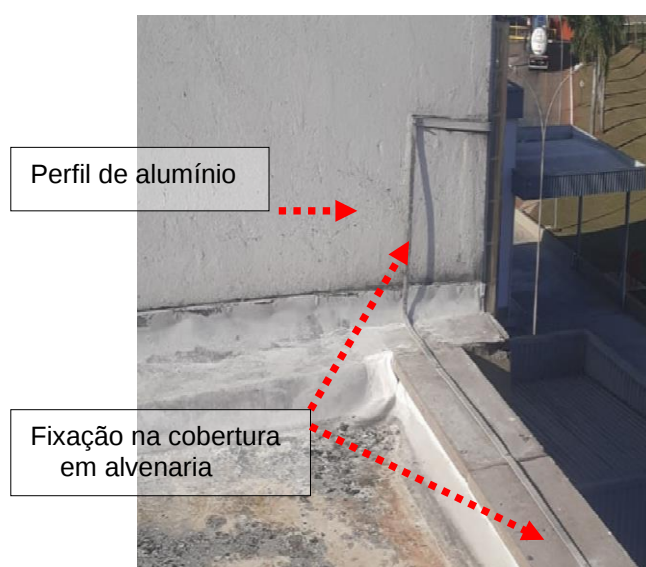
Figura 94: Malha captora - Fixação de trecho em perfil de alumínio sobre a alvenaria.
