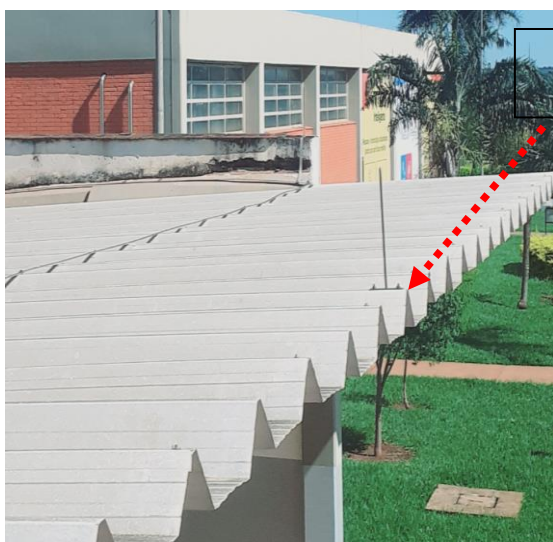
Figuras 59 e 60: Instalação de terminal aéreo faltante conforme projeto
