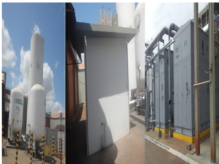
Figura 212: Gás inerte / Chillers
