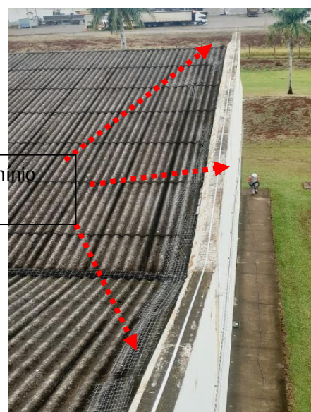
Figuras 127 e 128: Implantação de malha captora e terminais sobre a platibanda em alvenaria.
