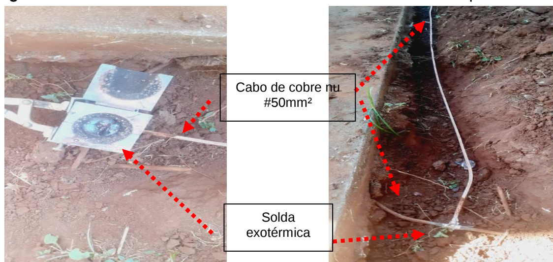
Figuras 285 e 286: Malha de aterramento construída na área do depósito de cinzas.
