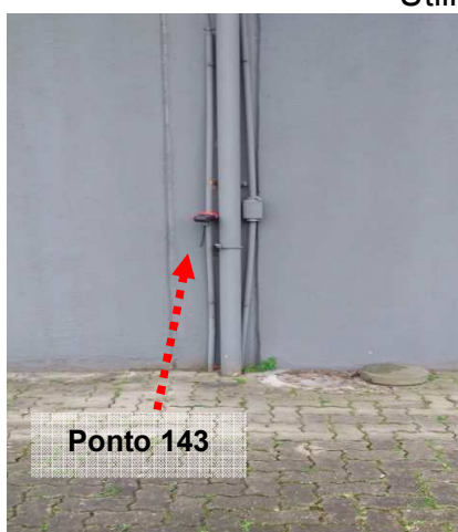
Figuras 902 e 903: Medição do ensaio realizado no ponto 143 – Descida do SPDA – Utilidades – Prédio 28.
