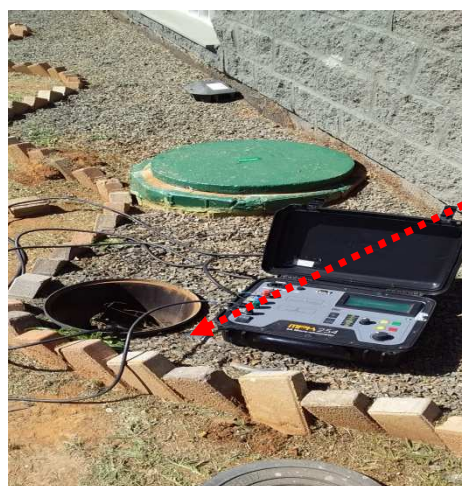
Figuras 595: Referência – Vestiário e Restaurante Novo – Prédio 29
