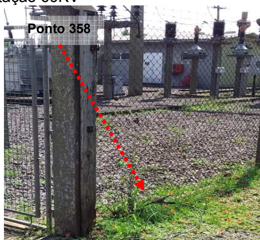
Figuras 654 e 655: Medição 360// Ponto 358 – Condutor de Aterramento - Cerca metálica – Subestação 69KV
