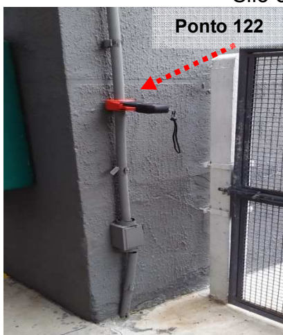
Figuras 874 e 875: Medição do ensaio realizado no ponto 122 – Descida do SPDA – Silo e Açúcar – Prédio 03.
