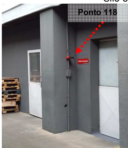
Figuras 866 e 867: Medição do ensaio realizado no ponto 118 – Descida do SPDA – Silo e Açúcar – Prédio 03.
