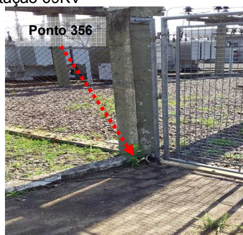
Figuras 650 e 651: Medição 358// Ponto 356 – Condutor de Aterramento - Cerca metálica – Subestação 69KV
