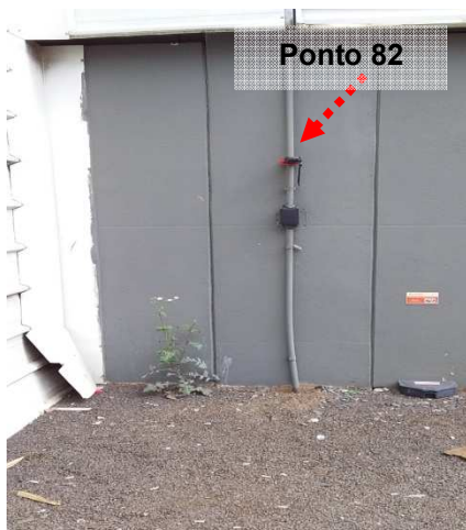
Figuras 804 e 805: Medição do ensaio realizado no ponto 82 – Descida do SPDA – Engarrafamento/Estoque – Prédio 01.
