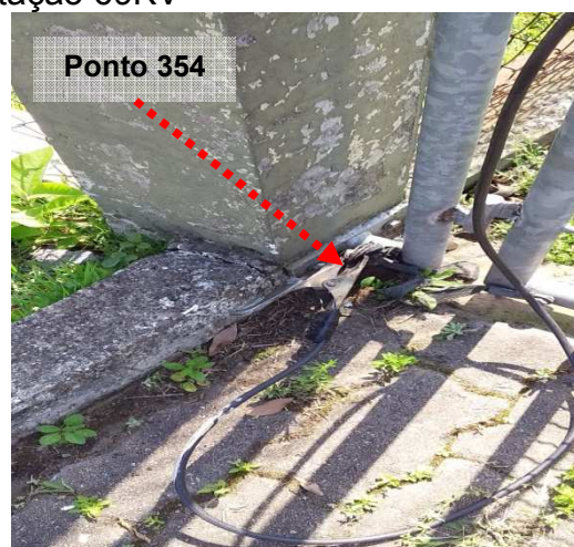
Figuras 644 e 645: Medição 355// Ponto 354 – Condutor de Aterramento - Cerca metálica – Subestação 69KV
