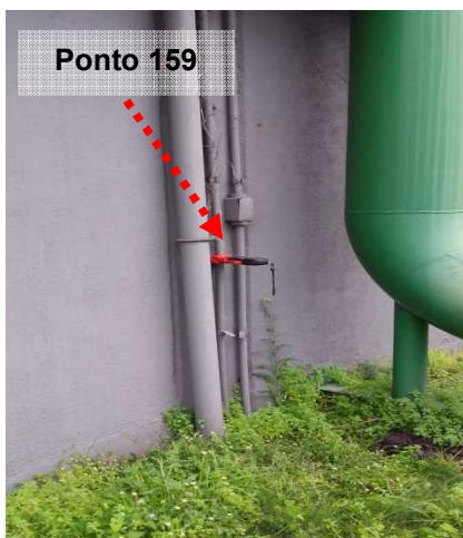
Figuras 924 e 925: Medição do ensaio realizado no ponto 159 – Descida do SPDA – Utilidades – Prédio 28.
