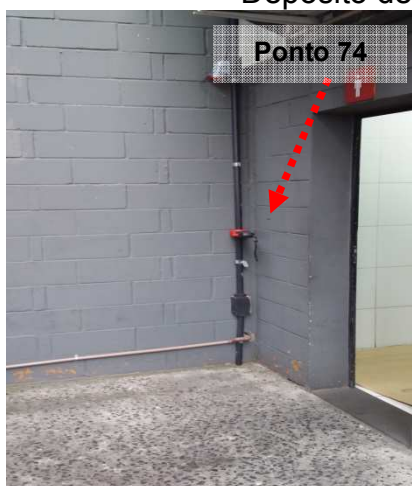
Figuras 788 e 789: Medição do ensaio realizado no ponto 74 – Descida do SPDA – Depósito de Latas e Sopro – Prédio 02.
