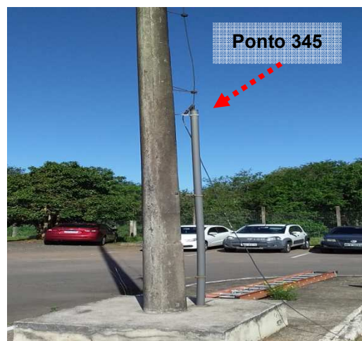
Figuras 635 e 636: Medição 348// Ponto 345 – Captor Franklin.
