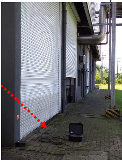
Figuras 440: Referência – Utilidades – Prédio 28.
