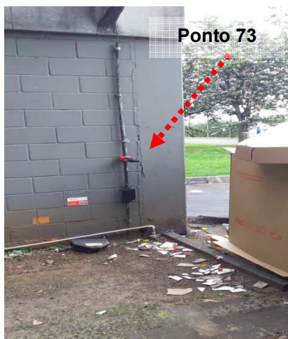
Figuras 786 e 787: Medição do ensaio realizado no ponto 73 – Descida do SPDA – Depósito de Latas e Sopro – Prédio 02.
