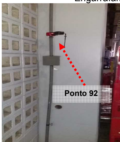
Figuras 820 e 821: Medição do ensaio realizado no ponto 92 – Descida do SPDA – Engarrafamento/Estoque – Prédio 01.
