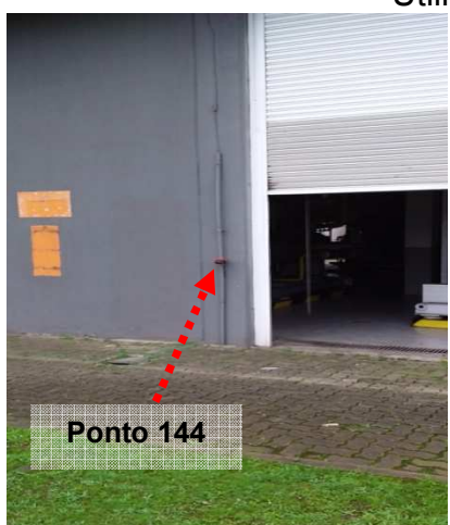
Figuras 904 e 905: Medição do ensaio realizado no ponto 144 – Descida do SPDA – Utilidades – Prédio 28.
