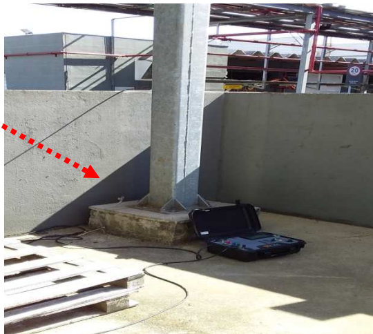
Figuras 479: Referência – Utilidades – Prédio 28.
