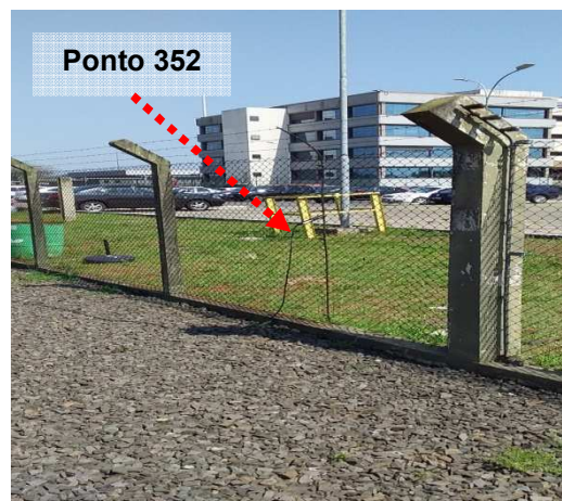
Figuras 640 e 641: Medição 353// Ponto 352 – Condutor de Aterramento - cerca metálica – Subestação 69KV
