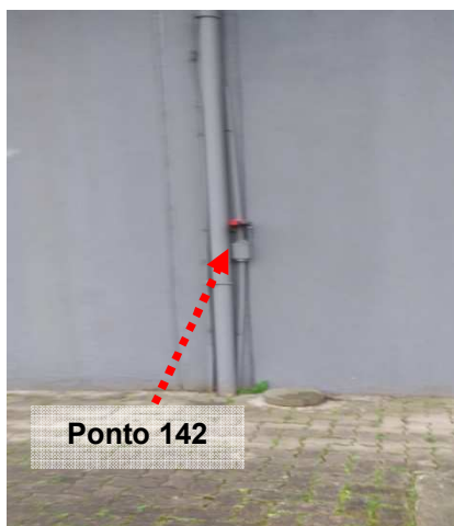
Figuras 900 e 901: Medição do ensaio realizado no ponto 142 – Descida do SPDA – Utilidades – Prédio 28.
