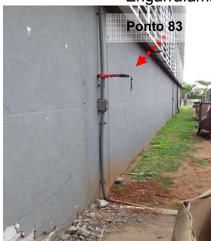
Figuras 806 e 807: Medição do ensaio realizado no ponto 83 – Descida do SPDA – Engarrafamento/Estoque – Prédio 01.
