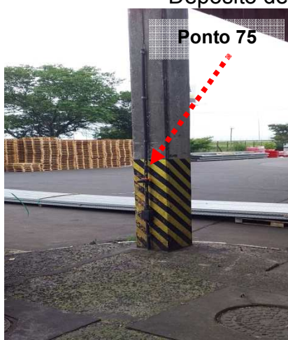
Figuras 790 e 791: Medição do ensaio realizado no ponto 75 – Descida do SPDA – Depósito de Latas e Sopro – Prédio 02.
