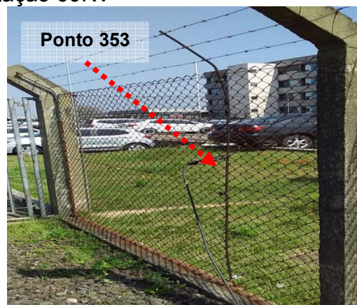
Figuras 642 e 643: Medição 354// Ponto 353 – Condutor de Aterramento - Cerca metálica – Subestação 69KV
