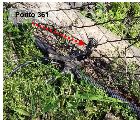
Figuras 658 e 659: Medição 364// Ponto 361 – Condutor de Aterramento - Cerca metálica – Subestação 69KV
