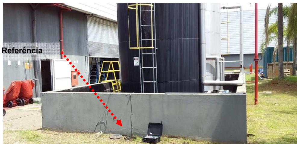
Figuras 460: Referência – Utilidades – Prédio 28.
