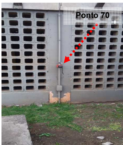
Figuras 780 e 781: Medição do ensaio realizado no ponto 70 – Descida do SPDA – Depósito de Latas e Sopro – Prédio 02.
