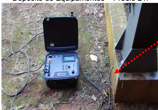
Figuras 571: Referência – Caixa de Inspeção de solo Deposito de Equipamentos – Prédio 21.
