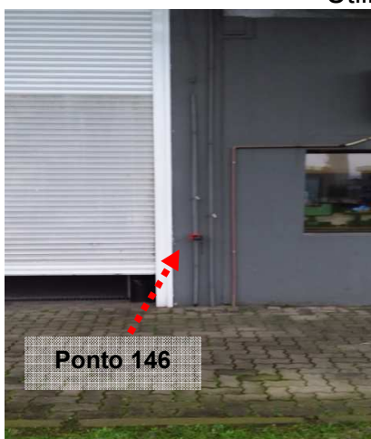
Figuras 908 e 909: Medição do ensaio realizado no ponto 146 – Descida do SPDA – Utilidades – Prédio 28.
