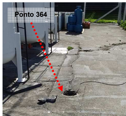
Figuras 663 e 664: Medição 366// Ponto 364 – Condutor de Aterramento - Caixa de Inspeção de Solo – Abastecimento GLP Prédio 27
