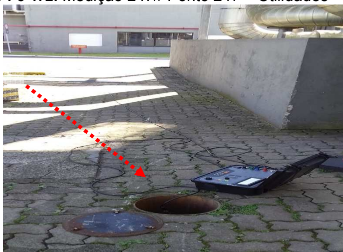
Figuras 473: Referência – Utilidades – Prédio 28.
