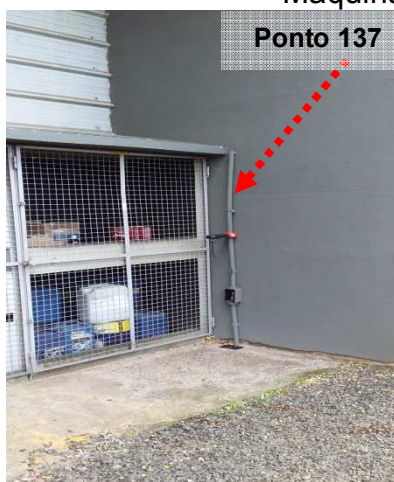
Figuras 890 e 891: Medição do ensaio realizado no ponto 137 – Descida do SPDA – Máquinas Auxiliares – Prédio 04.
