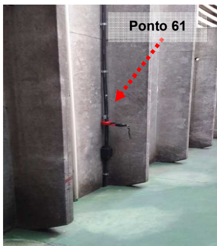
Figuras 762 e 763: Medição do ensaio realizado no ponto 61 – Descida do SPDA – Depósito de Latas e Sopro – Prédio 02.
