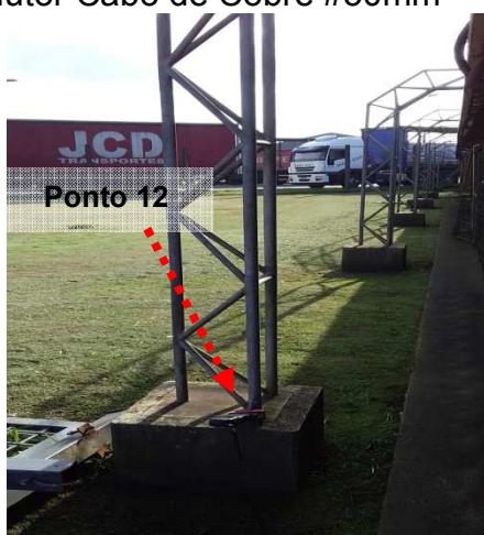
Figuras 692 e 693: Medição do ensaio realizado no ponto 12 – Condutor Cabo de Cobre #50mm 2 – Estacionamento Motos e Bicicletas – Prédio 17
