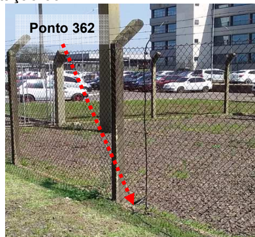
Figuras 660 e 661: Medição 365// Ponto 362 – Condutor de Aterramento - Cerca metálica – Subestação 69KV
