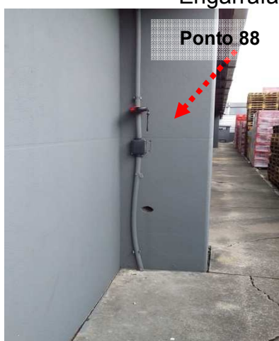
Figuras 812 e 813: Medição do ensaio realizado no ponto 88 – Descida do SPDA – Engarrafamento/Estoque – Prédio 01.
