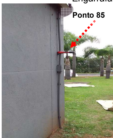
Figuras 808 e 809: Medição do ensaio realizado no ponto 85 – Descida do SPDA – Engarrafamento/Estoque – Prédio 01.
