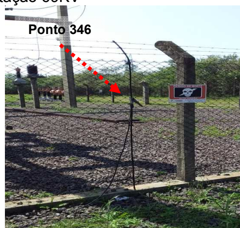
Figuras 648 e 649: Medição 357// Ponto 346 – Condutor de Aterramento - Cerca metálica – Subestação 69KV
