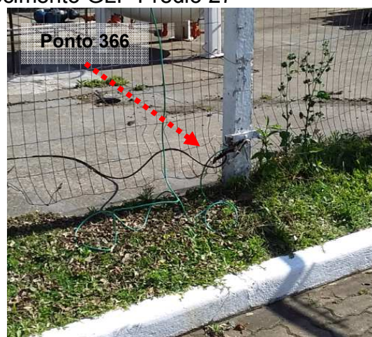
Figuras 667 e 668: Medição 368// Ponto 366 – Condutor de Aterramento - Barramento de Equipotencialização Principal – Abastecimento GLP - Prédio 27
