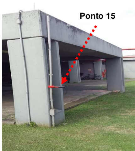
Figuras 696 e 697: Medição do ensaio realizado no ponto 15 – Descida do SPDA – Estacionamento Motos Escritório CCIL e Recrutamento – Prédio 09
