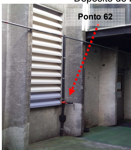
Figuras 764 e 765: Medição do ensaio realizado no ponto 62 – Descida do SPDA – Depósito de Latas e Sopro – Prédio 02.
