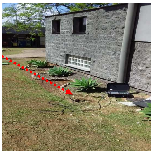
Figuras 600: Referência – Vestiário e Restaurante Novo – Prédio 29.
