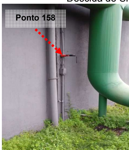
Figuras 922 e 923: Medição do ensaio realizado no ponto 158 – Descida do SPDA – Utilidades – Prédio 28.
