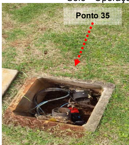
Figuras 722 e 723: Medição do ensaio realizado no ponto 35 – Caixa de Inspeção de Solo - Operações Logísticas – Prédio 31A
