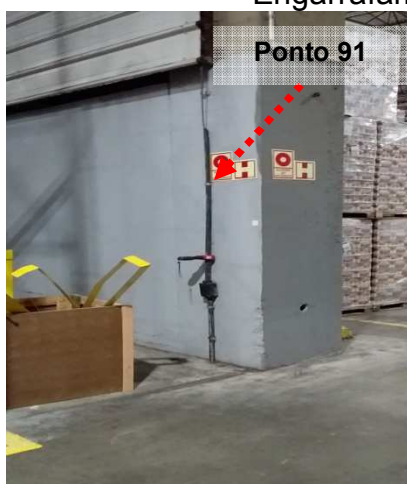
Figuras 818 e 819: Medição do ensaio realizado no ponto 91 – Descida do SPDA – Engarrafamento/Estoque – Prédio 01.
