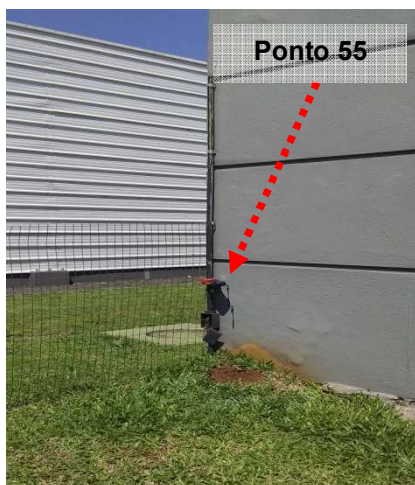
Figuras 750 e 751: Medição do ensaio realizado no ponto 55 – Descida do SPDA – Manutenção da Frota – Prédio 07.
