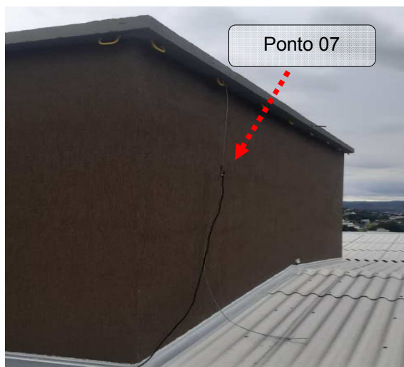
Figuras 19 e 20: Ponto 07 - Medição na cobertura – Descida 01A do SPDA.
