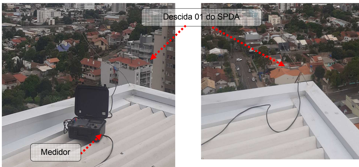
Figuras 07 e 08: Descida 01 do SPDA - Pilar nº 30 na cobertura da edificação.
