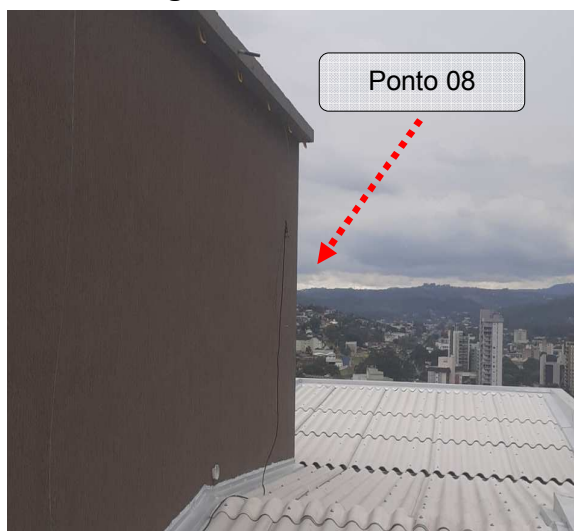
Figuras 21 e 22: Ponto 08 - Medição na cobertura – Descida 04A do SPDA.
