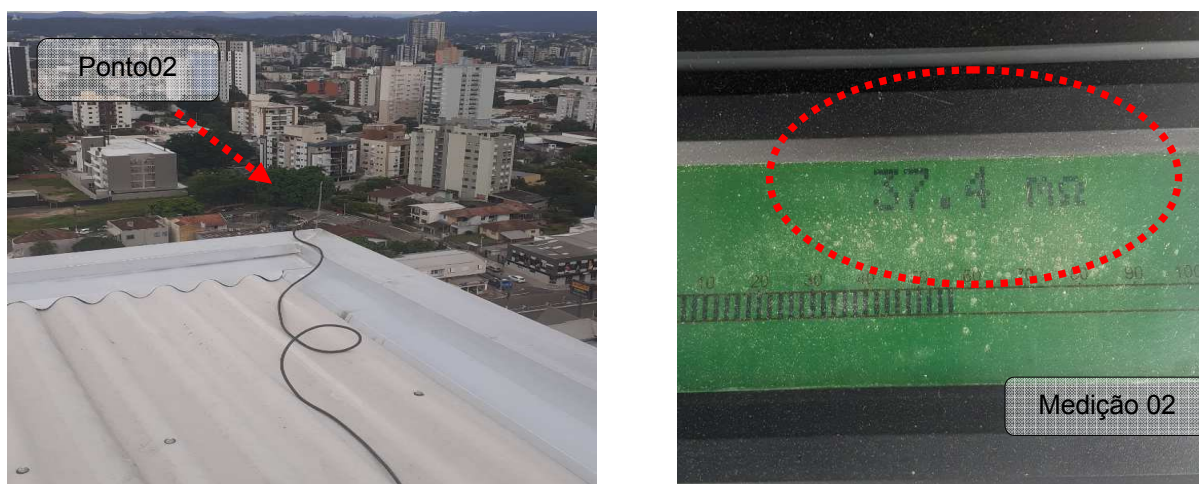
Figuras 09 e 10: Ponto 02 – Medição na cobertura – Descida 04 do SPDA.
