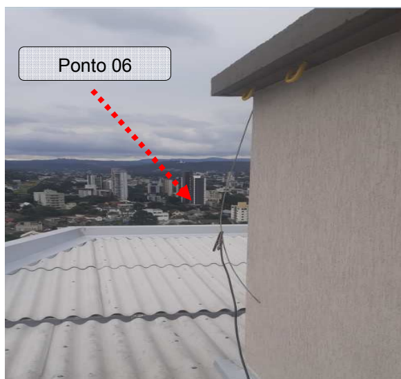
Figuras 17 e 18: Ponto 06 - Medição na cobertura – Descida 03B do SPDA.
