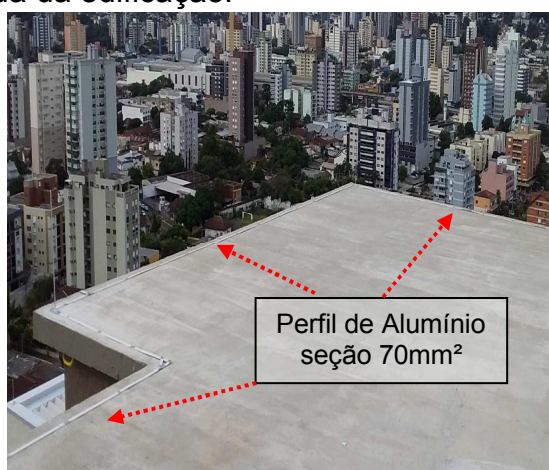
Figuras 37 e 38: Malha captora implantada em perfil de alumínio fixado sobre a laje em alvenaria em cota mais elevada da edificação.
