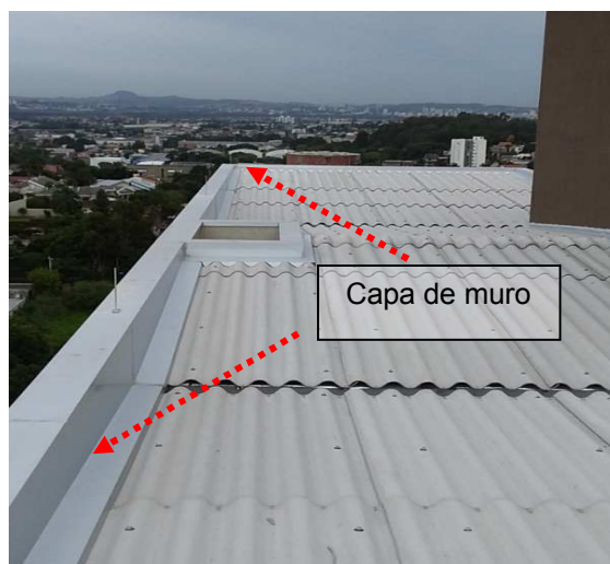
Figuras 55 e 56: Malha captora natural (capa de muro), entorno edificação muretas nível mais baixo.
