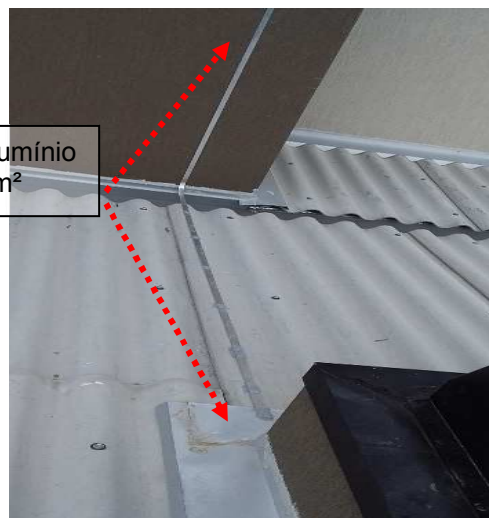
Figuras 61 e 62: Interligações entre desnível de altura no sistema de captação.
