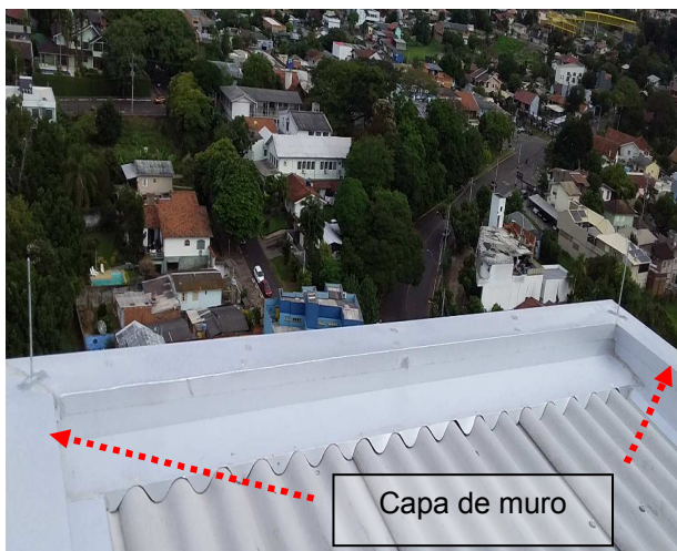
Figuras 47 e 48: Malha captora natural (capa de muro), entorno edificação muretas nível mais baixo.
