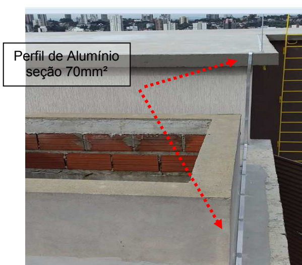
Figuras 65 e 66: Interligações entre desnível de altura no sistema de captação.
