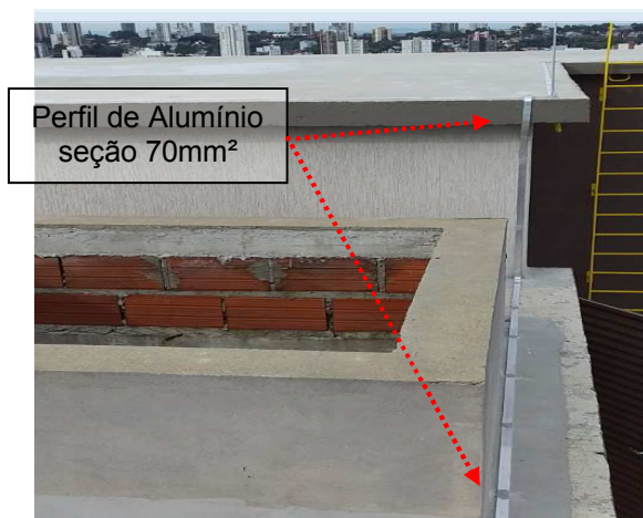
Figuras 41 e 42: Malha captora implantada em perfil de alumínio fixado sobre a laje em alvenaria em cota mais elevada da edificação.
