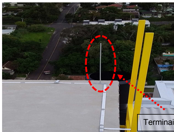
Figuras 01 e 02: Terminais aéreos 60cm instalados no volume mais elevado da edificação sobre a malha captora em perfil de alumínio # 70mm².
