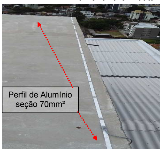
Figuras 31 e 32: Malha captora implantada em perfil de alumínio fixado sobre a laje em alvenaria em cota mais elevada da edificação.
