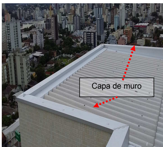
Figuras 55 e 56: Malha captora natural (capa de muro), entorno edificação muretas nível mais baixo.
