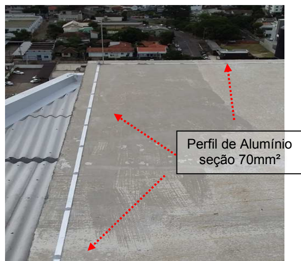
Figuras 43 e 44: Malha captora implantada em perfil de alumínio fixado sobre a laje em alvenaria em cota mais elevada da edificação.
