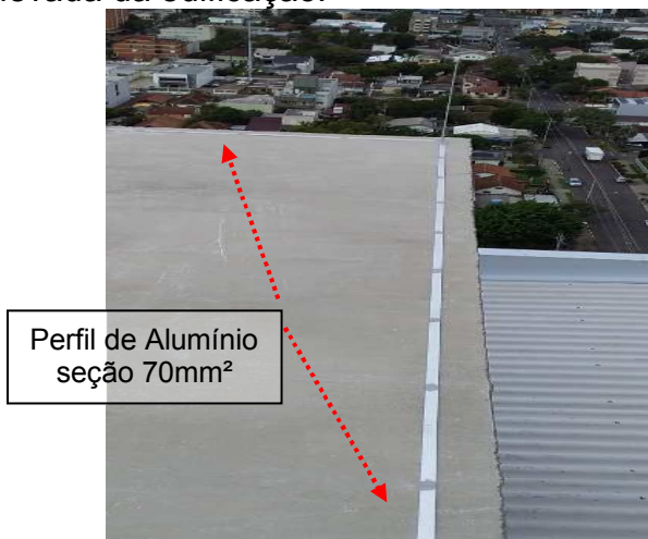
Figuras 29 e 30: Malha captora implantada em perfil de alumínio fixado sobre a laje em alvenaria em cota mais elevada da edificação.
