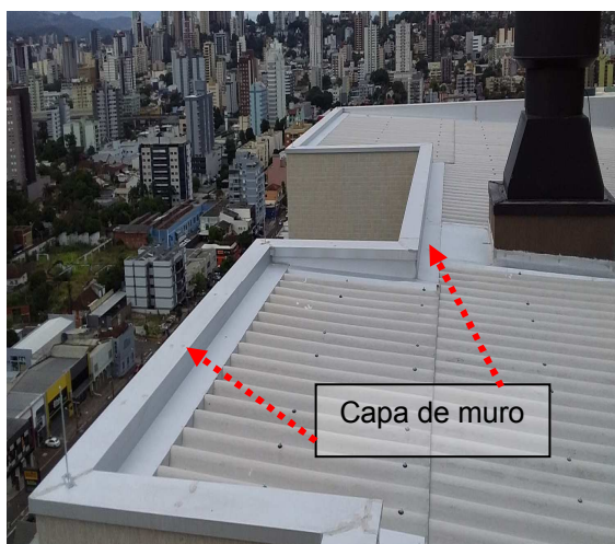
Figuras 53 e 54: Malha captora natural (capa de muro), entorno edificação muretas nível mais baixo.
