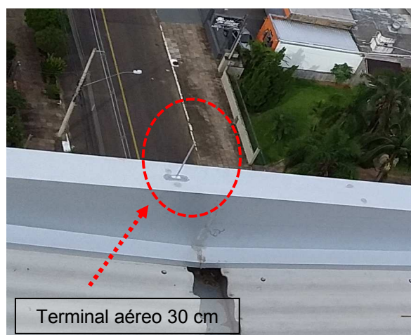
Figuras 09 e 10: Terminais aéreos 30cm instalados em cota mais baixa da cobertura sobre a malha captora em capa de muro.
