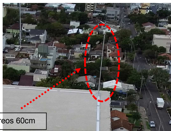
Figuras 01 e 02: Terminais aéreos 60cm instalados no volume mais elevado da edificação sobre a malha captora em perfil de alumínio # 70mm².
