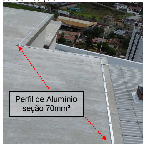
Figuras 31 e 32: Malha captora implantada em perfil de alumínio fixado sobre a laje em alvenaria em cota mais elevada da edificação.
