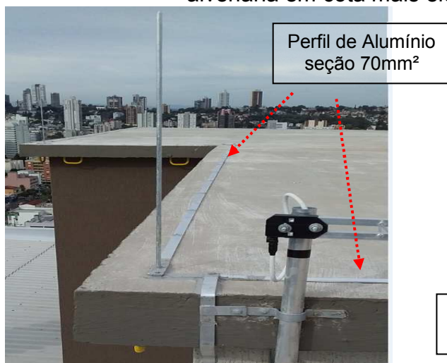
Figuras 35 e 36: Malha captora implantada em perfil de alumínio fixado sobre a laje em alvenaria em cota mais elevada da edificação.
