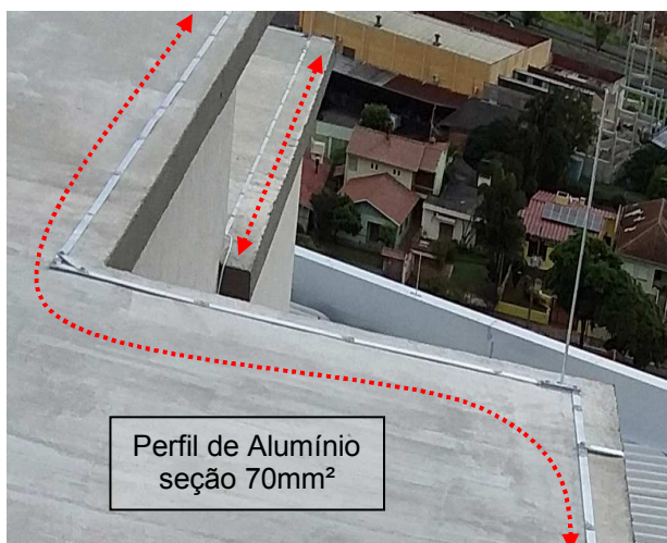
Figuras 27 e 28: Malha captora implantada em perfil de alumínio fixado sobre a laje em alvenaria em cota mais elevada da edificação.
