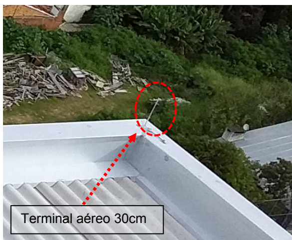
Figuras 07 e 08: Terminais aéreos 30cm instalados em cota mais baixa da cobertura sobre a malha captora em capa de muro.
