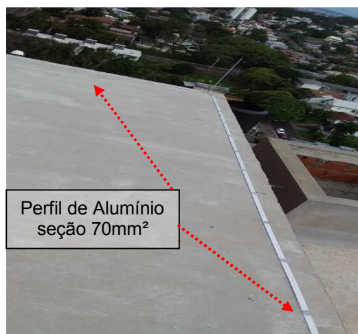
Figuras 33 e 34: Malha captora implantada em perfil de alumínio fixado sobre a laje em alvenaria em cota mais elevada da edificação.
