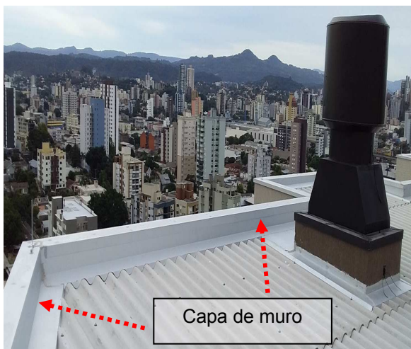
Figuras 51 e 52: Malha captora natural (capa de muro), no entorno da edificação em nível mais baixo.
