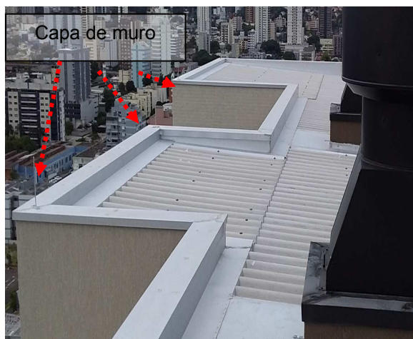
Figuras 51 e 52: Malha captora natural (capa de muro), no entorno da edificação em nível mais baixo.
