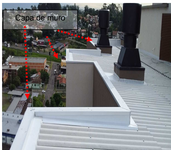
Figuras 45 e 46: Malha captora natural (capa de muro), no entorno da edificação em nível mais baixo.
