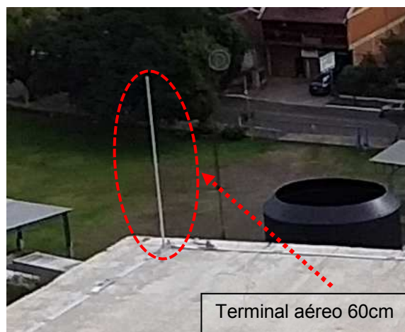
Figuras 05 e 06: Terminais aéreos 60cm instalados no volume mais elevado da edificação sobre a malha captora em perfil de alumínio # 70mm².
