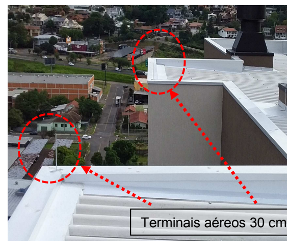
Figuras 11 e 12: Terminais aéreos 30cm instalados em cota mais baixa da cobertura sobre a malha captora em capa de muro.
