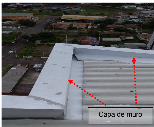
Figuras 49 e 50: Malha captora natural (capa de muro), entorno edificação muretas nível mais baixo.
