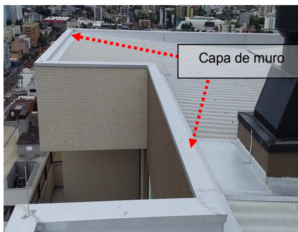
Figuras 53 e 54: Malha captora natural (capa de muro), entorno edificação muretas nível mais baixo.
