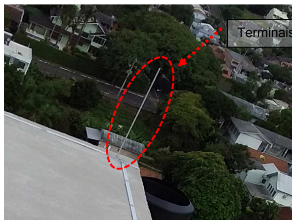
Figuras 03 e 04: Terminais aéreos 60cm instalados no volume mais elevado da edificação sobre a malha captora em perfil de alumínio # 70mm².
