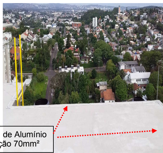
Figuras 35 e 36: Malha captora implantada em perfil de alumínio fixado sobre a laje em alvenaria em cota mais elevada da edificação.
