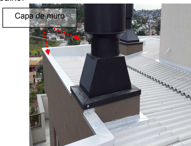
Figuras 47 e 48: Malha captora natural (capa de muro), entorno edificação muretas nível mais baixo.
