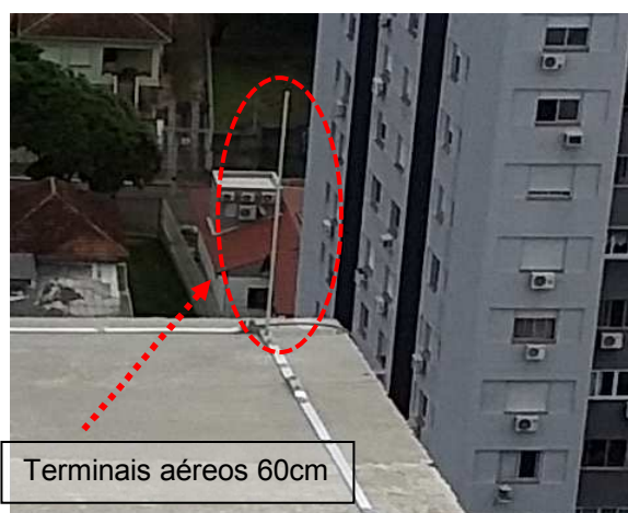
Figuras 05 e 06: Terminais aéreos 60cm instalados no volume mais elevado da edificação sobre a malha captora em perfil de alumínio # 70mm².
