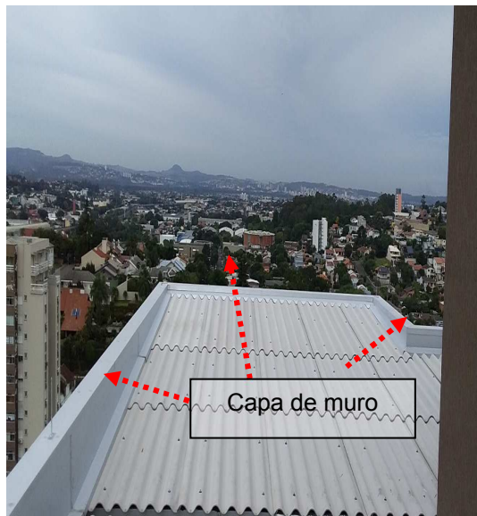
Figuras 57 e 58: Malha captora natural (capa de muro), no entorno da edificação em nível mais baixo.
