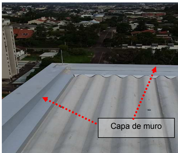
Figuras 45 e 46: Malha captora natural (capa de muro), no entorno da edificação em nível mais baixo.
