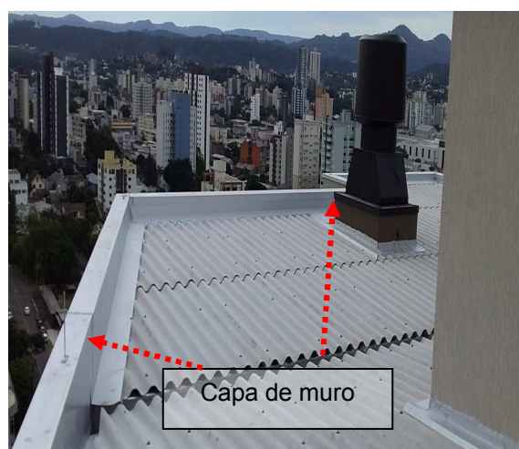
Figuras 49 e 50: Malha captora natural (capa de muro), entorno edificação muretas nível mais baixo.
