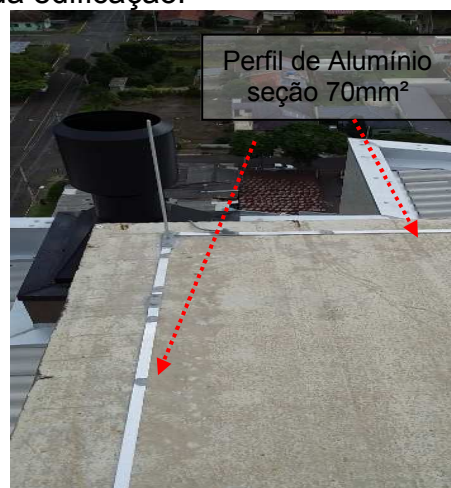
Figuras 41 e 42: Malha captora implantada em perfil de alumínio fixado sobre a laje em alvenaria em cota mais elevada da edificação.
