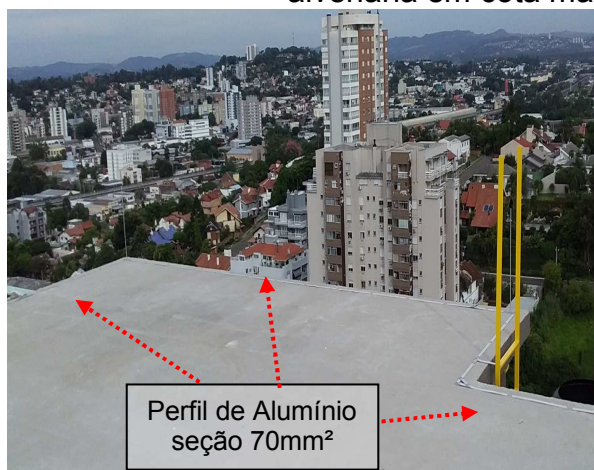
Figuras 37 e 38: Malha captora implantada em perfil de alumínio fixado sobre a laje em alvenaria em cota mais elevada da edificação.
