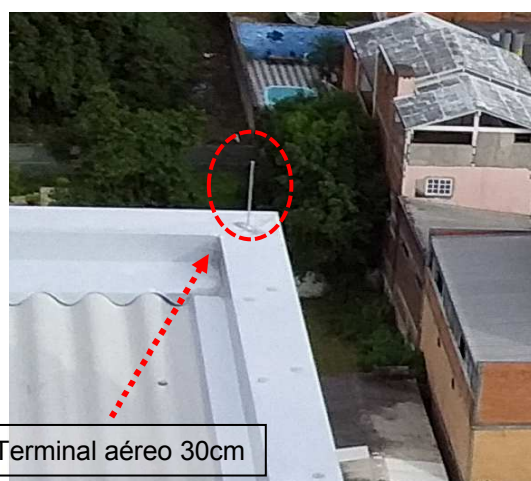
Figuras 07 e 08: Terminais aéreos 30cm instalados em cota mais baixa da cobertura sobre a malha captora em capa de muro.
