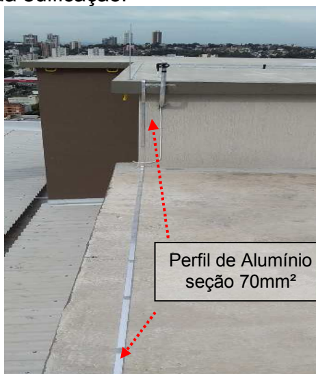
Figuras 43 e 44: Malha captora implantada em perfil de alumínio fixado sobre a laje em alvenaria em cota mais elevada da edificação.
