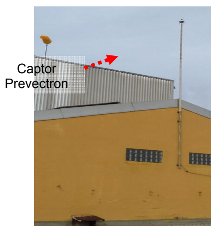
Figuras 247 e 248: Sistema de Captação– Ribeira Sólida/Refeit/Vest/Guarita/Recep.
