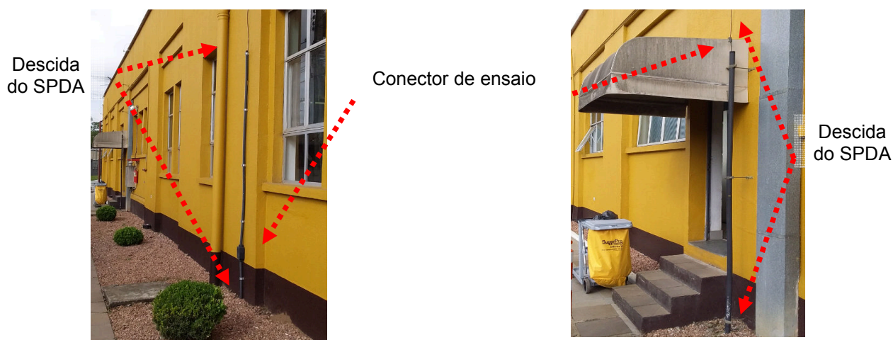
Figuras 259 e 260: Sistema de Descidas – Ribeira Sólida/Refeit/Vest/Guarita/Recep.
