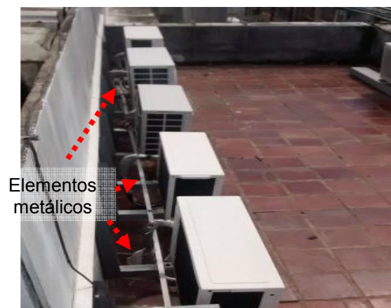
Figuras 279 e 280: Sistema de Captação- CDTC.
