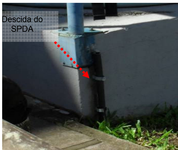
Figuras 91 e 92: Subsistema de Descidas – Produção de polímeros.
