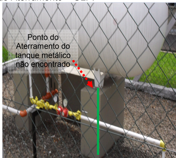
Figuras 236 e 237: Sistema de Aterramento – GLP.
