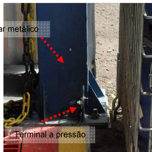
Figura 07 e 08: Sistema de descida Prédio Acabamento.
