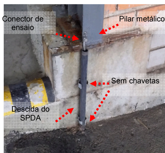
Figuras 154 e 155: Sistema de Descidas-Ribeira Líquida- conexão oxidada – Sem chavetas
