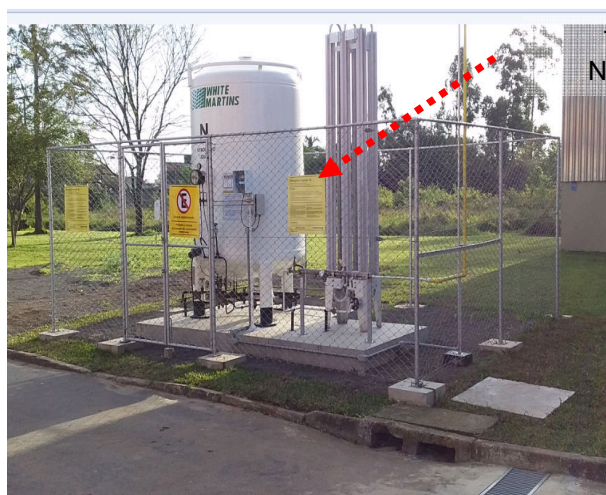
Figuras 109 e 110: Estruturas com SPDA instalado não identificadas nas plantas de referência.
