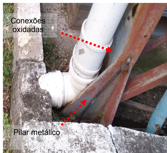
Figuras 144 e 145: Conexões Oxidadas – ADM / Expedição / Manutenção /LCQ.
