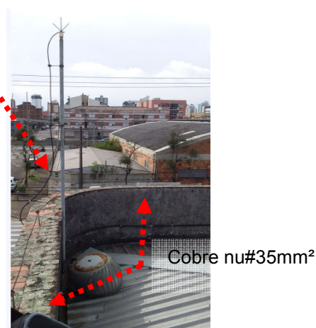
Figuras 247 e 248: Sistema de Captação– Ribeira Sólida/Refeit/Vest/Guarita/Recep.
