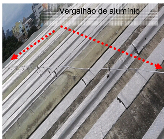
Figuras 285 e 286: Sistema de Captação- CDTC.
