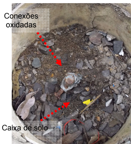
Figuras 190 e 191: Conexões oxidadas / Obstruídas – Caixa de inspeção de solo
