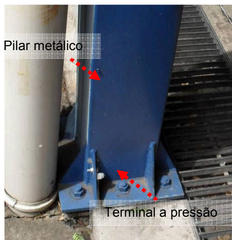
Figura 07 e 08: Sistema de descida Prédio Acabamento.
