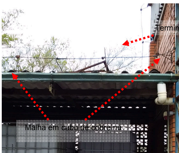
Figuras 161 e 162: Sistema de captação – Tancagem - lavagem de contêiner
