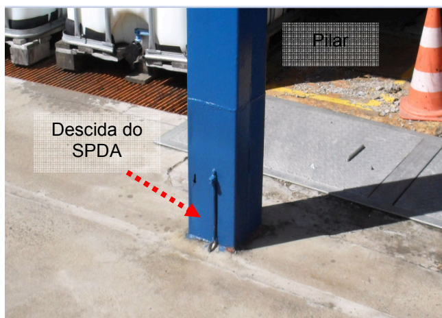
Figuras 89 e 90: Subsistema de Descidas – Produção de polímeros.
