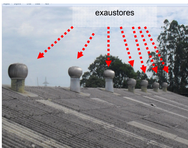
Figuras 130 e 131: Sistema Captor– ADM / Expedição / Manutenção /LCQ.
