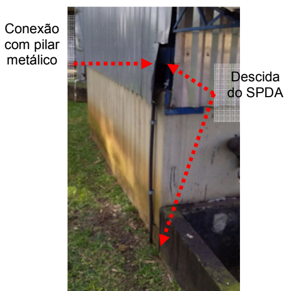
Figuras 21 e 22: Sistema de descida Prédio Tanque BPF.
