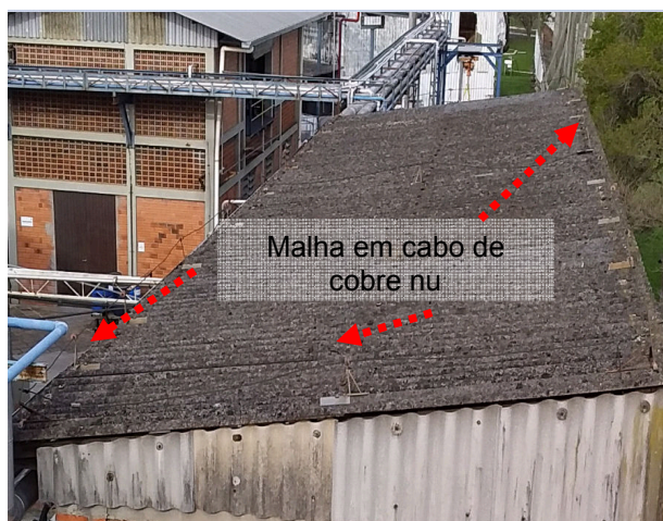
Figuras 157 e 158: Sistema de captação – Tancagem - lavagem de contêiner
