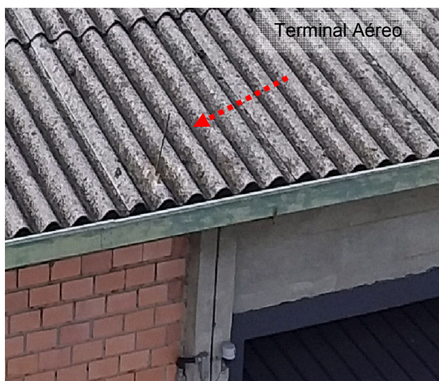
Figuras 122 e 123: Sistema Captor– ADM / Expedição / Manutenção /LCQ.
