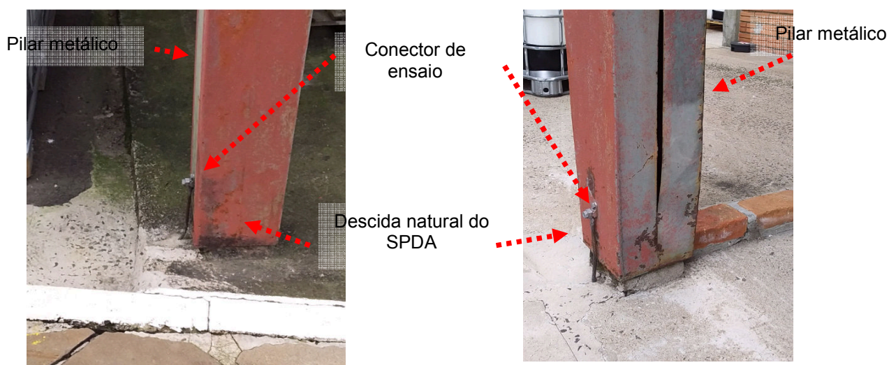
Figuras 185 e 186: Sistema de Descidas Naturais – UPET.
