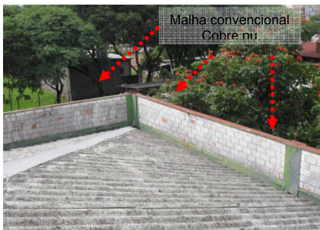
Figuras 126 e 127: Sistema Captor– ADM / Expedição / Manutenção /LCQ.
