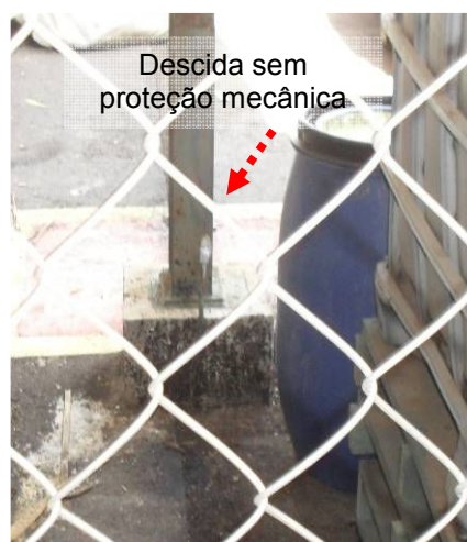
Figuras 51 e 52: Descida mal fixada e danificada - Descida sem proteção mecânica
