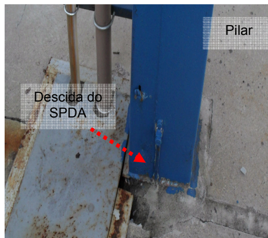
Figuras 89 e 90: Subsistema de Descidas – Produção de polímeros.
