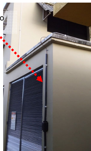
Figuras 113 e 114: Descidas do SPDA construídas na subestação
