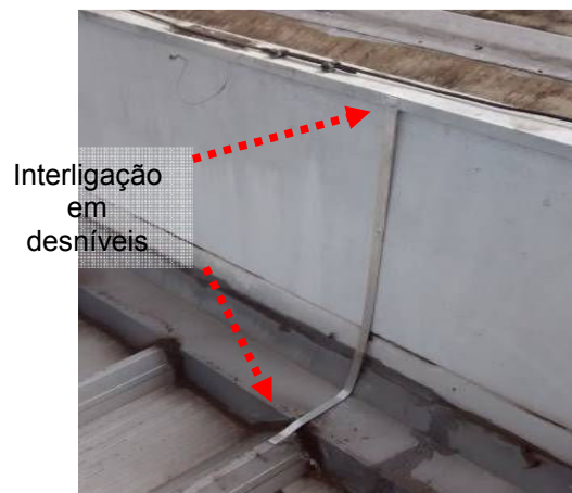
Figuras 281 e 282: Sistema de Captação- CDTC.
