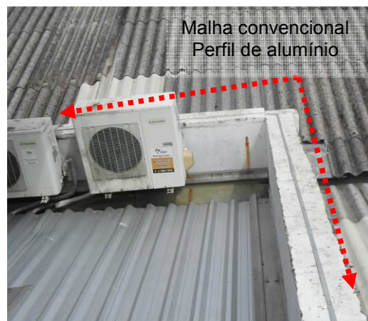
Figuras 126 e 127: Sistema Captor– ADM / Expedição / Manutenção /LCQ.
