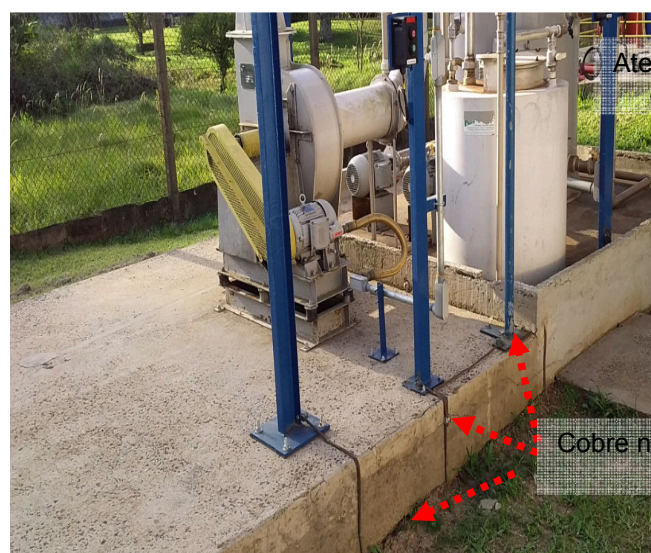
Figuras 101 e 102: Aterramento de estruturas não encontradas nas plantas de referencia.
