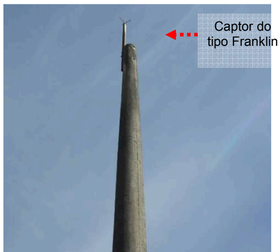
Figuras 72 e 73: Sistema Captor - Depósito de inflamáveis.
