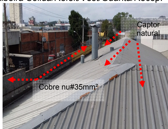
Figuras 249 e 250: Sistema de Captação– Ribeira Sólida/Refeit/Vest/Guarita/Recep.
