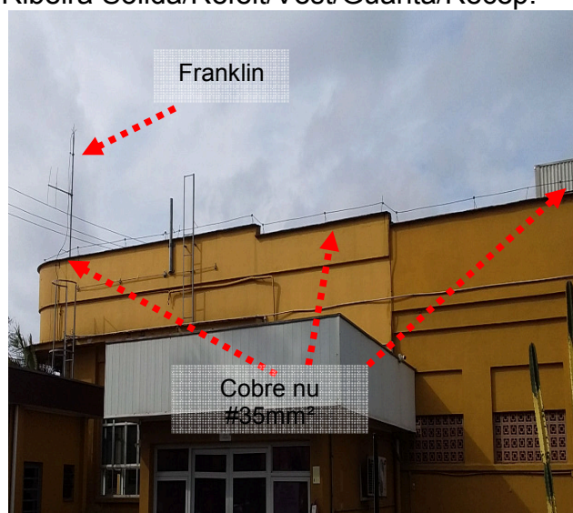
Figuras 255 e 256: Sistema de Captação– Ribeira Sólida/Refeit/Vest/Guarita/Recep.
