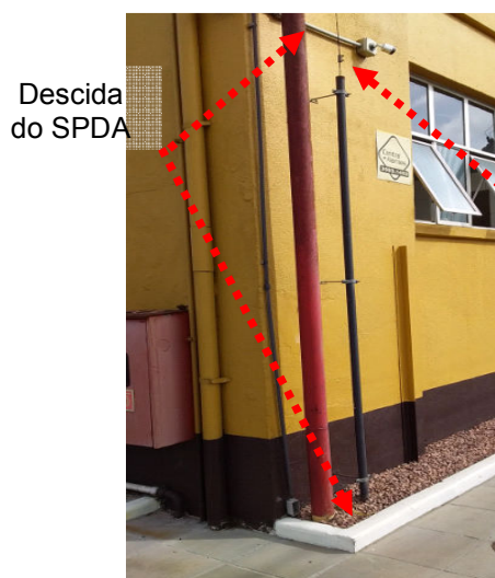
Figuras 261 e 262: Sistema de Descidas – Ribeira Sólida/Refeit/Vest/Guarita/Recep.
