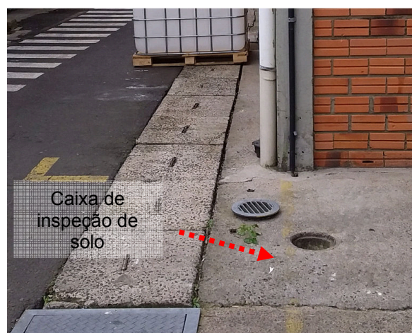
Figuras 187 e 188: Caixas de inspeção de solo – UPET.
