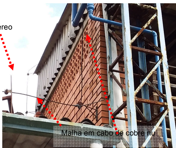
Figuras 161 e 162: Sistema de captação – Tancagem - lavagem de contêiner
