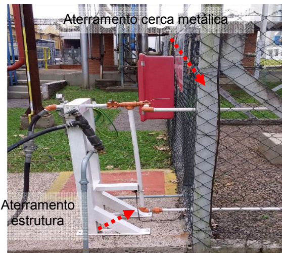
Figuras 234 e 235: Sistema de Aterramento – GLP.
