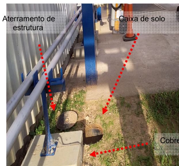
Figuras 99 e 100: Aterramento de estruturas não encontradas nas plantas de referencia.
