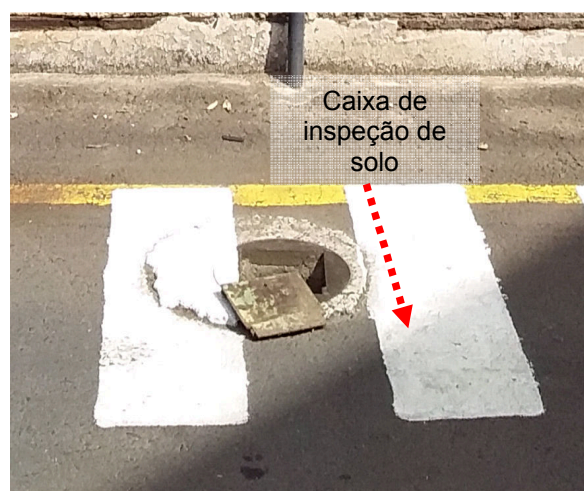
Figuras 169 e 170: Caixas de inspeção de solo – Tancagem - lavagem de contêiner
