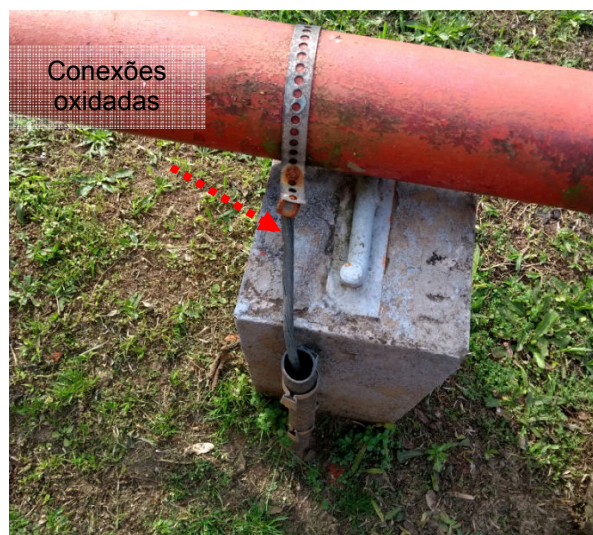
Figura 142 e 143: Conexões obstruídas e Oxidadas – ADM / Expedição / Manutenção /LCQ.
