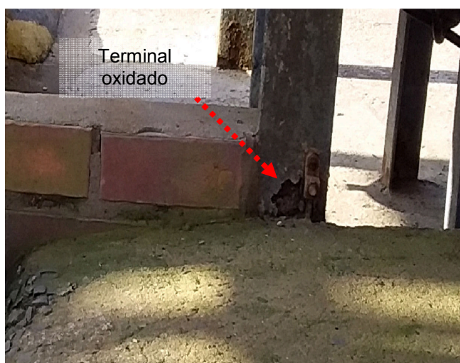
Figuras 67 e 68: Conexões oxidadas - ETER.
