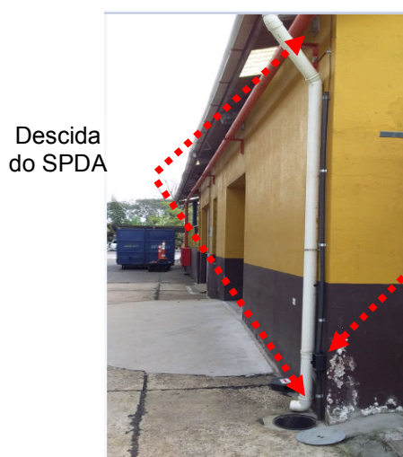
Figuras 265 e 266: Sistema de Descidas – Ribeira Sólida/Refeit/Vest/Guarita/Recep.
