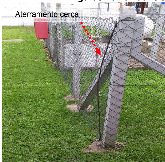
Figuras 236 e 237: Sistema de Aterramento – GLP.
