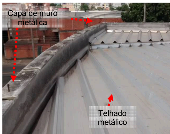
Figuras 281 e 282: Sistema de Captação- CDTC.
