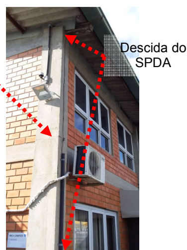
Figuras 132 e 133: Sistema de Decidas convencionais-ADM/ Expedição / Manutenção /LCQ.
