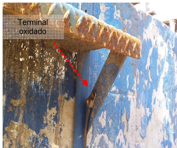
Figuras 65 e 66: Conexões oxidadas - ETER.
