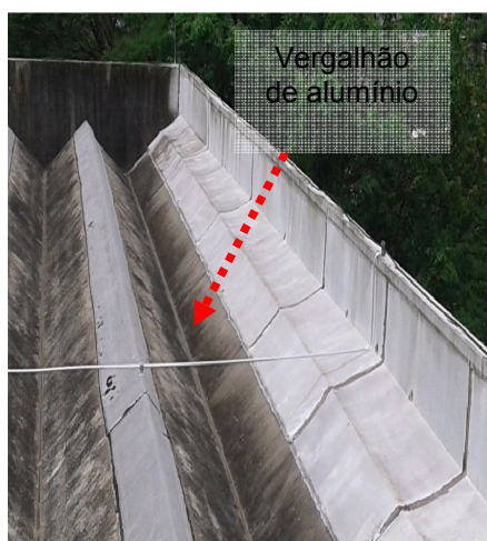
Figuras 285 e 286: Sistema de Captação- CDTC.
