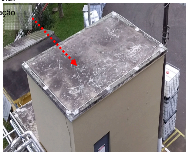
Figuras 107 e 108: Estruturas com SPDA instalado não identificadas nas plantas de referência.
