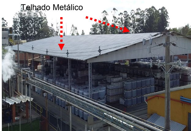
Figuras 198 e 199: Sistema de Captor – Depósito de Produtos químicos.
