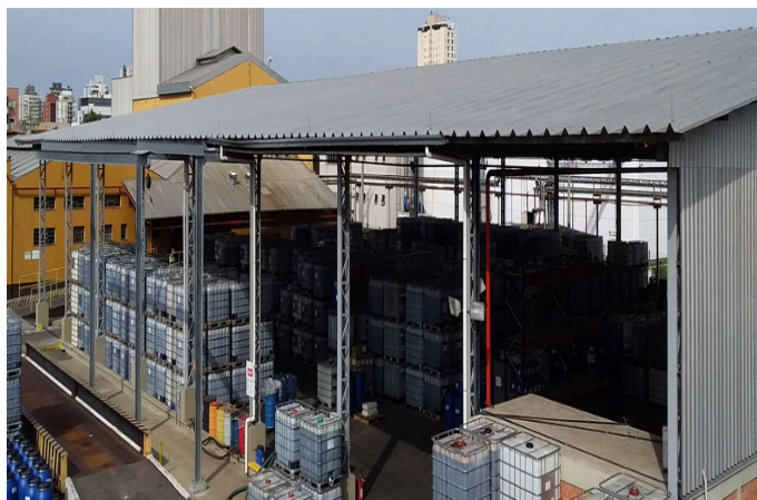
Figura 197: Depósito de matéria prima
