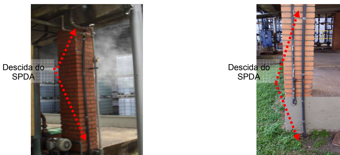
Figuras 242 e 243: Sistema de descida – Cisterna.
