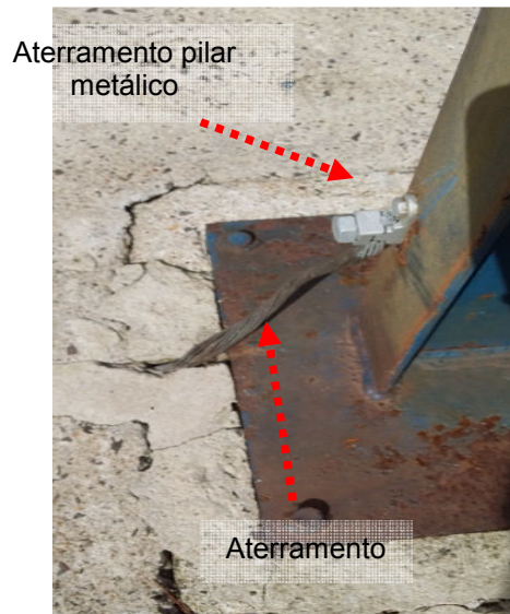
Figuras 229 e 230: Interligação de elementos metálicos ao Sistema de Aterramento
