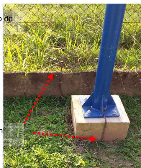
Figuras 101 e 102: Aterramento de estruturas não encontradas nas plantas de referencia.
