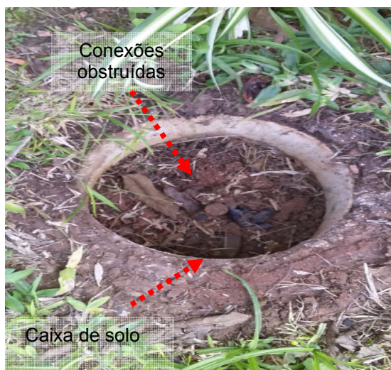
Figura 142 e 143: Conexões obstruídas e Oxidadas – ADM / Expedição / Manutenção /LCQ.
