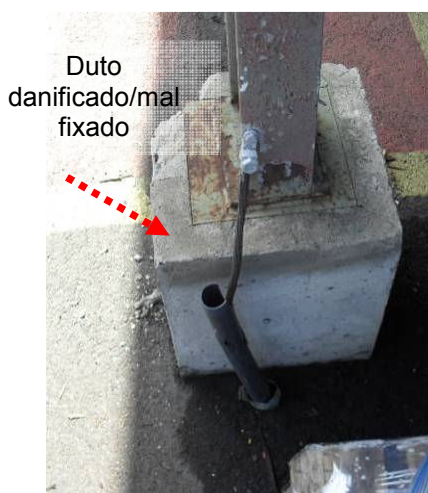
Figuras 51 e 52: Descida mal fixada e danificada - Descida sem proteção mecânica
