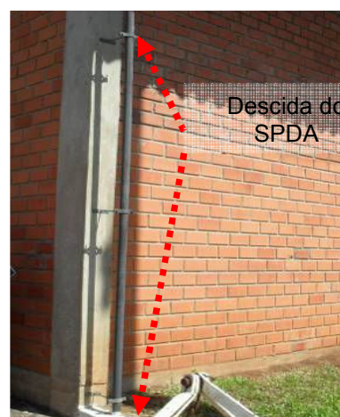
Figuras 36 e 37: Sistema de Descidas - Prédio Deposito Produção e Estufa.
