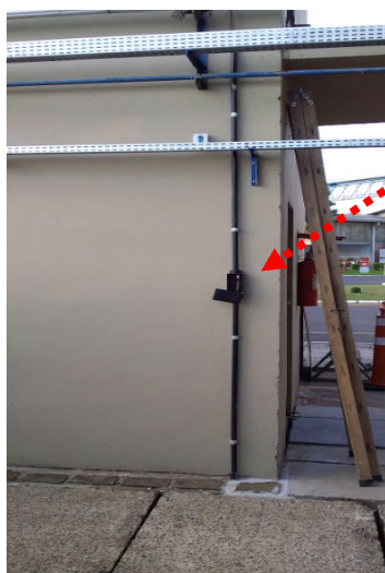
Figuras 113 e 114: Descidas do SPDA construídas na subestação
