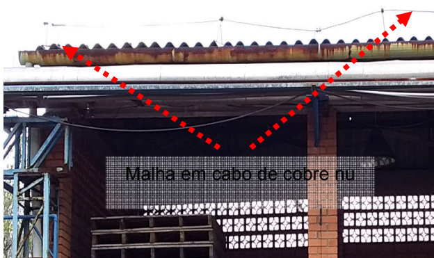
Figuras 159 e 160: Sistema de captação – Tancagem - lavagem de contêiner
