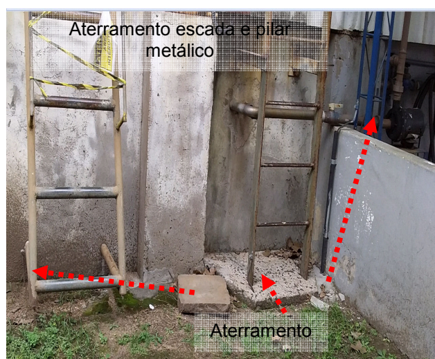
Figuras 227 e 228: Interligação de elementos metálicos ao Sistema de Aterramento
