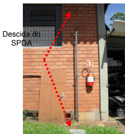
Figuras 36 e 37: Sistema de Descidas - Prédio Deposito Produção e Estufa.
