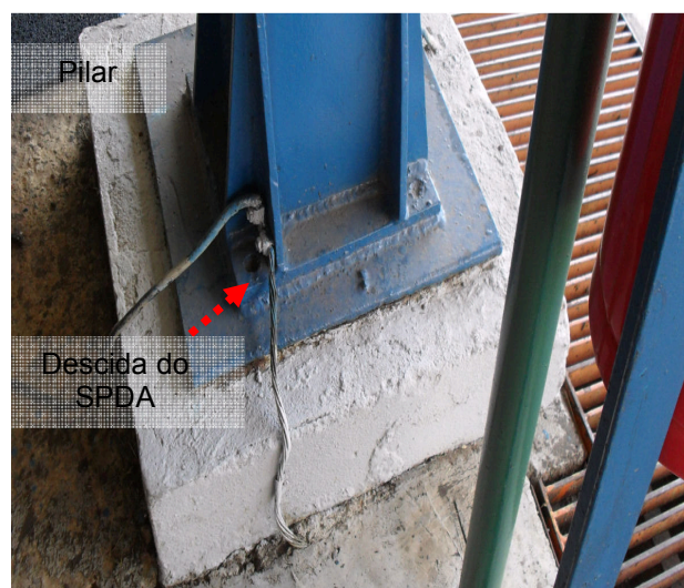
Figuras 93 e 94: Subsistema de Descidas – Produção de polímeros.
