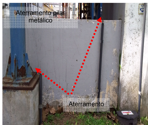
Figuras 227 e 228: Interligação de elementos metálicos ao Sistema de Aterramento
