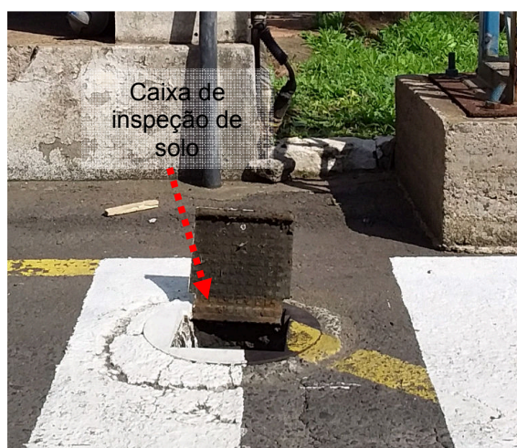
Figuras 169 e 170: Caixas de inspeção de solo – Tancagem - lavagem de contêiner
