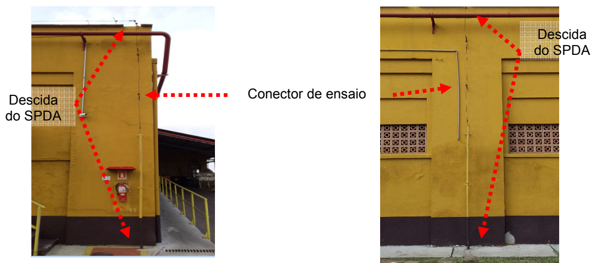
Figuras 257 e 258: Sistema de Descidas – Ribeira Sólida/Refeit/Vest/Guarita/Recep.
