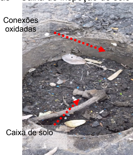
Figuras 175 e 176: Conexões Oxidadas – Caixa de inspeção de solo
