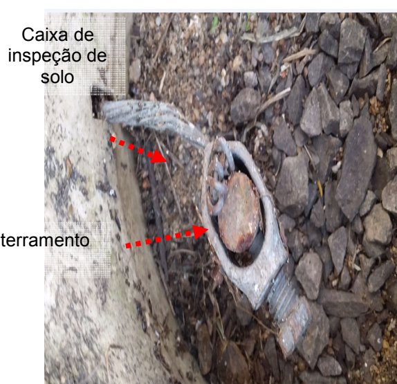
Figuras 140 e 141: Sistema de aterramento – ADM / Expedição / Manutenção /LCQ.
