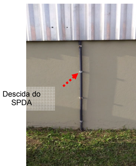
Figuras 97 e 98: Subsistema de Descidas – Produção de polímeros.
