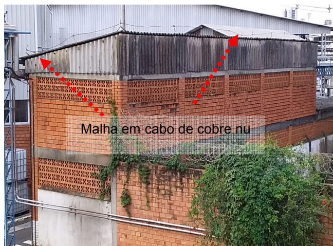
Figuras 157 e 158: Sistema de captação – Tancagem - lavagem de contêiner
