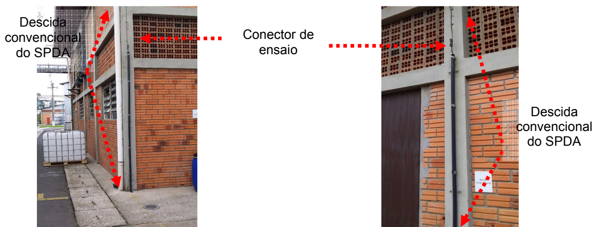
Figuras 183 e 184: Sistema de Descidas convencionais – UPET.
