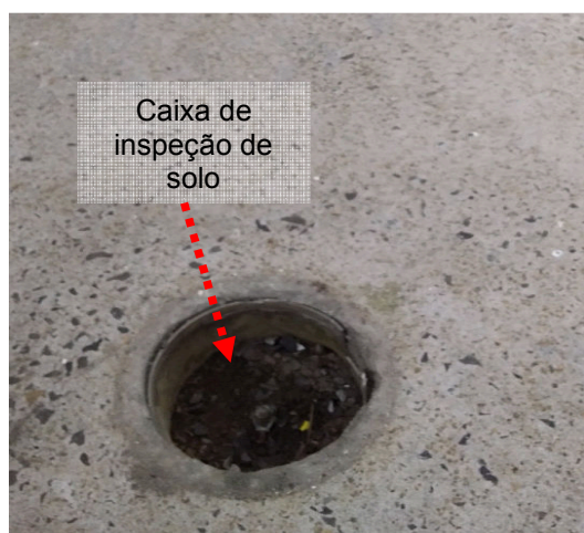
Figuras 187 e 188: Caixas de inspeção de solo – UPET.
