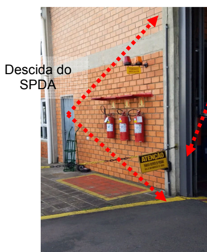
Figuras 132 e 133: Sistema de Decidas convencionais-ADM/ Expedição / Manutenção /LCQ.
