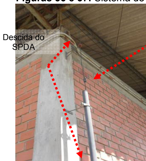
Figuras 38 e 39: Sistema de Descidas - Prédio Deposito Produção e Estufa.
