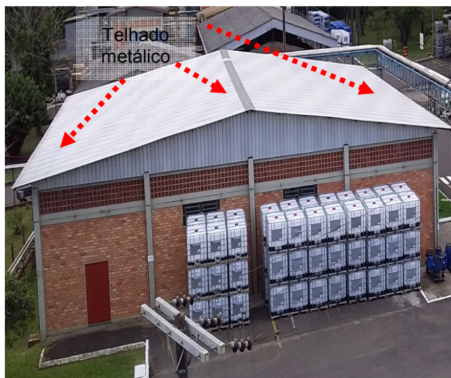
Figuras 70 e 71: Sistema Captor – Depósito de inflamáveis.
