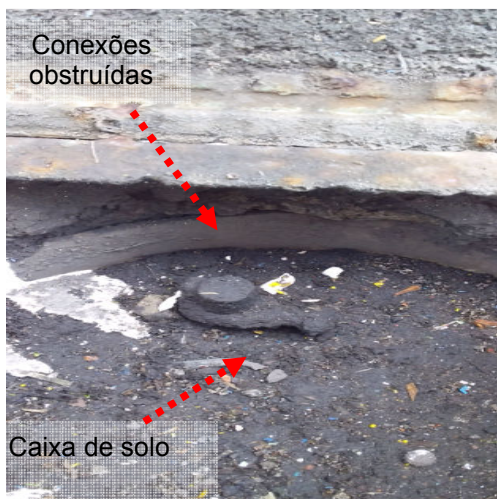
Figuras 173 e 174: Conexões Obstruídas – Caixa de inspeção de solo
