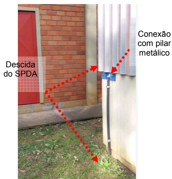
Figuras 21 e 22: Sistema de descida Prédio Tanque BPF.
