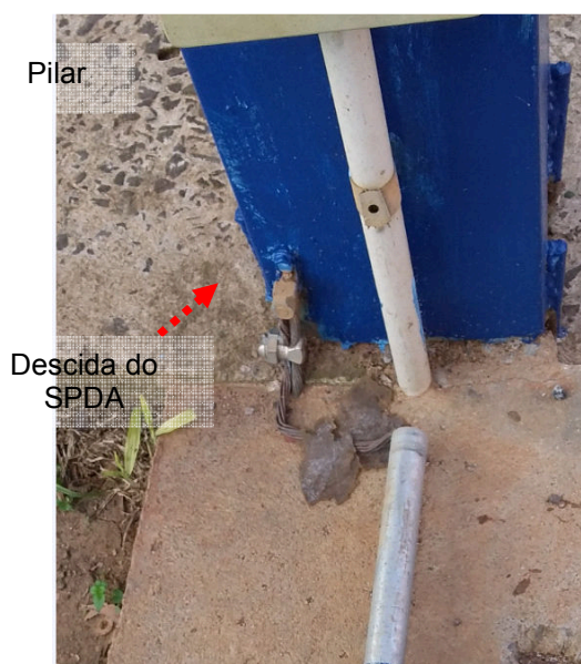
Figuras 95 e 96: Subsistema de Descidas – Produção de polímeros.
