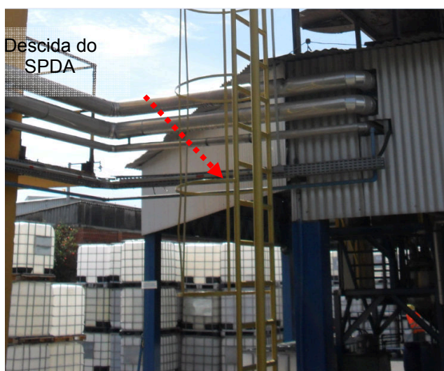
Figuras 93 e 94: Subsistema de Descidas – Produção de polímeros.
