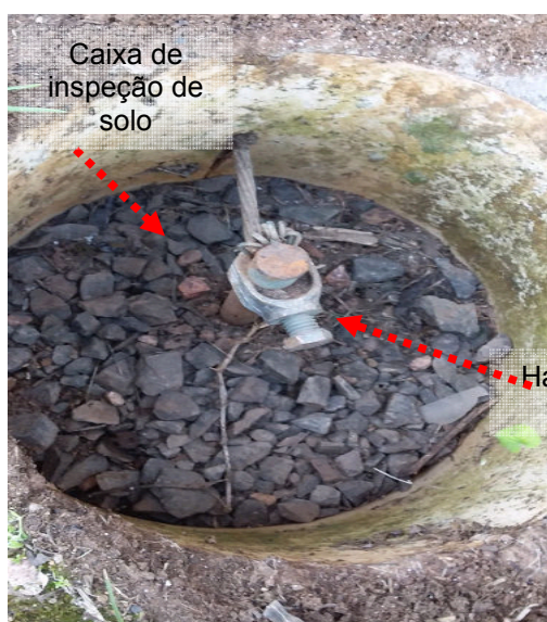
Figuras 140 e 141: Sistema de aterramento – ADM / Expedição / Manutenção /LCQ.
