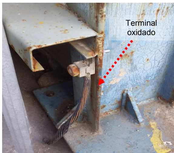
Figuras 65 e 66: Conexões oxidadas - ETER.
