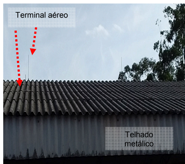
Figuras 32 e 33: Sistema Captor - Prédio Depósito Produção e Estufa.
