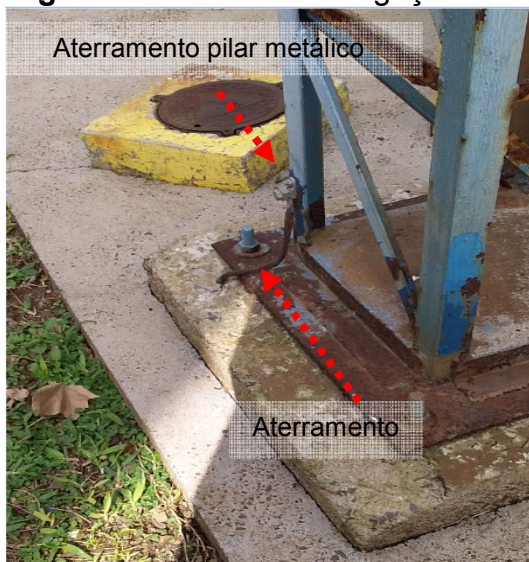
Figuras 229 e 230: Interligação de elementos metálicos ao Sistema de Aterramento
