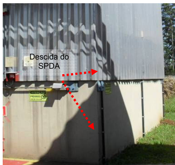
Figuras 87 e 88: Subsistema de Descidas – Produção de polímeros.
