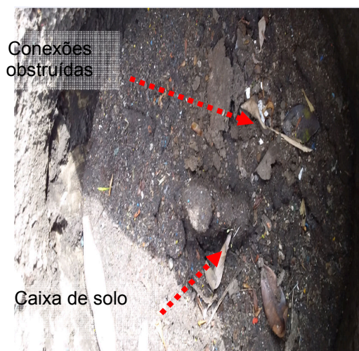
Figuras 173 e 174: Conexões Obstruídas – Caixa de inspeção de solo
