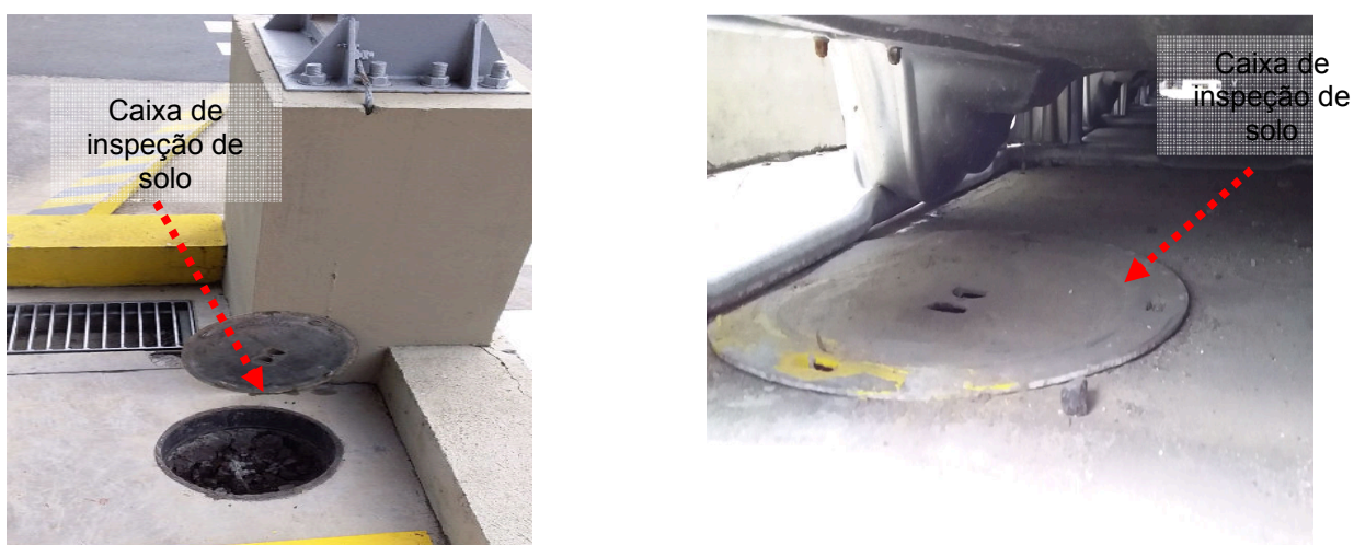
Figuras 210 e 211: Caixas de inspeção de solo – Depósito de Produtos químicos.
