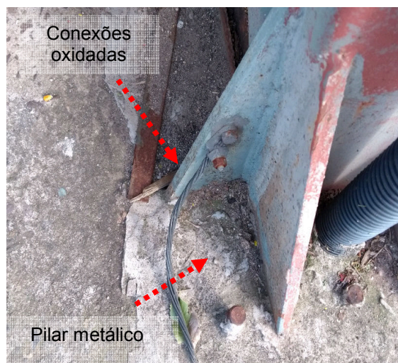
Figuras 144 e 145: Conexões Oxidadas – ADM / Expedição / Manutenção /LCQ.
