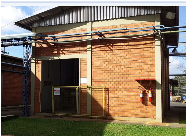
Figura 15: Fachada da Caldeira
