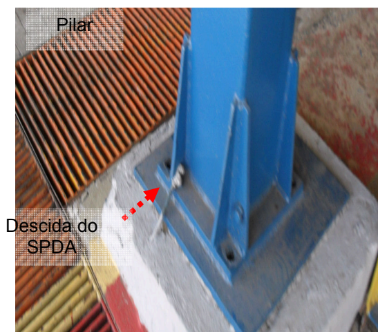
Figuras 91 e 92: Subsistema de Descidas – Produção de polímeros.
