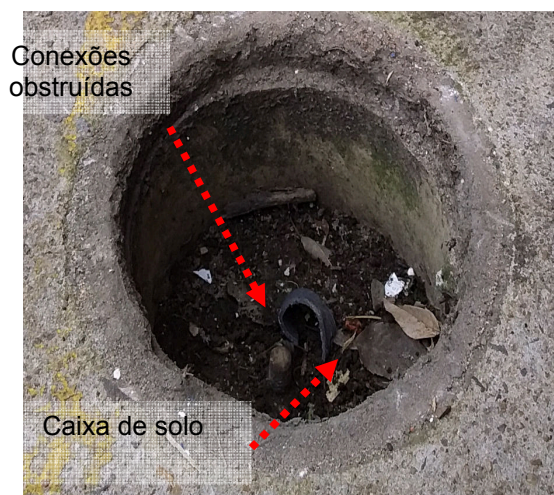
Figuras 190 e 191: Conexões oxidadas / Obstruídas – Caixa de inspeção de solo
