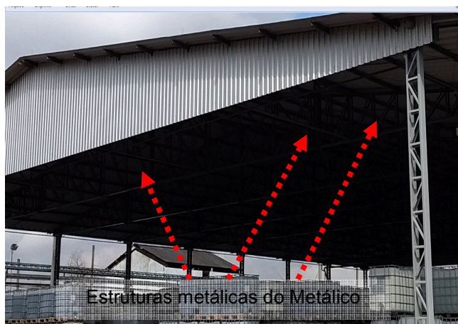
Figuras 198 e 199: Sistema de Captor – Depósito de Produtos químicos.
