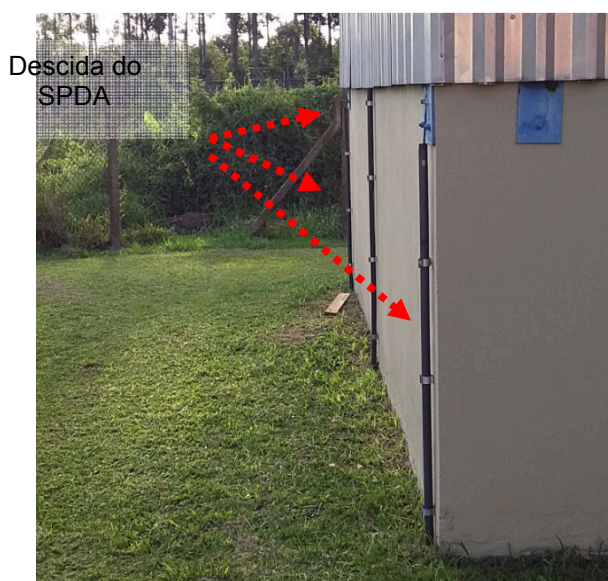
Figuras 97 e 98: Subsistema de Descidas – Produção de polímeros.
