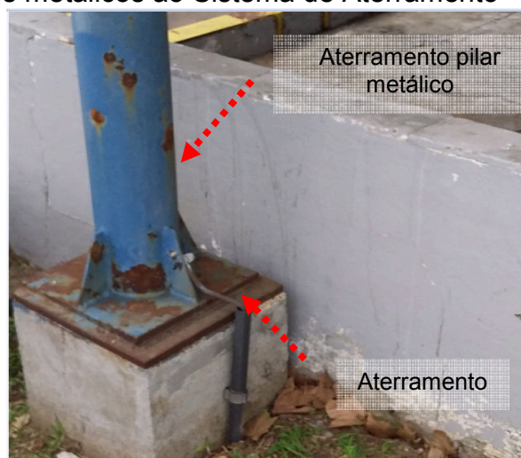
Figuras 231 e 232: Interligação de elementos metálicos ao Sistema de Aterramento
