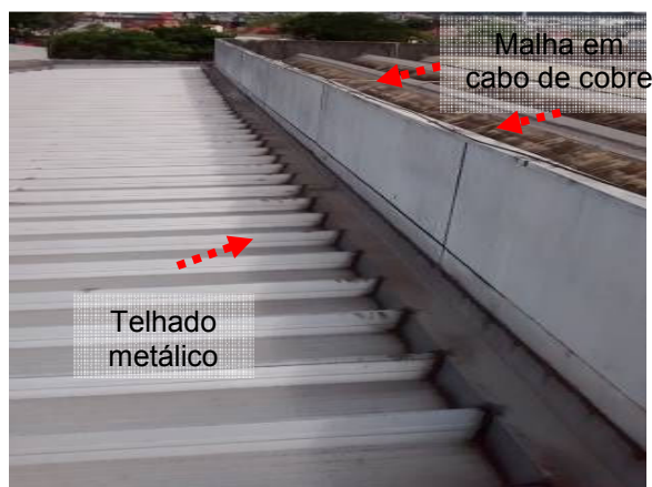
Figuras 277 e 278: Sistema de Captação- CDTC.
