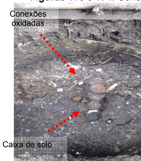
Figuras 175 e 176: Conexões Oxidadas – Caixa de inspeção de solo
