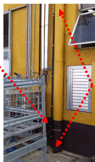
Figuras 261 e 262: Sistema de Descidas – Ribeira Sólida/Refeit/Vest/Guarita/Recep.
