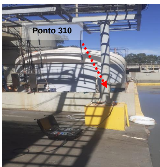
Figuras 61 e 62: Ponto 310 – Aterramento base estrutura pipe-rack - PTAR/Osmose.
