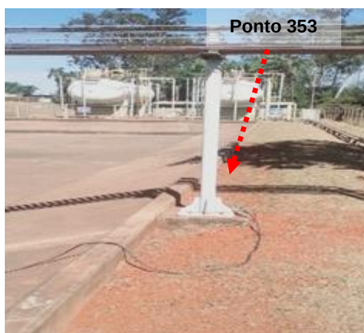
Figuras 35 e 36: Ponto 353 // Medição 14 – Aterramento pipe-rack Tratamento de Água Potável.
