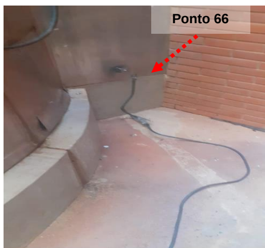
Figuras 15 e 16: Ponto 66 // Medição 06 – Aterramento do tanque ao lado da sala de armazenamento.
