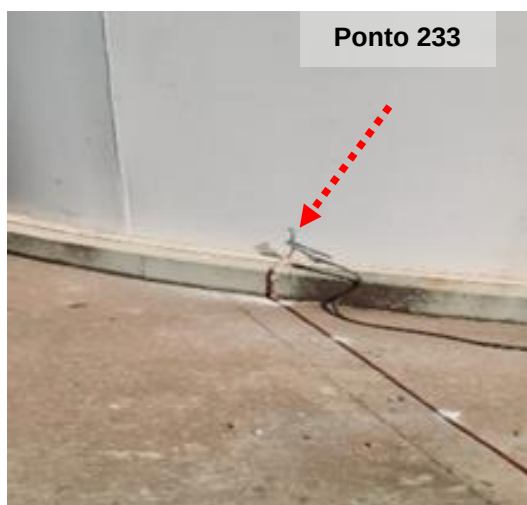
Figuras 31 e 32: Ponto 233 // Medição 12 - Aterramento de tanque do tratamento de água potável
