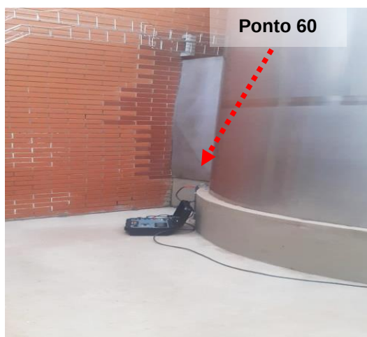
Figuras 03 e 04: Ponto 60 – Aterramento do tanque ao lado da sala de armazenamento.
