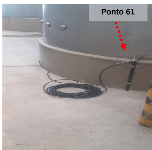
Figuras 05 e 06: Ponto 61 // Medição 01- Aterramento do tanque ao lado da sala de armazenamento.
