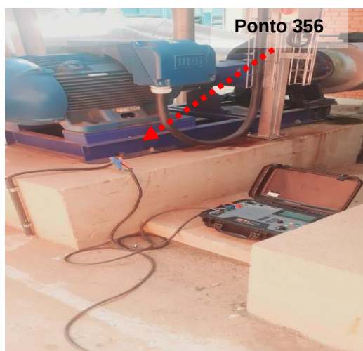
Figuras 69 e 70: Ponto 356 – Ponto de aterramento de equipamento (motor elétrico) Atrás Laboratório Central.
