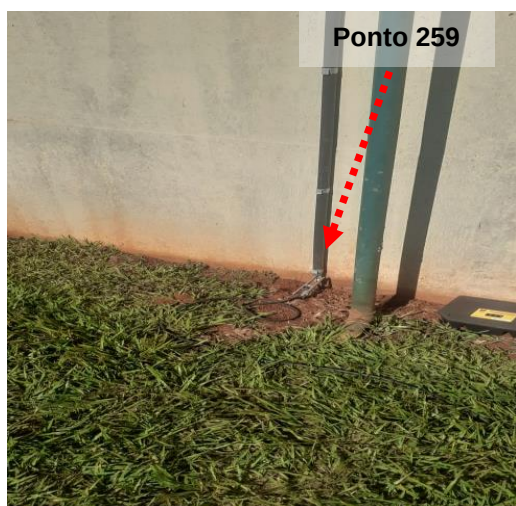
Figuras 53 e 54: Ponto 259 // Medição 23 - Descida do SPDA – Tratamento de Água Potável.
