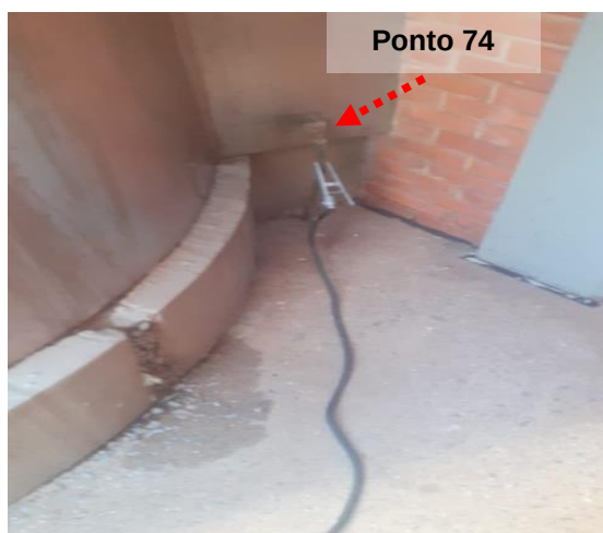
Figuras 21 e 22: Ponto 74 // Medição 08 - Aterramento do tanque ao lado do prédio de Estandarização - Condensação.
