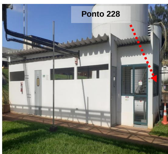
Figuras 25 e 26: Ponto 228 – Descida SPDA – Sala do gerador.
