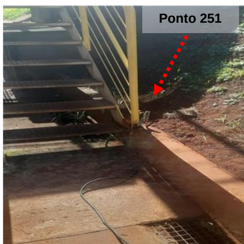
Figuras 49 e 50: Ponto 251 // Medição 21 – Aterramento escada – Tratamento de Água Potável.
