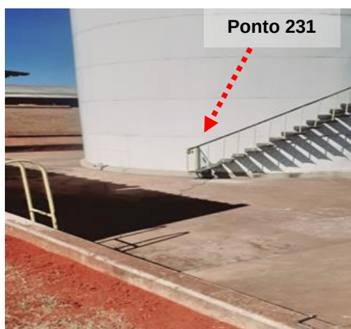
Figuras 27 e 28: Ponto 231 // Medição 10 – Aterramento de escada metálica de acesso a cobertura ao tanque de tratamento de água potável.
