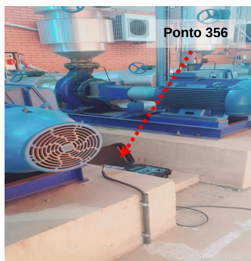
Figuras 69 e 70: Ponto 356 – Ponto de aterramento de equipamento (motor elétrico) Atrás Laboratório Central.
