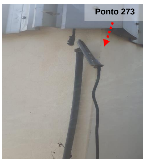
Figuras 59 e 60: Ponto 273 // Medição 25 - Descida do SPDA - Depósito de cinza.
