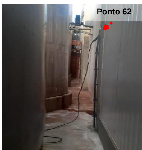
Figuras 07 e 08: Ponto 62 // Medição 02 - Descida do SPDA – Ao lado Sala de Armazenamento.
