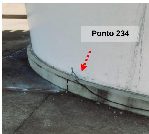
Figuras 33 e 34: Ponto 234 // Medição 13 - Aterramento de escada metálica de acesso a cobertura ao tanque de tratamento de água potável.
