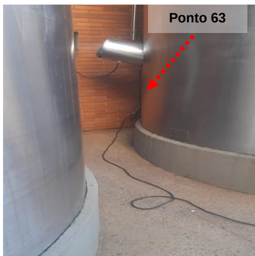
Figuras 09 e 10: Ponto 63 // Medição 03 - Aterramento do tanque ao lado da sala de armazenamento.
