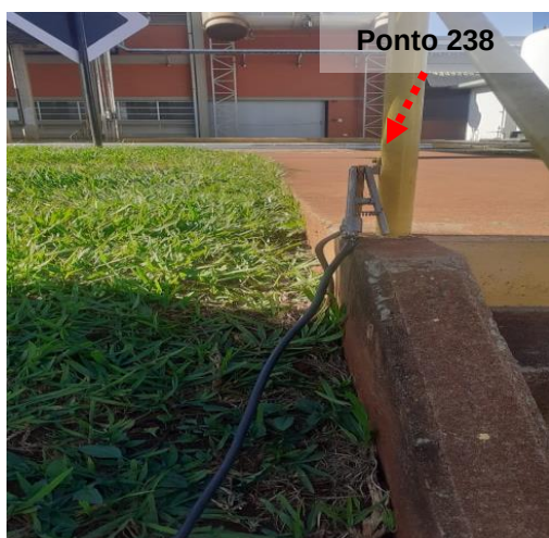
Figuras 39 e 40: Ponto 238 // Medição 16 - Condutor de Aterramento de escada metálica.
