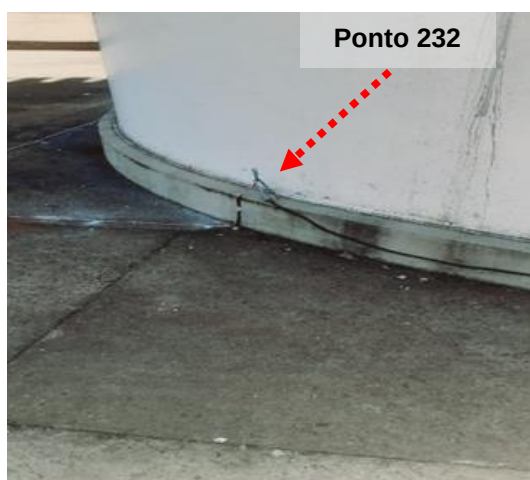
Figuras 29 e 30: Ponto 232 // Medição 11 – Aterramento de tanque do tratamento de água Potável.
