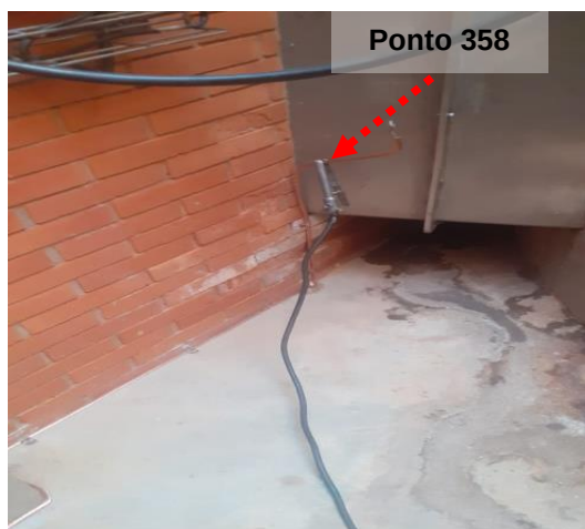
Figuras 17 e 18: Ponto 358 // Medição 07- Aterramento do tanque ao lado da sala de armazenamento.
