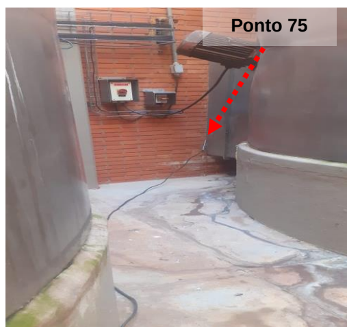
Figuras 23 e 24: Ponto 75 // Medição 09 - Aterramento do tanque ao lado do prédio de Estandarização - Condensação.
