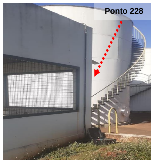
Figuras 25 e 26: Ponto 228 – Descida SPDA – Sala do gerador.
