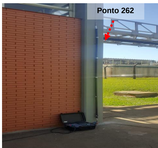
Figuras 57 e 58: Ponto 262 – Descida do SPDA – Energia Alternativa.
