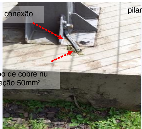
Figuras 297 e 298: Caixa de inspeção de solo // Interligação entre elementos metálicos e a malha de aterramento.
