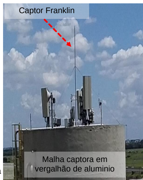
Figuras 740 e 741 : sistema captor existente – ETA/ETE (Construções Gerais)
