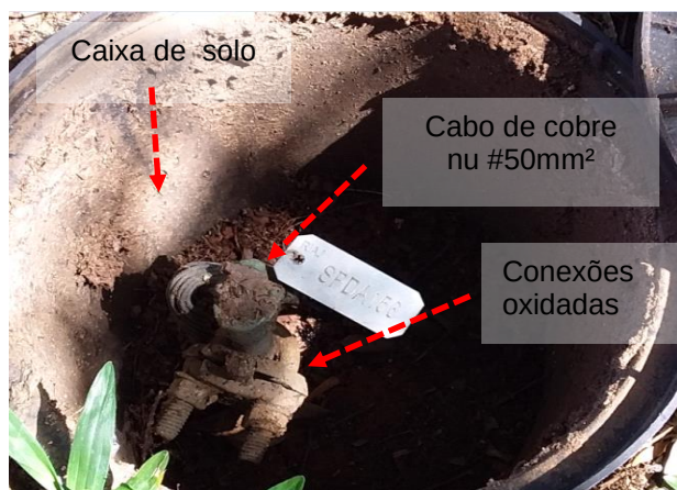
Figura 654: Conexões oxidadas
