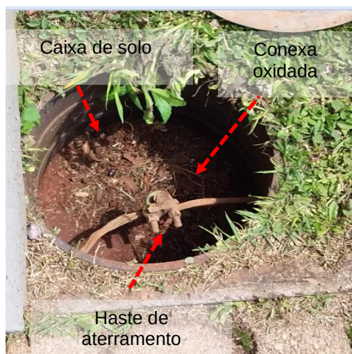
Figuras 234 e 235: Substância de aterramento – Não conformidades
