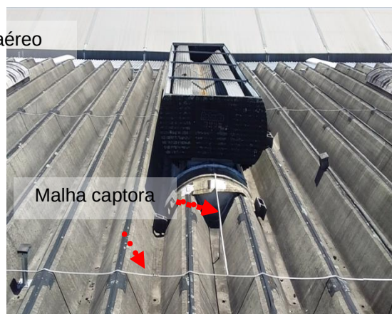
Figuras 156 e 157: sistema captor existente – Prédio 06 - Almojarifado
