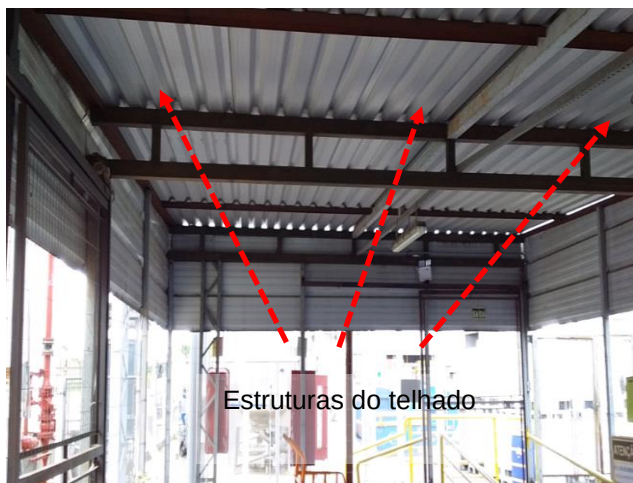
Figuras 482 e 483: sistema captor existente – Prédio 24- Estoque químicos/Inflamáveis
