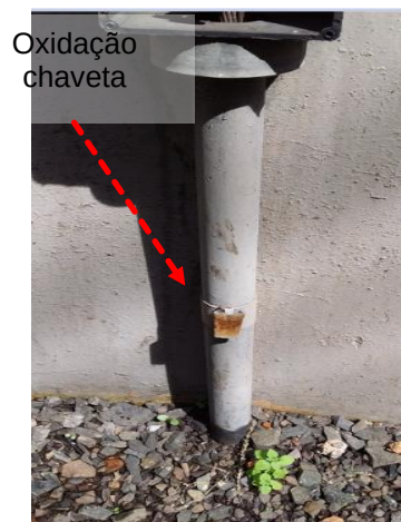
Figuras 788 e 789: Subsistema de descidas – Não conformidades encontradas
