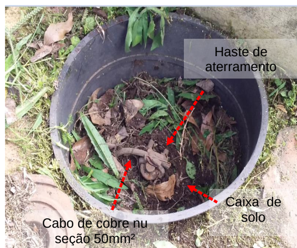
Figuras 374 e 375: Interligação entre elementos metálicos e a malha de aterramento // Caixa de solo existente
