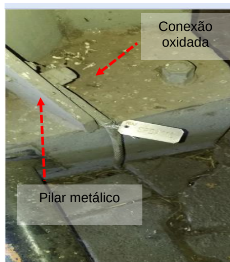
Figuras 236 e 237: Substância de aterramento – Não conformidades
