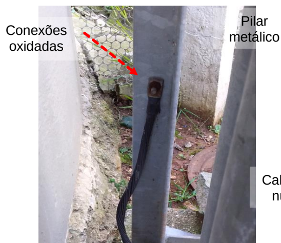
Figuras 802 e 803: Substância de aterramento – Não conformidades
