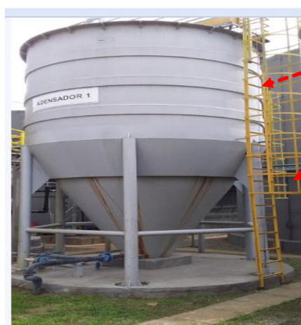
Figuras 822 e 823: Elementos metálicos não interligados ao SPDA
