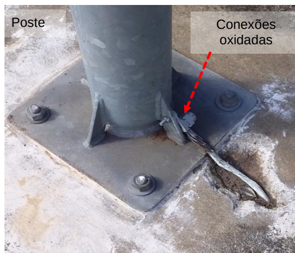
Figuras 737 e 738: Subsistema de aterramento – Não conformidades
