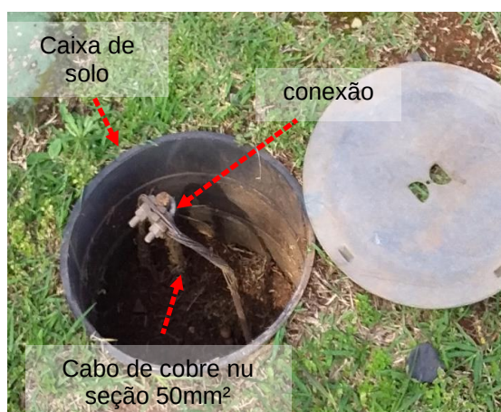
Figuras 345 e 346: Interligação entre elementos metálicos e a malha de aterramento.
