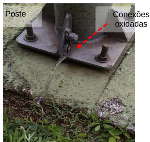
Figuras 702 e 703: Subsistema de aterramento – Não conformidades
