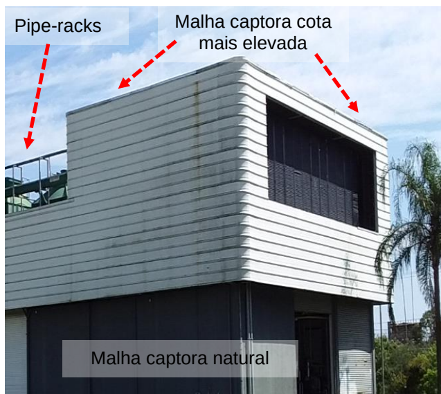
Figuras 520 e 521: sistema captor existente – Prédio 28 - Utilidades
