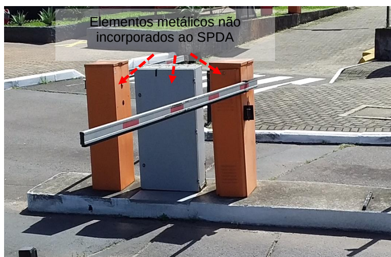
Figura 655: Elementos metálicos não interligados ao SPDA
