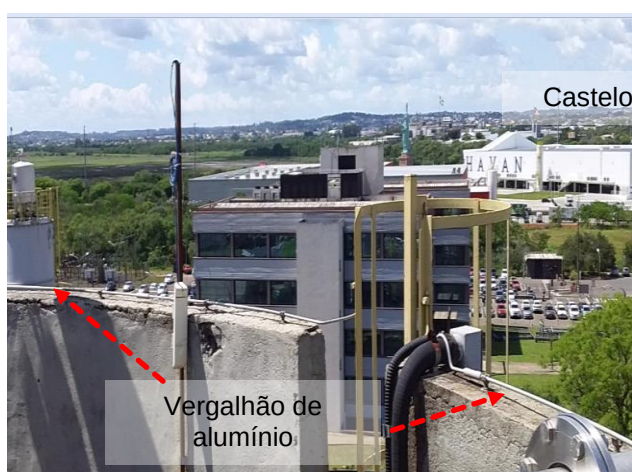
Figuras 746 e 747: sistema captor existente – ETA/ETE (Construções Gerais)
