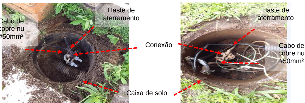
Figuras 713 e 714: Caixas de inspeção de solo encontradas
