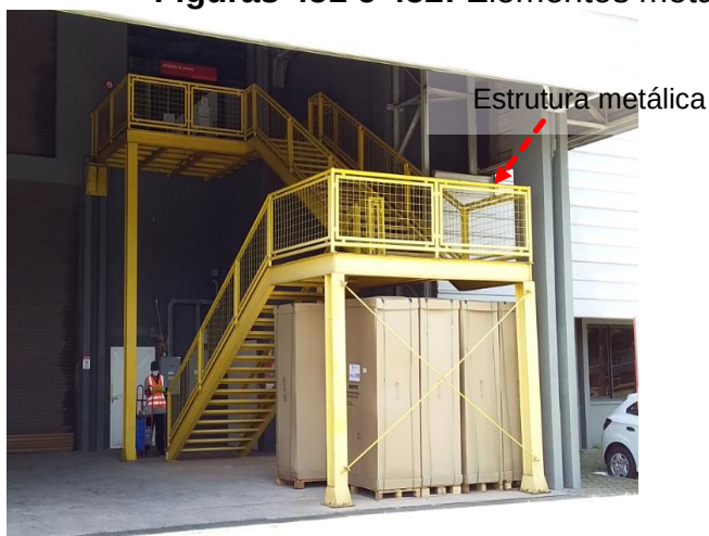
Figuras 453 e 454: Elementos metálicos não interligados ao SPDA
