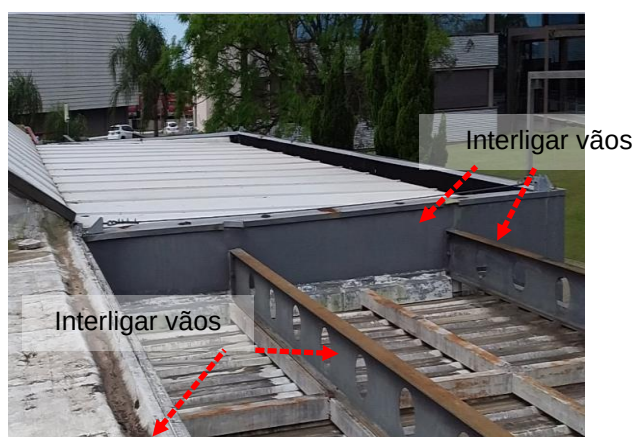
Figuras 357 e 358: Elementos metálicos não interligados ao SPDA
