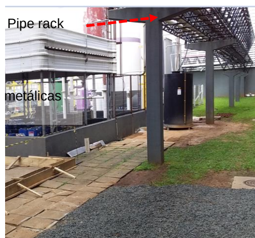
Figuras 495 e 496: Elementos metálicos nesta área não interligados ao SPDA.
