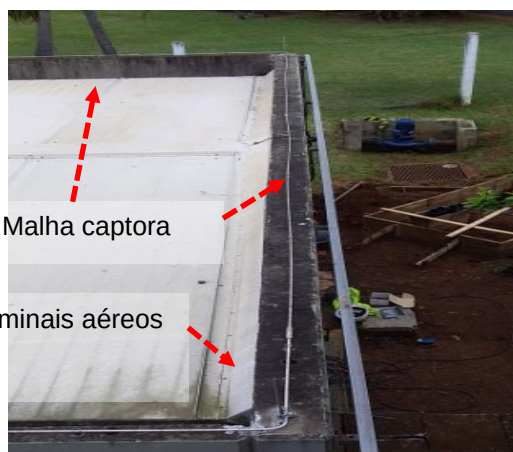
Figuras 659 e 660: sistema captor existente – Prédio 14 – Casa de Bombas
