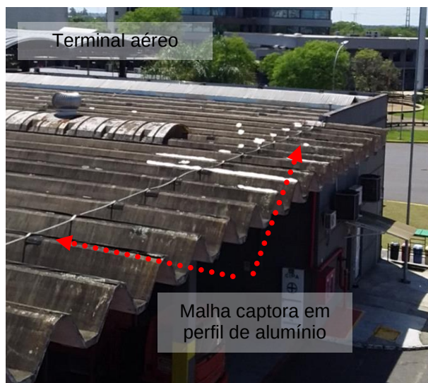
Figuras 154 e 155: sistema captor existente – Prédio 06 - Almojarifado
