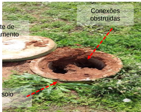
Figuras 690 e 691: Subsistema de aterramento – Não conformidades
