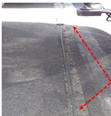
Figuras 914 e 915: Subsistema de aterramento - Áreas diversas (Estacionamento)
