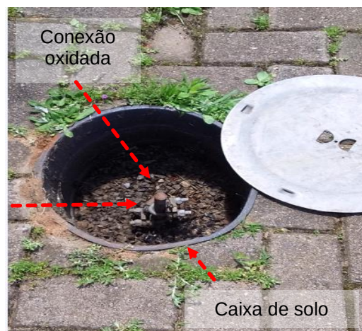
Figuras 449 e 450: Subsistema de aterramento – Não conformidades
