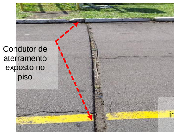
Figuras 892 e 893: Sistema de Aterramento –Não conformidades
