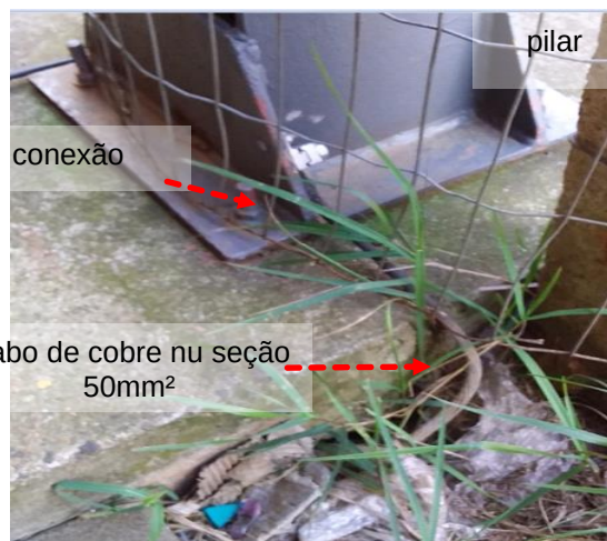
Figuras 443 e 444: Interligação entre elementos metálicos e a malha de aterramento.
