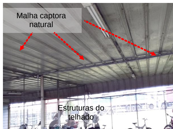
Figuras 364 e 365: sistema captor existente – Prédio 17 – Estac. Motos e bicicletas
