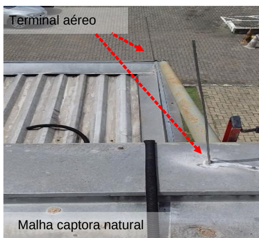
Figuras 287 e 288: Sistema captor existente – Prédio 11 ( Recepção)
