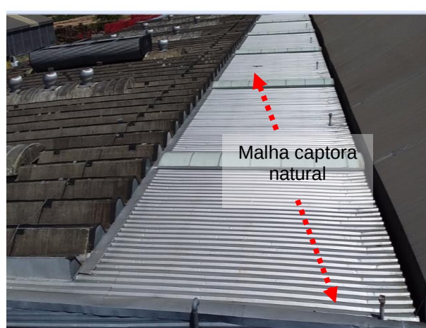
Figuras 160 e 161: sistema captor existente – Prédio 06 - Almojarifado
