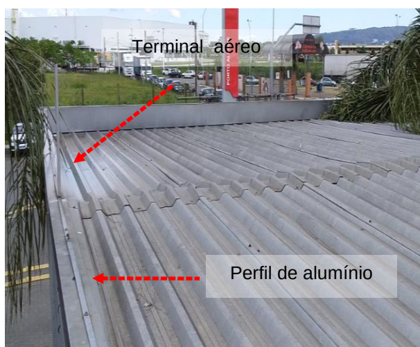
Figuras 277 e 278 : Sistema captor existente – Prédio 11 ( Recepção)
