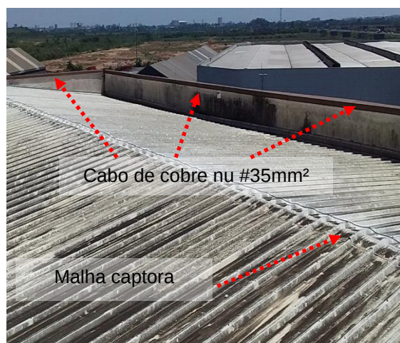
Figuras 403 e 404: sistema captor existente – Prédio 20 -Administrativo
