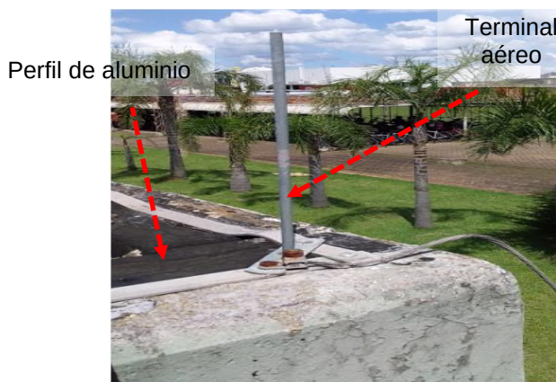
Figuras 239 e 240: sistema captor existente – Prédio 09 – Estac. Motos/Escritório
