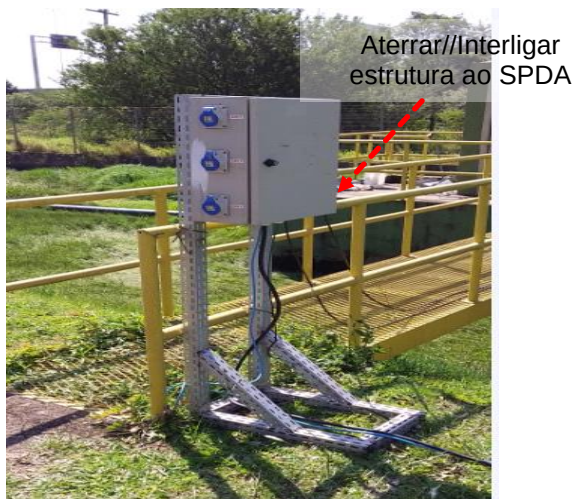
Figura 900: Interligar estrutura ao SPDA
