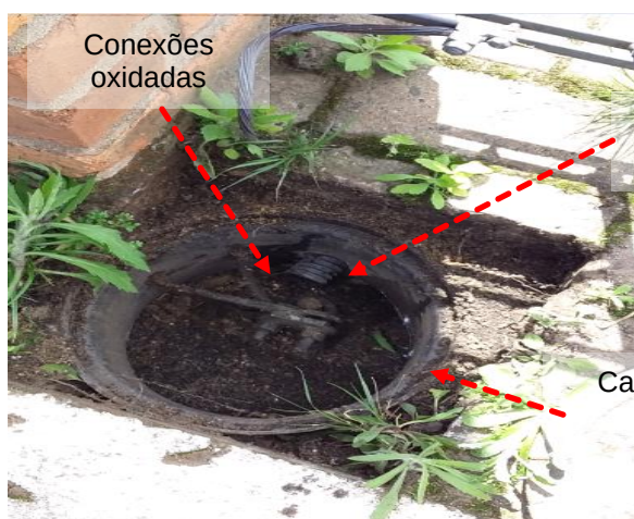
Figuras 731 e 732: Subsistema de aterramento – Não conformidades
