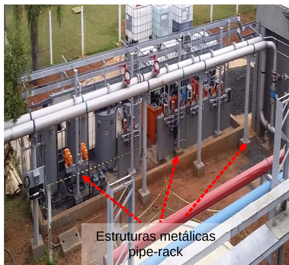
Figuras 320 e 321: Elementos metálicos não interligados ao SPDA
