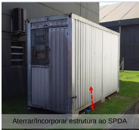
Figuras 215 e 216 : Elementos metálicos não interligados ao SPDA
