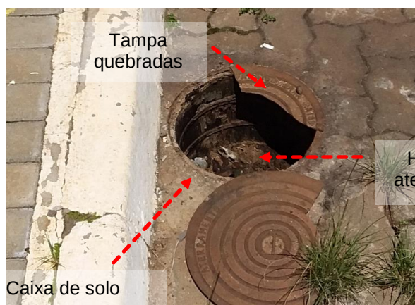
Figuras 447 e 448: Subsistema de aterramento – Não conformidades
