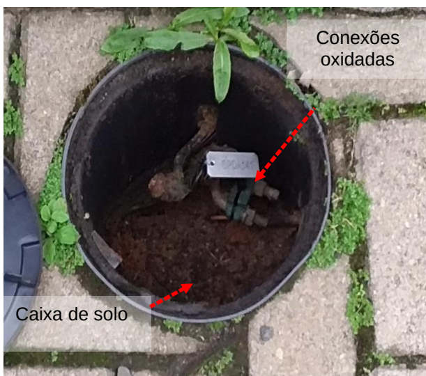
Figuras 303 e 304: Subsistema de aterramento – Não conformidades
