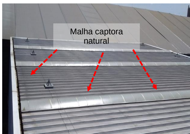
Figuras 626 e 627: sistema captor existente – Prédio 31B –Operações Logísticas
