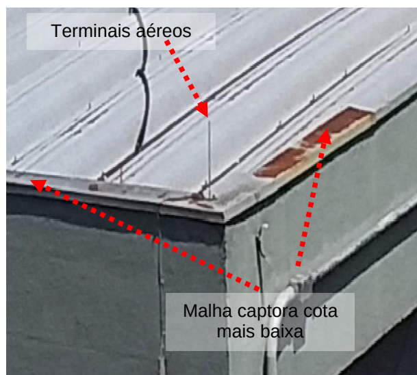
Figuras 131 e 132: Sistema captor existente – Prédio 05 – Conferencia.
