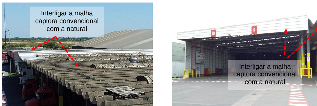
Figuras 638 e 639: Componentes do sistema de captação não interligados.
