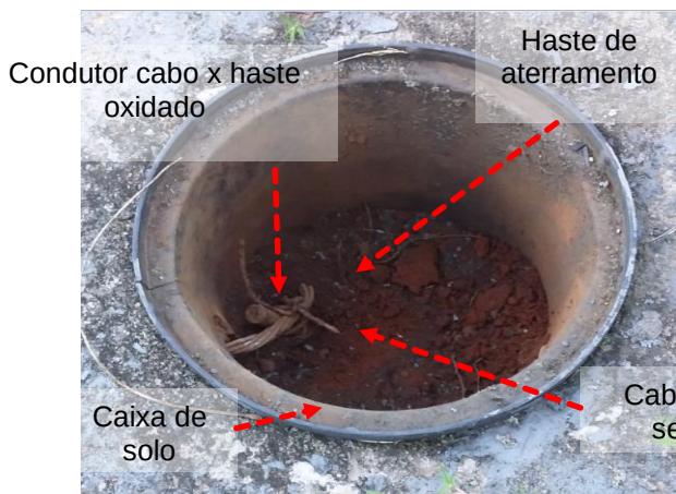
Figuras 861 e 862: Conector cabo x haste obstruído /// oxidado /// Condutor de aterramento com seção inferior ao estipulado pela norma
