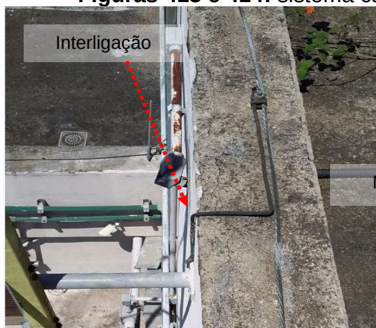
Figuras 415 e 416: sistema captor existente – Prédio 20 -Administrativo
