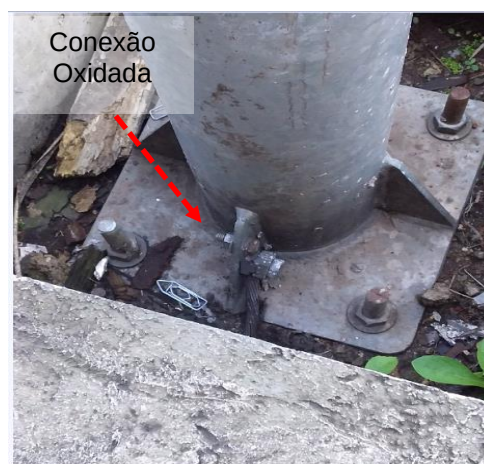
Figuras 182 e 183: Conexão cabo haste oxidadas / Conexão estrutura oxidada.
