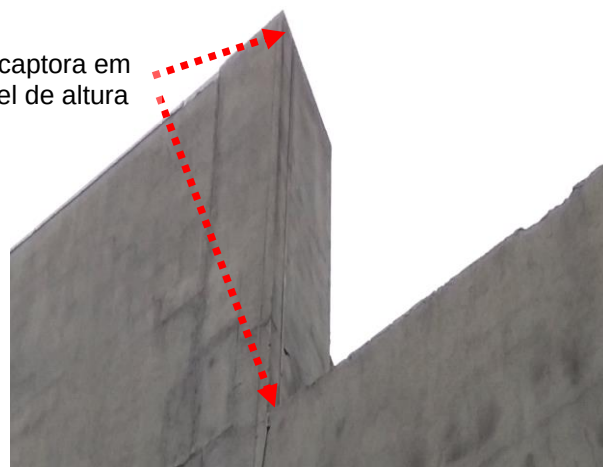
Figuras 84 e 85: sistema captor existente – Prédio 03 – Silo Açúcar
