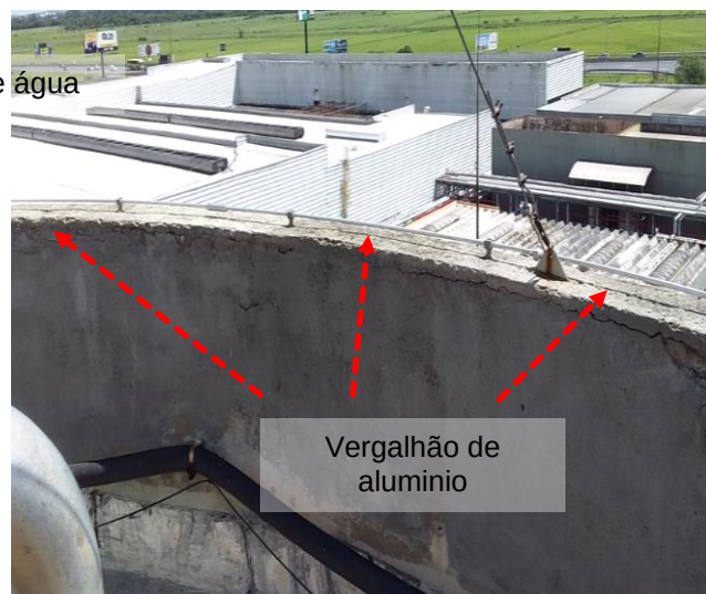
Figuras 742 e 743 : sistema captor existente – ETA/ETE (Construções Gerais)
