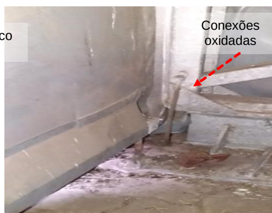
Figuras 698 e 699: Subsistema de aterramento – Não conformidades
