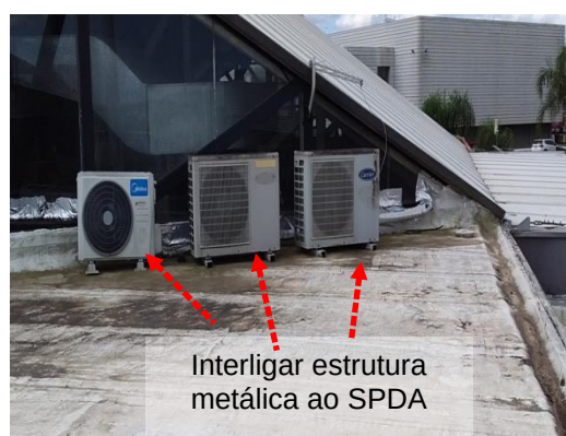
Figuras 353 e 354: Elementos metálicos não interligados ao SPDA
