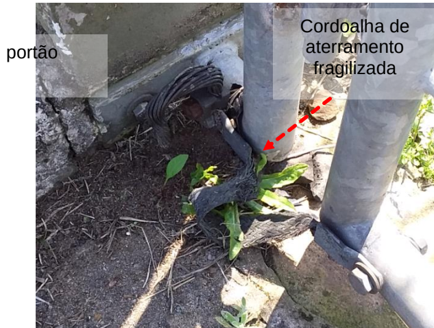
Figuras 470 e 471: Subsistema de aterramento – Não conformidades
