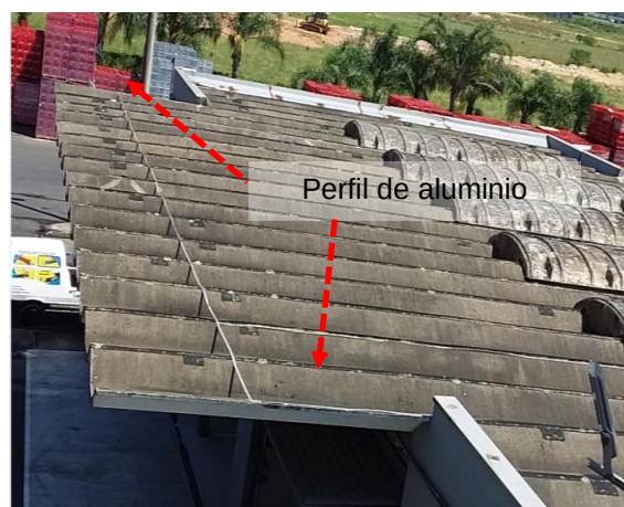
Figuras 197 e 198: sistema captor existente – Prédio 07 – Manutenção da Frota
