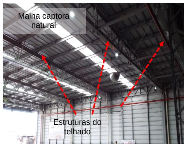
Figuras 628 e 629: sistema captor existente – Prédio 31B –Operações Logísticas
