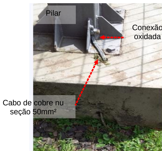
Figuras 303 e 304: Subsistema de aterramento – Não conformidades
