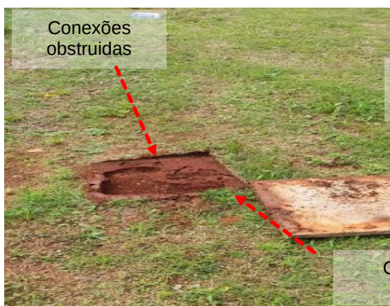
Figuras 688 e 689: Subsistema de aterramento – Não conformidades
