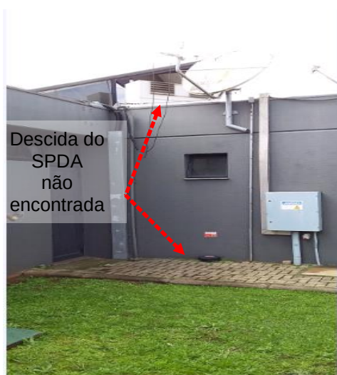
Figuras 343 e 344: Sistema de Descidas – Não encontradas
