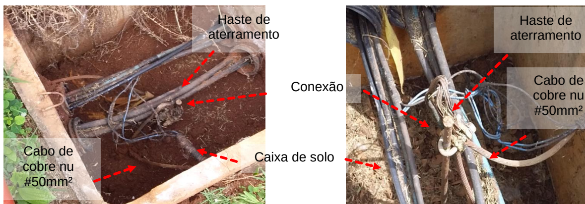
Figuras 672 e 673: Caixas de inspeção de solo encontradas
