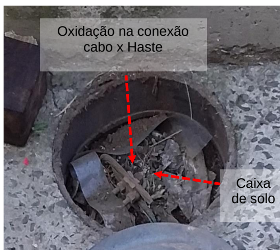
Figuras 211 e 212: Subsistema de aterramento – Não conformidades
