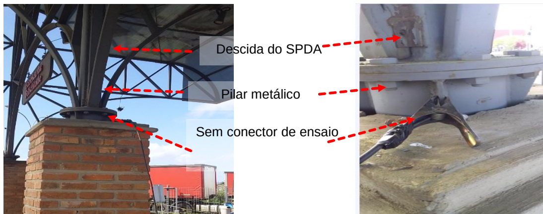
Figuras 711 e 712: Sistema de Descidas Naturais – Pilares metálicos
