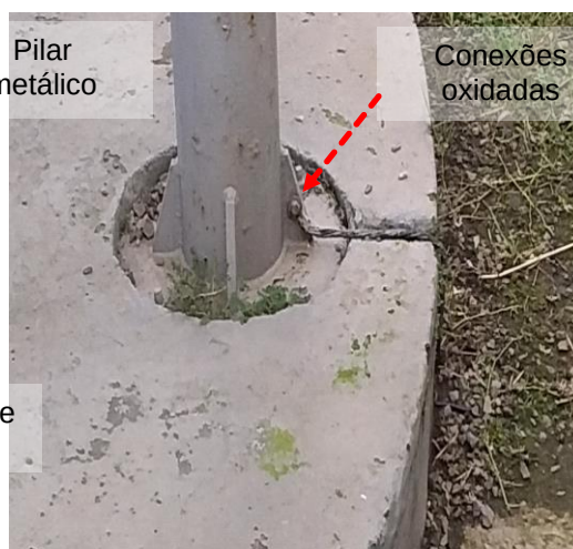
Figuras 812 e 813: Subsistema de aterramento – Não conformidades
