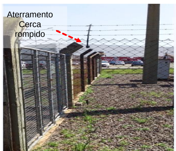
Figuras 476 e 477: Subsystema de aterramento – Não conformidades
