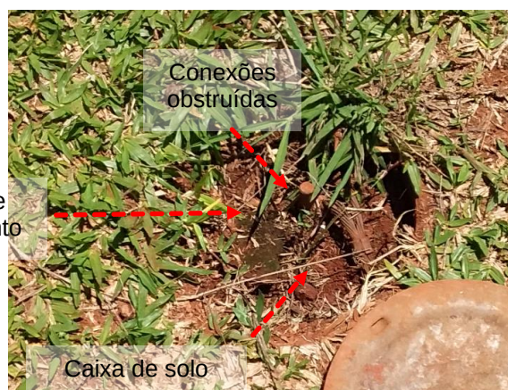
Figuras 447 e 448: Subsistema de aterramento – Não conformidades
