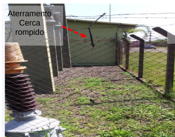
Figuras 474 e 475: Subsistema de aterramento – Não conformidades
