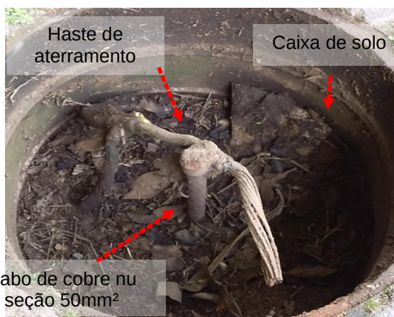
Figuras 297 e 298: Caixa de inspeção de solo // Interligação entre elementos metálicos e a malha de aterramento.
