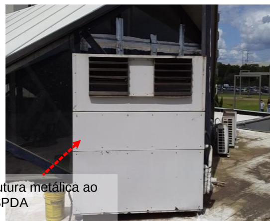
Figuras 355 e 356: Elementos metálicos não interligados ao SPDA
