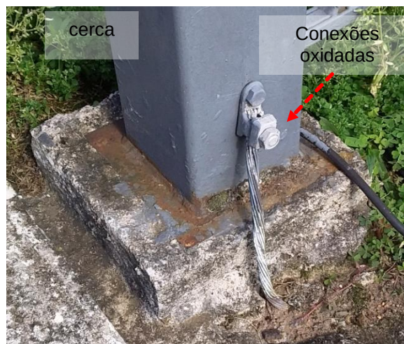
Figuras 735 e 736: Subsistema de aterramento – Não conformidades
