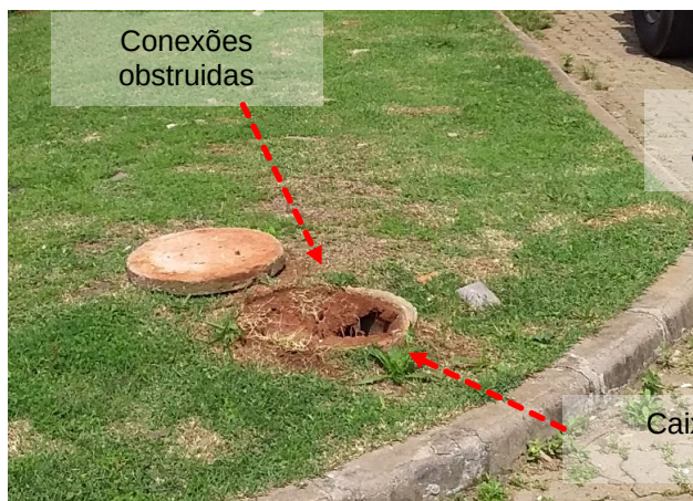
Figuras 690 e 691: Subsistema de aterramento – Não conformidades
