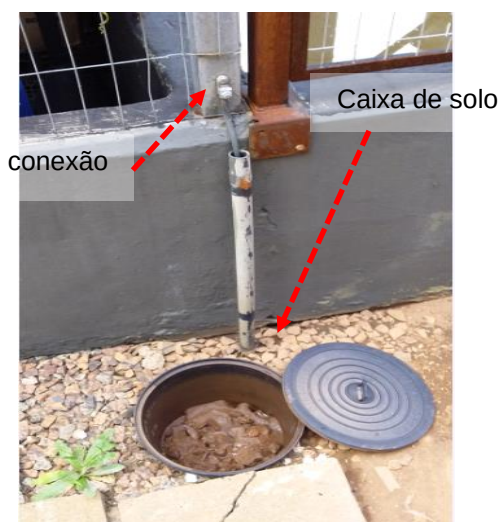
Figuras 487 e 488: Caixa de inspeção de solo // Interligação entre elementos metálicos e a malha de aterramento.
