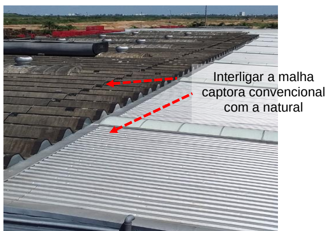
Figuras 186 e 187: Elementos metálicos não interligados ao SPDA
