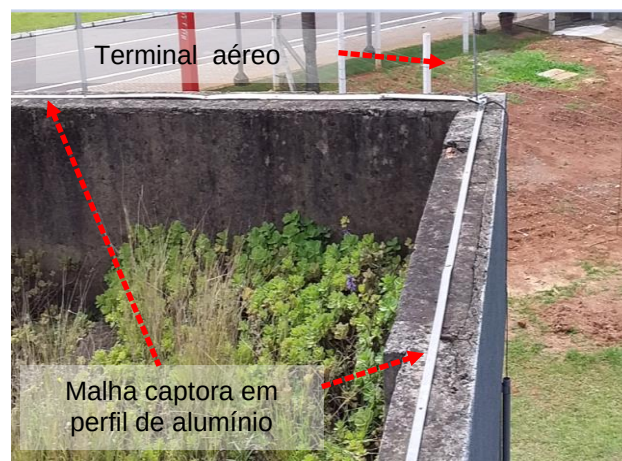
Figuras 325 e 326: Sistema captor existente – Prédio 13 –SEMT/Banco
