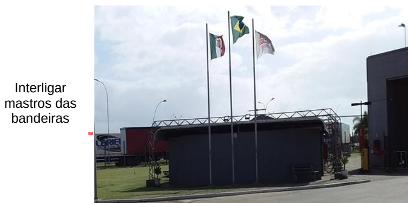
Figura 378: Aterrar/Interligar elementos metálicos ao SPDA.
