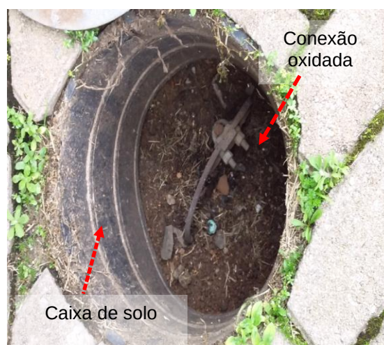
Figuras 265 e 266: Subsistema de aterramento – Não conformidades
