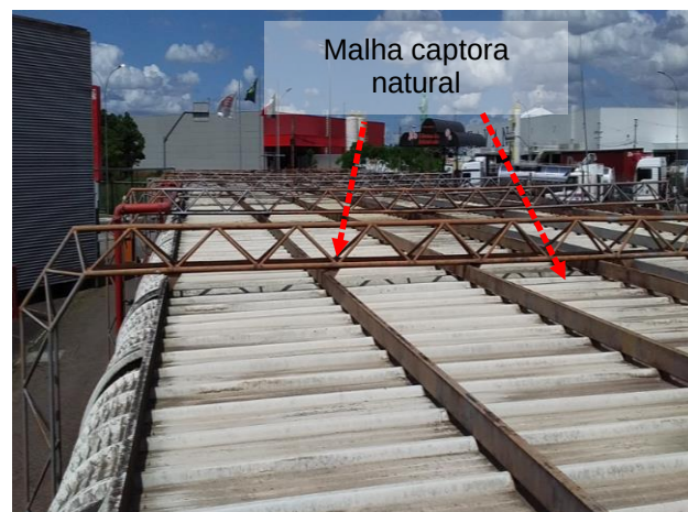
Figuras 362 e 363: sistema captor existente – Prédio 17 - Estac. Motos e bicicletas
