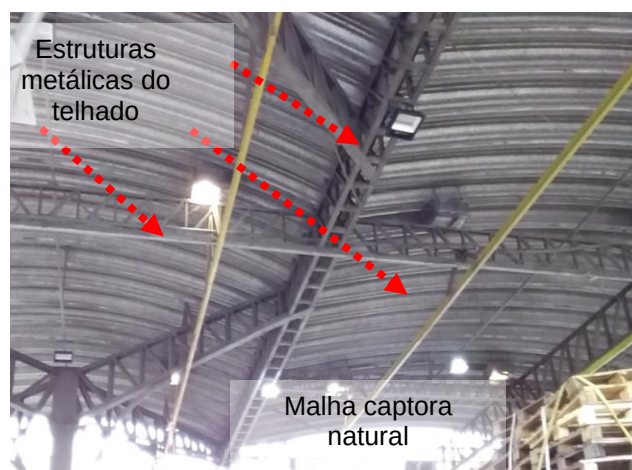
Figuras 137 e 138: Sistema captor existente – Prédio 05 – Conferencia.
