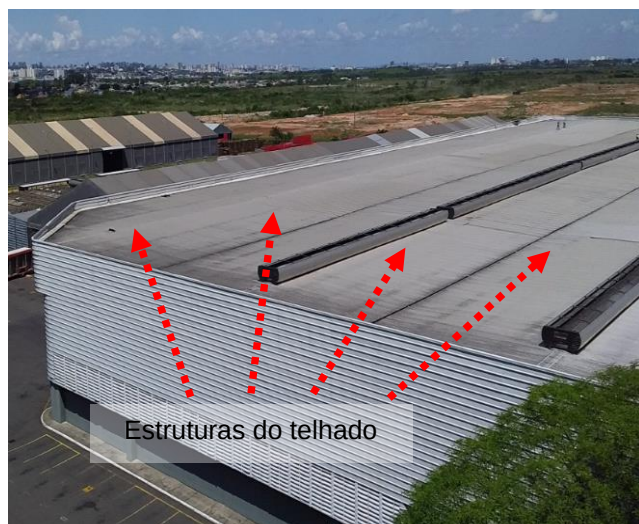
Figuras 05 e 06: Sistema Captor - Estruturas metálicas do telhado
