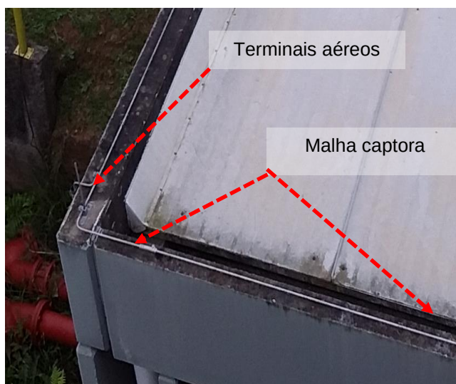
Figuras 657 e 658: sistema captor existente – Prédio 14 – Casa de Bombas
