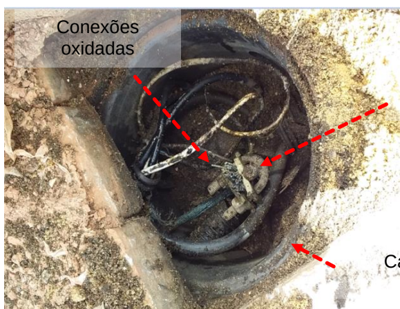
Figuras 729 e 730: Subsistema de aterramento – Não conformidades
