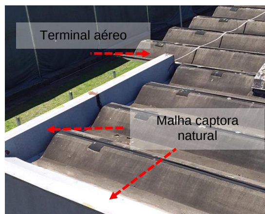
Figuras 193 e 194: sistema captor existente – Prédio 07 – Manutenção da Frota
