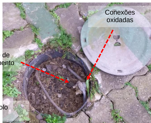
Figuras 576 e 577: Subsistema de aterramento – Não conformidades
