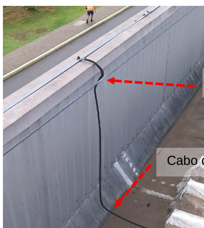
Figuras 603 e 604: Sistema de Descidas convencionais – Cabo de cobre nu #35mm 2
