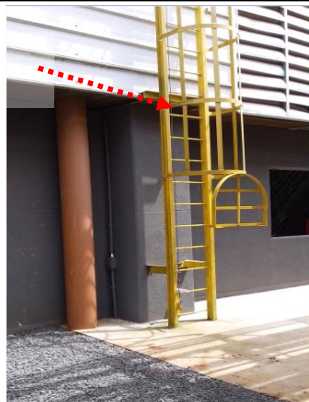
Figuras 40 e 41: Estruturas não incorporadas ao SPDA existente
