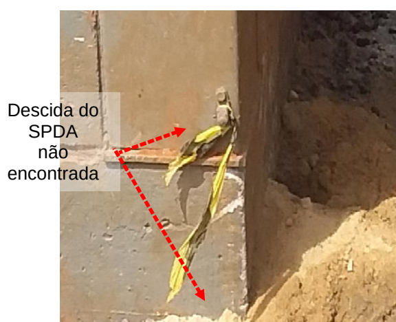
Figuras 384 e 385: Sistema de Descidas Naturais – Pilares metálicos Descida natural não encontrada
