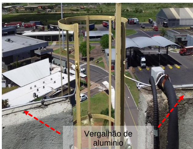
Figuras 744 e 745: sistema captor existente – ETA/ETE (Construções Gerais)
