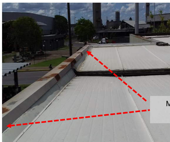
Figuras 247 e 248: sistema captor existente – Prédio 09 – Estac. Motos/Escritório
