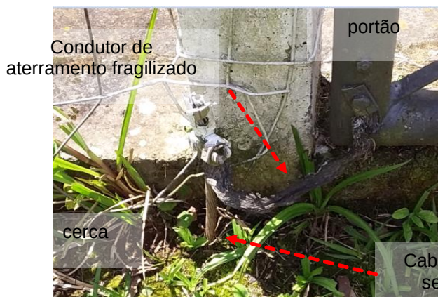
Figuras 859 e 860: Condutor de aterramento esta fragilizado na conexão com a cerca metálica //// Condutor de aterramento com seção inferior ao estipulado pela norma
