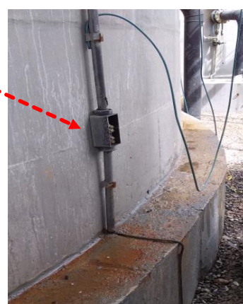
Figuras 792 e 793: Subsistema de descidas – Não conformidades encontradas
