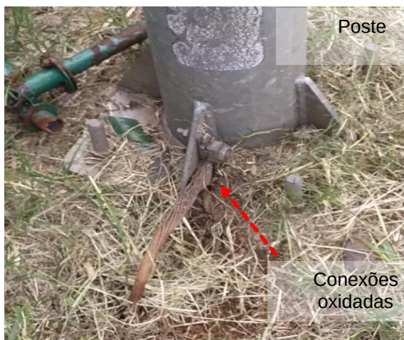
Figuras 696 e 697: Subsistema de aterramento – Não conformidades
