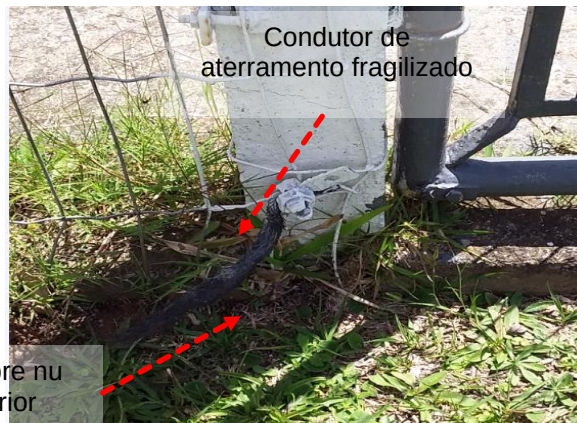
Figuras 859 e 860: Condutor de aterramento esta fragilizado na conexão com a cerca metálica //// Condutor de aterramento com seção inferior ao estipulado pela norma
