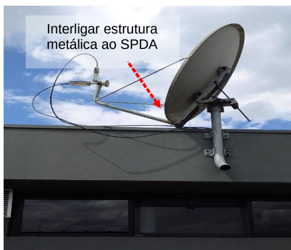
Figuras 351 e 352: Elementos metálicos não interligados ao SPDA – Cobertura.
