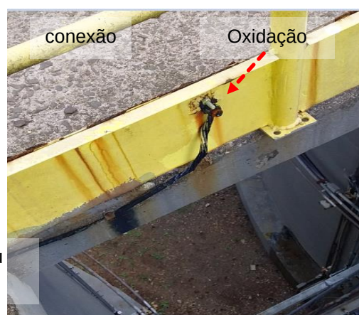
Figuras 776 e 777: Oxidação nas conexões entre o sistema de captação
