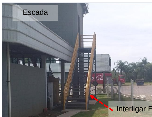
Figuras 517 e 518: Elementos metálicos nesta área não interligados ao SPDA.
