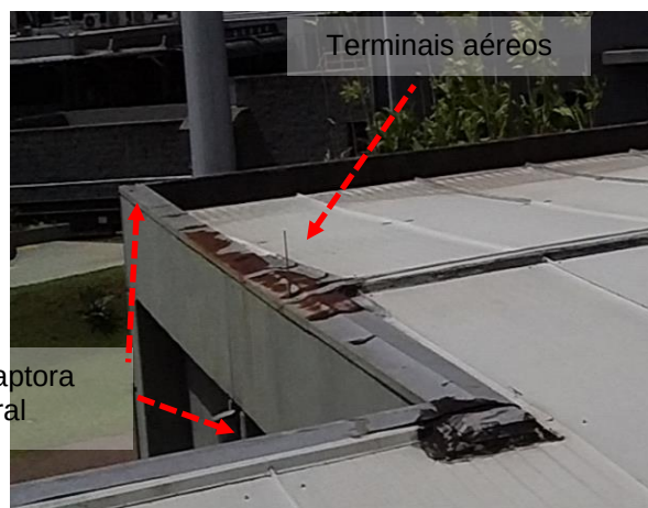
Figuras 247 e 248: sistema captor existente – Prédio 09 – Estac. Motos/Escritório
