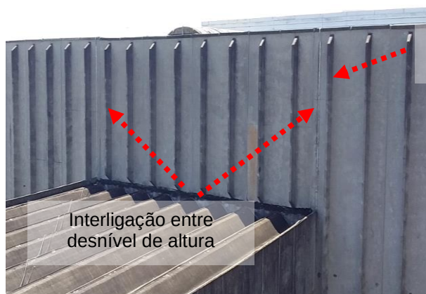
Figuras 50 e 51: Sistema Captor - Interligação entre desnível de altura malha captora.
