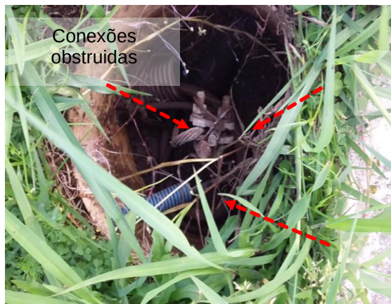
Figuras 717 e 718: Subsistema de aterramento – Não conformidades
