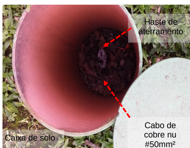
Figuras 607 e 608: Caixa de inspeção de solo // Interligação entre elementos metálicos e a malha de aterramento.
