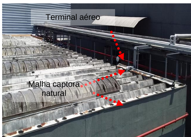
Figuras 113 e 114: sistema captor existente – Prédio 04 - Máquinas Auxiliares
