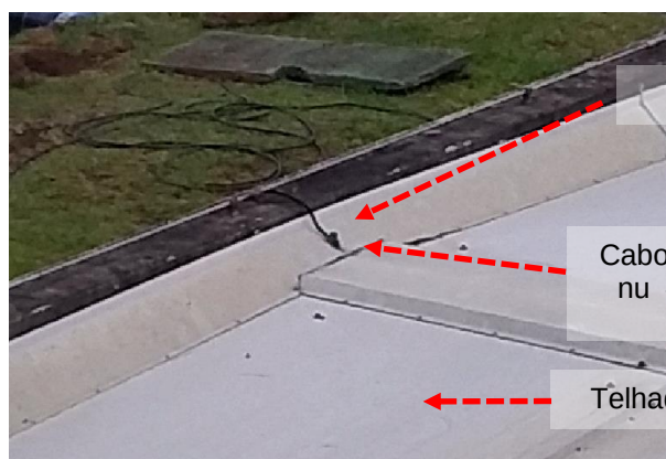
Figuras 661 e 662: sistema captor existente – Prédio 14 – Casa de Bombas
