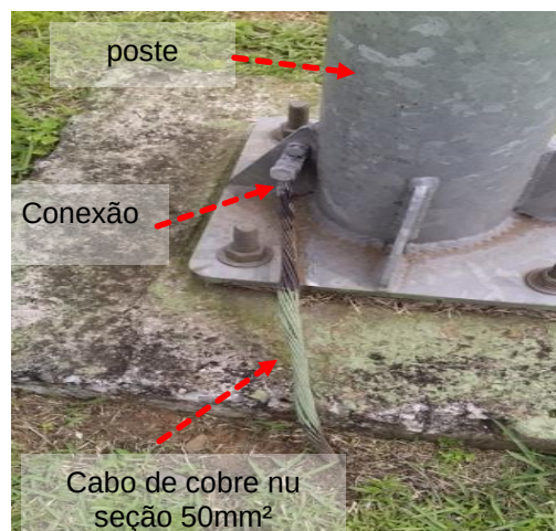
Figuras 680 e 681: Interligação entre elementos metálicos e a malha de aterramento.
