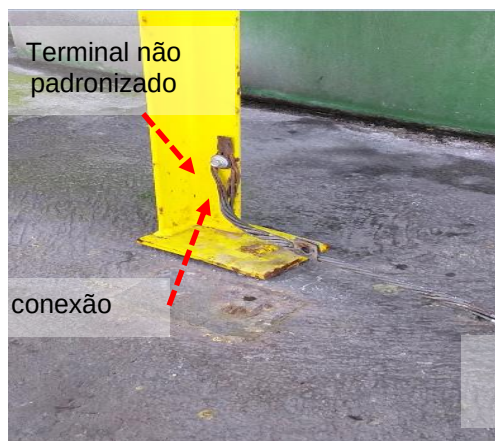
Figuras 558 e 559: Oxidação na interligação entre elementos metálicos e o sistema de captação.
