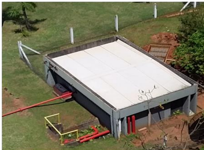
Figura 656: Prédio 14 – Casa de Bombas
