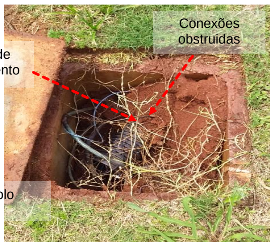
Figuras 684 e 685: Subsistema de aterramento – Não conformidades
