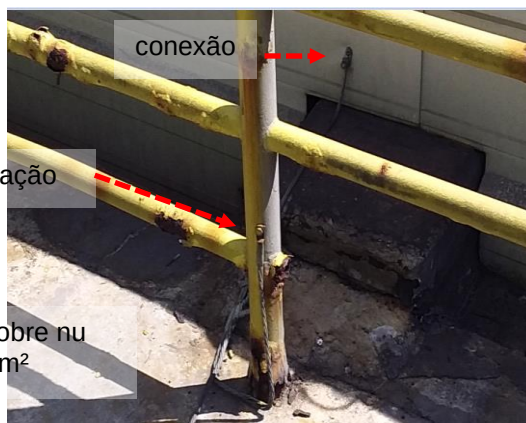
Figuras 560 e 561: Oxidação na interligação entre elementos metálicos e o sistema de captação.
