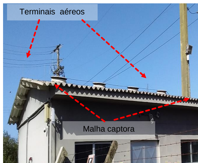
Figuras 458 e 459: sistema captor existente - Prédio 23 – Subestação 69 KV
