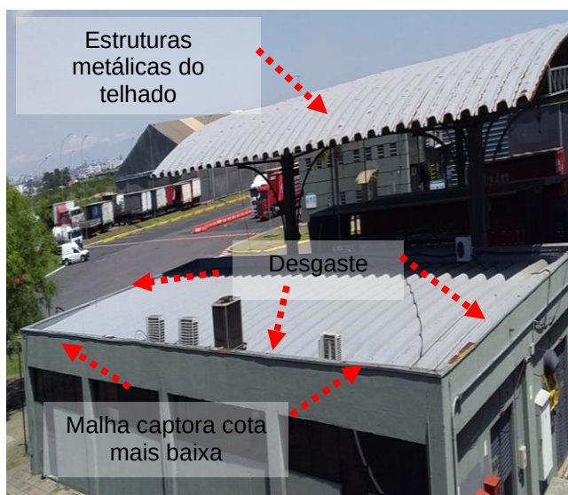
Figuras 131 e 132: Sistema captor existente – Prédio 05 – Conferencia.
