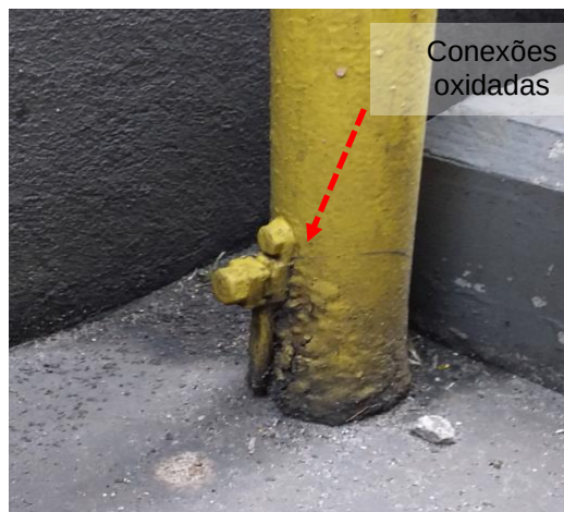
Figuras 578 e 579: Subsistema de aterramento – Não conformidades
