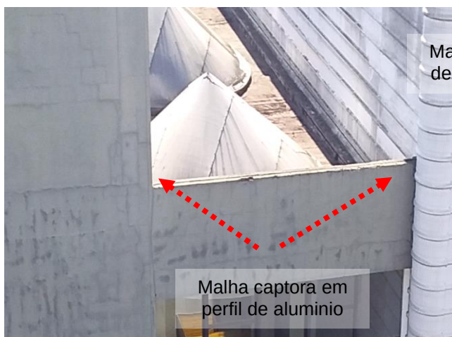
Figuras 84 e 85: sistema captor existente – Prédio 03 – Silo Açúcar
