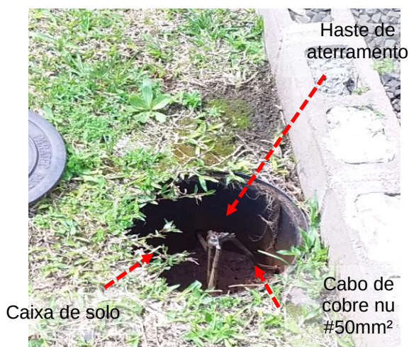
Figuras 634 e 635: Caixa de inspeção de solo // Interligação entre elementos metálicos e a malha de aterramento.
