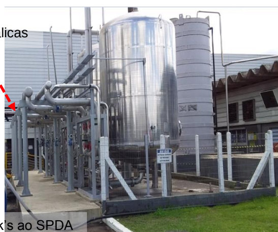
Figuras 499 e 500: Elementos metálicos nesta área não interligados ao SPDA.
