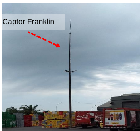
Figuras 189 e 190: sistema captor existente – Prédio 07 – Manutenção da Frota
