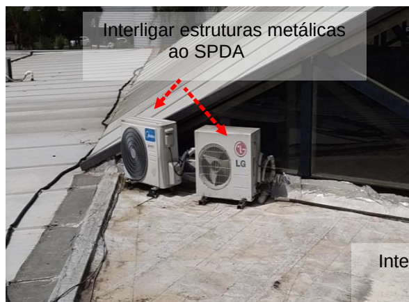
Figuras 355 e 356: Elementos metálicos não interligados ao SPDA
