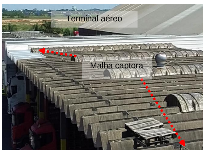
Figuras 158 e 159: sistema captor existente – Prédio 06 - Almojarifado
