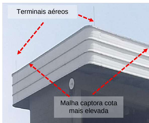
Figuras 502 e 503: sistema captor existente – Prédio 26 – Prensa de Lodo
