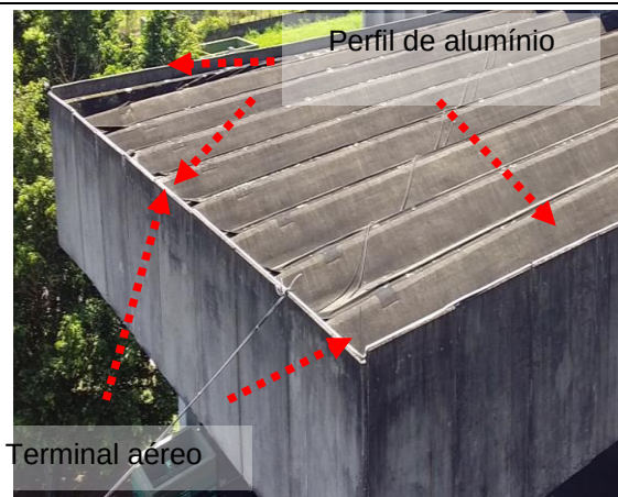
Figuras 46 e 47: Sistema Captor - Terminais aéreos sobre a malha captora
