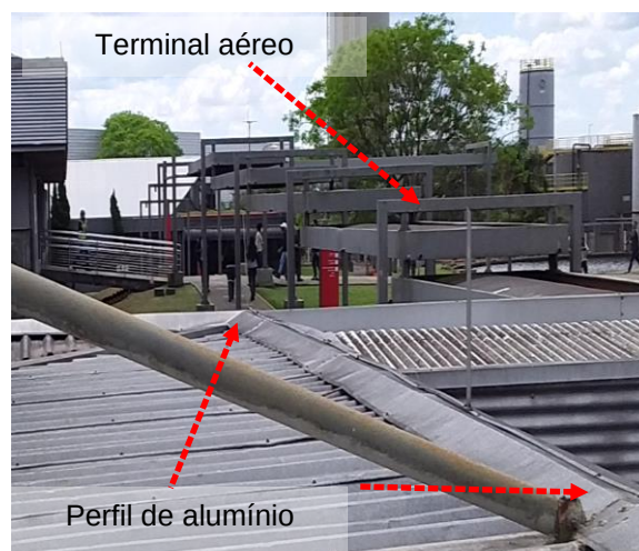
Figuras 285 e 286 : Sistema captor existente – Prédio 11 ( Recepção)
