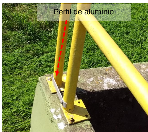
Figuras 882 e 883: Sistema Captor existente - Prédio 30 – Captação de Água
