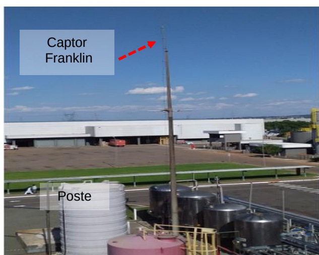
Figuras 480 e 481: sistema captor existente – Prédio 24- Estoque químicos/Inflamáveis
