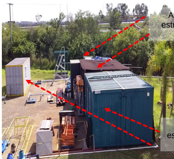
Figuras 923 e 924: Aterrar/Interligar estruturas ao SPDA existente
