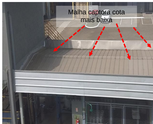
Figuras 504 e 505 : sistema captor existente – Prédio 26 – Prensa de Lodo
