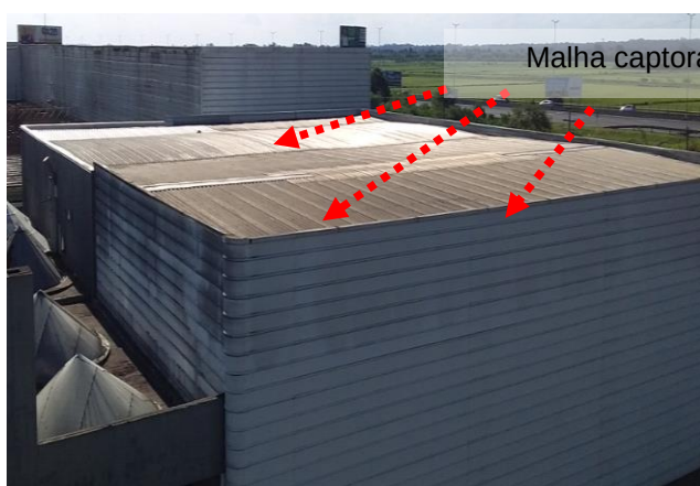
Figuras 86 e 87: sistema captor existente – Prédio 03 – Silo Açúcar
