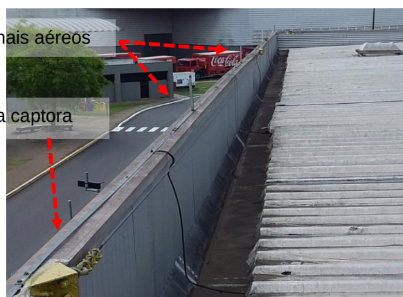
Figuras 593 e 594: sistema captor existente – Prédio 29 - Vestiário e Restaurante novo.
