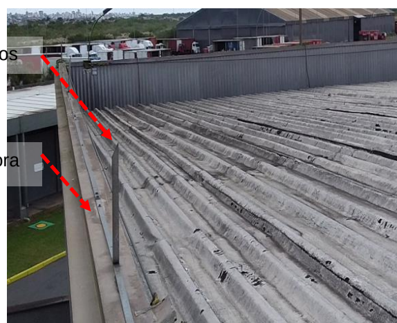
Figuras 591 e 592: sistema captor existente – Prédio 29 - Vestiário e Restaurante novo.
