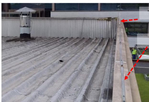
Figuras 593 e 594: sistema captor existente – Prédio 29 - Vestiário e Restaurante novo.
