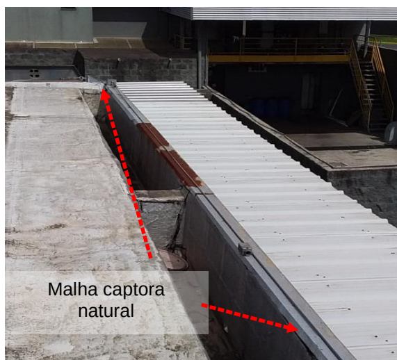
Figuras 331 e 332: Sistema captor existente – Prédio 13 –SEMT/Banco
