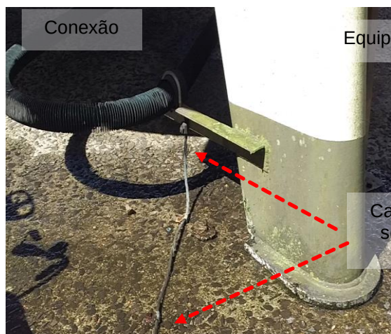
Figuras 851 e 852: Subsistema de aterramento - Prédio 27 – Abastecimento de GLP
