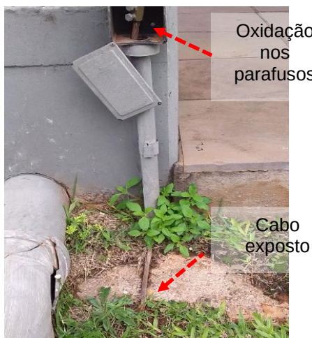
Figuras 261 e 262 : Substância de descidas – Não conformidades
