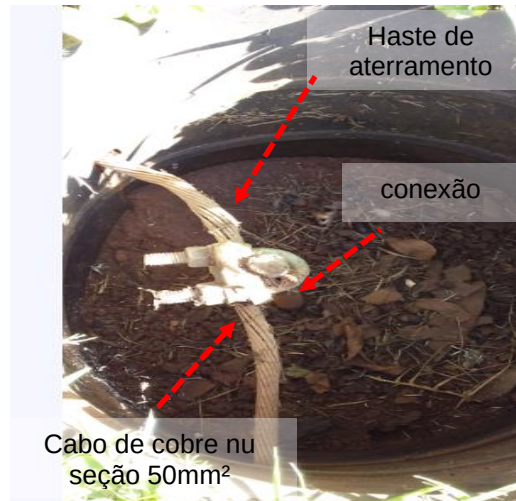
Figuras 230 e 231: Interligação entre elementos metálicos e a malha de aterramento // Caixa de solo existente
