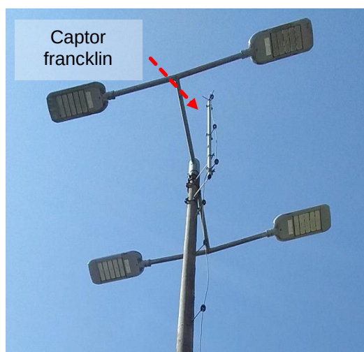
Figuras 904 e 905: Sistema captor existente - Áreas diversas
