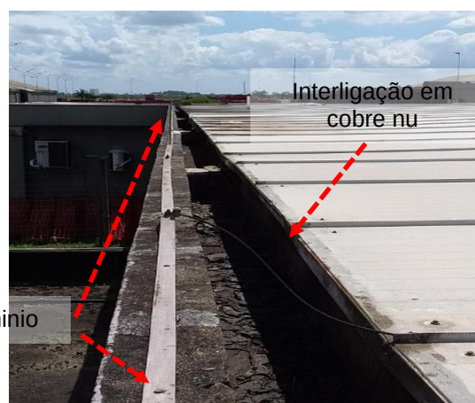
Figuras 245 e 246 : sistema captor existente – Prédio 09 – Estac. Motos/Escritório
