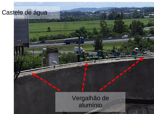
Figuras 744 e 745: sistema captor existente – ETA/ETE (Construções Gerais)
