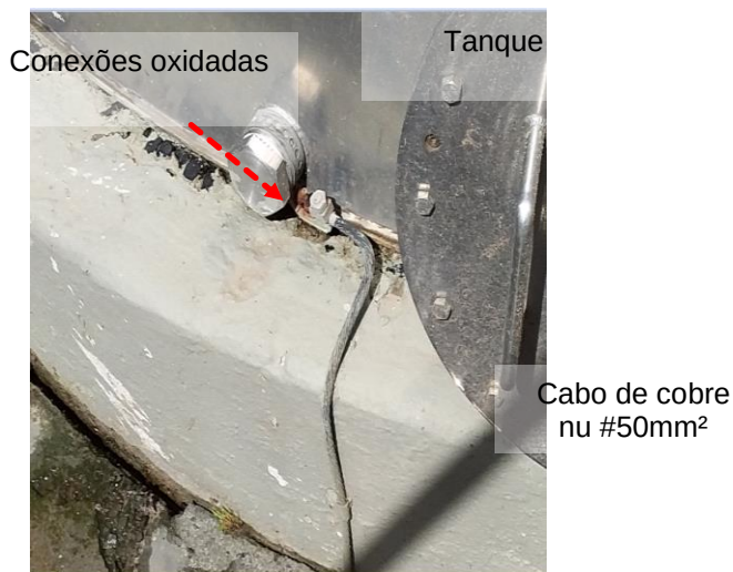
Figuras 804 e 805: Subsistema de aterramento – Não conformidades
