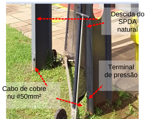
Figuras 341 e 342: Sistema de Descidas Naturais – Pilares metálicos Descida convencional não encontrada
