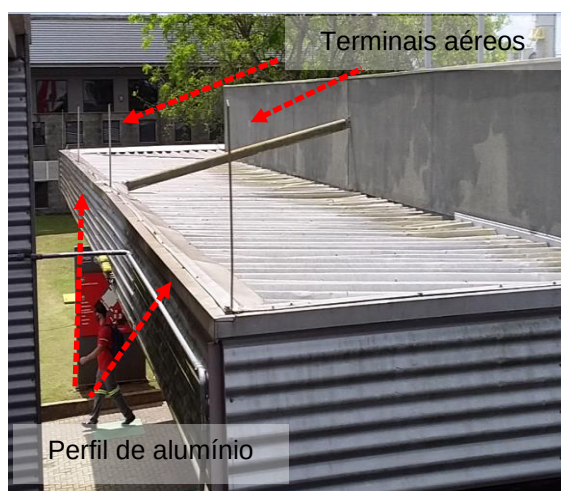
Figuras 281 e 282 : Sistema captor existente – Prédio 11 ( Recepção)
