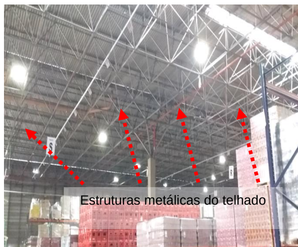
Figuras 03 e 04: Sistema Captor - Estruturas metálicas do telhado
