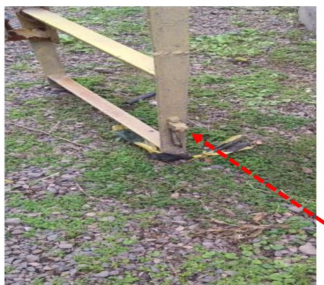
Figuras 515 e 516: Subsistema de aterramento – Não conformidades
