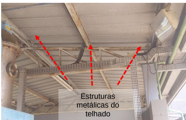
Figuras 508 e 509 : sistema captor existente – Prédio 26 – Prensa de Lodo
