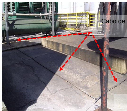
Figuras 532 e 533: sistema captor existente – Prédio 28 - Utilidades
