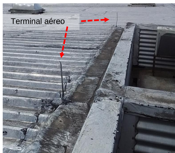
Figuras 599 e 600: sistema captor existente – Prédio 29 - Vestiário e Restaurante novo.
