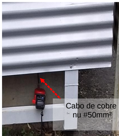
Figuras 295 e 296: Sistema de Descidas - Indicação da descida não encontrada Descida natural encontrada
