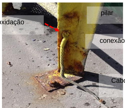
Figuras 564 e 565: Oxidação na interligação entre elementos metálicos e o sistema de captação // Cabo solto
