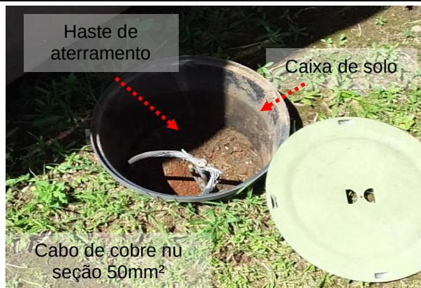
Figuras 421 e 422: Caixa de inspeção de solo // Interligação entre elementos metálicos e a malha de aterramento.
