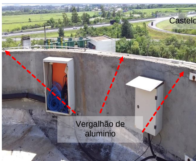
Figuras 742 e 743 : sistema captor existente – ETA/ETE (Construções Gerais)
