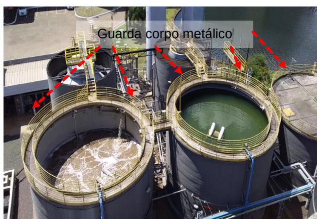
Figuras 748 e 749: sistema captor existente – ETA/ETE (Construções Gerais)
