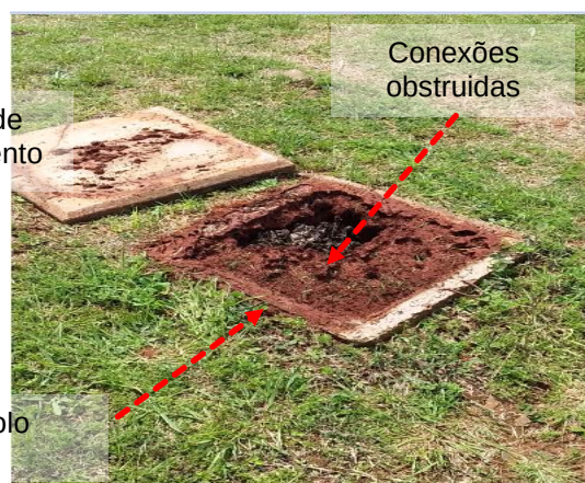
Figuras 688 e 689: Subsistema de aterramento – Não conformidades
