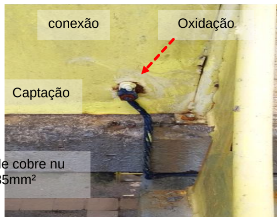
Figuras 774 e 775: Oxidação nas conexões entre o sistema de captação
