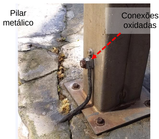
Figuras 808 e 809: Subsistema de aterramento – Não conformidades
