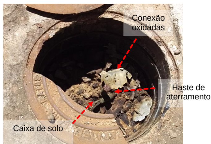
Figuras 449 e 450: Subsistema de aterramento – Não conformidades
