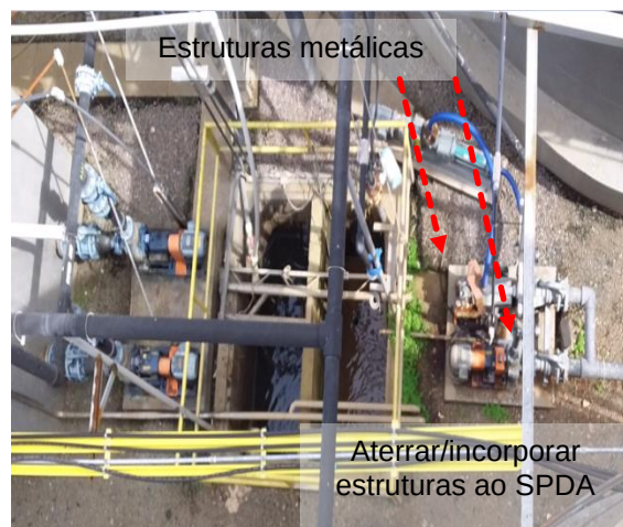
Figuras 820 e 821: Elementos metálicos não interligados ao SPDA - Motores
