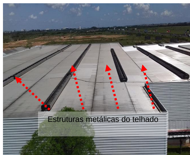
Figuras 05 e 06: Sistema Captor - Estruturas metálicas do telhado
