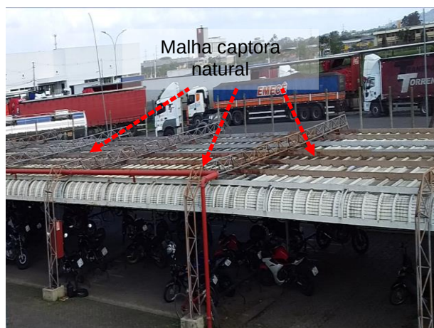
Figuras 362 e 363: sistema captor existente – Prédio 17 - Estac. Motos e bicicletas
