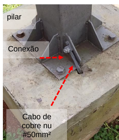
Figuras 607 e 608: Caixa de inspeção de solo // Interligação entre elementos metálicos e a malha de aterramento.
