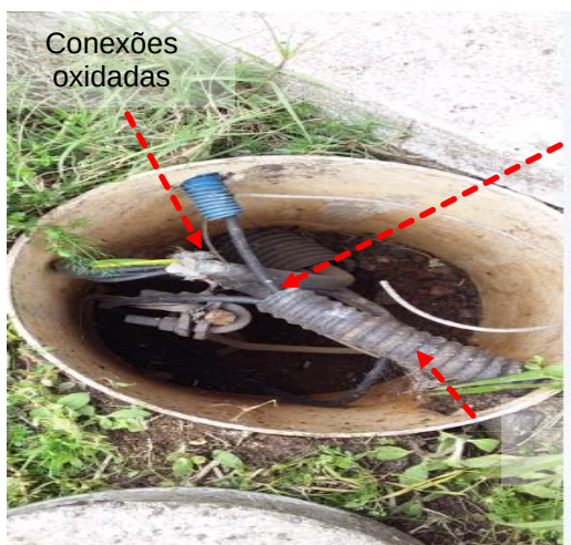
Figuras 721 e 722: Subsistema de aterramento – Não conformidades
