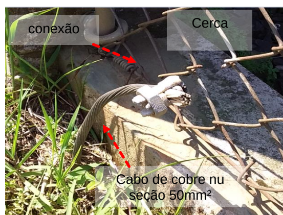
Figuras 466 e 467: Interligação entre elementos metálicos e a malha de aterramento.
