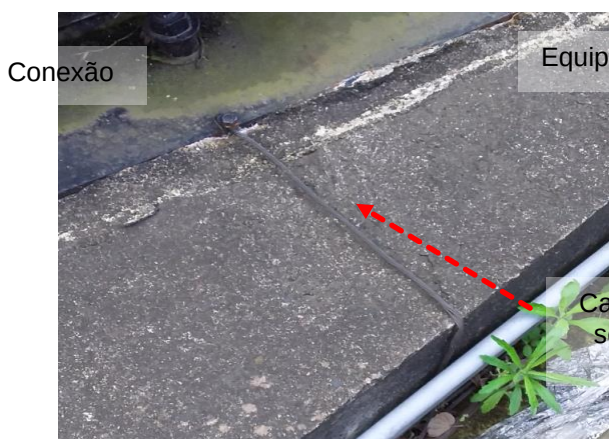
Figuras 853 e 854: Subsistema de aterramento - Prédio 27 – Abastecimento de GLP
