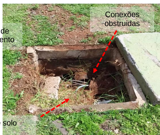
Figuras 692 e 693: Subsistema de aterramento – Não conformidades
