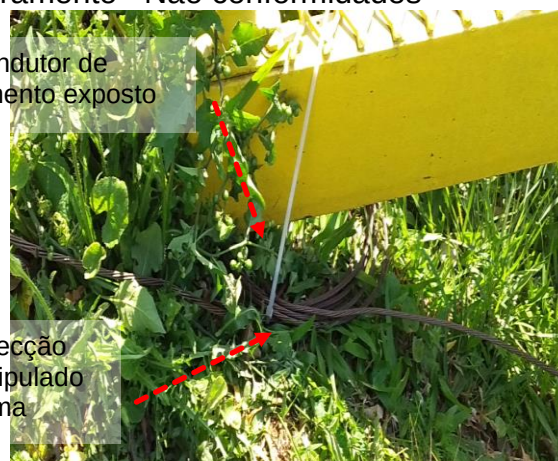
Figuras 894 e 895: Sistema de Aterramento –Não conformidades
