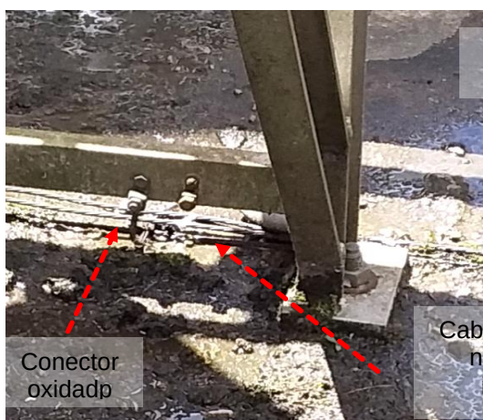
Figuras 867 e 868: Interligação entre o sistema de aterramento com a estrutura oxidado
