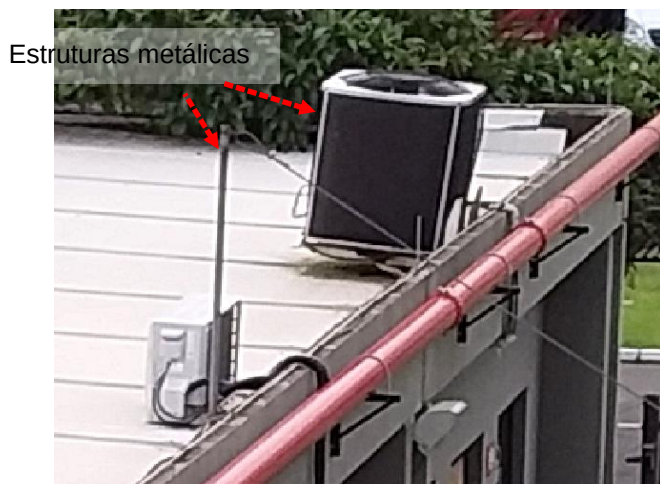
Figuras 318 e 319: Elementos metálicos não interligados ao SPDA
