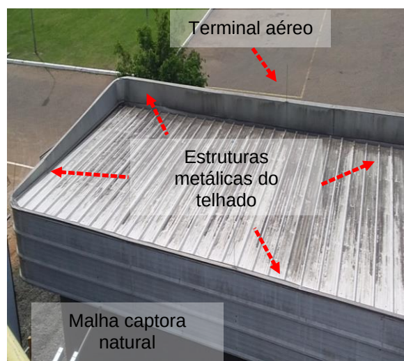
Figuras 382 e 383: Sistema captor existente – Central de Resíduos - Classe I
