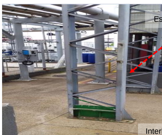
Figuras 499 e 500: Elementos metálicos nesta área não interligados ao SPDA.
