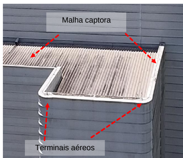
Figuras 437 e 438: sistema captor existente – Prédio 21 -Depósito de Equipamentos
