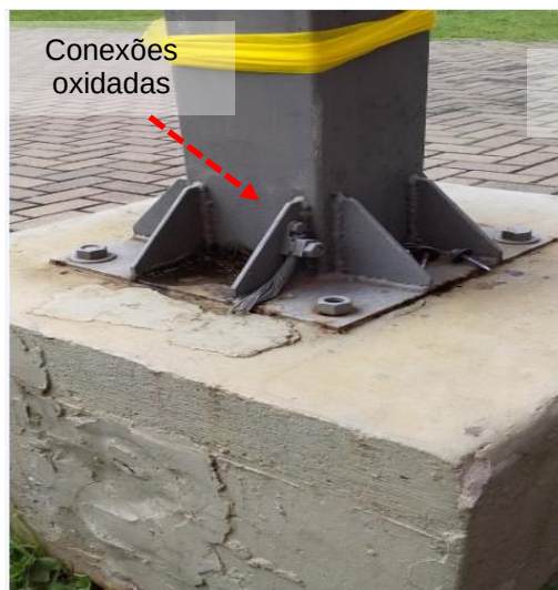
Figuras 623 e 624: Subsistema de aterramento – Não conformidades
