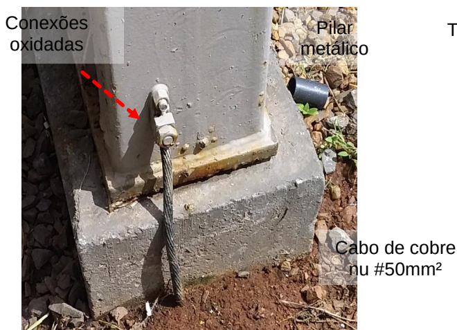
Figuras 806 e 807: Subsistema de aterramento – Não conformidades
