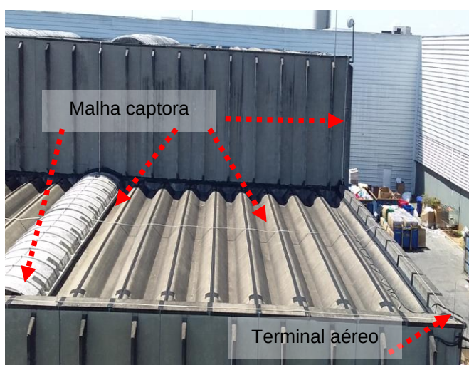
Figuras 48 e 49: Sistema Captor - Malha captora em perfil de alumínio secção #75mm 2 .
