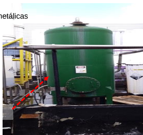
Figuras 877 e 878: Elementos metálicos não interligados ao SPDA (Tanques).
