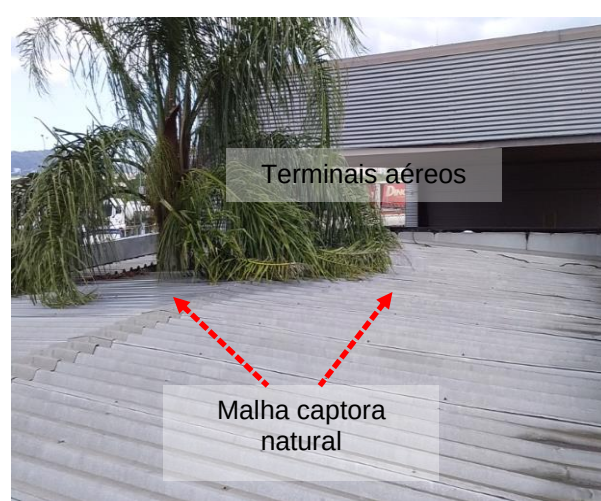
Figuras 277 e 278 : Sistema captor existente – Prédio 11 ( Recepção)
