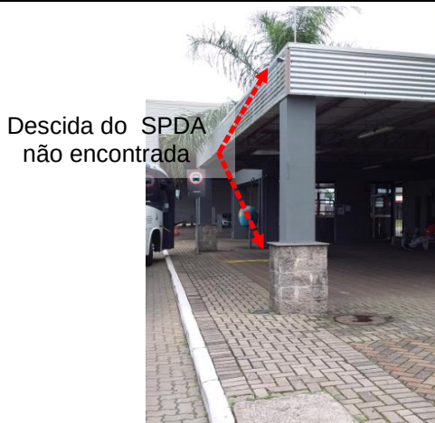
Figuras 295 e 296: Sistema de Descidas - Indicação da descida não encontrada Descida natural encontrada
