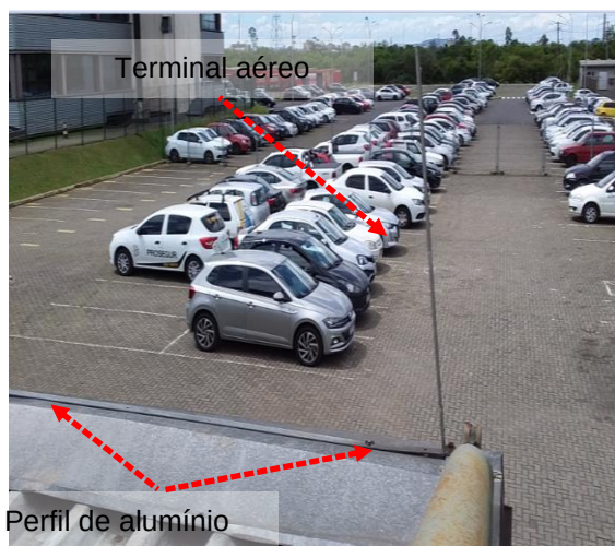
Figuras 285 e 286 : Sistema captor existente – Prédio 11 ( Recepção)
