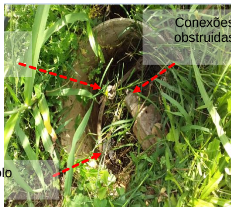
Figuras 717 e 718: Subsistema de aterramento – Não conformidades
