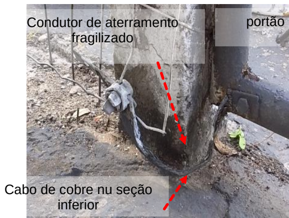
Figuras 857 e 858: Condutor de aterramento esta fragilizado na conexão com portão metálico /// Condutor de aterramento esta rompido
