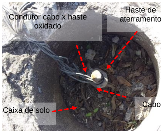
Figuras 863 e 864: Conector cabo x haste obstruído /// oxidado /// Conductor de aterramento com seção inferior ao estipulado pela norma
