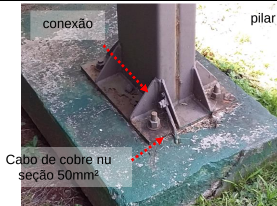
Figuras 421 e 422: Caixa de inspeção de solo // Interligação entre elementos metálicos e a malha de aterramento.
