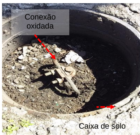
Figuras 182 e 183: Conexão cabo haste oxidadas / Conexão estrutura oxidada.
