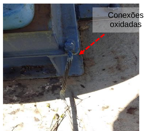
Figuras 580 e 581: Subsistema de aterramento – Não conformidades
