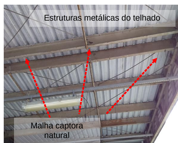
Figuras 275 e 276 : sistema captor existente - Prédio 11 ( Recepção)
