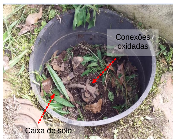
Figuras 376 e 377: Subsistema de aterramento – Não conformidades
