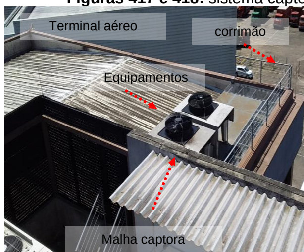
Figuras 419 e 420: sistema captor existente – Prédio 20 -Administrativo
