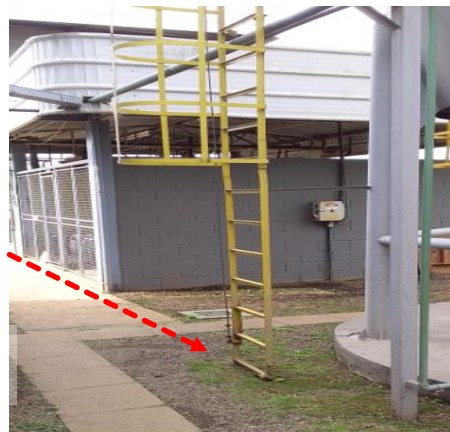
Figuras 814 e 815: Subsistema de aterramento – Não conformidades
