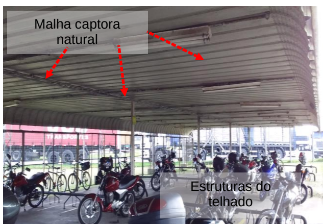
Figuras 364 e 365: sistema captor existente – Prédio 17 – Estac. Motos e bicicletas
