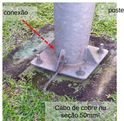
Figuras 205 e 206: Caixa de inspeção de solo // Interligação entre elementos metálicos e a malha de aterramento.
