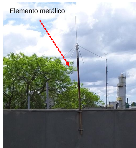
Figuras 305 e 306 : Elementos metálicos não interligados ao SPDA – Cobertura.
