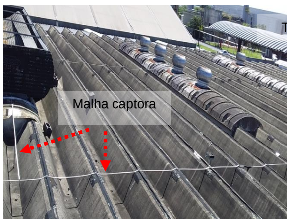
Figuras 156 e 157: sistema captor existente – Prédio 06 - Almojarifado
