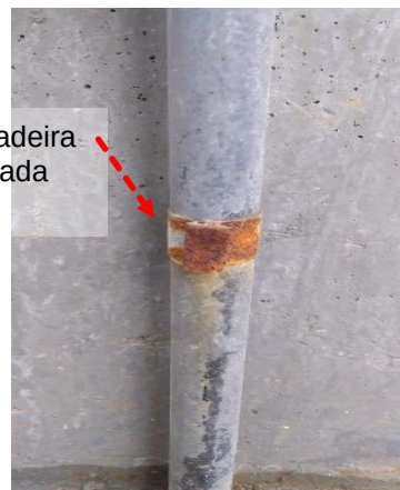
Figuras 784 e 785: Subsistema de descidas – Não conformidades encontradas
