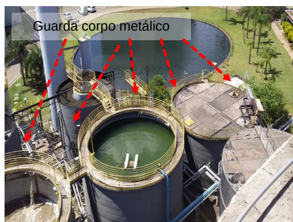
Figuras 748 e 749: sistema captor existente – ETA/ETE (Construções Gerais)
