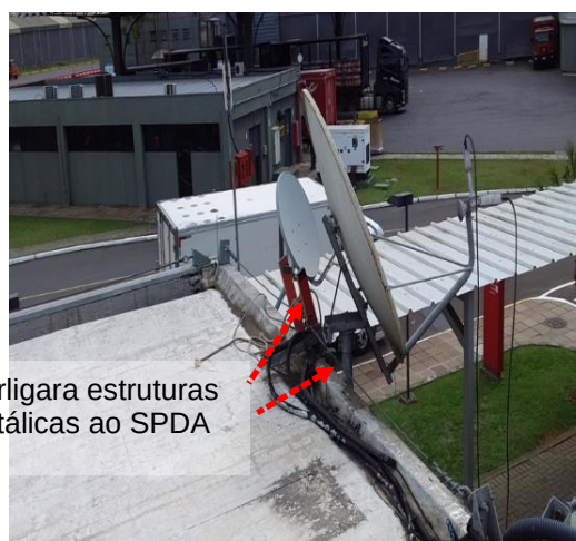
Figuras 351 e 352: Elementos metálicos não interligados ao SPDA – Cobertura.
