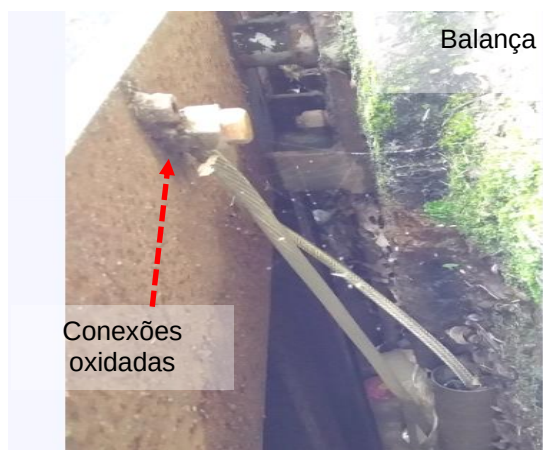
Figuras 621 e 622: Subsistema de aterramento – Não conformidades
