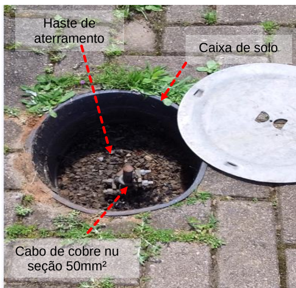
Figuras 441 e 442: Caixa de inspeção de solo // Interligação entre elementos metálicos e a malha de aterramento.
