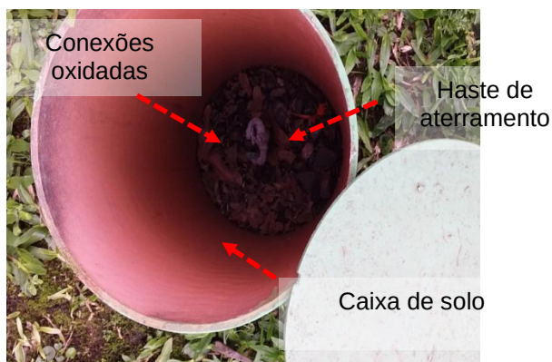
Figuras 619 e 620: Subsistema de aterramento – Não conformidades
