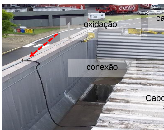
Figuras 611 e 612: Oxidação nas conexões entre o sistema de captação e descidas.
