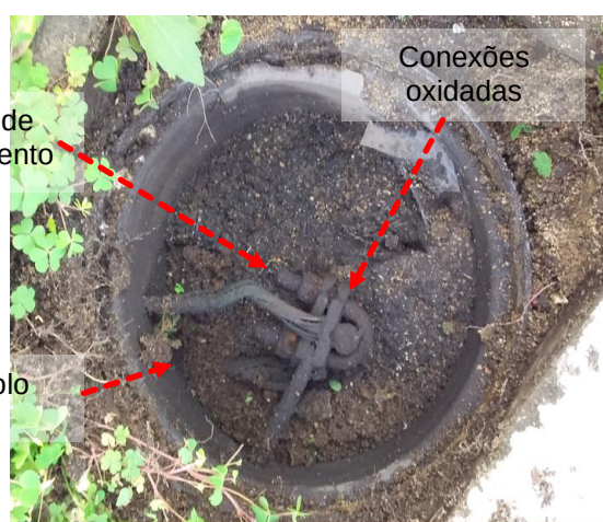
Figuras 731 e 732: Subsistema de aterramento – Não conformidades
