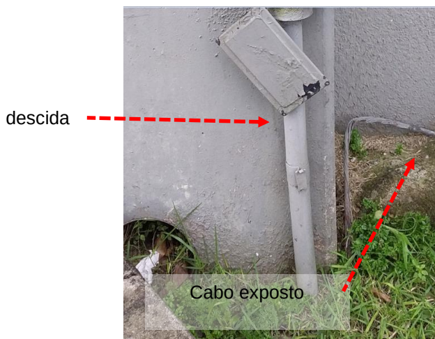
Figuras 261 e 262 : Substância de descidas – Não conformidades
