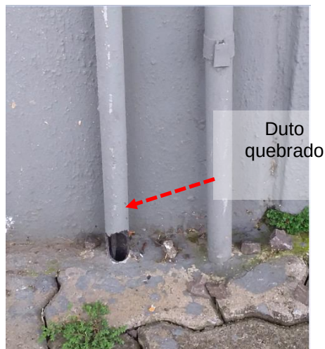
Figuras 572 e 573: Subsistema de descidas – Não conformidades
