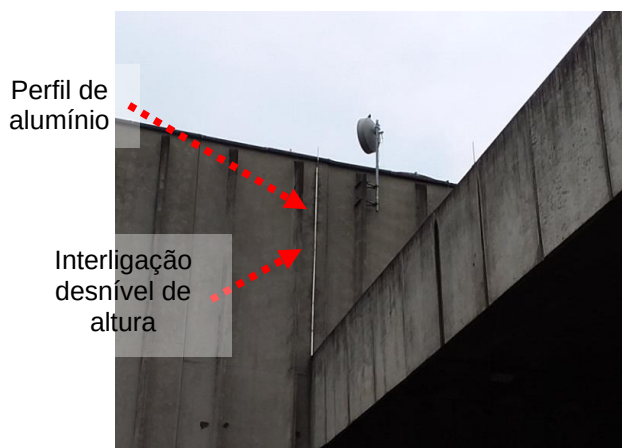
Figuras 50 e 51: Sistema Captor - Interligação entre desnível de altura malha captora.
