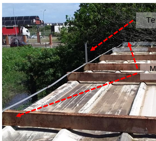
Figuras 645 e 646: sistema captor existente – Prédio 32- Quiosque entrega refrigerante
