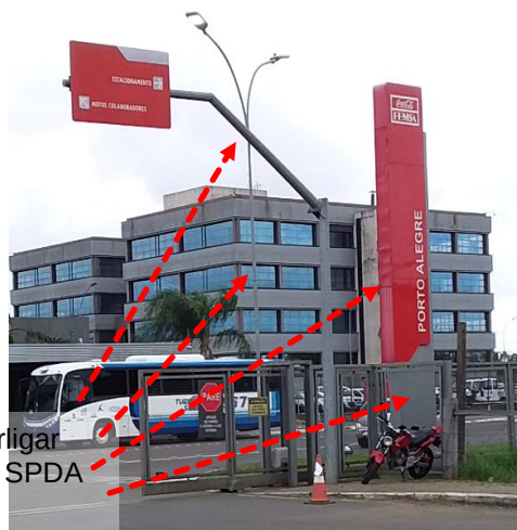
Figuras 921 e 922: Aterrar/Interligar estruturas ao SPDA existente
