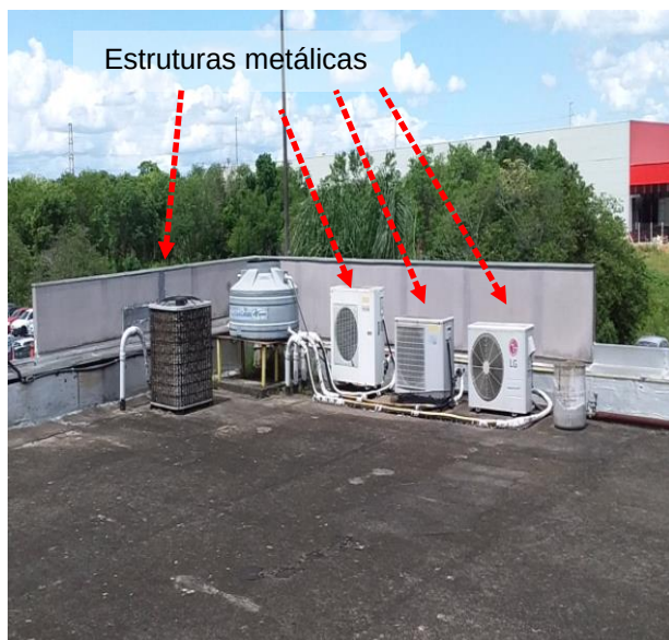
Figuras 305 e 306 : Elementos metálicos não interligados ao SPDA – Cobertura.
