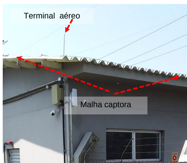
Figuras 460 e 461: sistema captor existente - Prédio 23 – Subestação 69 KV
