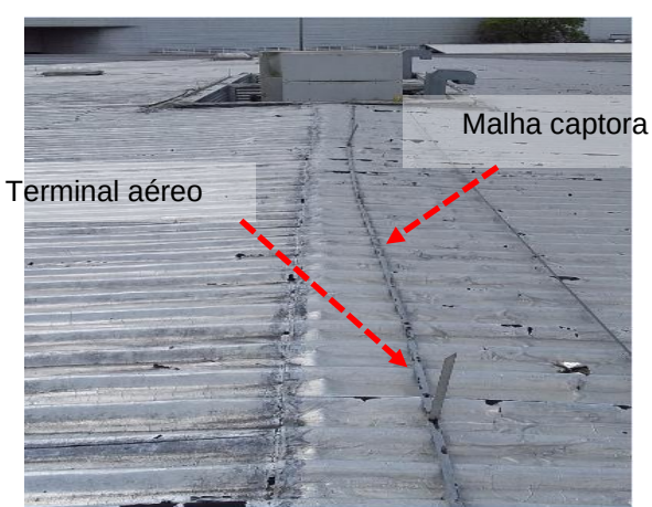
Figuras 597 e 598: sistema captor existente – Prédio 29 - Vestiário e Restaurante novo.
