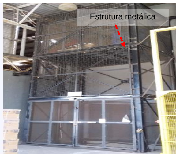
Figuras 451 e 452: Elementos metálicos não interligados ao SPDA
