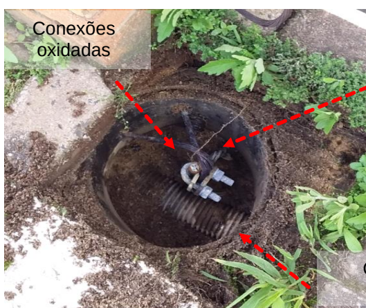
Figuras 725 e 726: Subsistema de aterramento – Não conformidades
