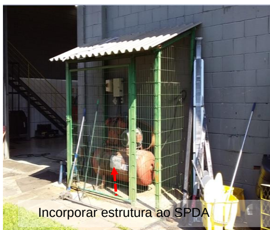
Figuras 217 e 218 : Elementos metálicos não interligados ao SPDA
