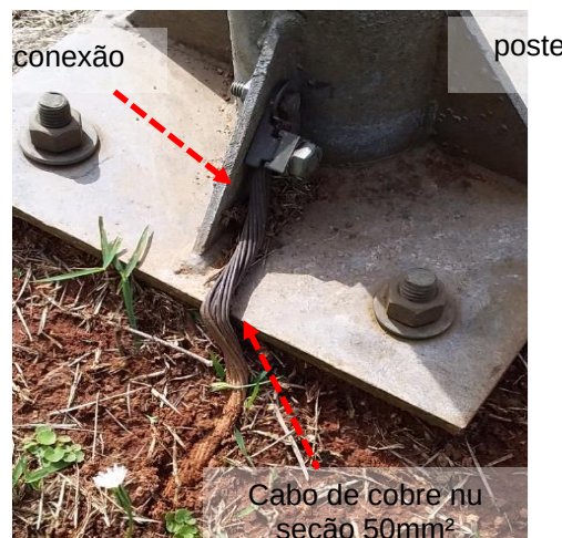
Figuras 257 e 258: Caixa de inspeção de solo // Interligação entre elementos metálicos e a malha de aterramento.
