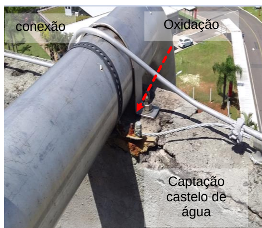
Figuras 772 e 773: Condutor rompido na conexão com o captor Franklin Oxidação nas conexões entre o sistema de captação
