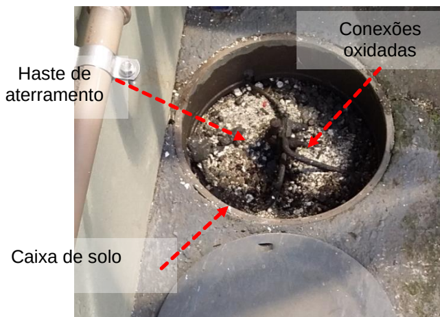
Figuras 798 e 799: Substância de aterramento – Não conformidades
