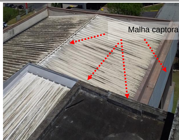
Figuras 405 e 406: sistema captor existente – Prédio 20 -Administrativo
