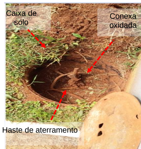
Figuras 234 e 235: Substância de aterramento – Não conformidades
