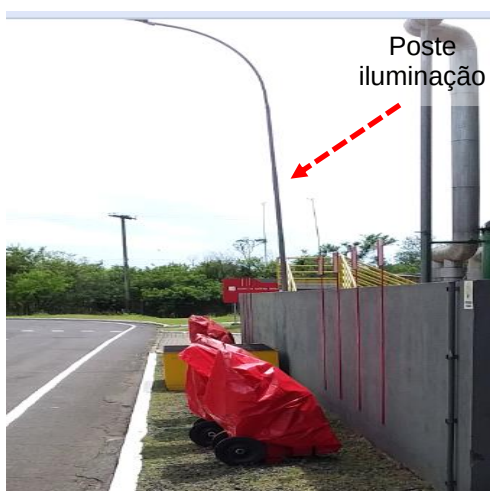
Figuras 584 e 585: Elementos metálicos não interligados ao SPDA
