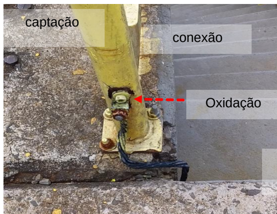
Figuras 774 e 775: Oxidação nas conexões entre o sistema de captação
