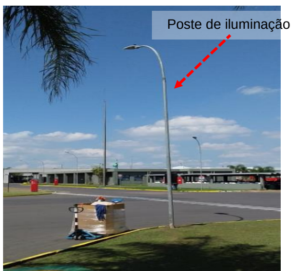
Figuras 184 e 185: Elementos metálicos não interligados ao SPDA
