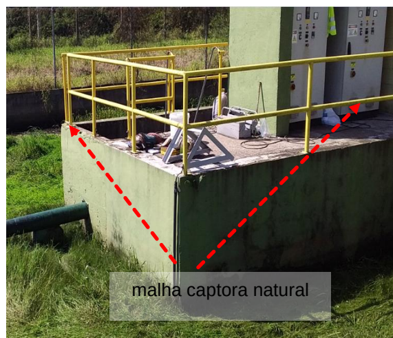
Figuras 888 e 889: Sistema Captor existente - Prédio 30 -Captação de Água -Guarda-corpo
