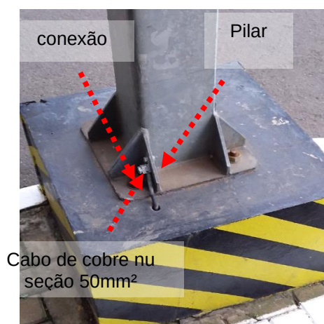
Figuras 123 e 124: Interligação entre elementos metálicos e a malha de aterramento.
