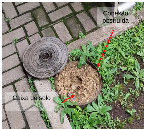
Figuras 301 e 302: Subsistema de aterramento – Não conformidades
