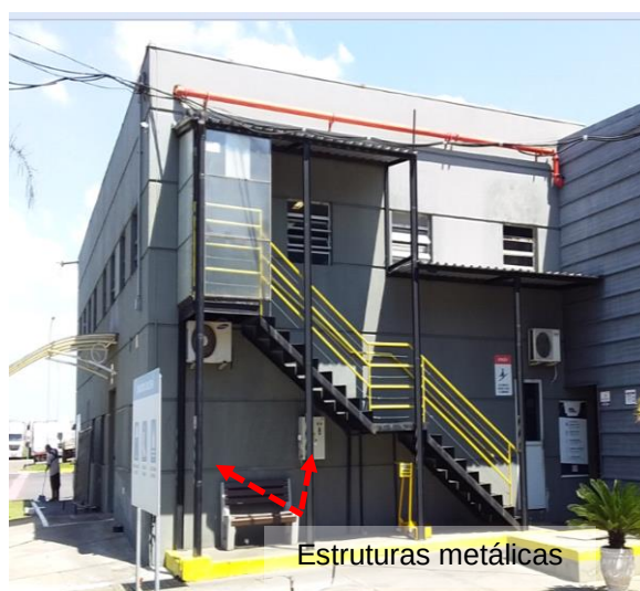
Figuras 184 e 185: Elementos metálicos não interligados ao SPDA
