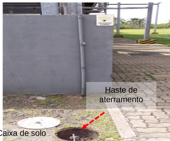
Figuras 552 e 553: Caixa de inspeção de solo // Interligação entre elementos metálicos e a malha de aterramento.
