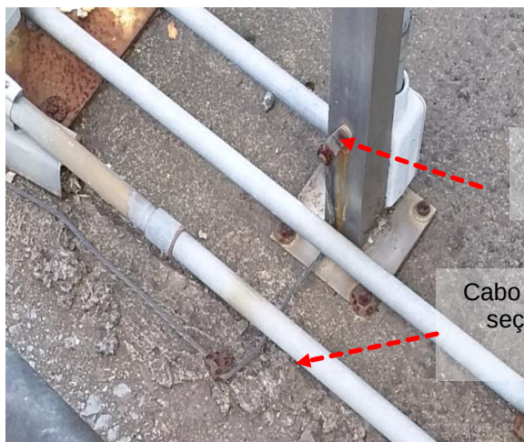
Figuras 873 e 874: Interligação entre o sistema de aterramento com a estrutura oxidado
