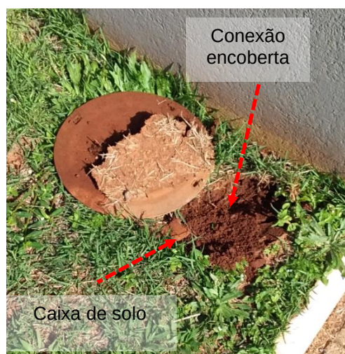
Figuras 232 e 233: Subsistema de aterramento – Não conformidades
