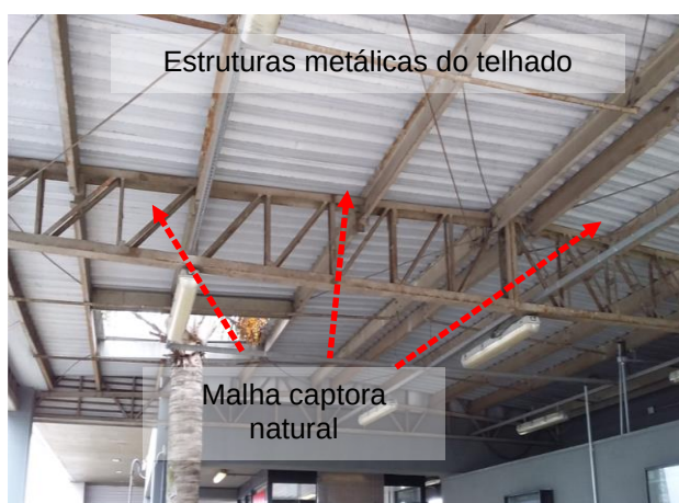
Figuras 275 e 276 : sistema captor existente - Prédio 11 ( Recepção)
