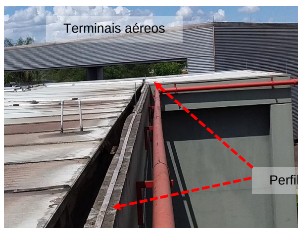
Figuras 245 e 246 : sistema captor existente – Prédio 09 – Estac. Motos/Escritório
