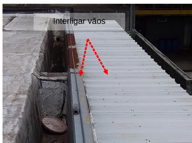
Figuras 359 e 360: Elementos metálicos não interligados ao SPDA
