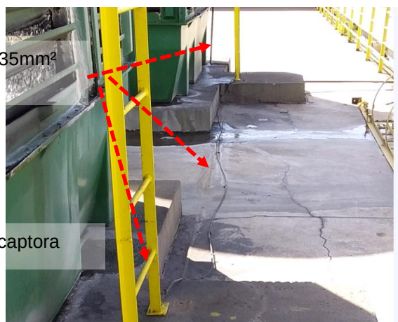
Figuras 534 e 535: sistema captor existente – Prédio 28 - Utilidades
