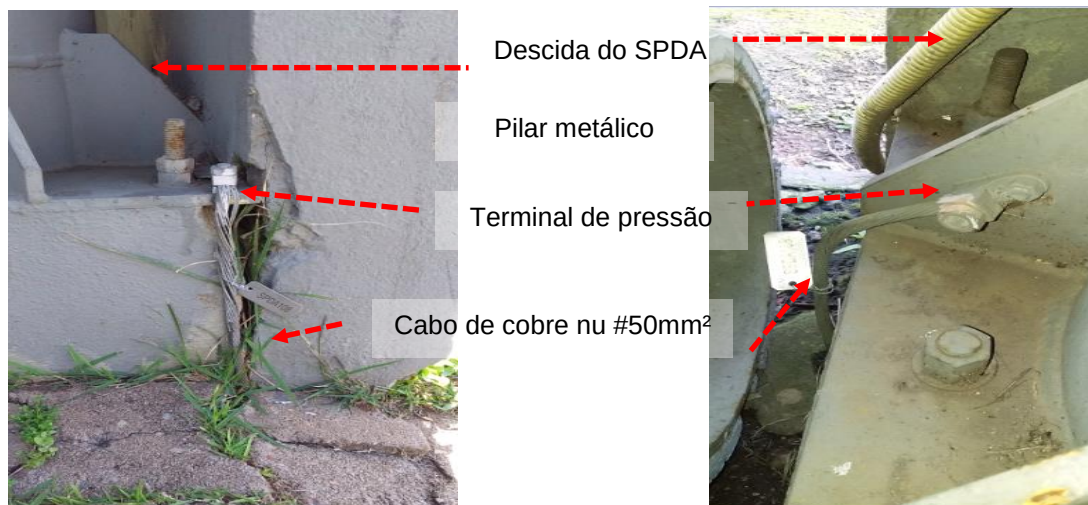
Figuras 224 e 225: Sistema de Descidas Naturais – Pilares metálicos
