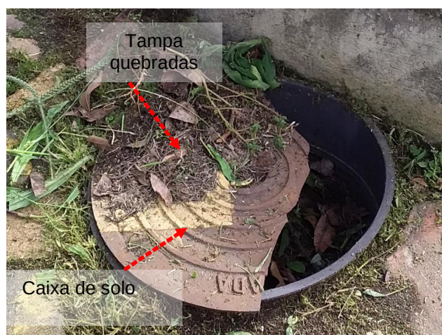
Figuras 376 e 377: Subsistema de aterramento – Não conformidades
