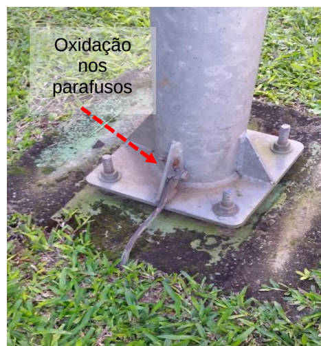
Figuras 211 e 212: Subsistema de aterramento – Não conformidades
