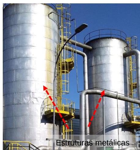
Figuras 584 e 585: Elementos metálicos não interligados ao SPDA
