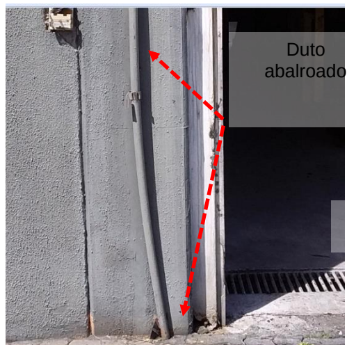
Figuras 572 e 573: Subsistema de descidas – Não conformidades
