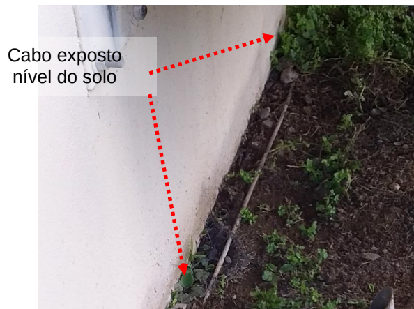
Figuras 427 e 428: Subsistema de aterramento – Não conformidades
