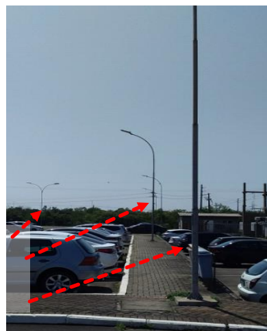
Figuras 919 e 920: Aterrar/Interligar estruturas ao SPDA existente
