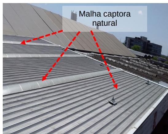
Figuras 626 e 627: sistema captor existente – Prédio 31B –Operações Logísticas
