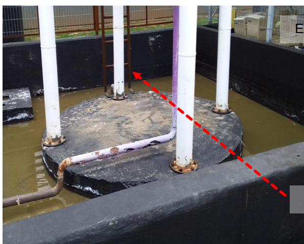
Figuras 877 e 878: Elementos metálicos não interligados ao SPDA (Tanques).
