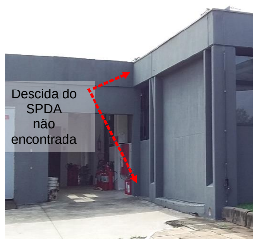
Figuras 341 e 342: Sistema de Descidas Naturais – Pilares metálicos Descida convencional não encontrada
