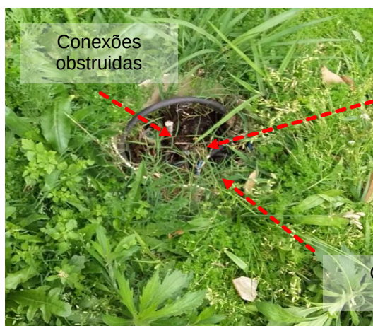
Figuras 719 e 720: Subsistema de aterramento – Não conformidades
