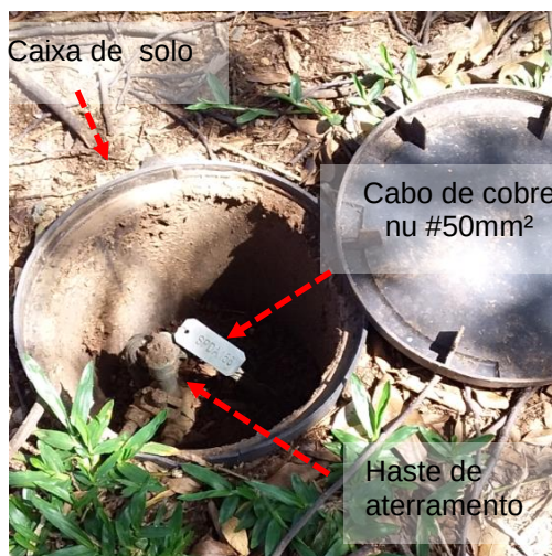
Figura 651: Caixa de inspeção de solo encontrada
