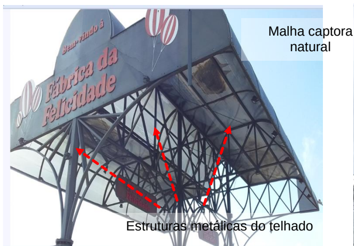
Figuras 707 e 708: sistema captor existente – Prédio 19 –Fábrica da Felicidade
