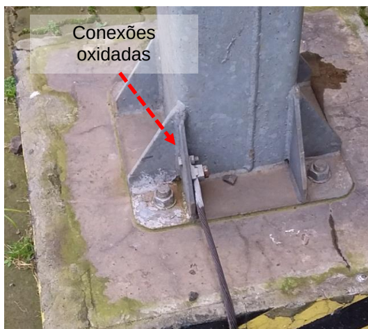
Figuras 582 e 583: Subsistema de aterramento – Não conformidades
