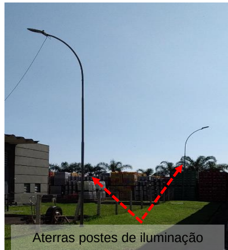
Figuras 215 e 216 : Elementos metálicos não interligados ao SPDA
