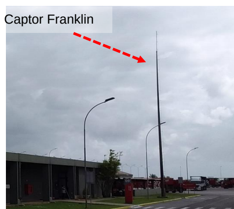
Figuras 239 e 240: sistema captor existente – Prédio 09 – Estac. Motos/Escritório
