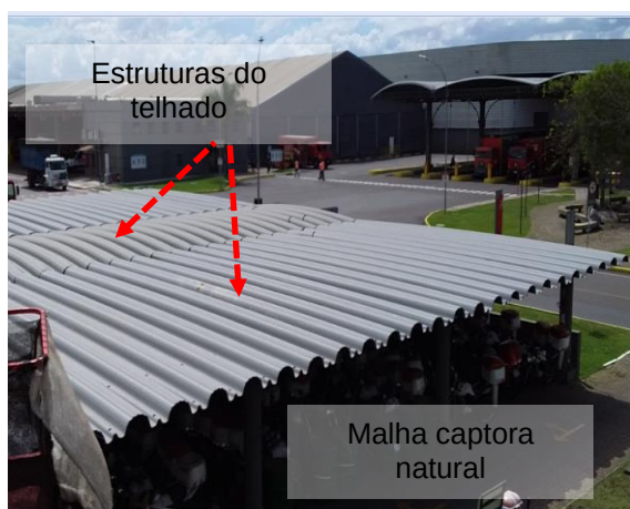
Figuras 222 e 223: sistema captor existente – Prédio 08 - Estacionamento Motos
