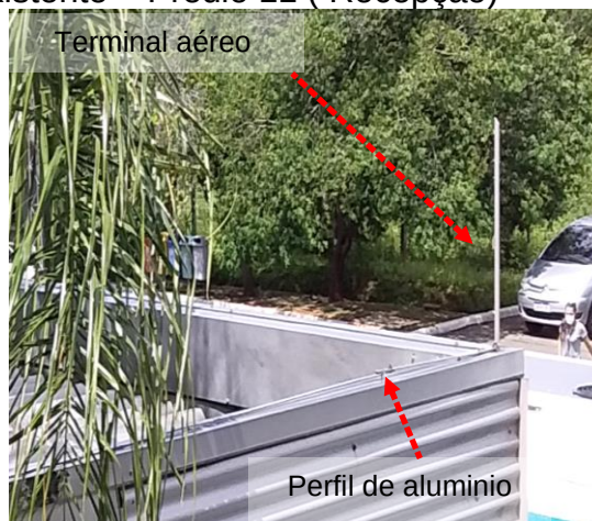
Figuras 283 e 284 : Sistema captor existente – Prédio 11 ( Recepção)
