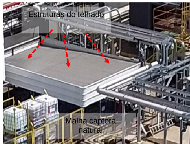
Figuras 482 e 483: sistema captor existente – Prédio 24- Estoque químicos/Inflamáveis
