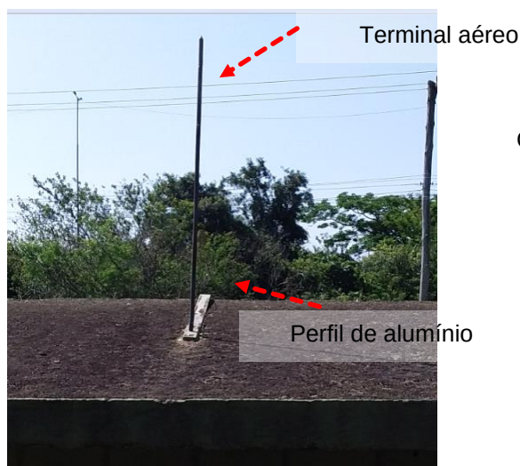
Figuras 880 e 881: Sistema Captor existente - Prédio 30 – Captação de Água
