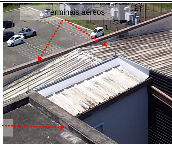
Figuras 399 e 400: sistema captor existente – Prédio 20 -Administrativo
