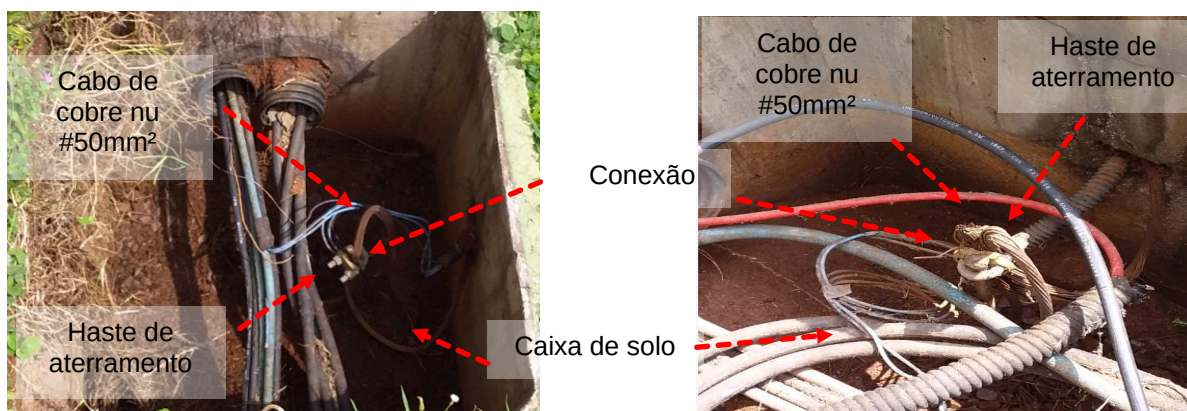
Figuras 674 e 675: Caixas de inspeção de solo encontradas
