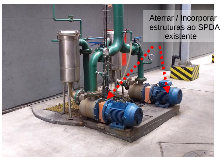
Figura 42: Estruturas não incorporadas ao SPDA existente
