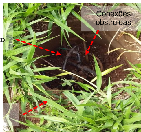
Figuras 719 e 720: Subsistema de aterramento – Não conformidades
