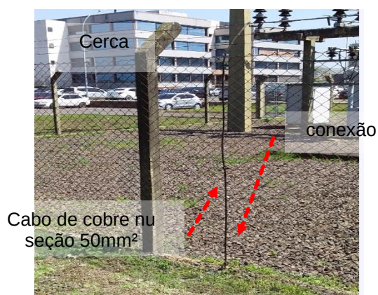
Figuras 466 e 467: Interligação entre elementos metálicos e a malha de aterramento.
