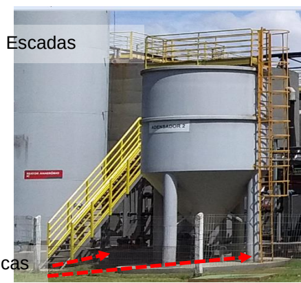
Figuras 517 e 518: Elementos metálicos nesta área não interligados ao SPDA.
