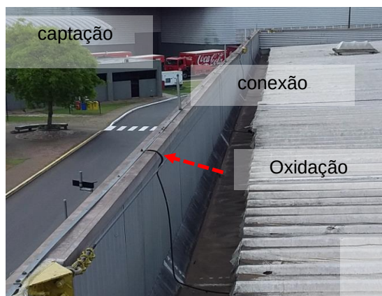
Figuras 609 e 610: Oxidação nas conexões entre o sistema de captação e descidas.
