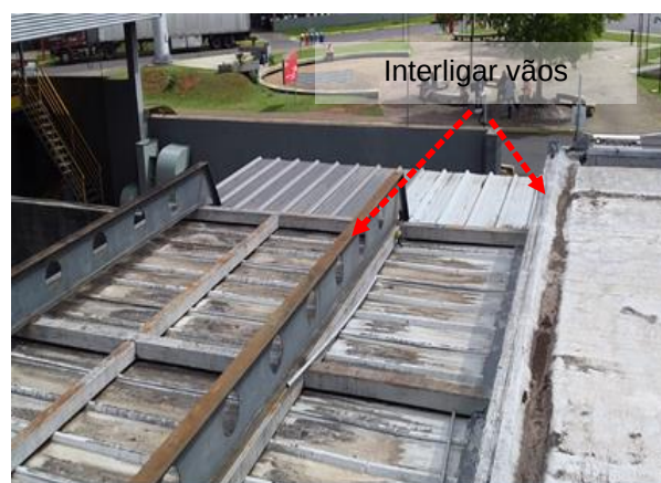
Figuras 357 e 358: Elementos metálicos não interligados ao SPDA
