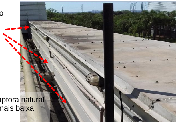
Figuras 522 e 523: sistema captor existente – Prédio 28 - Utilidades
