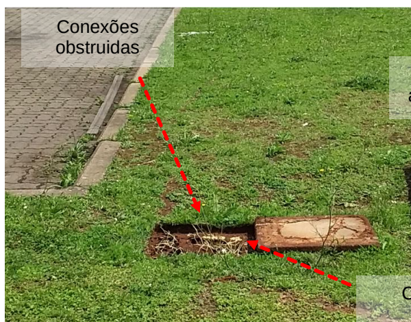
Figuras 692 e 693: Subsistema de aterramento – Não conformidades
