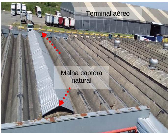
Figuras 162 e 163: sistema captor existente – Prédio 06 - Almoxarifado
