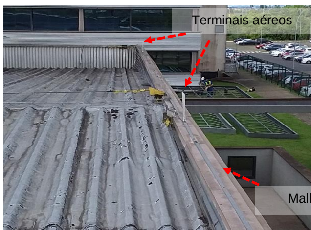
Figuras 595 e 596: sistema captor existente – Prédio 29 - Vestiário e Restaurante novo.
