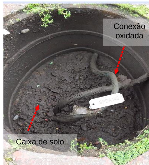
Figuras 301 e 302: Subsistema de aterramento – Não conformidades
