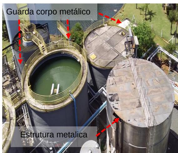
Figuras 750 e 751: sistema captor existente – ETA/ETE (Construções Gerais)
