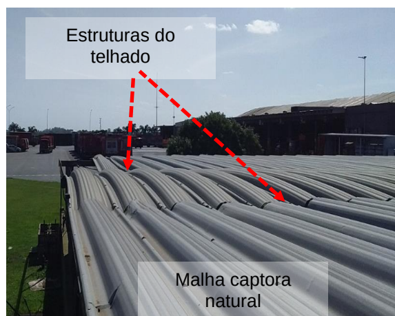
Figuras 222 e 223: sistema captor existente – Prédio 08 - Estacionamento Motos
