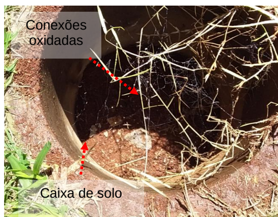
Figuras 429 e 430: Subsistema de aterramento – Não conformidades
