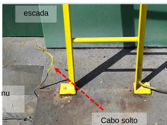
Figuras 564 e 565: Oxidação na interligação entre elementos metálicos e o sistema de captação // Cabo solto
