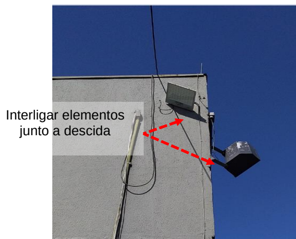
Figuras 217 e 218 : Elementos metálicos não interligados ao SPDA
