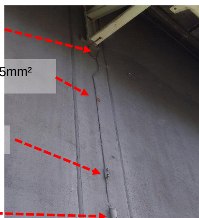
Figuras 544 e 545: Sistema de Descidas convencionais – Cabo de cobre nu #35mm²
