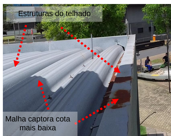
Figuras 135 e 136: Sistema captor existente – Prédio 05 – Conferencia.
