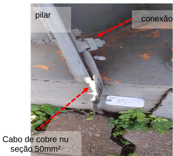
Figuras 228 e 229: Interligação entre elementos metálicos e a malha de aterramento.
