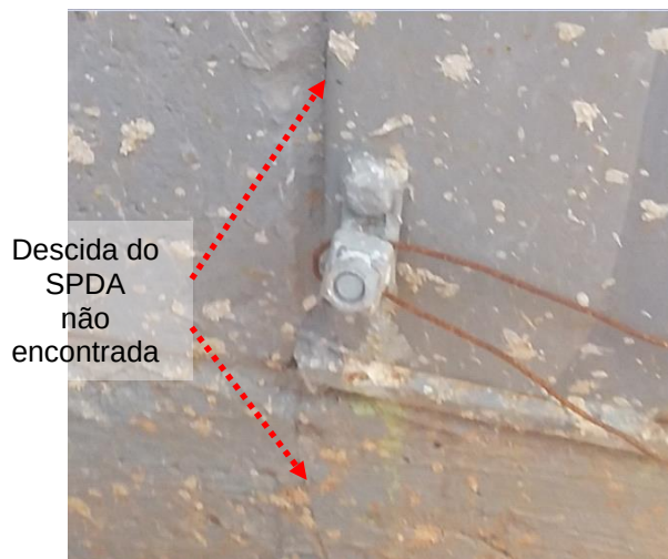
Figuras 386 e 387: Sistema de Descidas – Não encontradas
