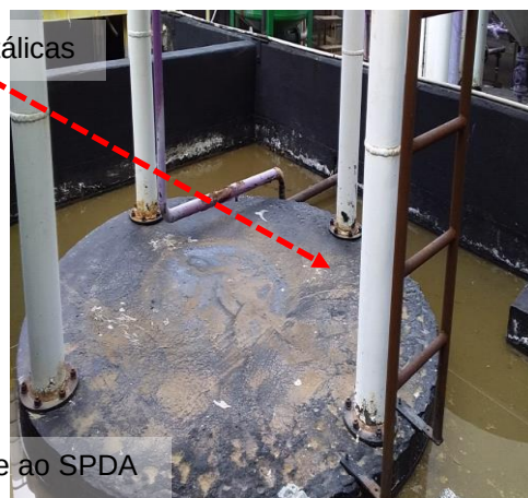
Figuras 497 e 498: Elementos metálicos nesta área não interligados ao SPDA.
