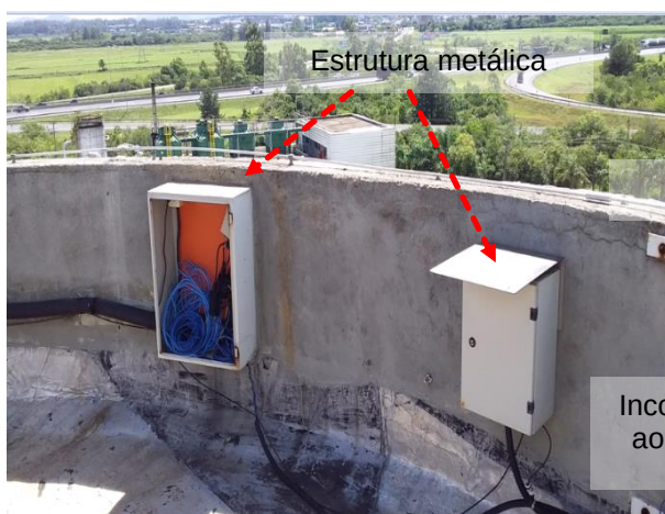
Figuras 816 e 817: Elementos metálicos não interligados ao SPDA
