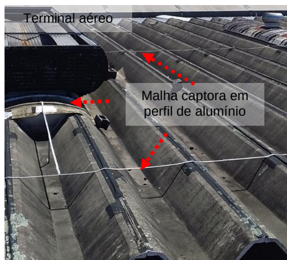
Figuras 154 e 155: sistema captor existente – Prédio 06 - Almojarifado
