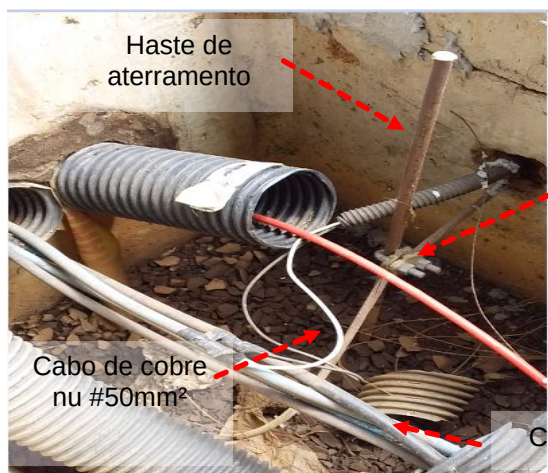
Figuras 676 e 677: Caixas de inspeção de solo encontradas
