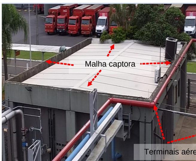
Figuras 308 e 309: sistema captor existente - Prédio 11-Laboratório ETA
