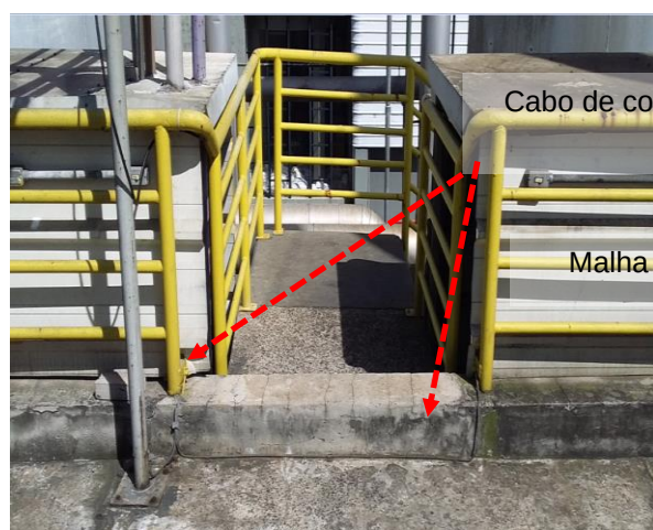
Figuras 538 e 539: sistema captor existente – Prédio 28 - Utilidades
