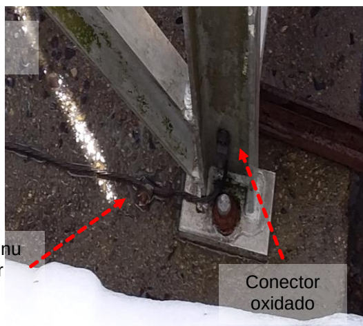
Figuras 869 e 870: Interligação entre o sistema de aterramento com a estrutura oxidado
