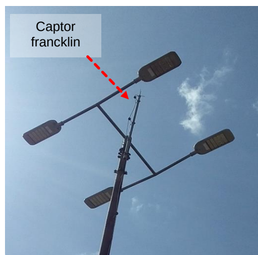
Figuras 904 e 905: Sistema captor existente - Áreas diversas
