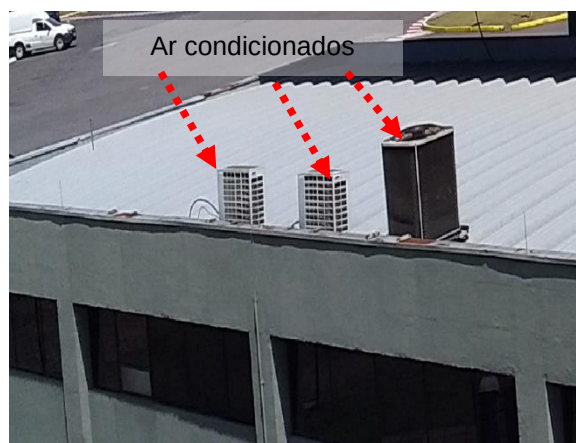
Figuras 150 e 151: Elementos metálicos não interligados ao SPDA – Cobertura.
