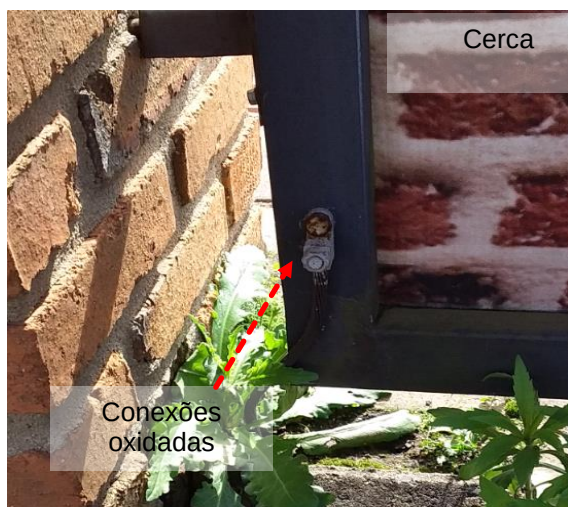
Figuras 735 e 736: Subsistema de aterramento – Não conformidades
