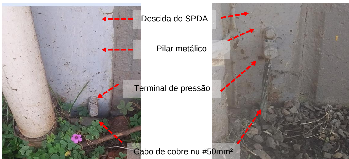
Figuras 510 e 511 : Sistema de Descidas Naturais – Pilares metálicos
