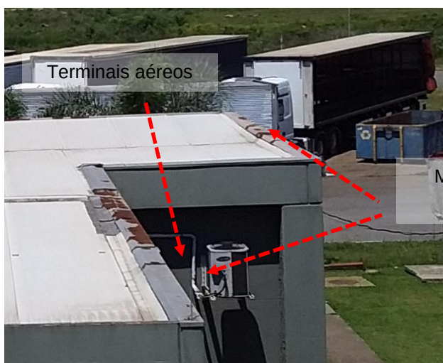
Figuras 249 e 250: sistema captor existente – Prédio 09 – Estac. Motos/Escritório
