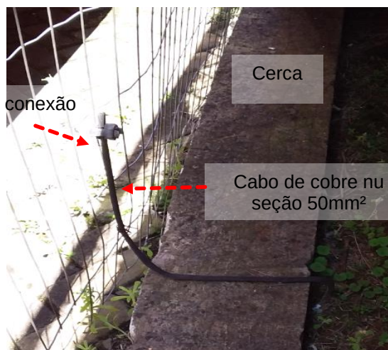
Figuras 445 e 446: Interligação entre elementos metálicos e a malha de aterramento.
