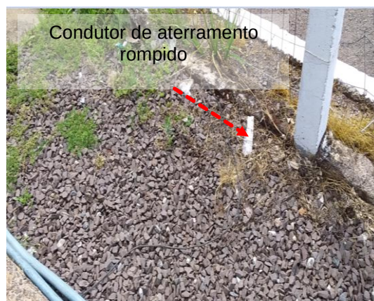
Figuras 857 e 858: Condutor de aterramento esta fragilizado na conexão com portão metálico /// Condutor de aterramento esta rompido
