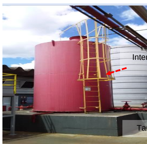
Figuras 495 e 496: Elementos metálicos nesta área não interligados ao SPDA.
