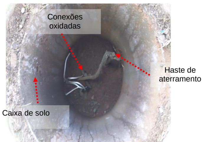
Figuras 431 e 432: Subsistema de aterramento – Não conformidades
