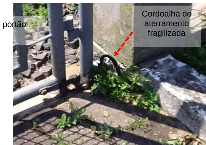
Figuras 472 e 473: Subsistema de aterramento – Não conformidades
