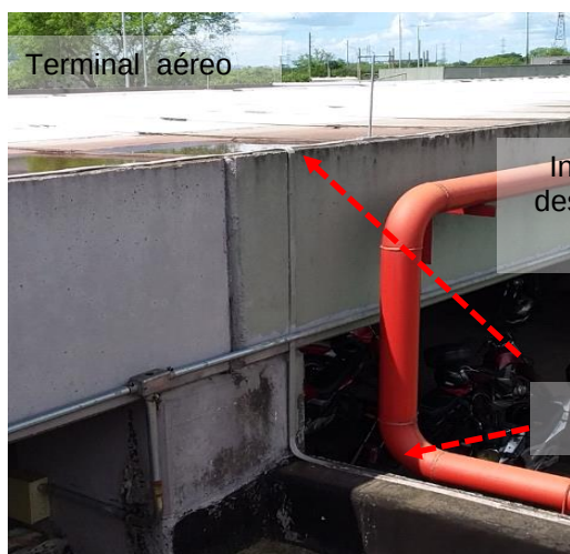
Figuras 243 e 244: sistema captor existente – Prédio 09 – Estac. Motos/Escritório
