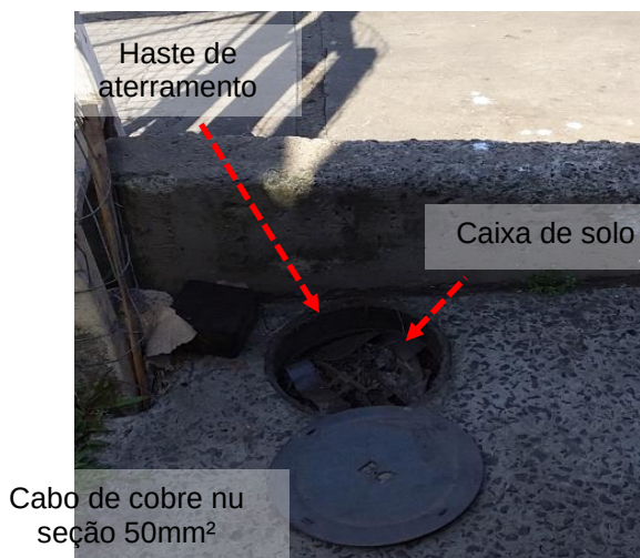
Figuras 205 e 206: Caixa de inspeção de solo // Interligação entre elementos metálicos e a malha de aterramento.
