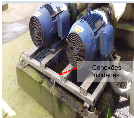
Figuras 582 e 583: Subsistema de aterramento – Não conformidades
