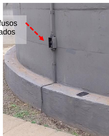
Figuras 790 e 791: Subsistema de descidas – Não conformidades encontradas
