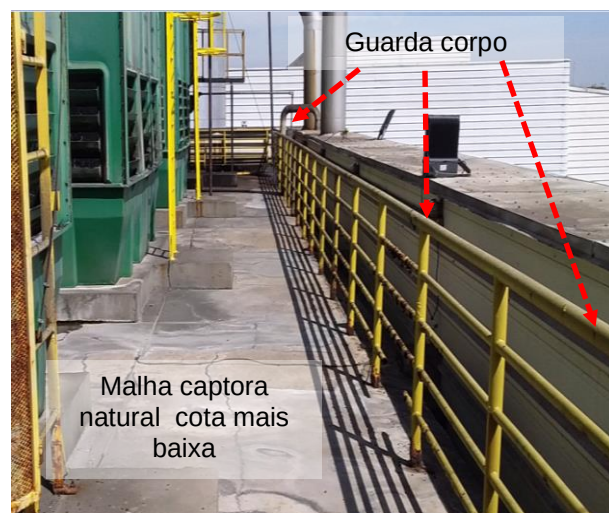
Figuras 526 e 527: sistema captor existente – Prédio 28 - Utilidades
