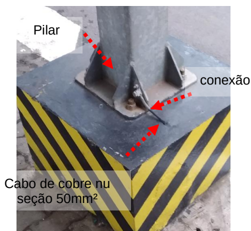
Figuras 123 e 124: Interligação entre elementos metálicos e a malha de aterramento.
