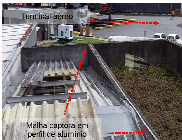
Figuras 325 e 326: Sistema captor existente – Prédio 13 –SEMT/Banco
