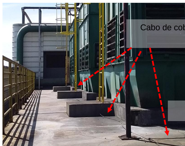
Figuras 534 e 535: sistema captor existente – Prédio 28 - Utilidades
