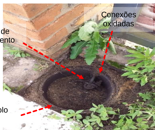
Figuras 729 e 730: Subsistema de aterramento – Não conformidades
