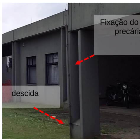
Figuras 259 e 260: Substância de descidas – Não conformidades
