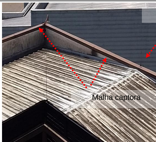
Figuras 393 e 394: sistema captor existente – Prédio 20 -Administrativo
