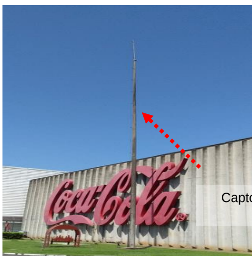
Figuras 44 e 45: Sistema Captor - Captadores tipo Franklin em poste de alvenaria
