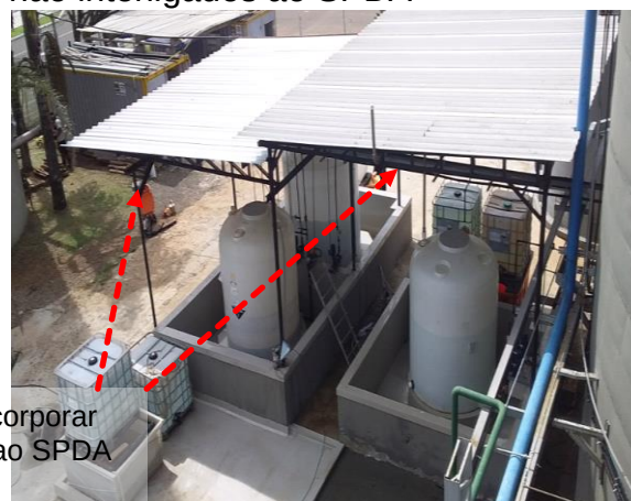
Figuras 818 e 819: Elementos metálicos não interligados ao SPDA
