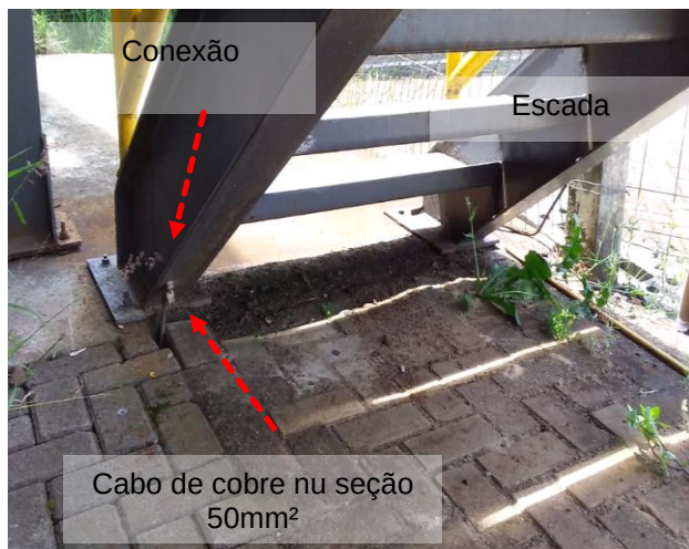
Figuras 443 e 444: Interligação entre elementos metálicos e a malha de aterramento.
