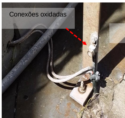
Figuras 810 e 811: Subsistema de aterramento – Não conformidades
