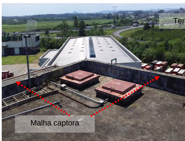
Figuras 407 e 408: sistema captor existente – Prédio 20 -Administrativo
