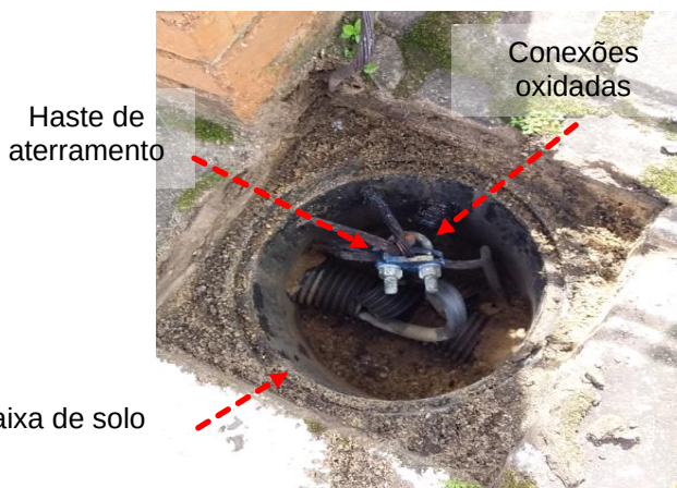
Figuras 723 e 724: Subsistema de aterramento – Não conformidades
