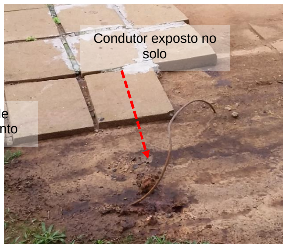
Figuras 491 e 492: Subsistema de aterramento – Não conformidades
