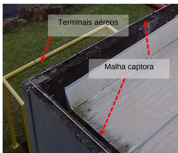
Figuras 657 e 658: sistema captor existente – Prédio 14 – Casa de Bombas
