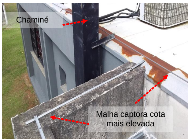
Figuras 327 e 328: Sistema captor existente – Prédio 13 –SEMT/Banco
