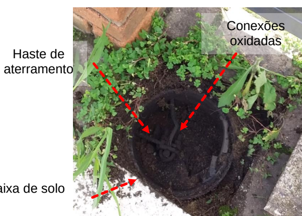
Figuras 725 e 726: Subsistema de aterramento – Não conformidades
