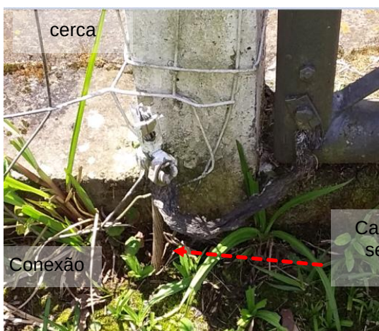
Figuras 839 e 840: Subsistema de aterramento - Prédio 27 – Abastecimento de GLP
