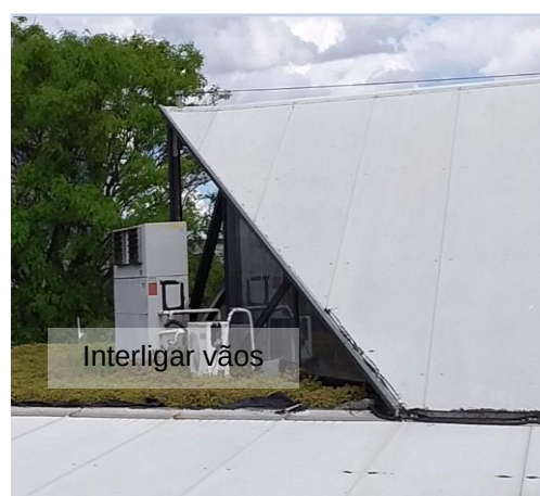
Figuras 359 e 360: Elementos metálicos não interligados ao SPDA
