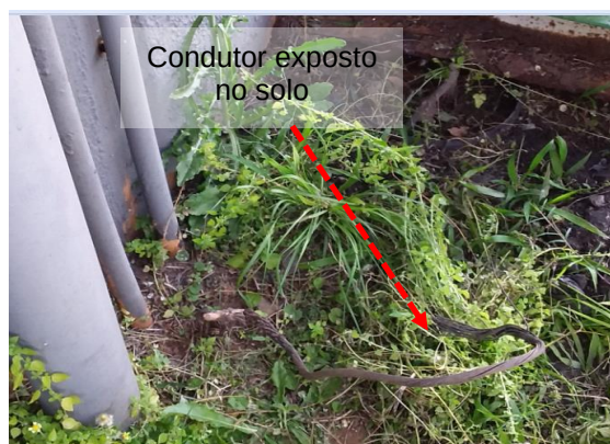
Figuras 574 e 575: Subsistema de aterramento – Não conformidades
