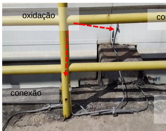
Figuras 560 e 561: Oxidação na interligação entre elementos metálicos e o sistema de captação.
