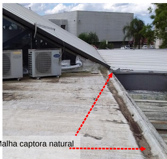
Figuras 331 e 332: Sistema captor existente – Prédio 13 –SEMT/Banco
