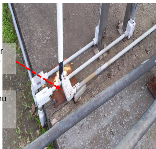
Figuras 873 e 874: Interligação entre o sistema de aterramento com a estrutura oxidado
