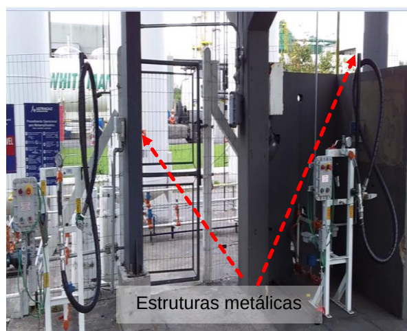
Figuras 875 e 876: Elementos metálicos não interligados ao SPDA (Pilares metálicos).
