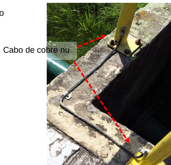
Figuras 880 e 881: Sistema Captor existente - Prédio 30 – Captação de Água
