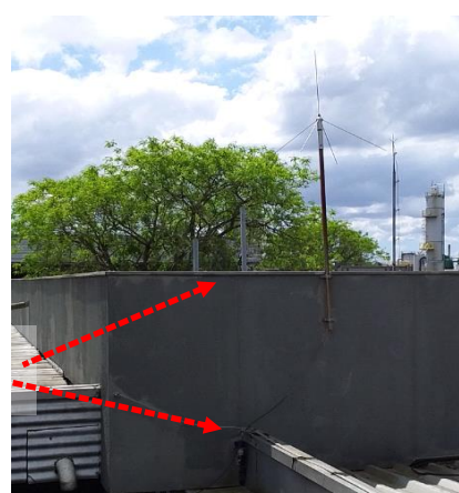
Figuras 289 e 290 : Sistema captor existente – Prédio 11 ( Recepção)
