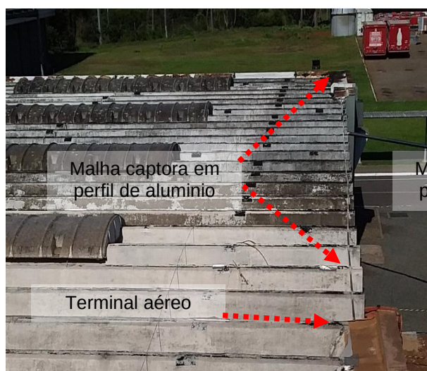
Figuras 109 e 110: sistema captor existente – Prédio 04 - Máquinas Auxiliares
