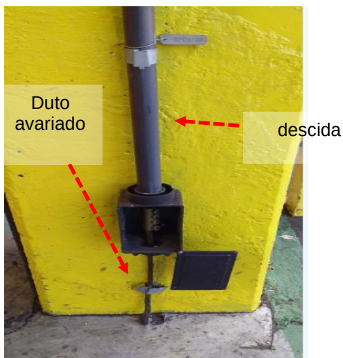
Figuras 180 e 181: Descidas – Não conformidades
