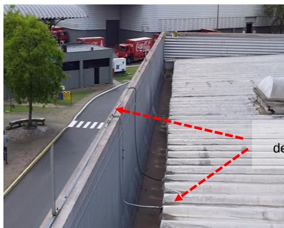
Figuras 601 e 602: sistema captor existente – Prédio 29 - Vestiário e Restaurante novo.
