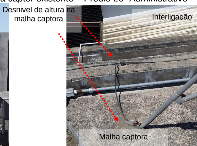
Figuras 413 e 414: sistema captor existente – Prédio 20 -Administrativo
