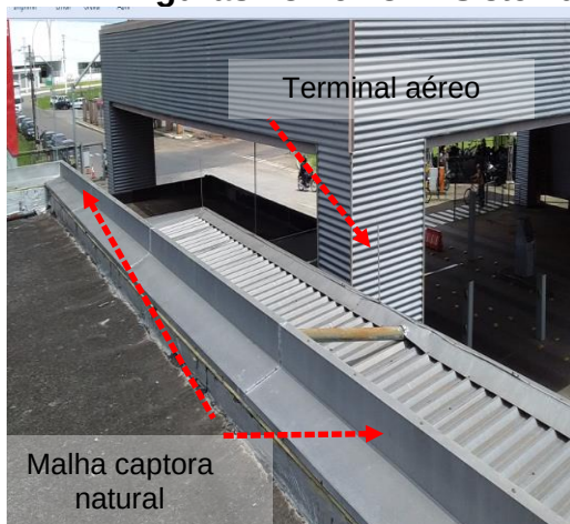
Figuras 283 e 284 : Sistema captor existente – Prédio 11 ( Recepção)
