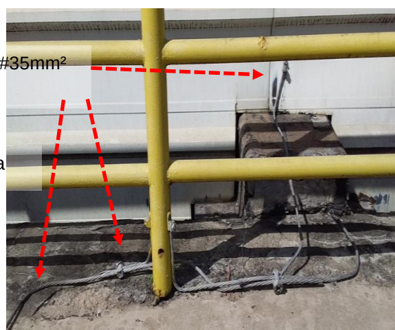
Figuras 538 e 539: sistema captor existente – Prédio 28 - Utilidades
