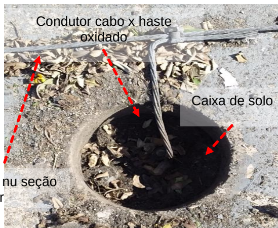
Figuras 863 e 864: Conector cabo x haste obstruído /// oxidado /// Conductor de aterramento com seção inferior ao estipulado pela norma
