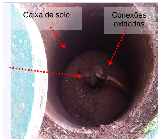
Figuras 431 e 432: Subsistema de aterramento – Não conformidades
