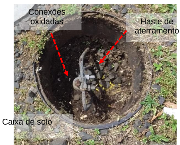
Figuras 578 e 579: Subsistema de aterramento – Não conformidades
