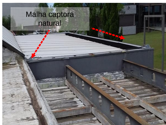
Figuras 333 e 334: Sistema captor existente – Prédio 13 –SEMT/Banco
