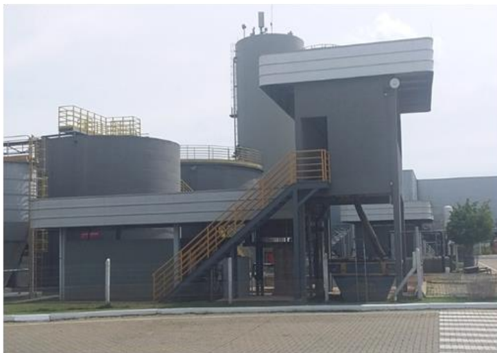
Figura 501: Prédio 26 – Prensa de Lodo
