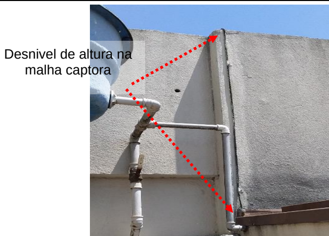
Figuras 411 e 412: sistema captor existente – Prédio 20 -Administrativo
