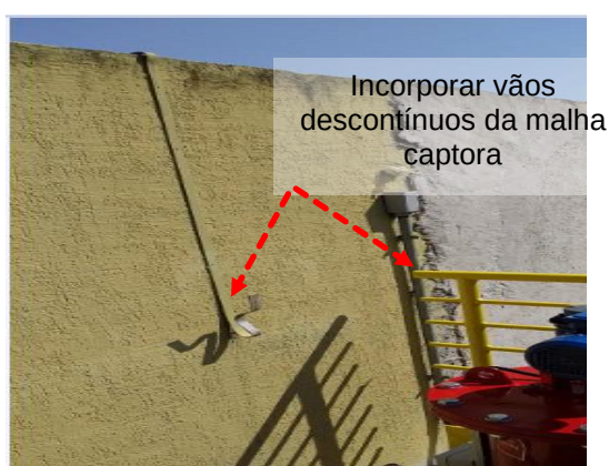
Figuras 886 e 887: Sistema Captor existente - Prédio 30 – Captação de Água
