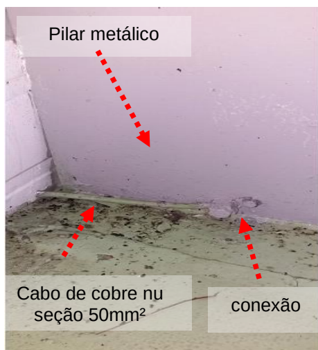
Figuras 11 e 12: Interligação elemento metálico através de cabo de cobre nu #50mm 2
