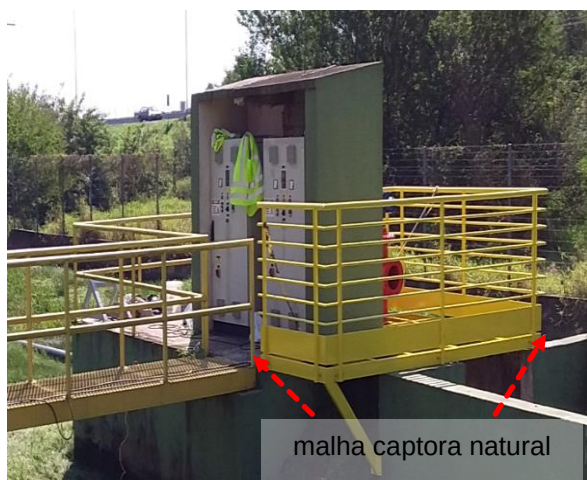
Figuras 888 e 889: Sistema Captor existente - Prédio 30 -Captação de Água -Guarda-corpo
