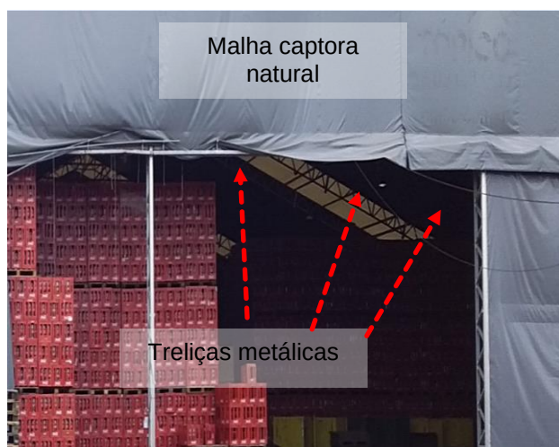
Figuras 668 e 669: sistema captor existente – Prédio 31A –Operações Logísticas
