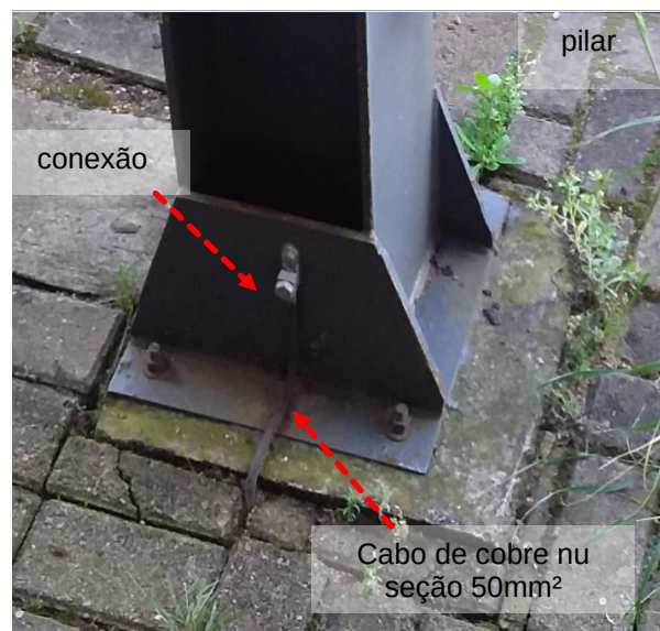
Figuras 441 e 442: Caixa de inspeção de solo // Interligação entre elementos metálicos e a malha de aterramento.
