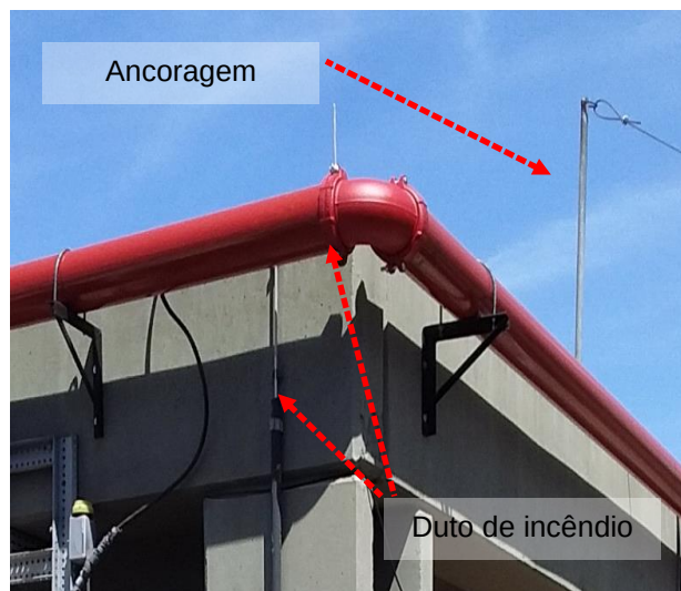
Figuras 320 e 321: Elementos metálicos não interligados ao SPDA
