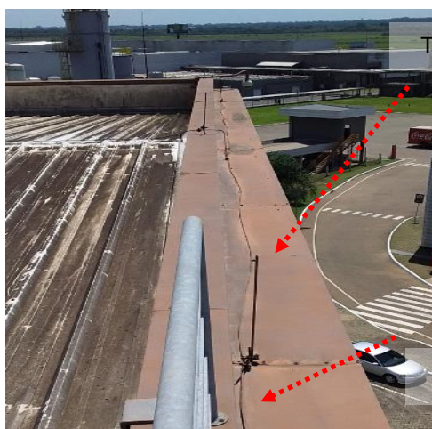
Figuras 395 e 396: sistema captor existente – Prédio 20 -Administrativo
