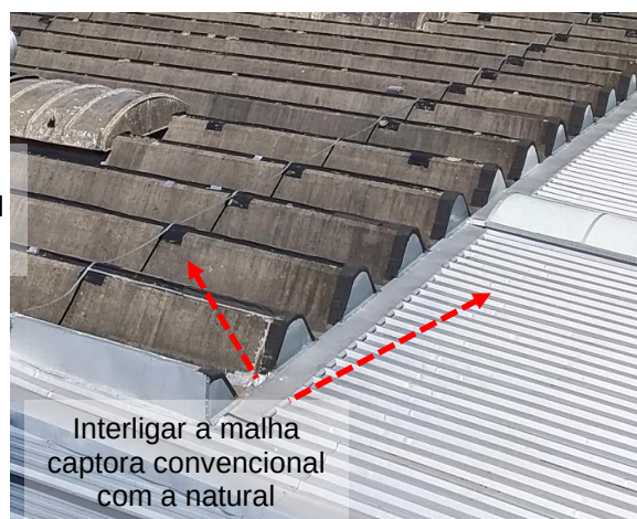
Figuras 186 e 187: Elementos metálicos não interligados ao SPDA
