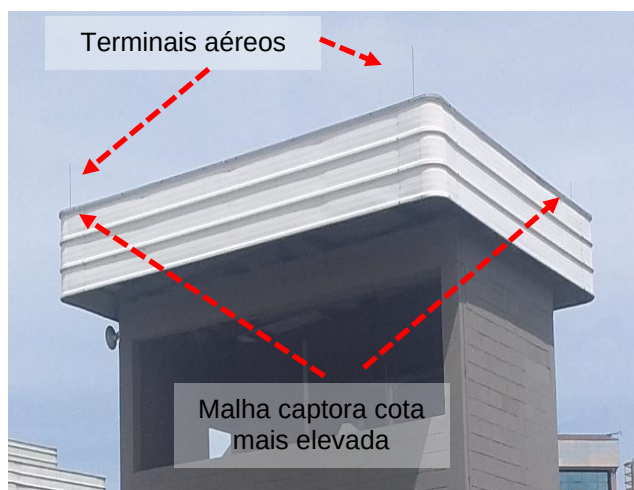
Figuras 502 e 503: sistema captor existente – Prédio 26 – Prensa de Lodo
