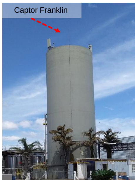
Figuras 740 e 741 : sistema captor existente – ETA/ETE (Construções Gerais)
