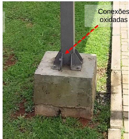
Figuras 623 e 624: Subsistema de aterramento – Não conformidades
