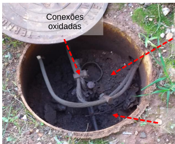
Figuras 798 e 799: Substância de aterramento – Não conformidades
