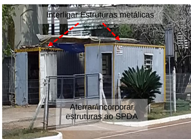
Figuras 824 e 825: Elementos metálicos não interligados ao SPDA
