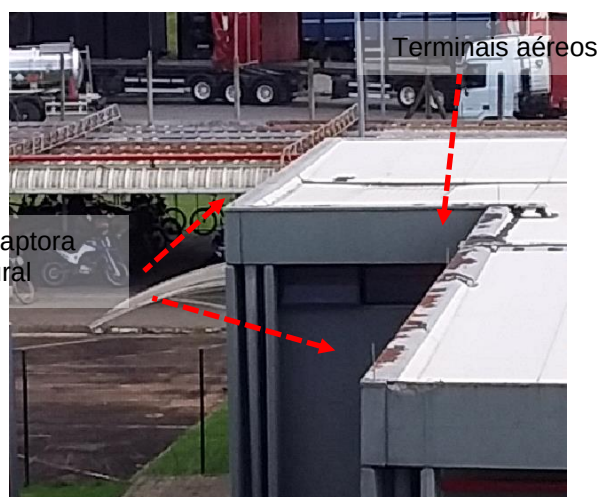
Figuras 249 e 250: sistema captor existente – Prédio 09 – Estac. Motos/Escritório
