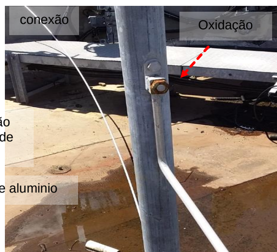
Figuras 780 e 781: Oxidação nas conexões entre o sistema de captação
