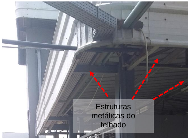
Figuras 506 e 507 : sistema captor existente – Prédio 26 – Prensa de Lodo
