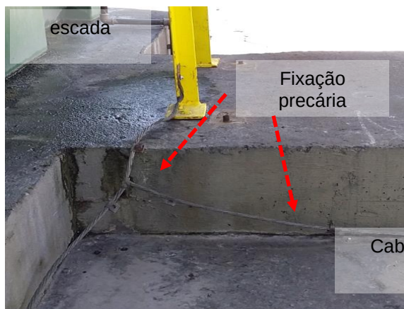
Figuras 566 e 567: Oxidação na interligação entre elementos metálicos e o sistema de captação // Cabo solto
