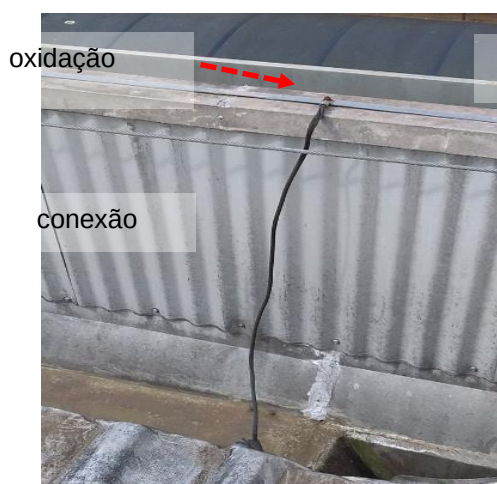
Figuras 613 e 614: Oxidação nas conexões entre o sistema de captação e descidas.
