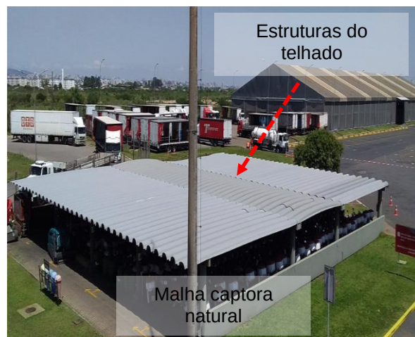
Figuras 220 e 221: sistema captor existente – Prédio 08 - Estacionamento Motos
