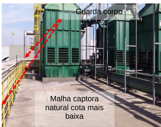
Figuras 524 e 525: sistema captor existente – Prédio 28 - Utilidades
