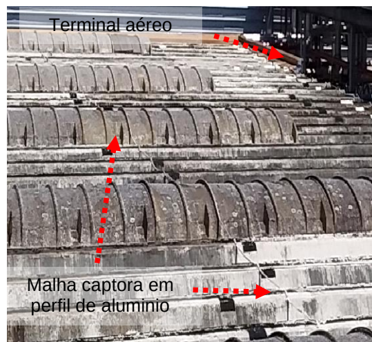
Figuras 111 e 112: sistema captor existente – Prédio 04 - Máquinas Auxiliares
