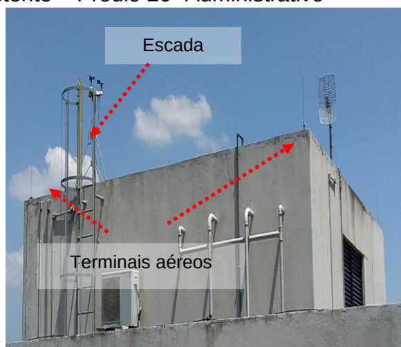
Figuras 419 e 420: sistema captor existente – Prédio 20 -Administrativo
