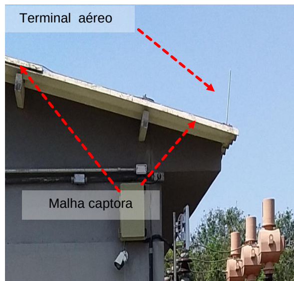
Figuras 456 e 457: sistema captor existente - Prédio 23 – Subestação 69 KV
