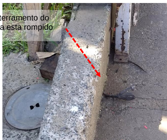
Figuras 213 e 214: Subsistema de aterramento – Não conformidades
