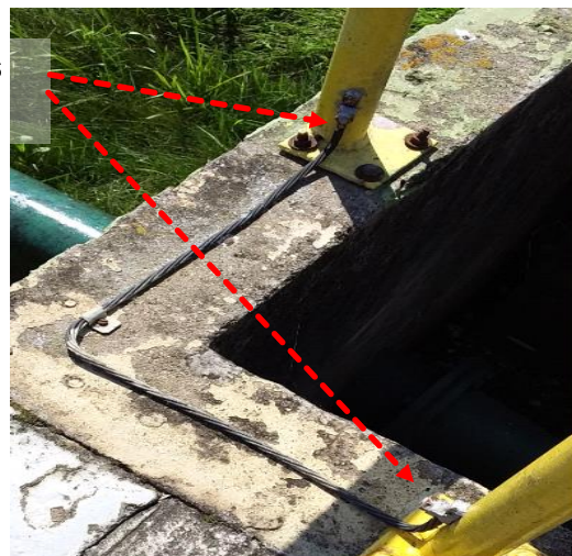
Figuras 897 e 898: Sistema de descidas –Não conformidades
