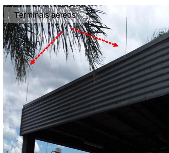
Figuras 271 e 272: sistema captor existente – Prédio 10 (Portaria)
