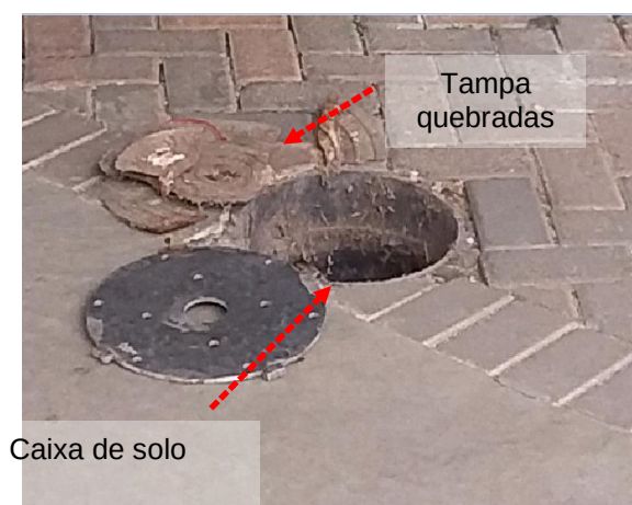
Figuras 299 e 300: Subsistema de aterramento – Não conformidades
