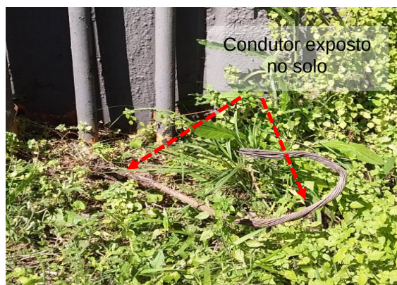
Figuras 574 e 575: Subsistema de aterramento – Não conformidades
