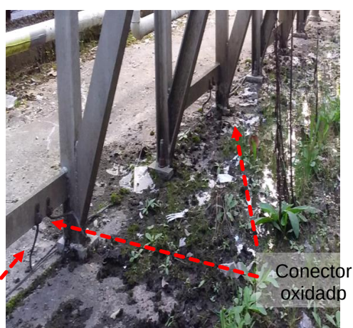
Figuras 867 e 868: Interligação entre o sistema de aterramento com a estrutura oxidado
