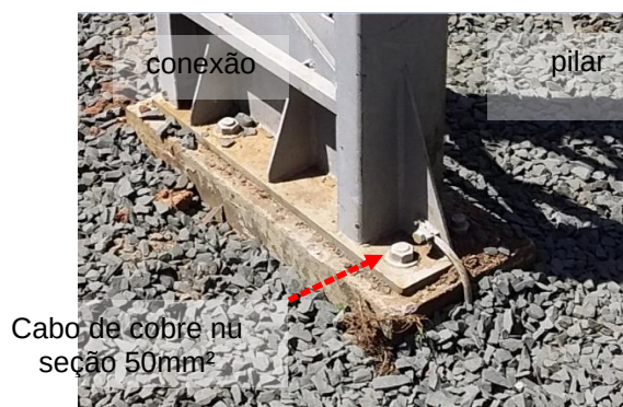
Figura 314: Interligação entre elementos metálicos e a malha de aterramento.
