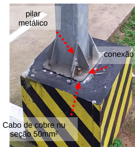
Figuras 94 e 95: Interligação elemento metálico através de cabo de cobre nu #50mm 2
