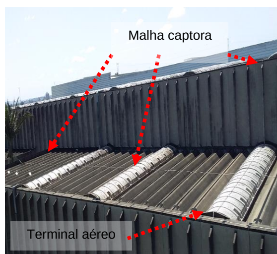
Figuras 48 e 49: Sistema Captor - Malha captora em perfil de alumínio secção #75mm 2 .
