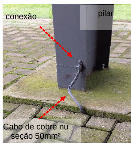
Figuras 345 e 346: Interligação entre elementos metálicos e a malha de aterramento.
