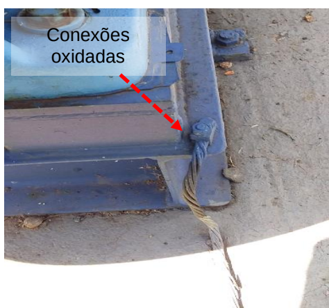
Figuras 580 e 581: Subsistema de aterramento – Não conformidades
