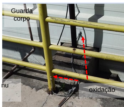
Figuras 566 e 567: Oxidação na interligação entre elementos metálicos e o sistema de captação // Cabo solto
