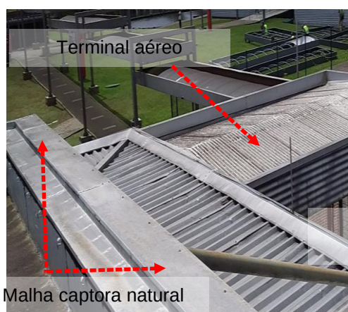
Figuras 289 e 290 : Sistema captor existente – Prédio 11 ( Recepção)
