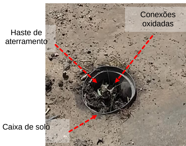
Figuras 727 e 728: Subsistema de aterramento – Não conformidades
