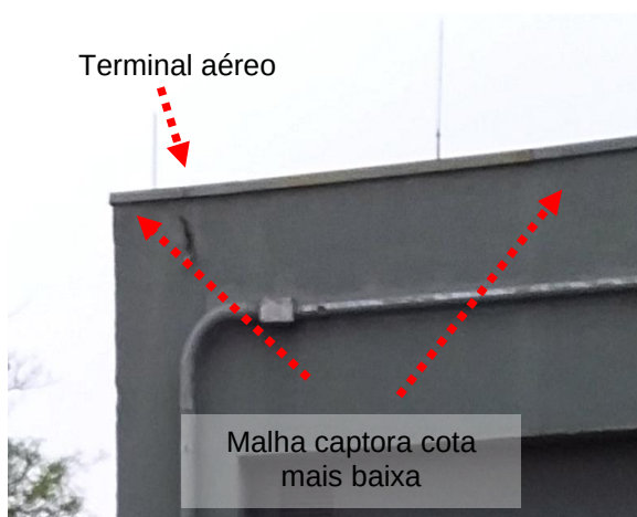
Figuras 133 e 134: Sistema captor existente – Prédio 05 – Conferencia.
