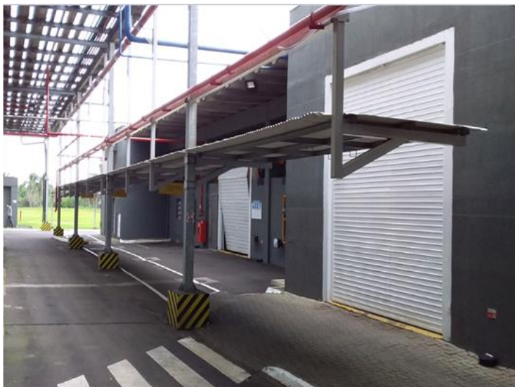
Figura 108: Prédio 04 - Máquinas Auxiliares
