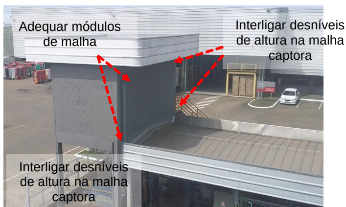
Figuras 508 e 509 : sistema captor existente – Prédio 26 – Prensa de Lodo
