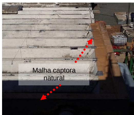
Figuras 113 e 114: sistema captor existente – Prédio 04 - Máquinas Auxiliares
