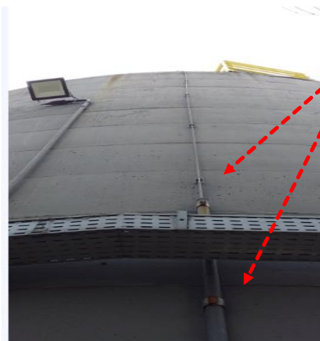
Figuras 782 e 783: Subsistema de descidas – Não conformidades encontradas
