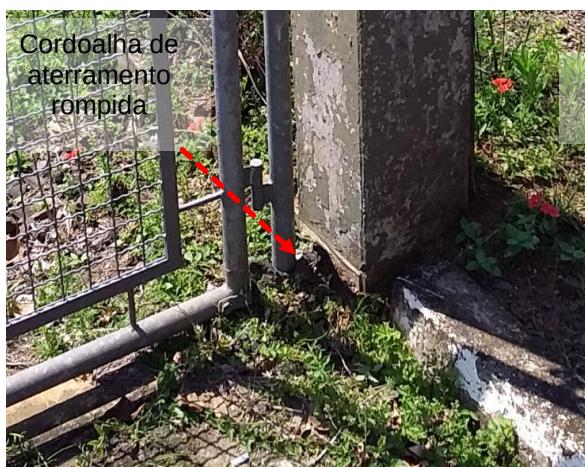
Figuras 472 e 473: Subsistema de aterramento – Não conformidades
