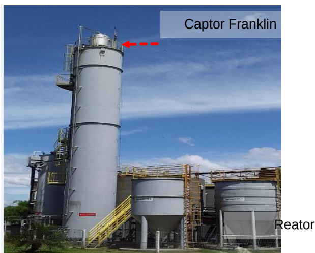
Figuras 752 e 753 : sistema captor existente – ETA/ETE (Construções Gerais)
