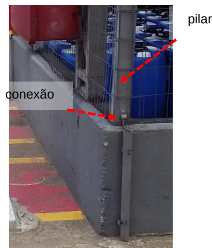
Figuras 487 e 488: Caixa de inspeção de solo // Interligação entre elementos metálicos e a malha de aterramento.
