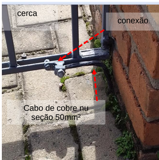
Figuras 715 e 716: Interligação entre elementos metálicos e a malha de aterramento
