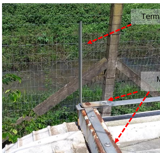
Figuras 641 e 642: sistema captor existente – Prédio 32- Quiosque entrega refrigerante.
