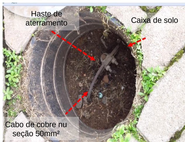
Figuras 257 e 258: Caixa de inspeção de solo // Interligação entre elementos metálicos e a malha de aterramento.
