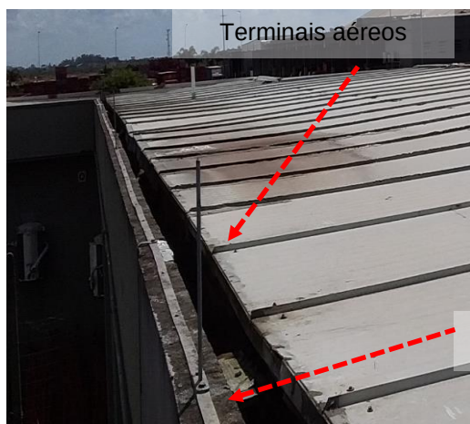
Figuras 241 e 242: sistema captor existente – Prédio 09 – Estac. Motos/Escritório
