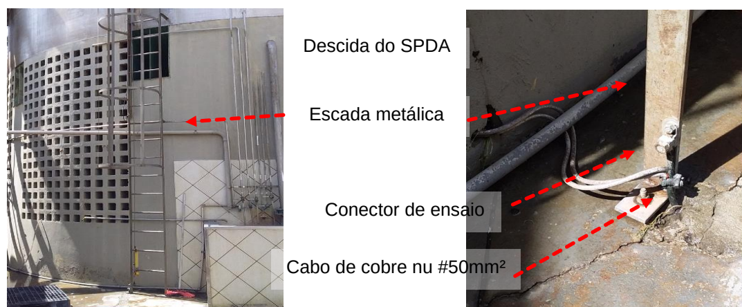
Figuras 760 e 761: Sistema de Descidas Naturais – Escada de acesso
