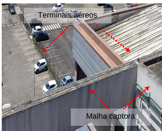
Figuras 405 e 406: sistema captor existente – Prédio 20 -Administrativo
