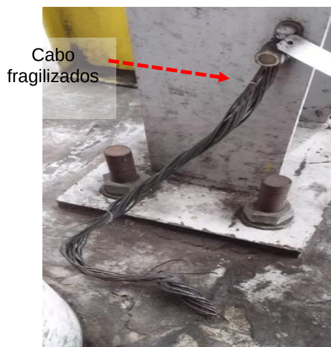
Figuras 180 e 181: Descidas – Não conformidades
