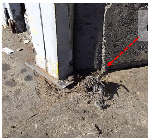
Figuras 213 e 214: Subsistema de aterramento – Não conformidades
