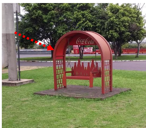
Figura 78: Estrutura não incorporada ao SPDA existente
