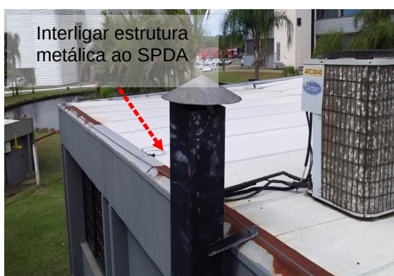
Figuras 353 e 354: Elementos metálicos não interligados ao SPDA
