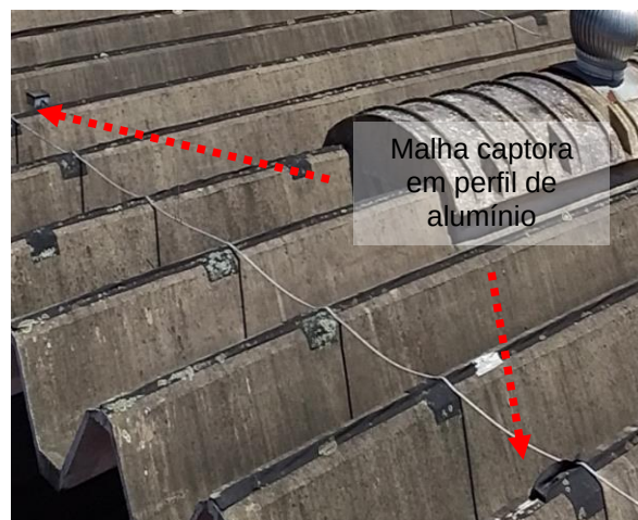
Figuras 158 e 159: sistema captor existente – Prédio 06 - Almojarifado
