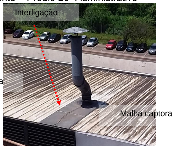
Figuras 415 e 416: sistema captor existente – Prédio 20 -Administrativo
