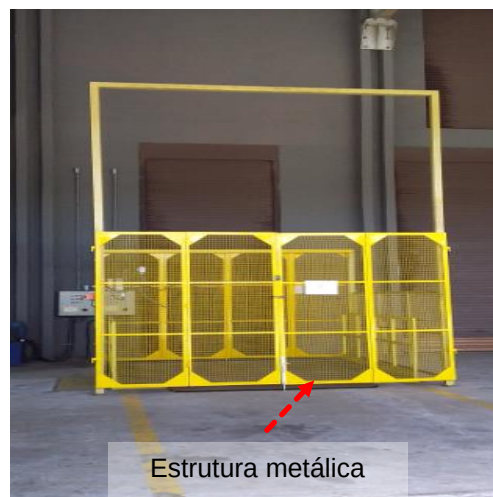
Figuras 451 e 452: Elementos metálicos não interligados ao SPDA
