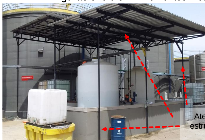
Figuras 818 e 819: Elementos metálicos não interligados ao SPDA
