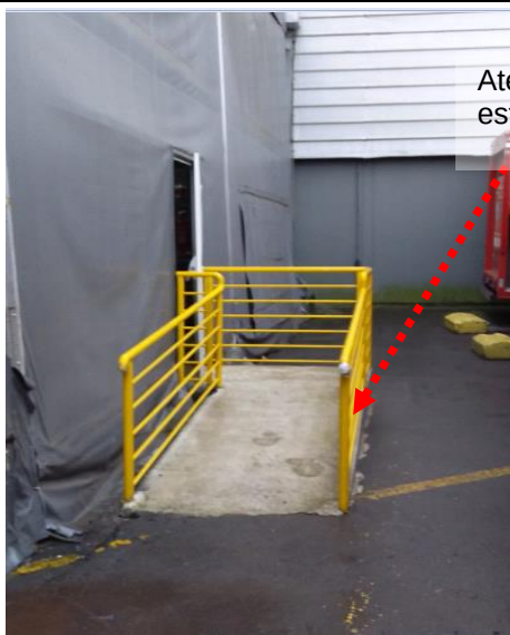
Figuras 40 e 41: Estruturas não incorporadas ao SPDA existente
