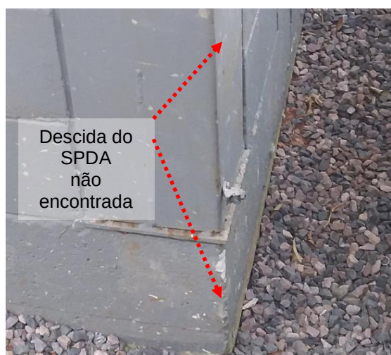
Figuras 386 e 387: Sistema de Descidas – Não encontradas
