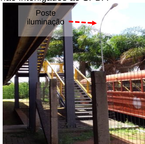
Figuras 453 e 454: Elementos metálicos não interligados ao SPDA
