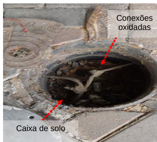
Figuras 299 e 300: Subsistema de aterramento – Não conformidades
