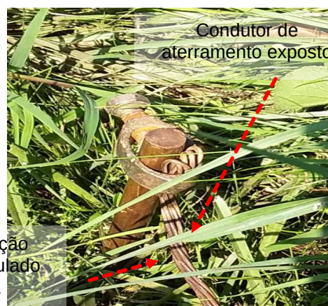
Figuras 892 e 893: Sistema de Aterramento –Não conformidades
