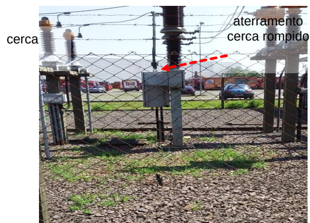
Figuras 474 e 475: Subsistema de aterramento – Não conformidades
