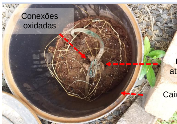
Figuras 617 e 618: Subsistema de aterramento – Não conformidades
