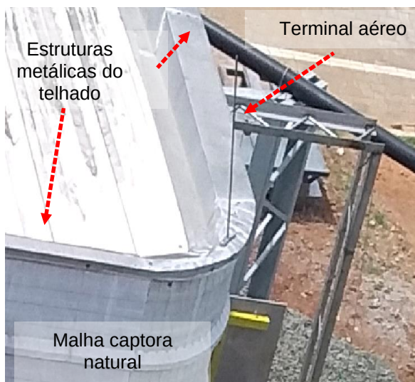
Figuras 380 e 381: Sistema captor existente – Central de Resíduos - Classe I
