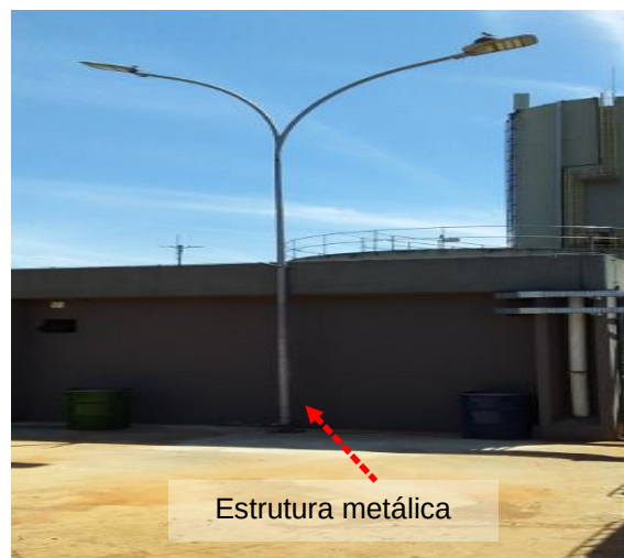
Figuras 318 e 319: Elementos metálicos não interligados ao SPDA
