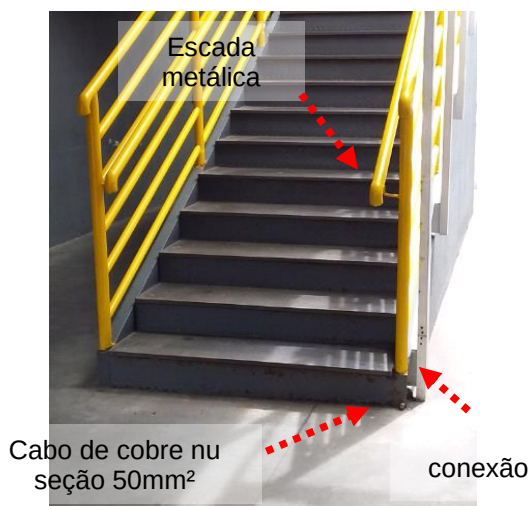
Figuras 11 e 12: Interligação elemento metálico através de cabo de cobre nu #50mm 2
