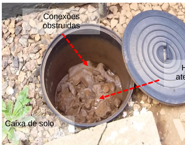
Figuras 491 e 492: Subsistema de aterramento – Não conformidades
