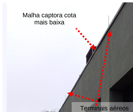
Figuras 133 e 134: Sistema captor existente – Prédio 05 – Conferencia.
