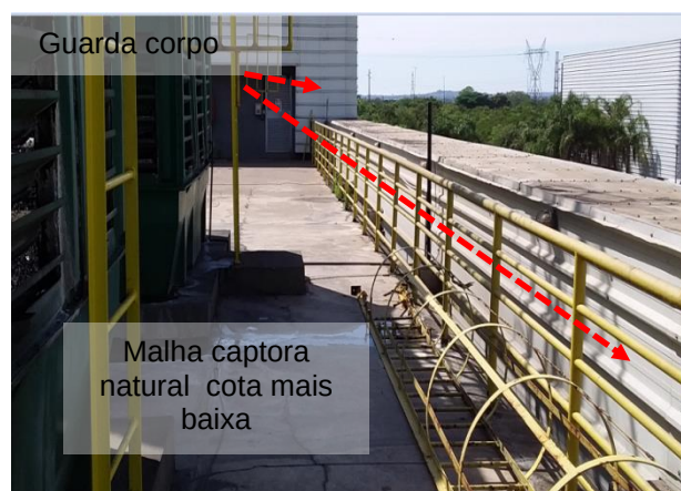
Figuras 524 e 525: sistema captor existente – Prédio 28 - Utilidades
