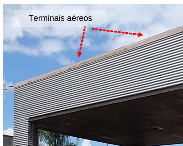
Figuras 273 e 274 : sistema captor existente – Prédio 10 (Portaria)
