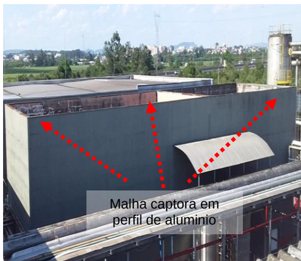
Figuras 82 e 83: sistema captor existente – Prédio 03 – Silo Açúcar
