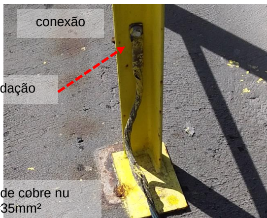
Figuras 562 e 563: Oxidação na interligação entre elementos metálicos e o sistema de captação.
