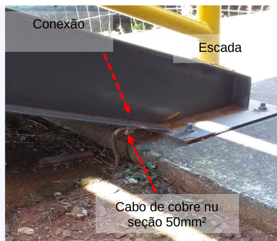
Figuras 445 e 446: Interligação entre elementos metálicos e a malha de aterramento.
