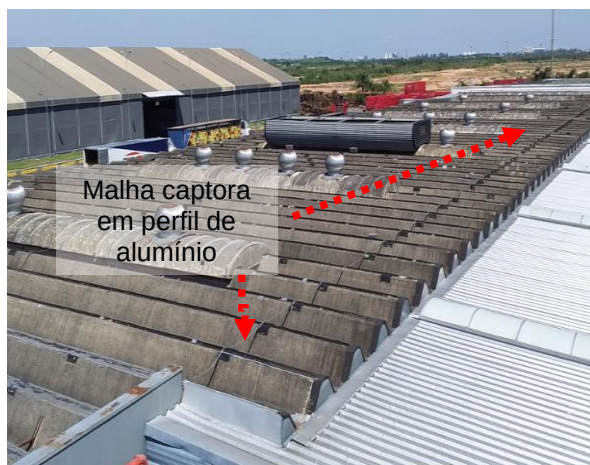
Figuras 160 e 161: sistema captor existente – Prédio 06 - Almojarifado
