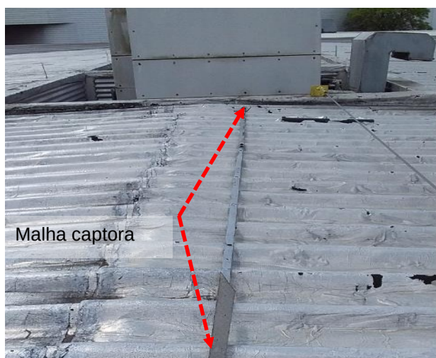
Figuras 599 e 600: sistema captor existente – Prédio 29 - Vestiário e Restaurante novo.
