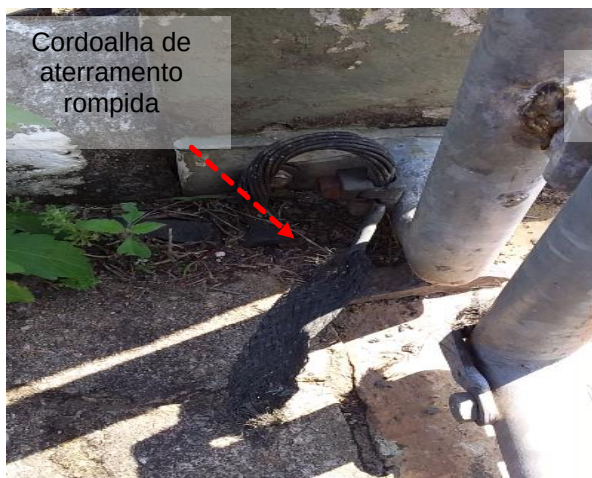
Figuras 470 e 471: Subsistema de aterramento – Não conformidades
