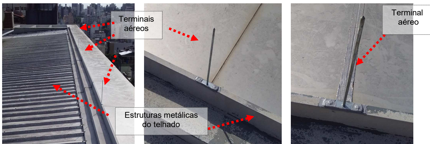
Figuras 21, 22 e 23: Implantação de terminais aéreos sobre a malha natural na cobertura.
