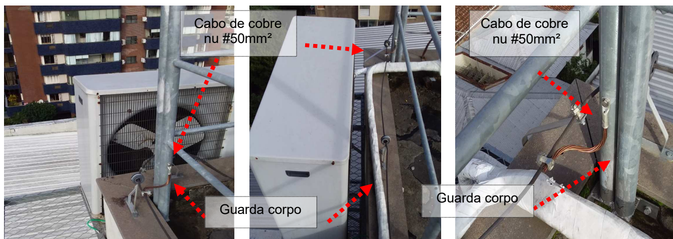
Figuras 30, 31 e 32: Interligação implantada em cabo de cobre nu #50mm² entre as estruturas metálicas (guarda corpo) e a malha captora existente na cobertura da edificação.
