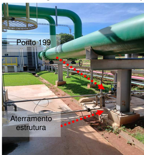
Figuras 145 e 146: Medição 223 – Aterramento estrutura pilar metálico – Chiller.
