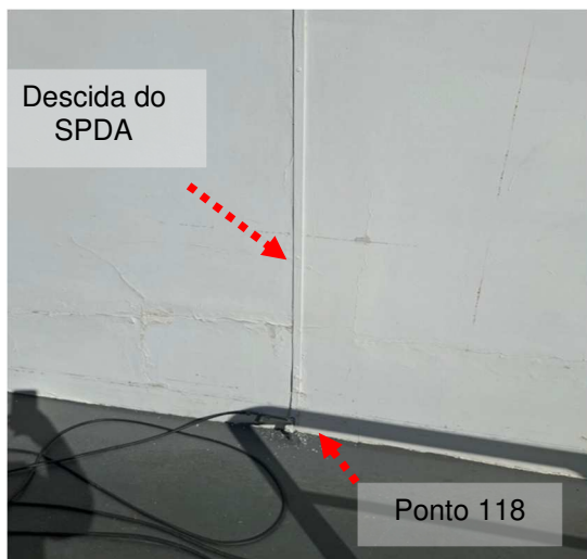
Figuras 101 e 102: Medição 140 – Descida do SPDA – Bloco 14.
