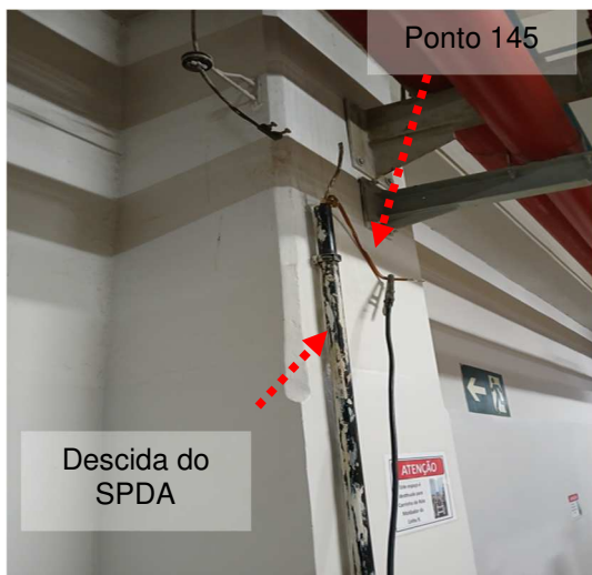
Figuras 119 e 120: Medição 178 – Descida do SPDA – Fábrica parte interna.
