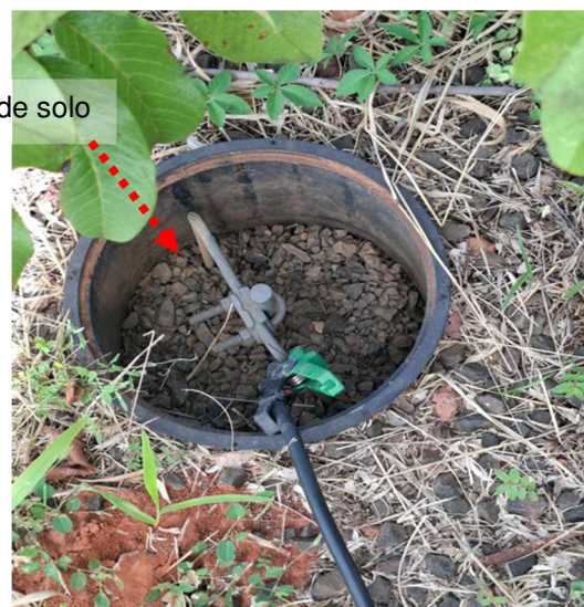
Figuras 27 e 28: Ponto 47 - Caixa de solo – GLP.
