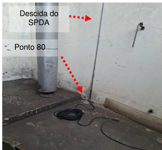
Figuras 77 e 78: Medição 86 – Descida do SPDA – Caldeiras.
