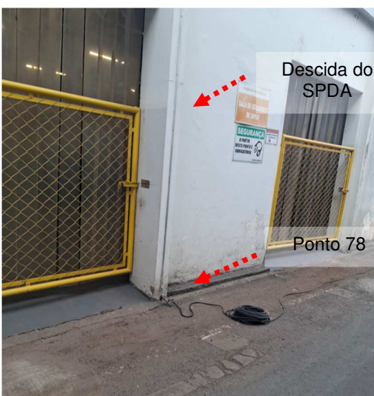
Figuras 75 e 76: Medição 84 – Descida do SPDA – Caldeiras.
