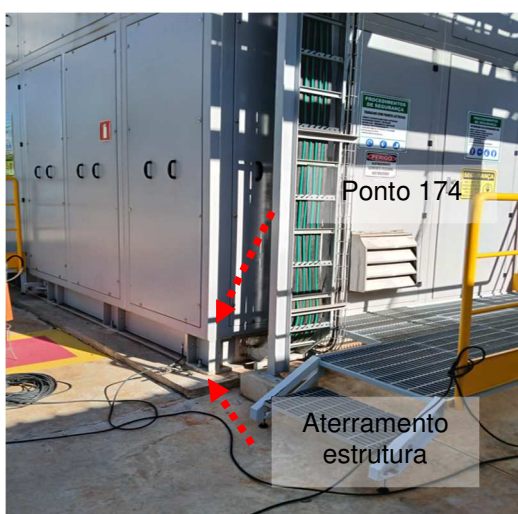
Figuras 135 e 136: Medição 206 – Aterramento estrutura base contêiner – Chiller.
