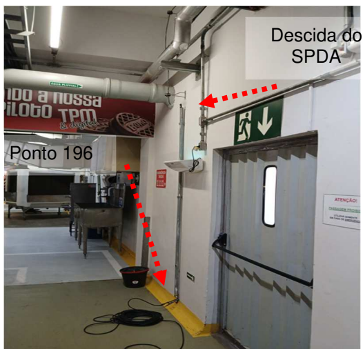
Figuras 121 e 122: Medição 180 – Descida do SPDA – Fábrica parte interna.
