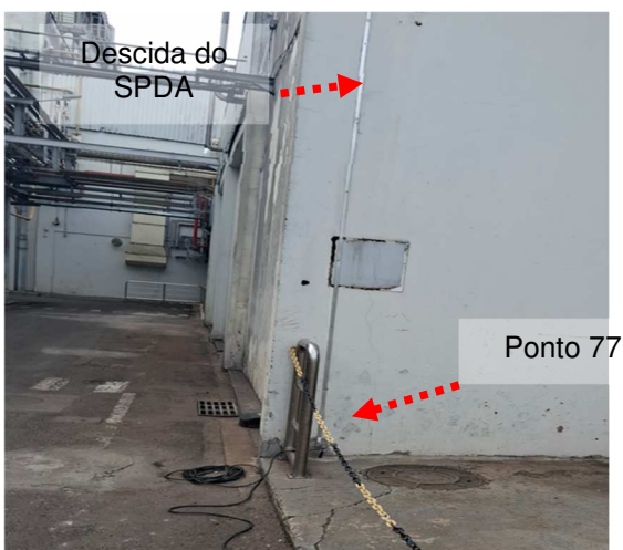
Figuras 73 e 74: Medição 83 – Descida do SPDA – Caldeiras.
