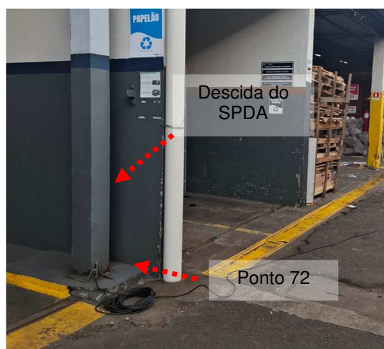
Figuras 67 e 68: Medição 77 – Descida do SPDA – Lavagem de peças.
