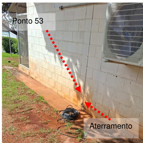
Figuras 35 e 36: Medição 53 – Aterramento do SPDA – Depósito de óleo e tinta.
