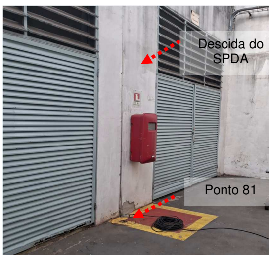
Figuras 79 e 80: Medição 87 – Descida do SPDA – Casa 440 V.
