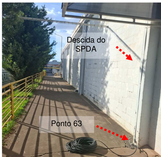
Figuras 53 e 54: Medição 64 – Descida do SPDA – Almojarifado e depósito de máquinas.
