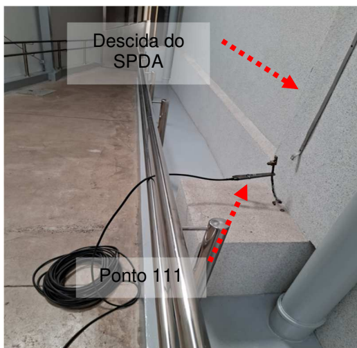
Figuras 95 e 96: Medição 125 – Descida do SPDA – Bloco 14.
