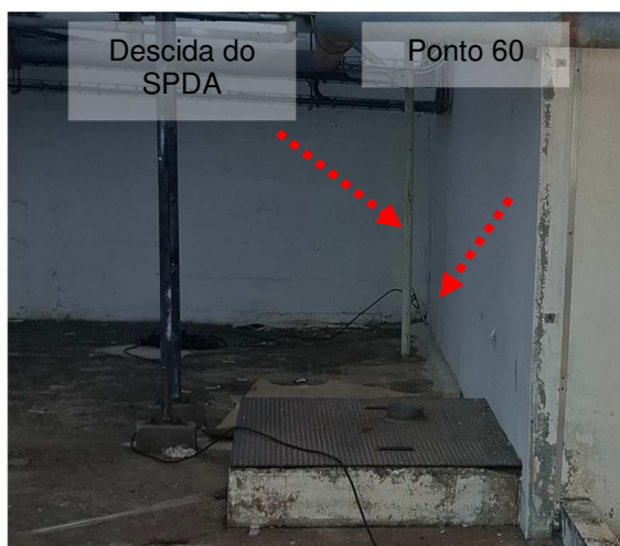
Figuras 49 e 50: Medição 61 – Descida do SPDA – Reservatório/Casa de bombas.
