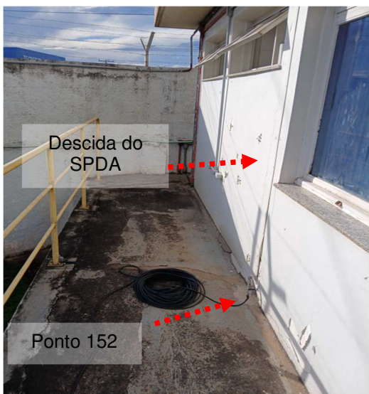
Figuras 123 e 124: Medição 186 – Descida do SPDA – Portaria 02.
