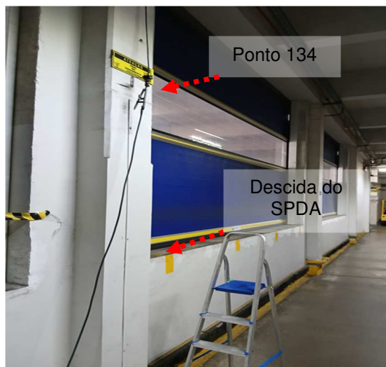
Figuras 113 e 114: Medição 168 – Descida do SPDA – Fábrica.
