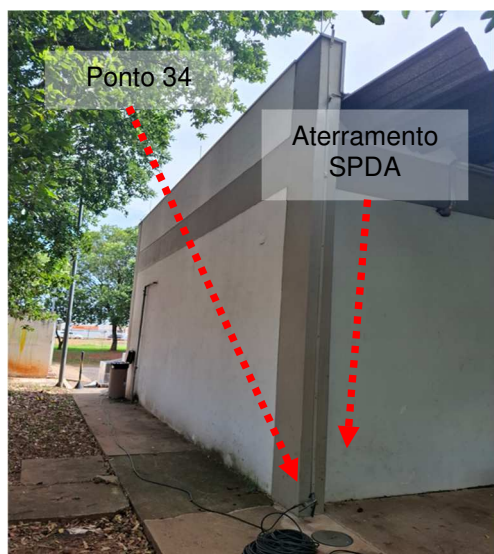
Figuras 15 e 16: Medição 34 – Aterramento do SPDA – PTARA.
