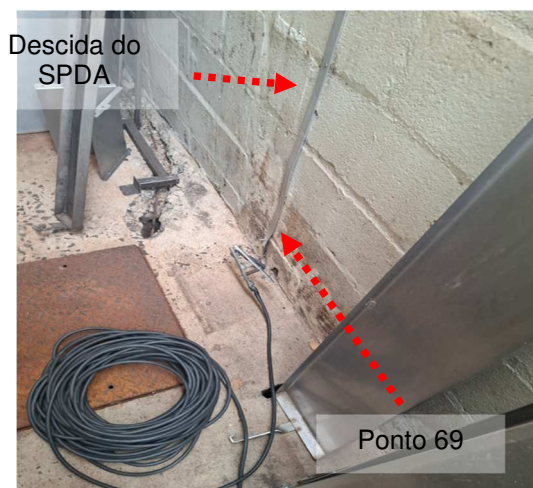
Figuras 61 e 62: Medição 72 – Descida do SPDA – Manutenção /Oficina Empilhadeira.
