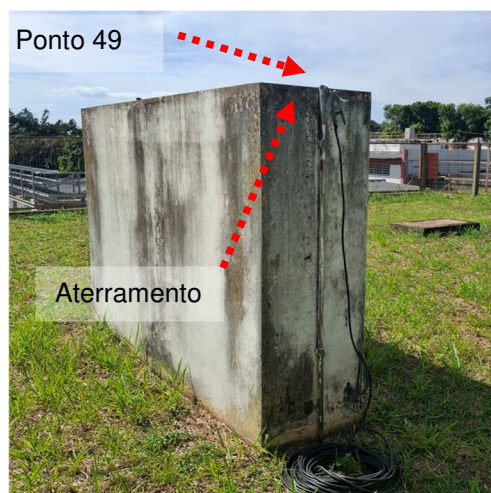
Figuras 31 e 32: Medição 50 – Aterramento do SPDA – PTAR.
