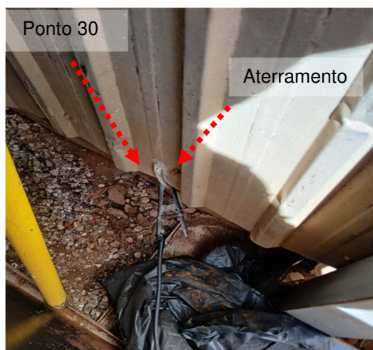
Figuras 13 e 14: Medição 30 – Aterramento do SPDA – Galpões novos.
