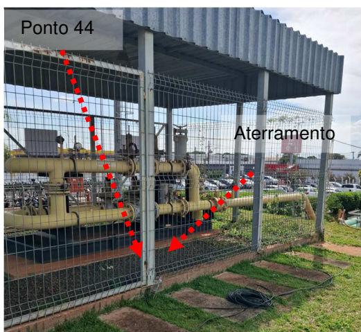
Figuras 25 e 26: Medição 45 – Aterramento do SPDA – GNV.
