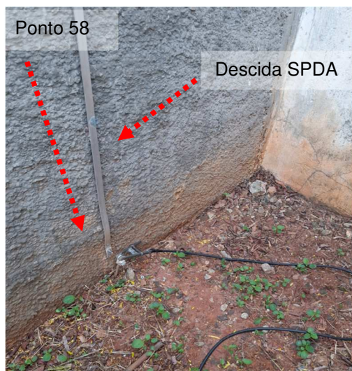
Figuras 43 e 44: Medição 58 – Descida do SPDA – Reservatório/Caixa d'água.
