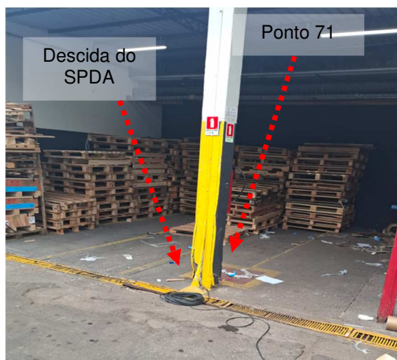
Figuras 65 e 66: Medição 76 – Descida do SPDA – Resíduos e reciclagem.
