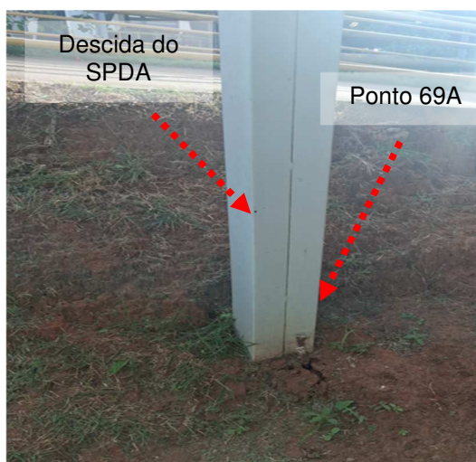
Figuras 57 e 58: Medição 73 – Descida do SPDA – Manutenção /Oficina Empilhadeira.
