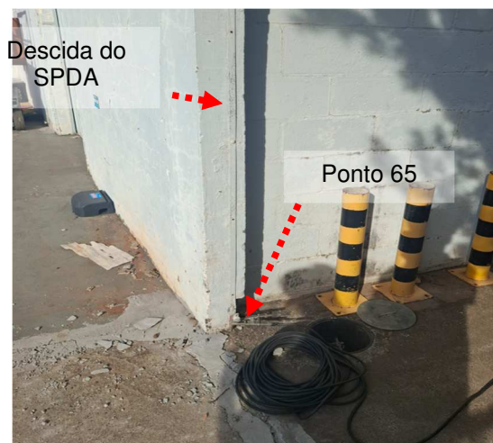
Figuras 55 e 56: Medição 66 – Descida do SPDA – Almojarifado e depósito de máquinas.
