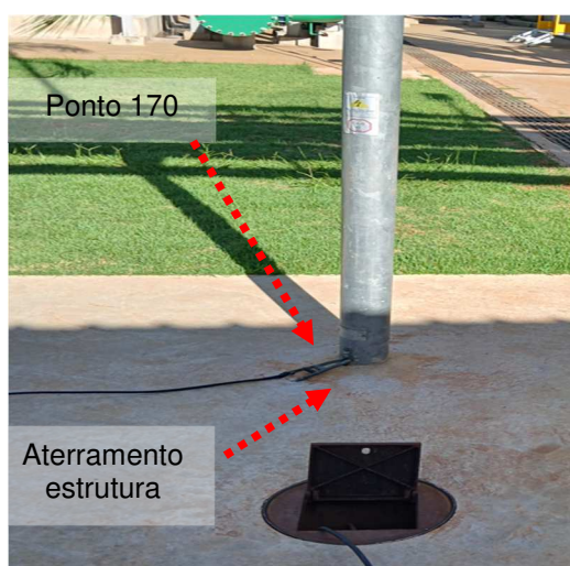
Figuras 147 e 148: Medição 202 – Aterramento estrutura pilar metálico – Chiller.
