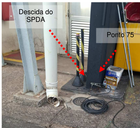
Figuras 71 e 72: Medição 80 – Descida do SPDA – Lavagem de peças.
