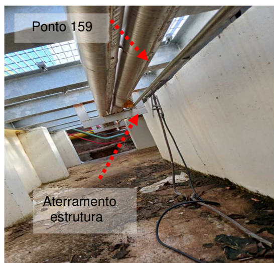
Figuras 129 e 130: Medição 149 – Aterramento estrutura base contêiner – Chiller.
