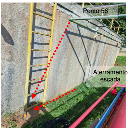
Figuras 39 e 40: Medição 56 – Aterramento escada – Reservatório/Caixa d'água.
