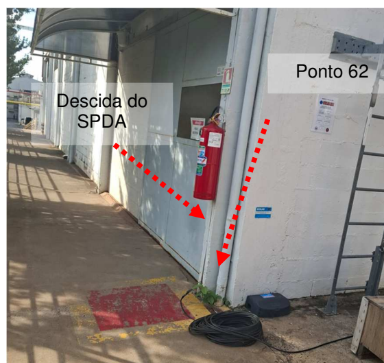
Figuras 51 e 52: Medição 63 – Descida do SPDA – Almojarifado e depósito de máquinas.
