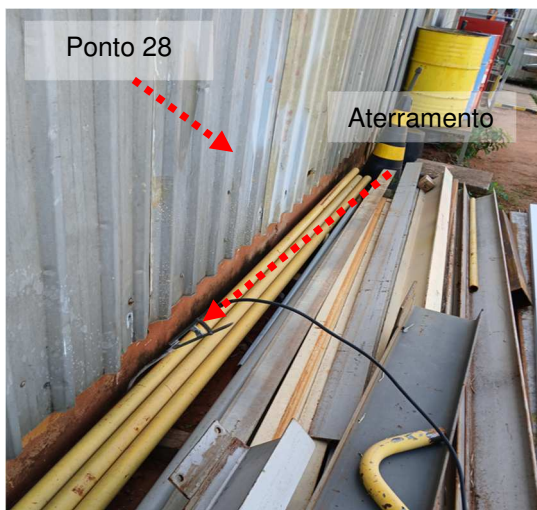
Figuras 11 e 12: Medição 28 – Aterramento do SPDA – Galpões novos.
