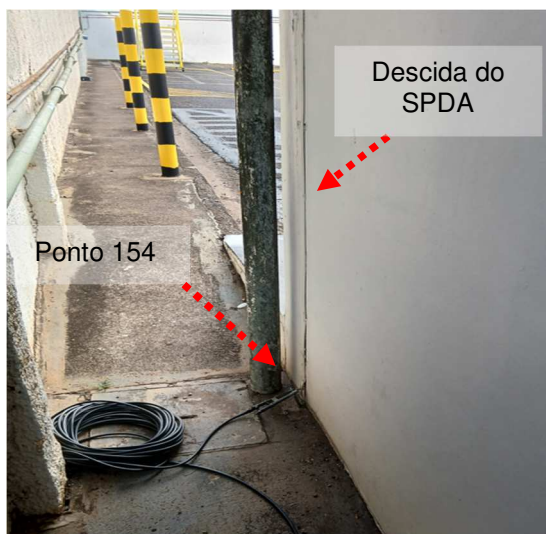
Figuras 125 e 126: Medição 188 – Descida do SPDA – Portaria 2.
