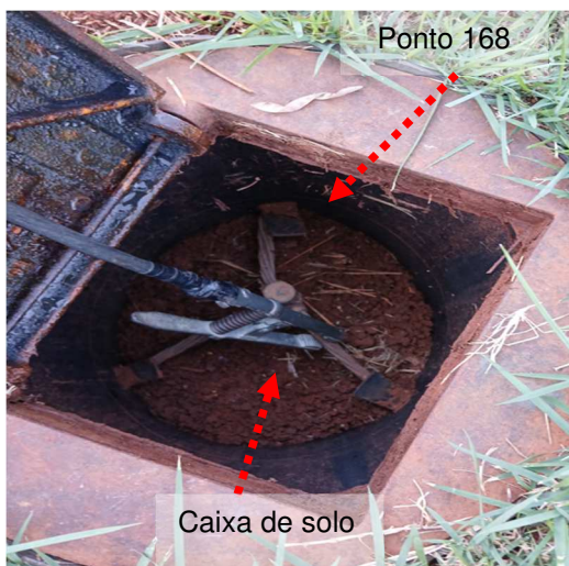
Figuras 133 e 134: Medição 200 – Caixa de solo – Chiller.
