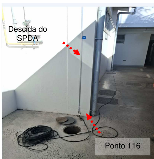
Figuras 99 e 100: Medição 138 – Descida do SPDA – Bloco 14.
