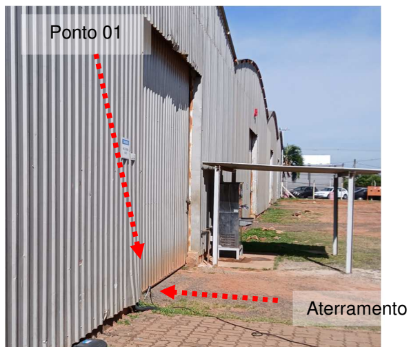
Figuras 05 e 06: Medição 01 – Aterramento do SPDA – Galpões novos.
