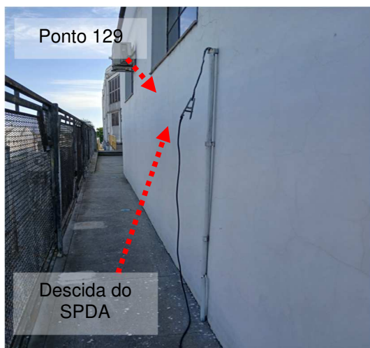
Figuras 109 e 110: Medição 160 – Descida do SPD – Fábrica.
