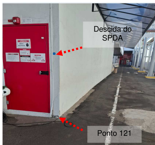
Figuras 103 e 104: Medição 144 – Descida do SPDA – Bloco 14.
