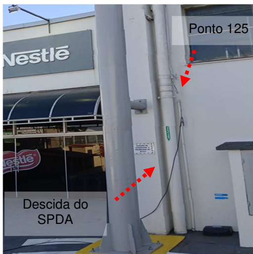
Figuras 107 e 108: Medição 156 – Descida do SPD – Fábrica.
