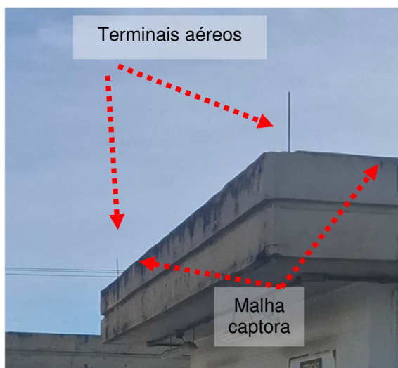
Figuras 348 e 349: Sistema captor existente -Vestiários
