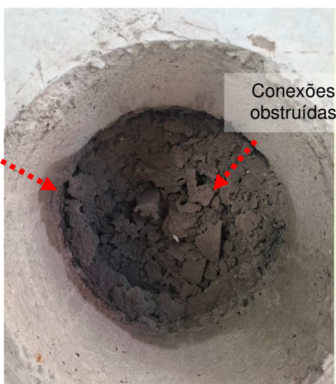
Figuras 216 e 217: Caixa de solo -Conexões obstruídas
