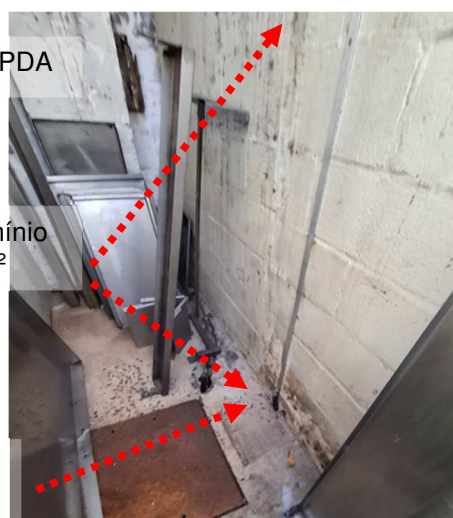
Figuras 248 e 249: Sistema de descidas existentes convencionais.
