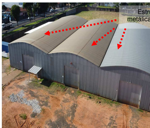
Figuras 591 e 592: Sistema captor natural existente / Galpões novos.
