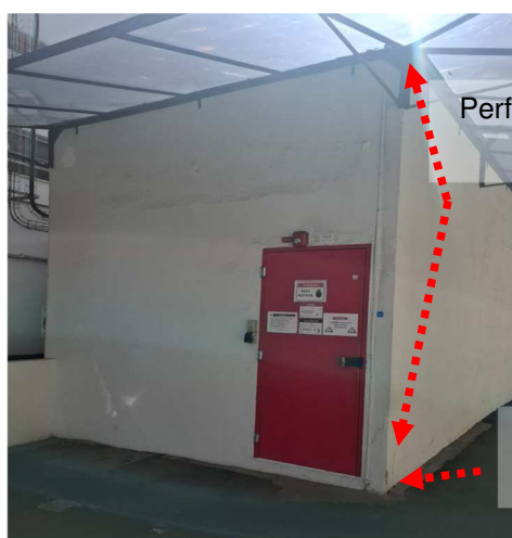
Figuras 192 e 193: Descida do SPDA em perfil de alumínio.
