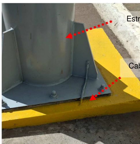
Figuras 136 e 137: Conexões entre a malha de terra e estruturas metálicas.
