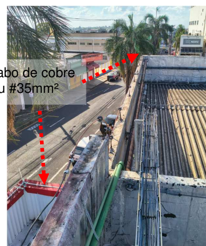
Figuras 176, 177 e 178: Sistema captor existente.
