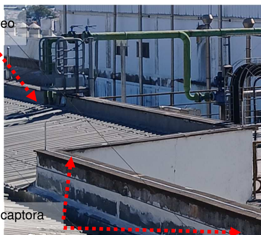
Figuras 412 e 413: Malha captora em perfil de alumínio secção #70mm 2 .
