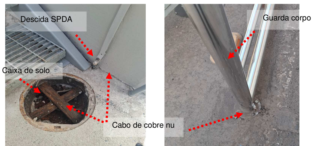
Figuras 206 e 207: Caixa de solo / Conexão estrutura.
