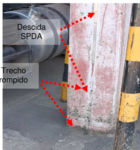
Figuras 142 e 143: Descida rompida com a malha de terra/ Conexão oxidada.
