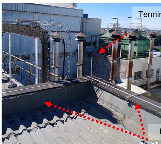
Figuras 412 e 413: Malha captora em perfil de alumínio secção #70mm 2 .
