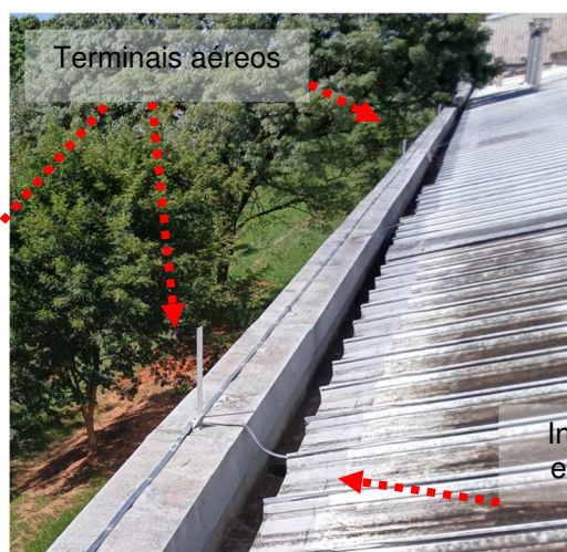
Figuras 502 e 503: Malha captora em perfil de alumínio secção #70mm 2 .
