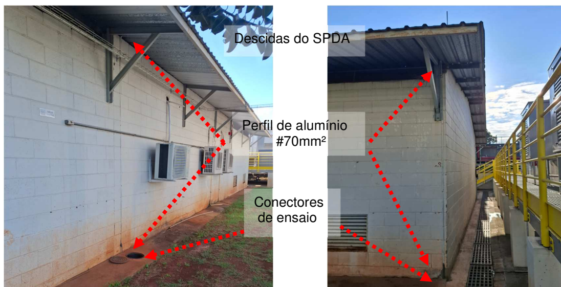
Figuras 46 e 47: Sistema de descidas existentes.
