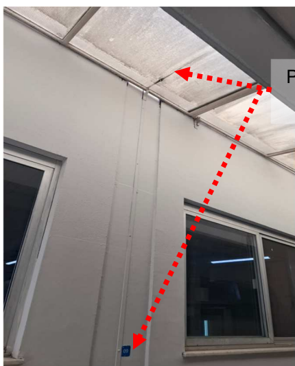
Figuras 186 e 187: Descida do SPDA em perfil de alumínio.
