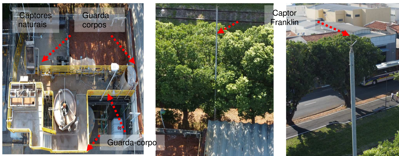
Figuras 59, 60 e 61: Sistema captor existente.
