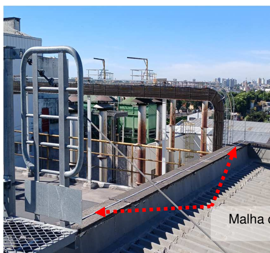
Figuras 408 e 409: Malha captora em perfil de alumínio secção #70mm 2 .
