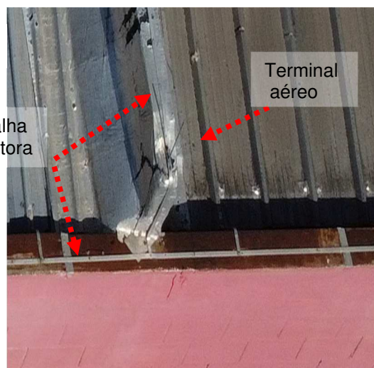
Figuras 03 e 04: Sistema captor existente.
