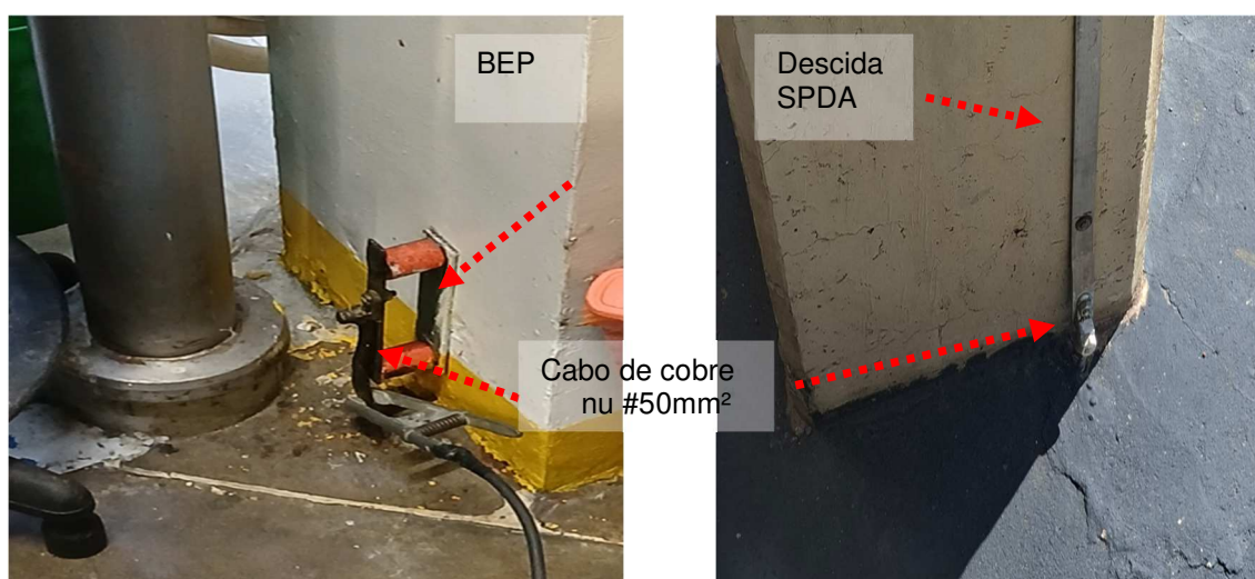
Figuras 576 e 577: Interligação da malha de aterramento com BEP e descida do SPDA.
