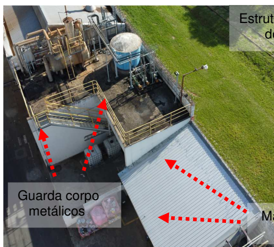
Figuras 310 e 311: Sistema captor existente
