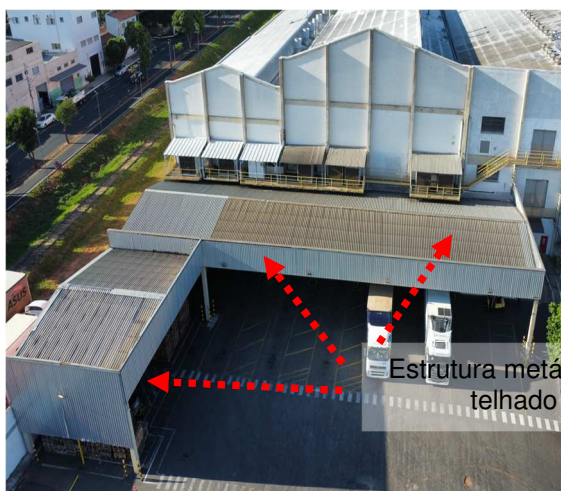
Figuras 532 e 533: Malha captora natural – Estruturas metálicas do telhado.
