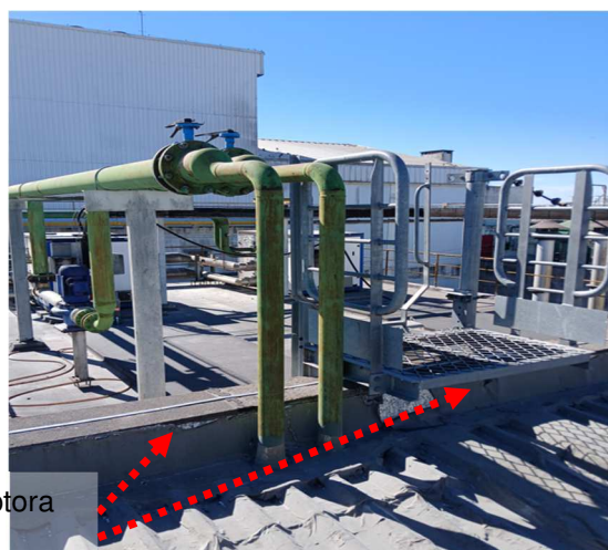
Figuras 406 e 407: Malha captora em perfil de alumínio secção #70mm 2 .
