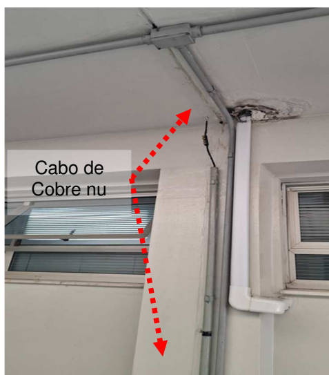
Figuras 188 e 189: Descida do SPDA em cobre nu e perfil de alumínio.
