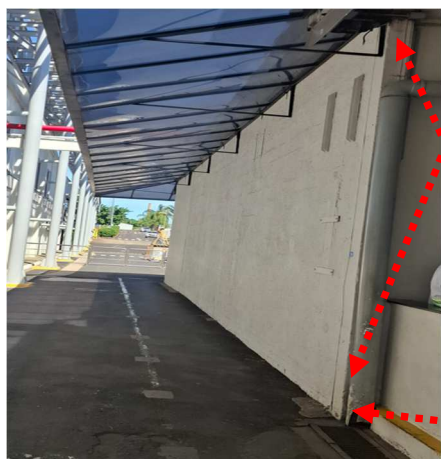
Figuras 190 e 191: Descida do SPDA em perfil de alumínio.
