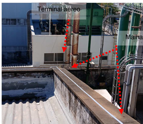
Figuras 420 e 421: Malha captora em perfil de alumínio secção #70mm 2 .
