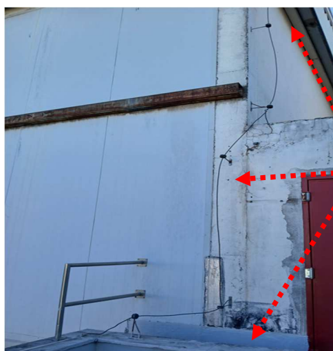
Figuras 382 e 383: Interligação em desnível da altura da malha captora.
