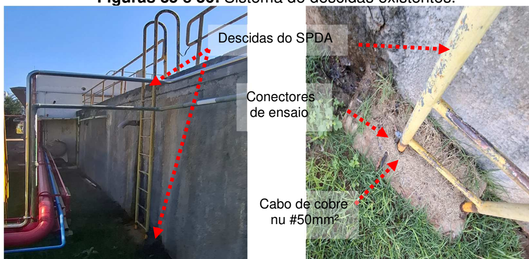
Figuras 37 e 38: Sistema de descidas existentes.
