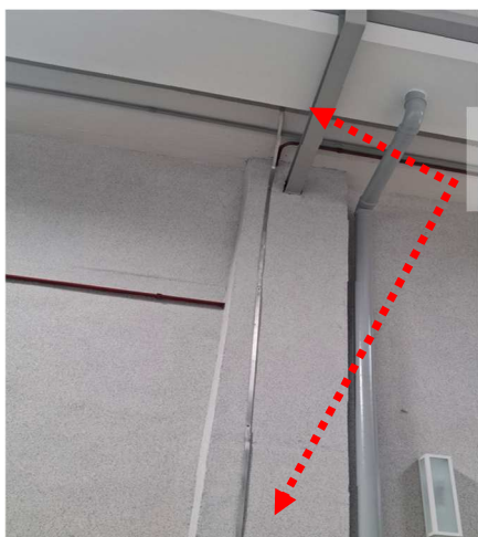
Figuras 184 e 185: Descida do SPDA em perfil de alumínio.
