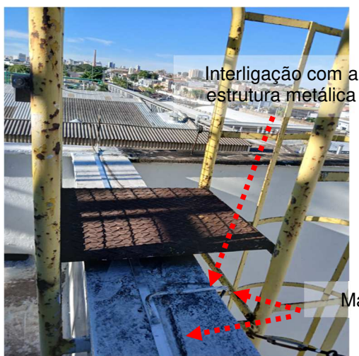
Figuras 392 e 393: Malha captora em perfil de alumio secção #70mm 2 .
