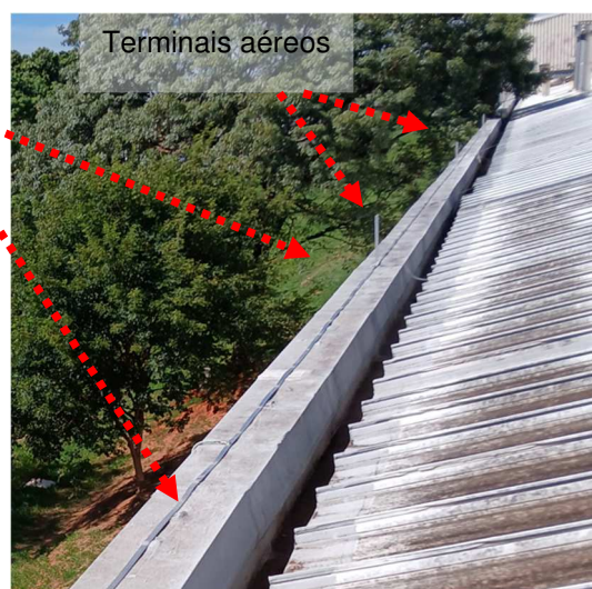
Figuras 500 e 501: Malha captora em perfil de alumínio secção #70mm 2 .
