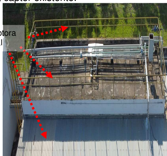
Figuras 20 e 21: Sistema captor existente.
