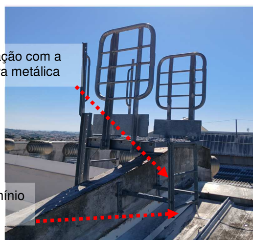
Figuras 514 e 515: Interligação entre o SPDA e estrutura metálica.
