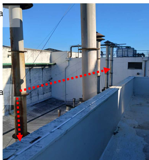
Figuras 390 e 391: Malha captora em perfil de alumio secção #70mm 2 .
