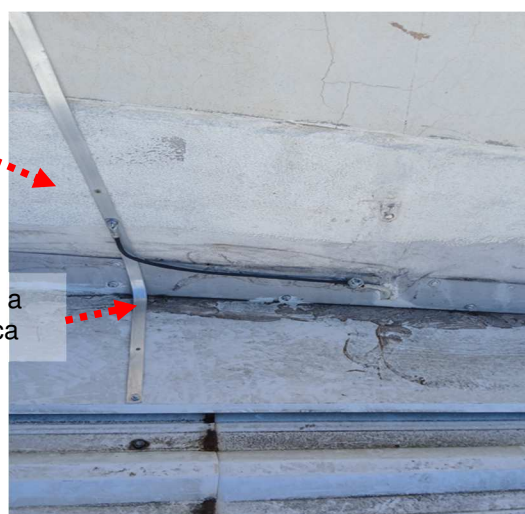
Figuras 486 e 487: Malha captora em perfil de alumínio secção #70mm 2 .
