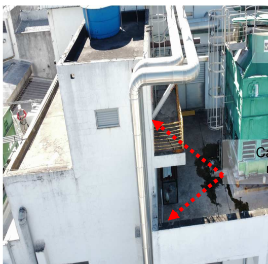
Figuras 528 e 529: Malha captora em cabo de cobre nu secção #35mm 2 .
