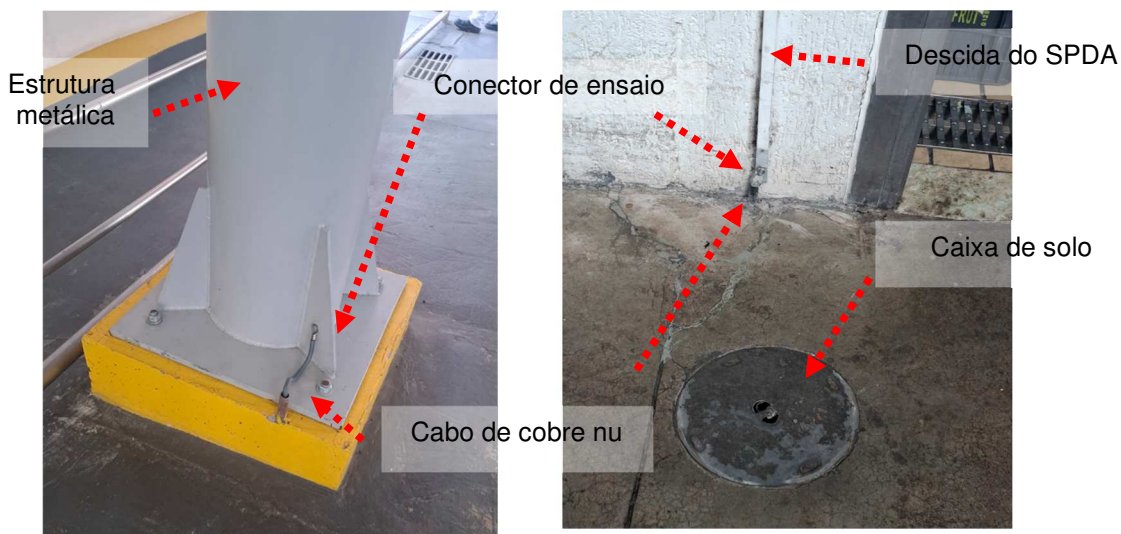
Figuras 208 e 209: Caixa de solo / Conexão estrutura.
