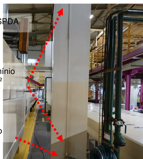
Figuras 556 e 557: Descidas existentes área da Fábrica.
