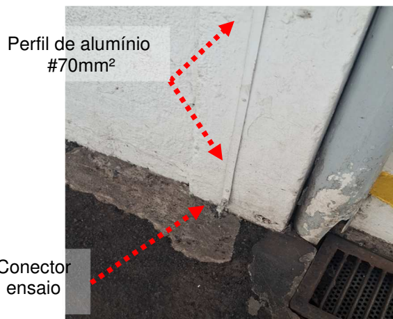
Figuras 190 e 191: Descida do SPDA em perfil de alumínio.
