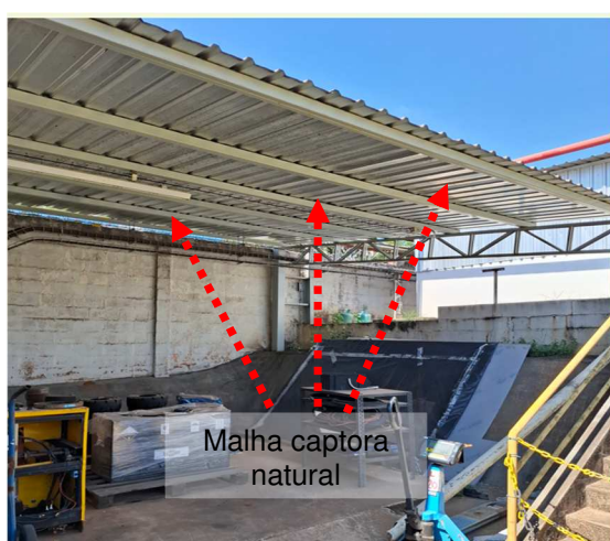
Figuras 244 e 245: Sistema captor existente .
