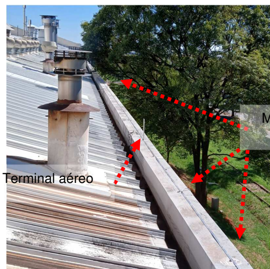
Figuras 506 e 507: Malha captora em perfil de alumínio seção #70mm 2 .
