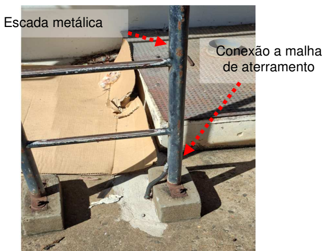
Figuras 30 e 31: Sistema de aterramento.
