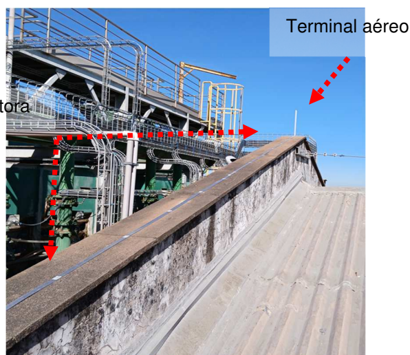
Figuras 420 e 421: Malha captora em perfil de alumínio secção #70mm 2 .
