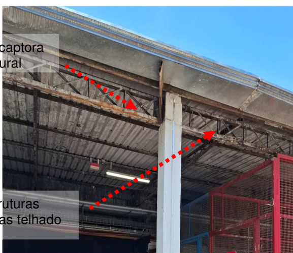
Figuras 371 e 372: Terminal aéreo // Sistema captor natural existente.
