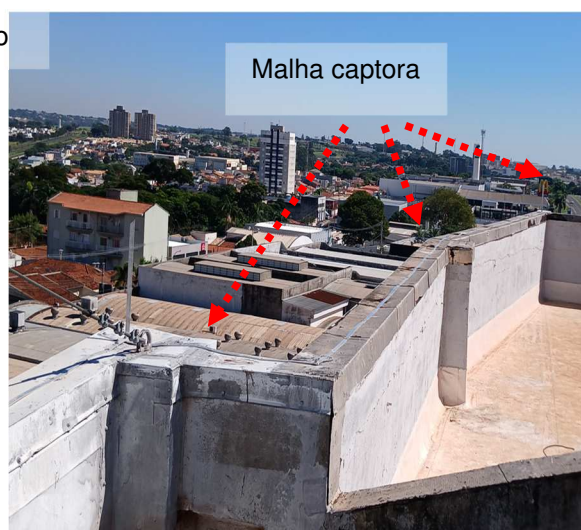
Figuras 476 e 477: Malha captora em perfil de alumínio secção #70mm 2 .
