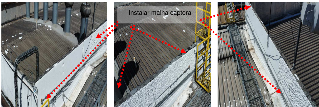
Figuras 148, 149 e 150: Trechos projetados não constam na planta de captação //refazer.
