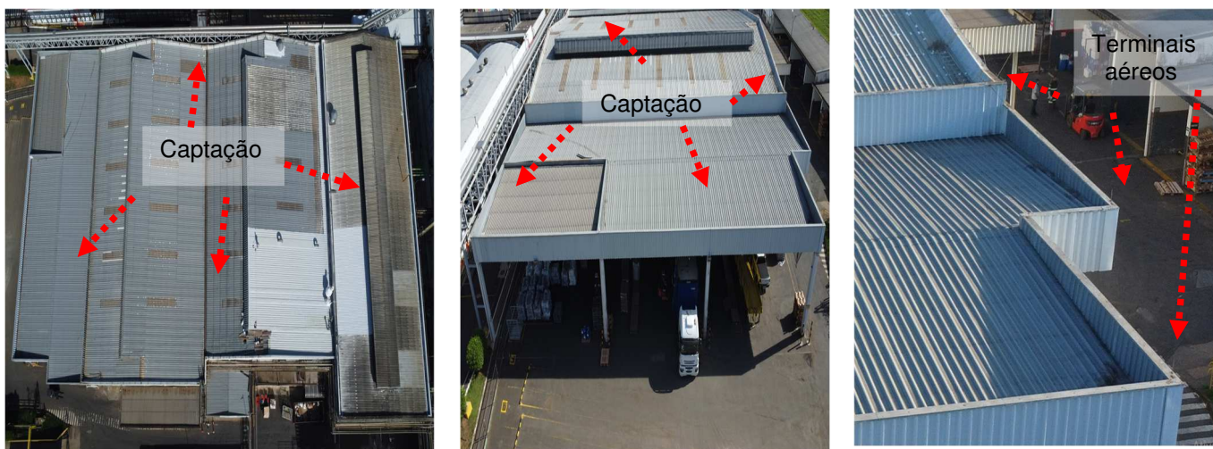
Figuras 76, 77 e 78: Sistema captor existente.
