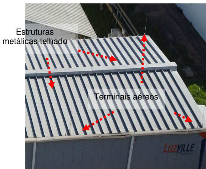
Figuras 622 e 623: Sistema captor existente / Novo Schiller.
