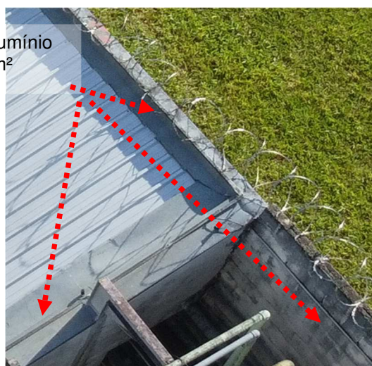
Figuras 312 e 313: Sistema captor existente
