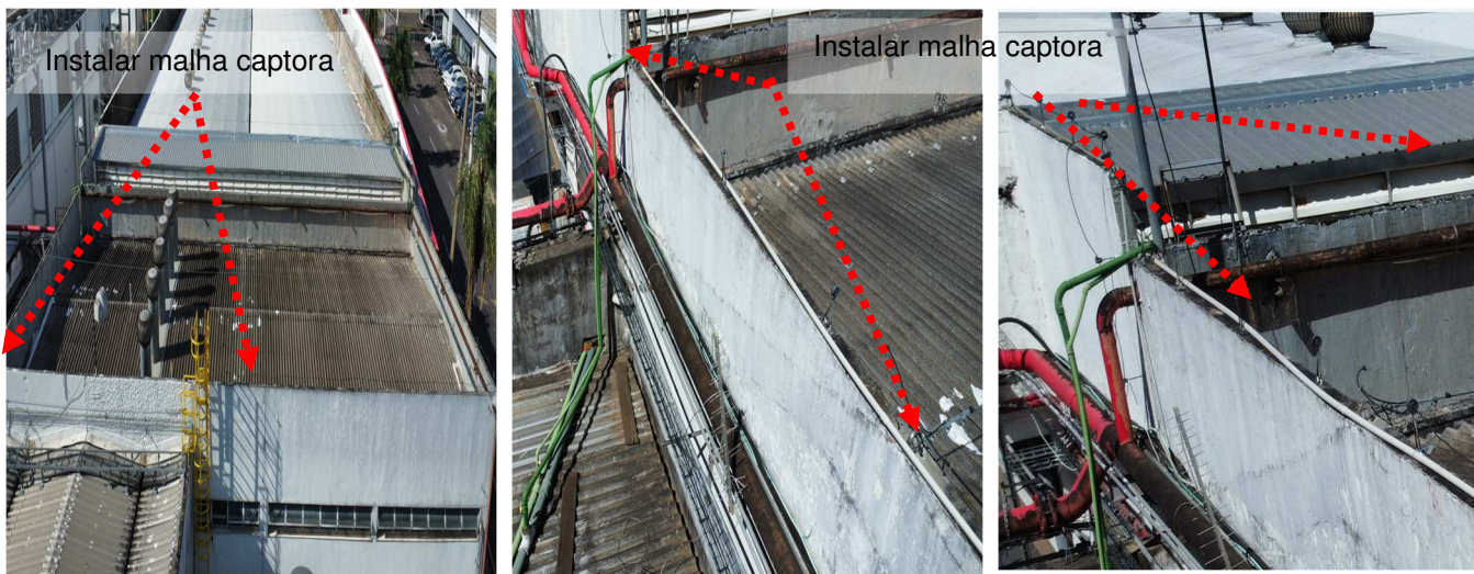
Figuras 145, 146 e 147: Trechos projetados não constam na planta de captação //refazer.
