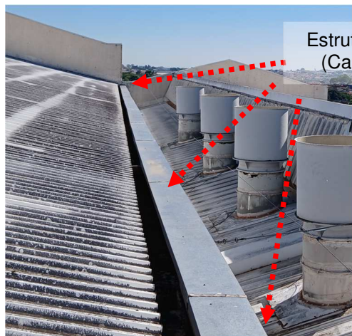
Figuras 508 e 509: Malha captora natural - (Capas de muro metálicas).
