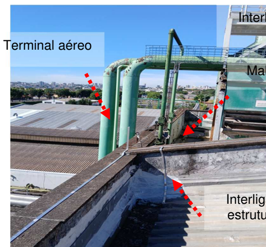
Figuras 418 e 419: Malha captora em perfil de alumínio secção #70mm 2 .
