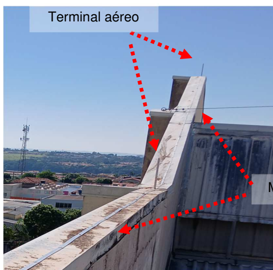
Figuras 482 e 483: Malha captora em perfil de alumínio secção #70mm 2 .
