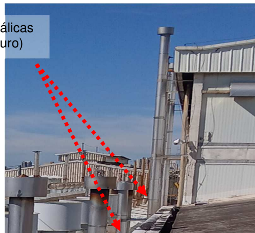
Figuras 508 e 509: Malha captora natural - (Capas de muro metálicas).
