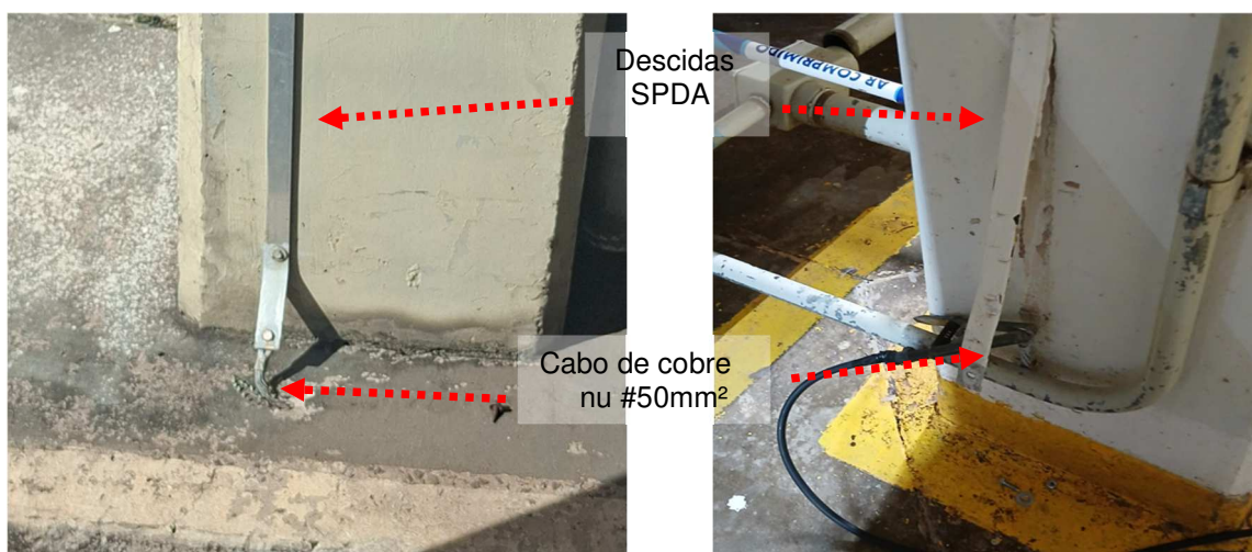
Figuras 578 e 579: Interligação da malha de aterramento com as descidas do SPDA.
