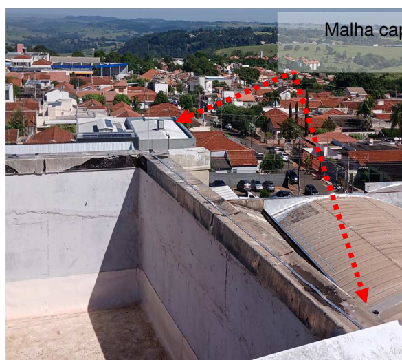
Figuras 480 e 481: Malha captora em perfil de alumínio secção #70mm 2 .
