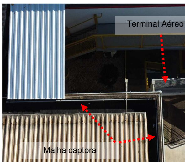
Figuras 333 e 334: Sistema captor existente
