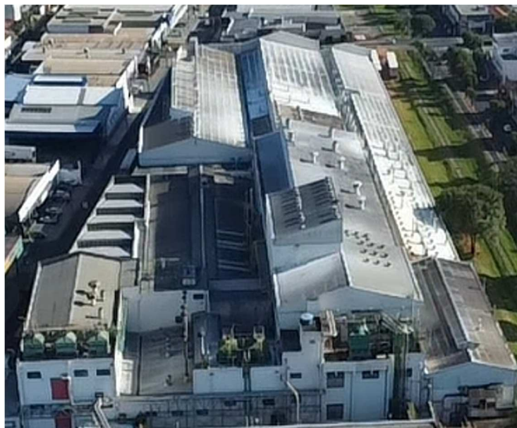
Figura 379: Fabrica - Bloco Geral
