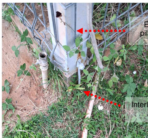
Figuras 265 e 266: Sistema de descidas natural existente
