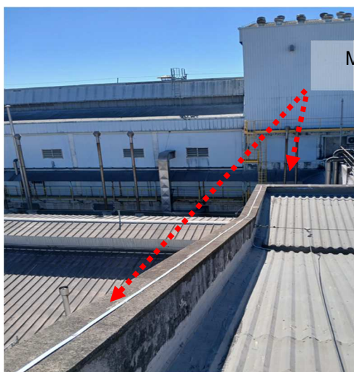
Figuras 404 e 405: Malha captora em perfil de alumínio secção #70mm 2 .
