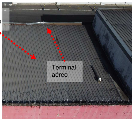
Figuras 367 e 368: Sistema captor natural existente / Terminal aéreo.
