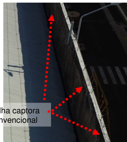
Figuras 161, 162 e 163: Sistema captor existente.
