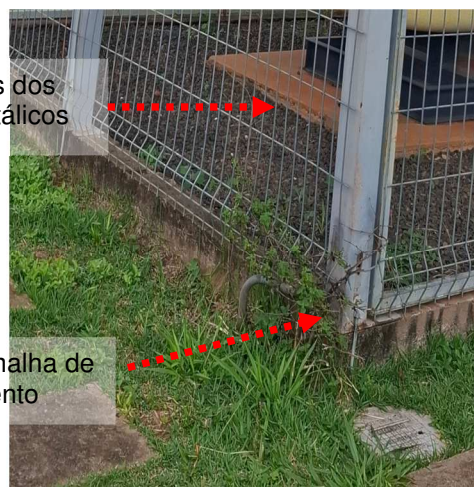
Figuras 265 e 266: Sistema de descidas natural existente
