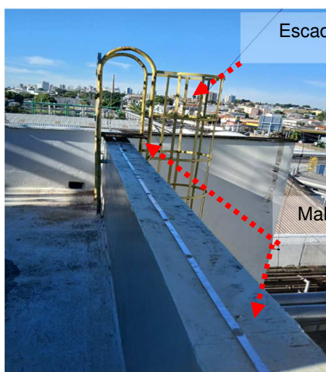
Figuras 390 e 391: Malha captora em perfil de alumio secção #70mm 2 .
