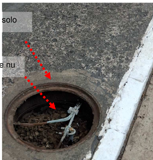
Figuras 140 e 141: Conexões entre a malha de terra e caixas de solo.
