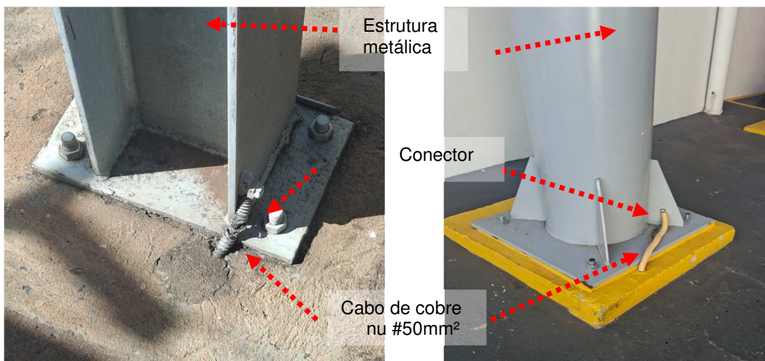
Figuras 566 e 567: Interligação da malha de aterramento com estrutura metálica.
