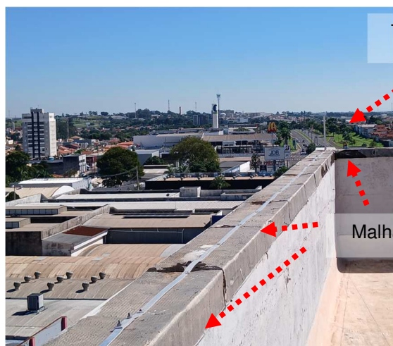
Figuras 478 e 479: Malha captora em perfil de alumínio secção #70mm 2 .
