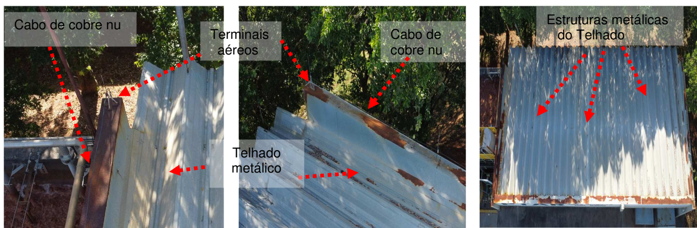
Figuras 56, 57 e 58: Sistema captor existente.
