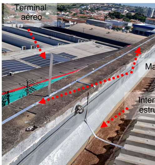
Figuras 398 e 399: Malha captora em perfil de alumínio secção #70mm 2 .
