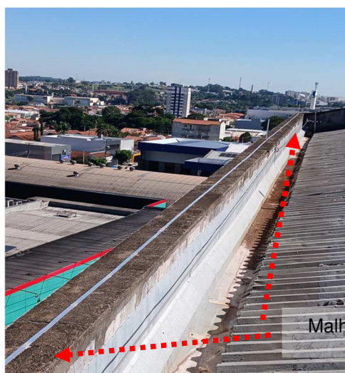
Figuras 396 e 397: Malha captora em perfil de alumio secção #70mm 2 .
