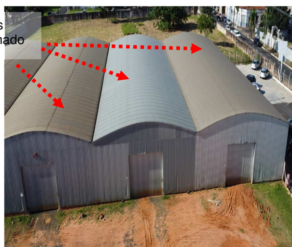
Figuras 589 e 590: Sistema captor natural existente / Galpões novos.
