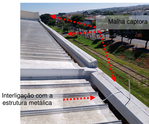
Figuras 500 e 501: Malha captora em perfil de alumínio secção #70mm 2 .
