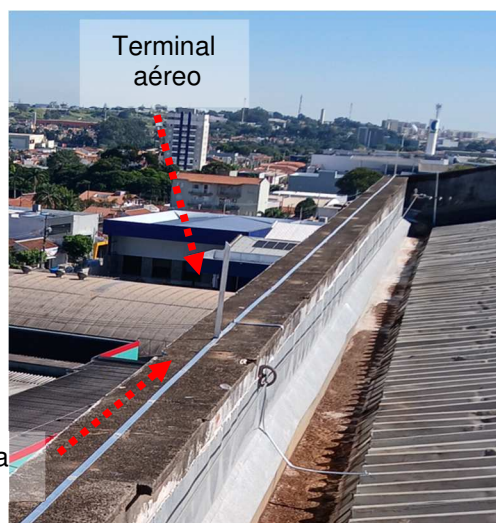
Figuras 396 e 397: Malha captora em perfil de alumio secção #70mm 2 .
