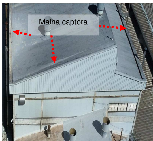
Figuras 520 e 521: Malha captora em cabo de cobre nu secção #35mm 2 .
