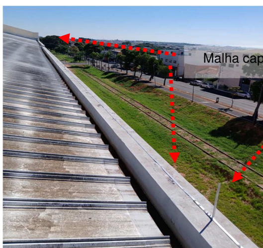
Figuras 502 e 503: Malha captora em perfil de alumínio secção #70mm 2 .
