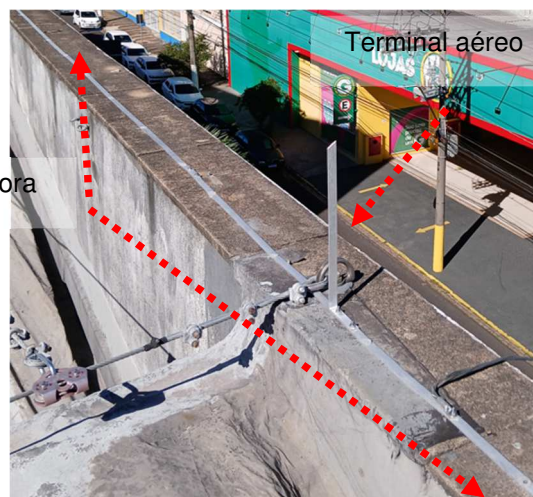
Figuras 442 e 443: Malha captora em perfil de alumínio seção #70mm².
