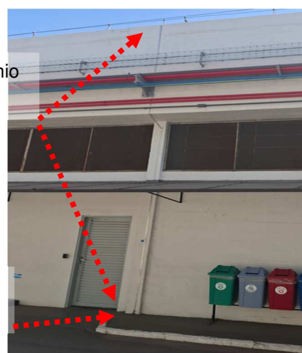
Figuras 192 e 193: Descida do SPDA em perfil de alumínio.
