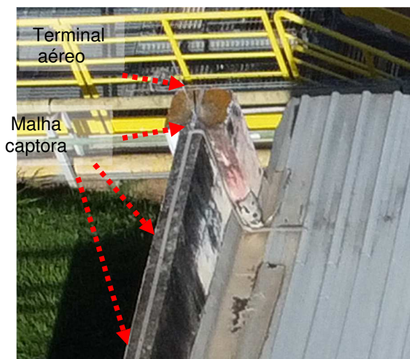
Figuras 22 e 23: Sistema captor existente.
