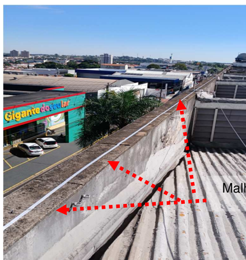
Figuras 440 e 441: Malha captora em perfil de alumínio seção #70mm².
