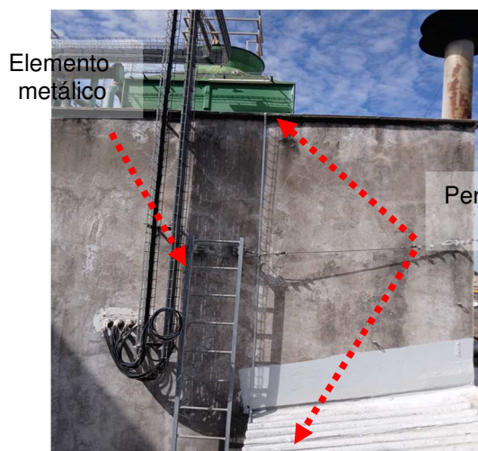
Figuras 380 e 381: Interligação em desnível da altura da malha captora.
