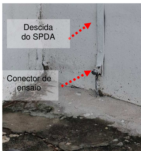
Figuras 30 e 31: Sistema de aterramento.
