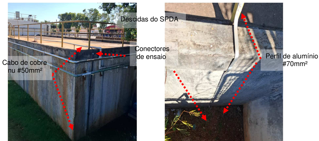
Figuras 35 e 36: Sistema de descidas existentes.
