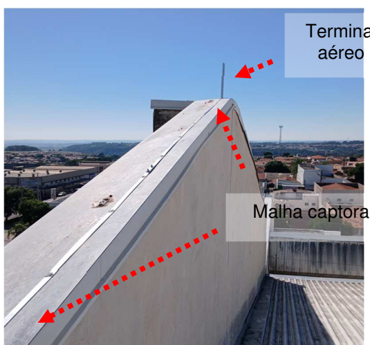
Figuras 484 e 485: Malha captora em perfil de alumínio secção #70mm 2 .
