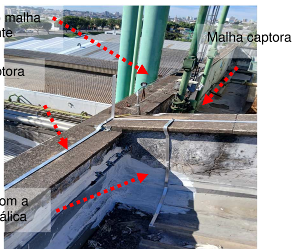
Figuras 418 e 419: Malha captora em perfil de alumínio secção #70mm 2 .
