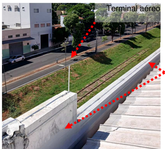
Figuras 496 e 497: Malha captora em perfil de alumínio secção #70mm 2 .
