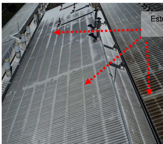
Figuras 538 e 539: Malha captora natural – Estruturas metálicas do telhado.
