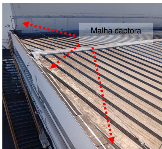
Figuras 460 e 461: Malha captora em perfil de alumínio seccão #70mm².
