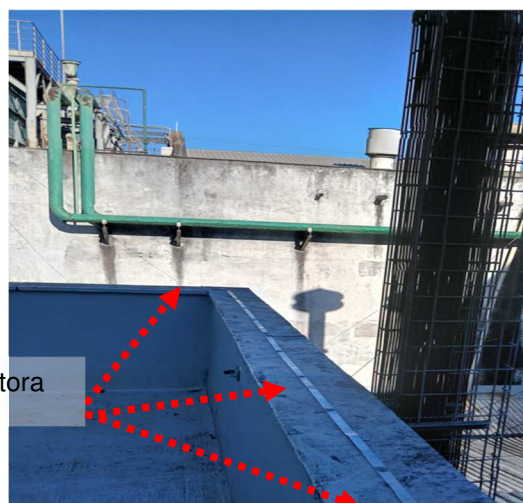
Figuras 386 e 387: Malha captora em perfil de alumio secção #70mm 2 .
