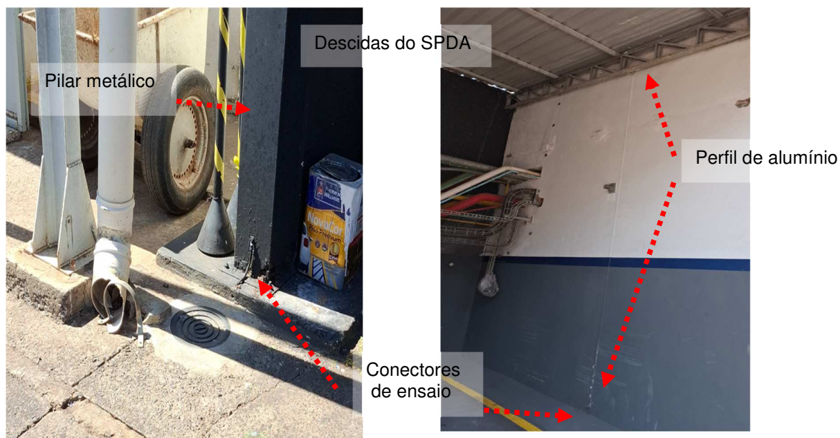
Figuras 289 e 290: Sistema de descidas / Natural e em perfil de alumínio existentes.
