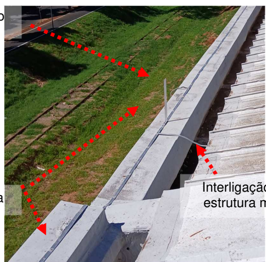
Figuras 498 e 499: Malha captora em perfil de alumínio secção #70mm 2 .
