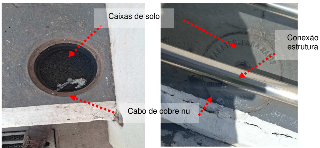
Figuras 202 e 203: Caixa de solo / Conexão estrutura.
