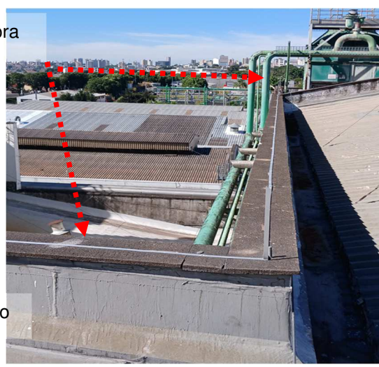
Figuras 414 e 415: Malha captora em perfil de alumínio secção #70mm 2 .
