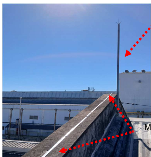
Figuras 402 e 403: Malha captora em perfil de alumínio secção #70mm 2 .
