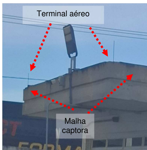
Figuras 348 e 349: Sistema captor existente -Vestiários
