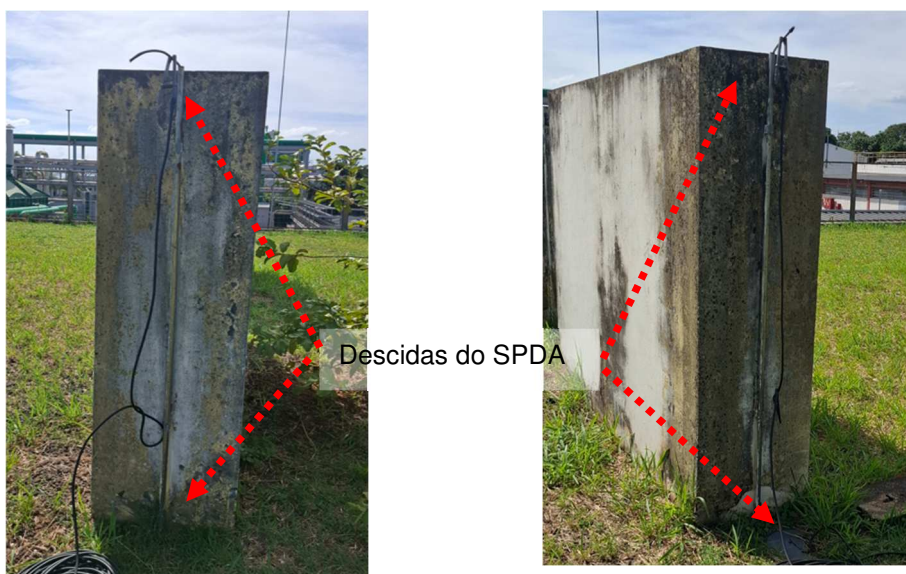
Figuras 278 e 279: Fotos da área do GLP no momento desta inspeção.
