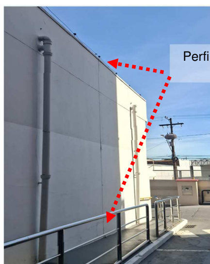
Figuras 188 e 189: Descida do SPDA em cobre nu e perfil de alumínio.
