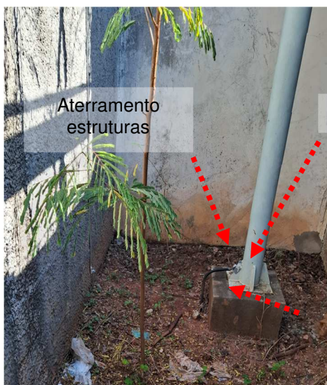
Figuras 41 e 42: Conexões entre a malha de terra com elementos metálicos
