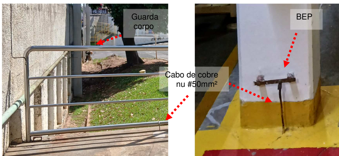
Figuras 572 e 573: Interligação da malha de aterramento com as estruturas.
