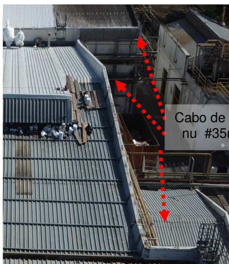
Figuras 103, 104 e 105: Sistema captor existente.
