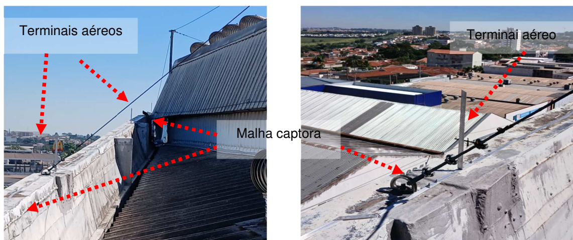
Figuras 472 e 473: Malha captora em perfil de alumínio seção #70mm².
