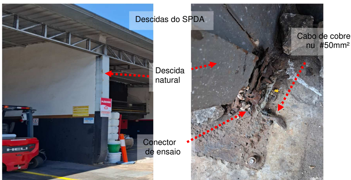
Figuras 291 e 292: Sistema de descidas existentes.
