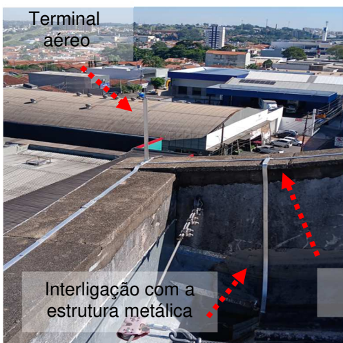
Figuras 400 e 401: Malha captora em perfil de alumínio secção #70mm 2 .
