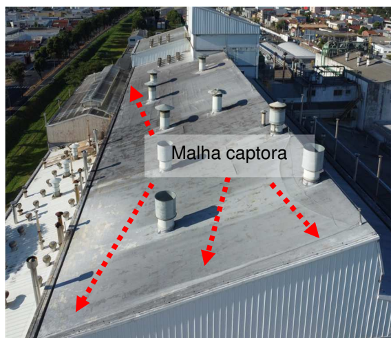
Figuras 520 e 521: Malha captora em cabo de cobre nu secção #35mm 2 .
