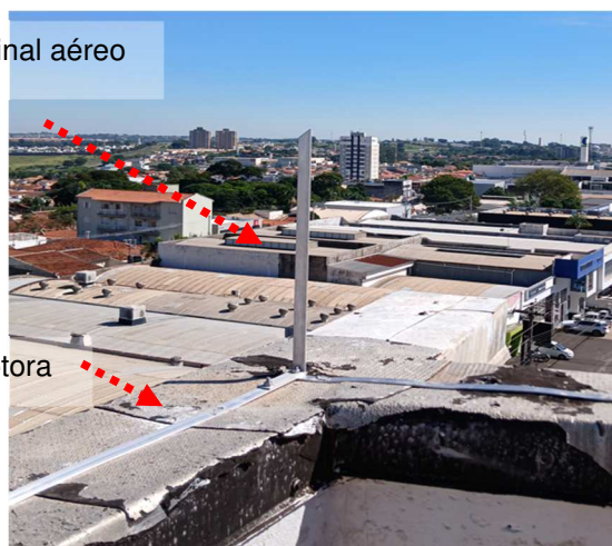
Figuras 478 e 479: Malha captora em perfil de alumínio secção #70mm 2 .
