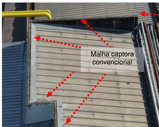
Figuras 242 e 243: Sistema captor existente.
