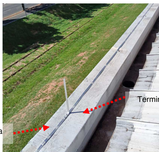
Figuras 504 e 505: Malha captora em perfil de alumínio secção #70mm 2 .
