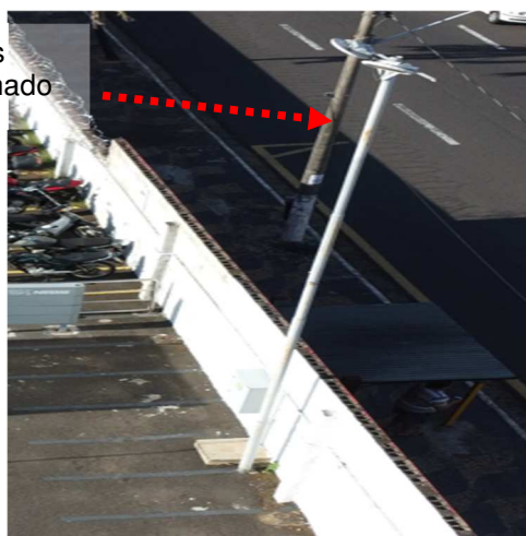
Figuras 659 e 660: Sistema captor existente / Estacionamento / Postes/Totens /Cercas
