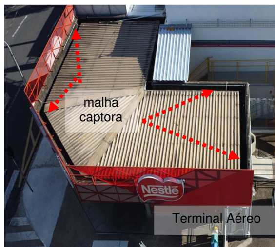
Figuras 327 e 328: Sistema captor existente
