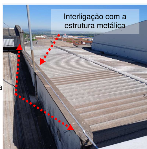
Figuras 456 e 457: Malha captora em perfil de alumínio seção #70mm².
