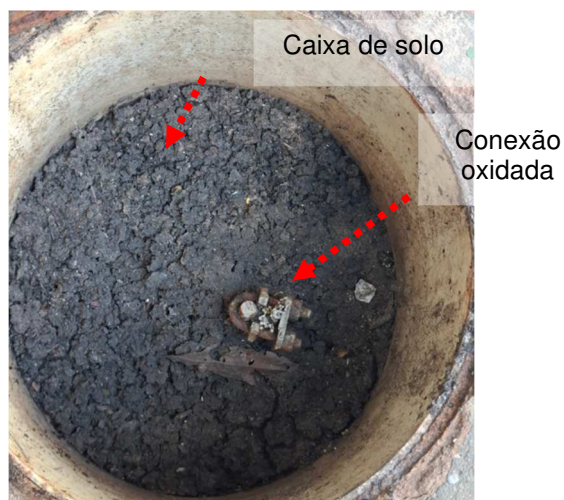
Figuras 142 e 143: Descida rompida com a malha de terra/ Conexão oxidada.
