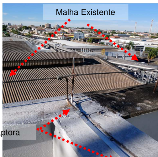
Figuras 392 e 393: Malha captora em perfil de alumio secção #70mm 2 .
