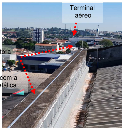
Figuras 398 e 399: Malha captora em perfil de alumínio secção #70mm 2 .
