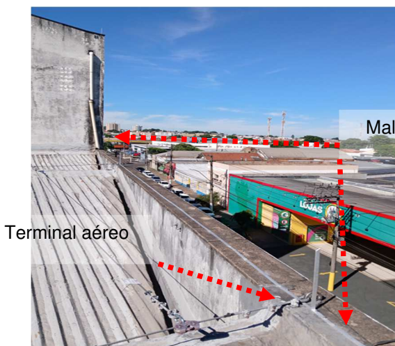
Figuras 442 e 443: Malha captora em perfil de alumínio seção #70mm².
