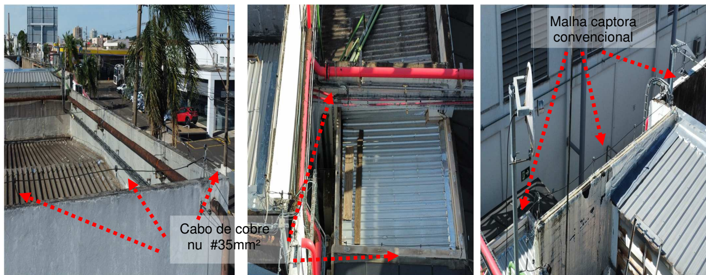
Figuras 179, 180 e 181: Sistema captor existente.
