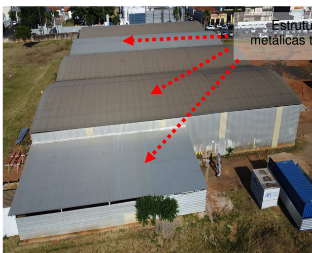
Figuras 589 e 590: Sistema captor natural existente / Galpões novos.
