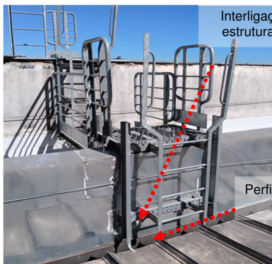
Figuras 512 e 513: Interligação entre o SPDA e estrutura metálica.
