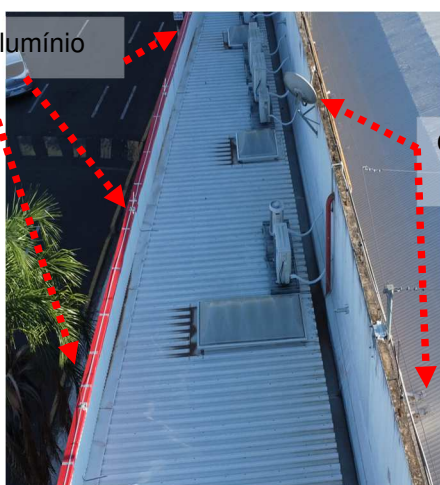
Figuras 176, 177 e 178: Sistema captor existente.
