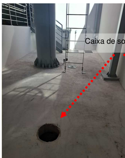
Figuras 216 e 217: Caixa de solo -Conexões obstruídas
