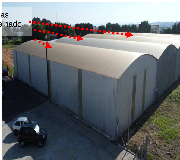
Figuras 591 e 592: Sistema captor natural existente / Galpões novos.
