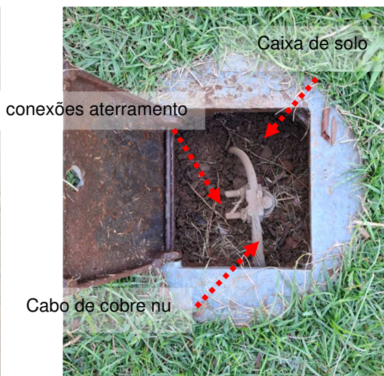
Figuras 41 e 42: Conexões entre a malha de terra com elementos metálicos
