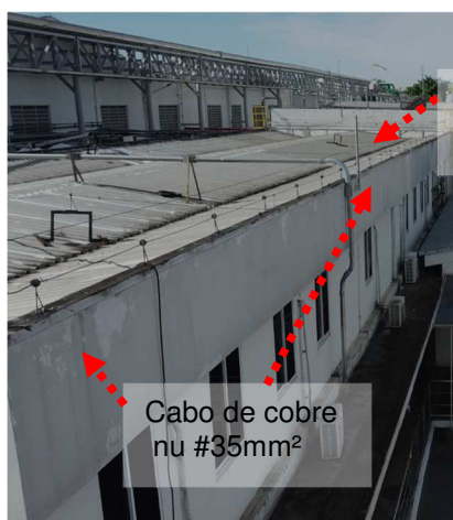
Figuras 167, 168 e 169: Sistema captor existente.
