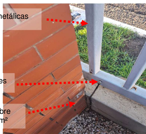
Figuras 683 e 684: Sistema de aterramento existente /Conexões estruturais.
