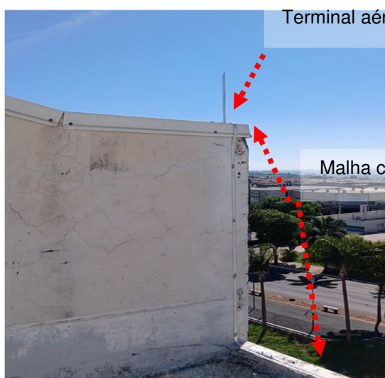
Figuras 494 e 495: Malha captora em perfil de alumínio secção #70mm 2 .
