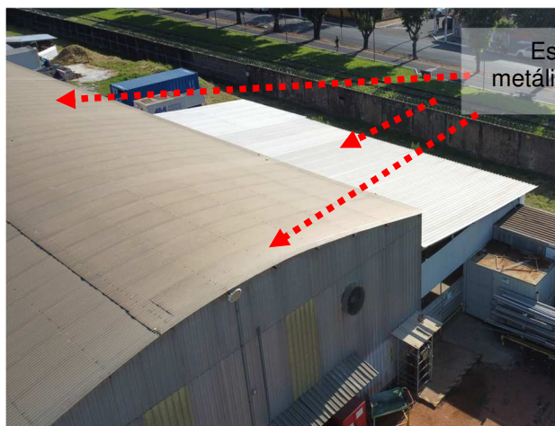
Figuras 593 e 594: Sistema captor natural existente / Galpões novos.
