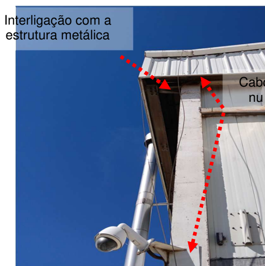
Figuras 510 e 511: Interligação em desnível de altura da malha captora.
