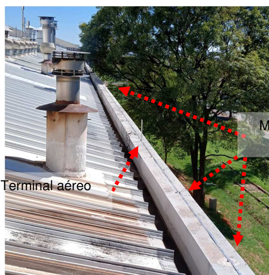
Figuras 144 e 145: Malha captora construída em perfil de alumínio seção #70mm².
