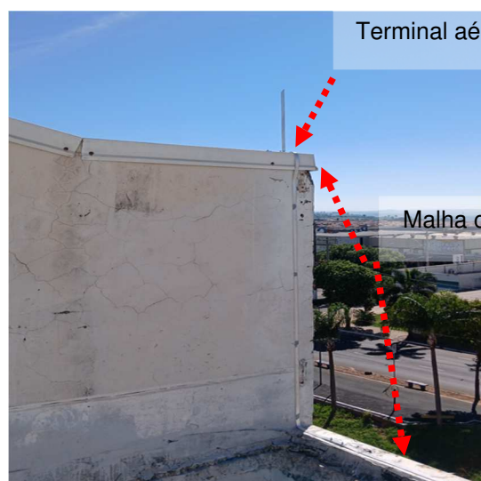
Figuras 132 e 133: Malha captora construída em perfil de alumínio secção #70mm 2 .
