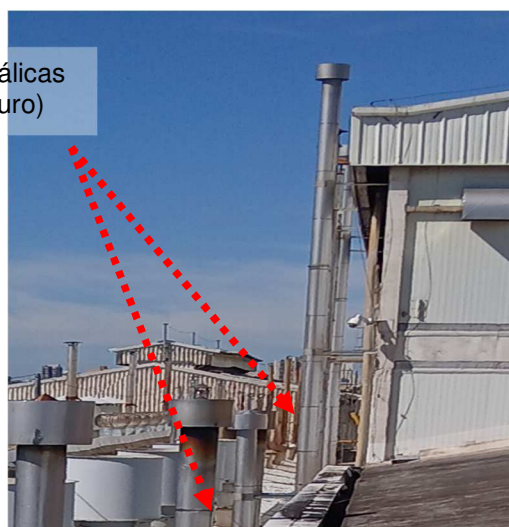
Figuras 146 e 147: Malha captora natural - (Capas de muro metálicas).
