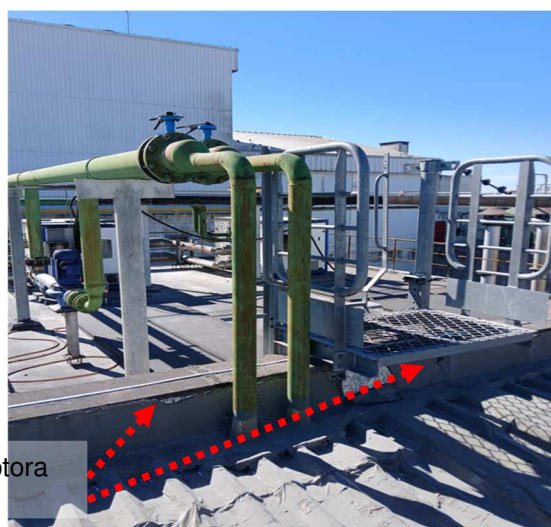
Figuras 44 e 45: Malha captora construída em perfil de alumínio secção #70mm 2 .
