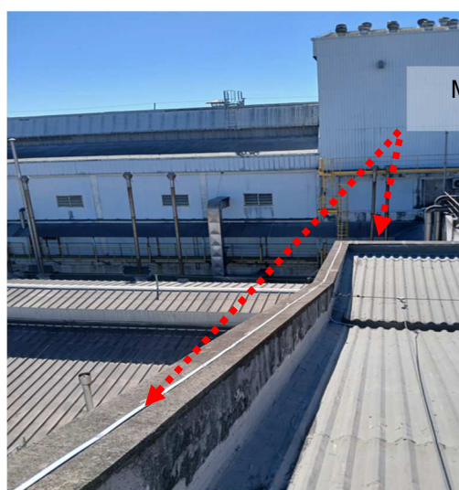
Figuras 42 e 43: Malha captora construída em perfil de alumínio secção #70mm 2 .
