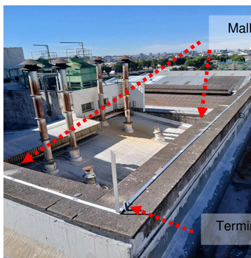
Figuras 52 e 53: Malha captora construída em perfil de alumínio secção #70mm 2 .
