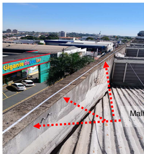
Figuras 78 e 79: Malha captora construída em perfil de alumínio secção #70mm².
