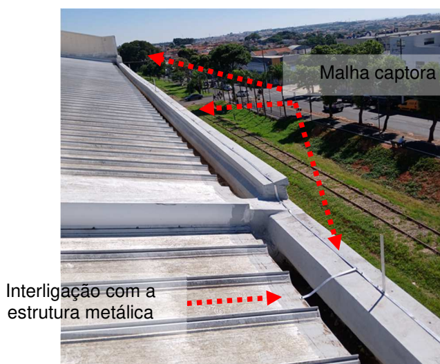
Figuras 138 e 139: Malha captora construída em perfil de alumínio secção #70mm².
