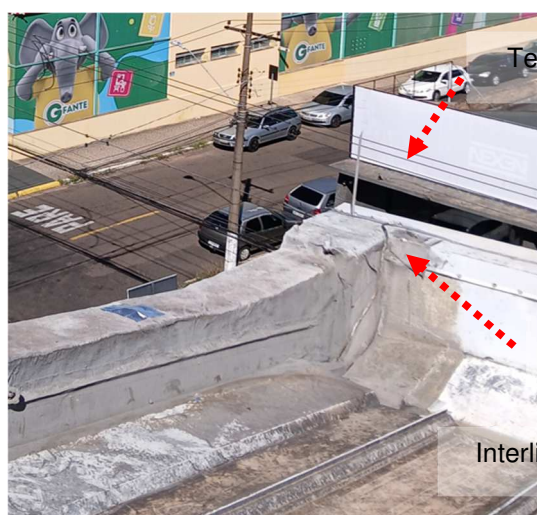
Figuras 106 e 107: Malha captora construída em perfil de alumínio secção #70mm 2 .
