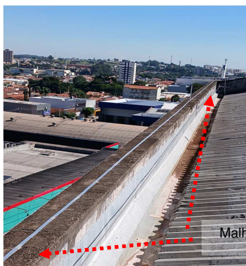
Figuras 34 e 35: Malha captora construída em perfil de alumínio secção #70mm².
