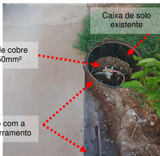
Figuras 03 e 04: Interligação entre a base do pilar do pipe-rack com a malha existente.
