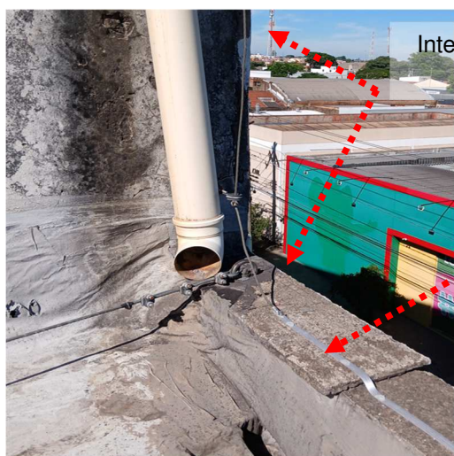
Figuras 76 e 77: Interligação em desnível de altura da malha captora.
