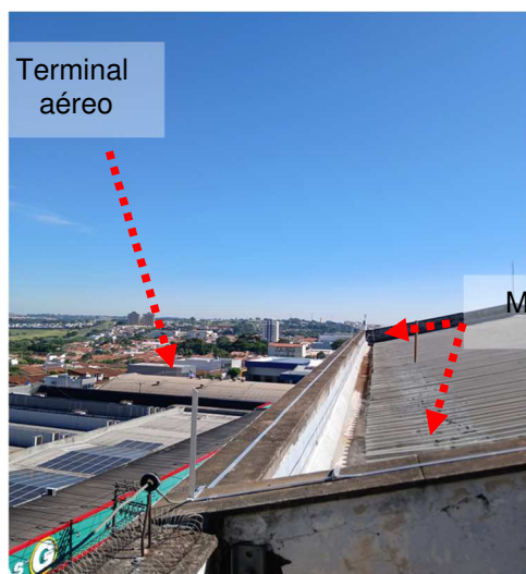
Figuras 32 e 33: Malha captora construída em perfil de alumínio secção #70mm²..
