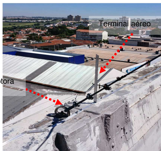
Figuras 110 e 111: Malha captora construída em perfil de alumínio secção #70mm².
