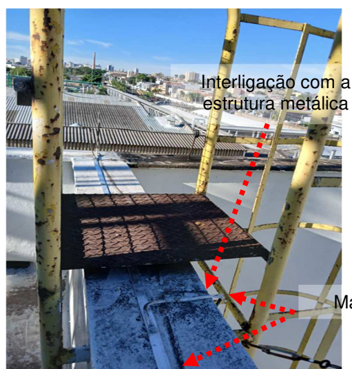
Figuras 30 e 31: Malha captora construída em perfil de alumínio secção #70mm 2 .
