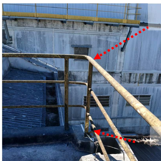
Figuras 64 e 65: Malha captora construída em perfil de alumínio secção #70mm 2 .
