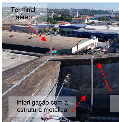
Figuras 38 e 39: Malha captora construída em perfil de alumínio secção #70mm 2 .
