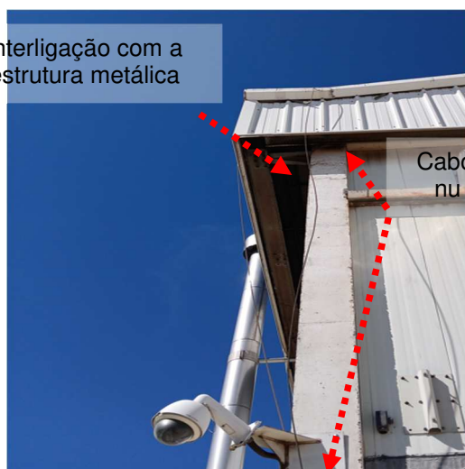
Figuras 148 e 149: Interligação em desnível de altura da malha captora..
