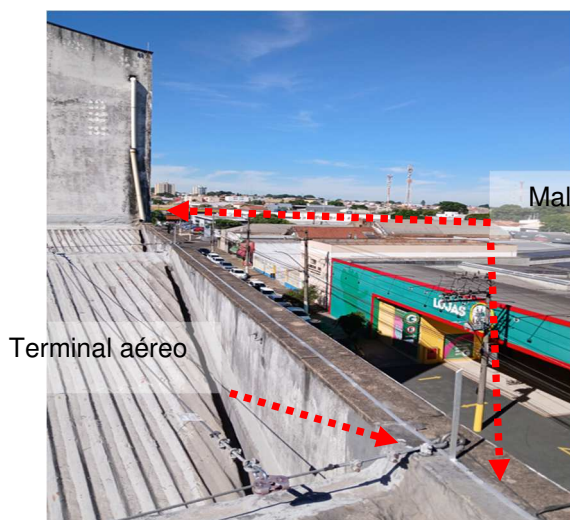
Figuras 80 e 81: Malha captora construída em perfil de alumínio secção #70mm 2 .
