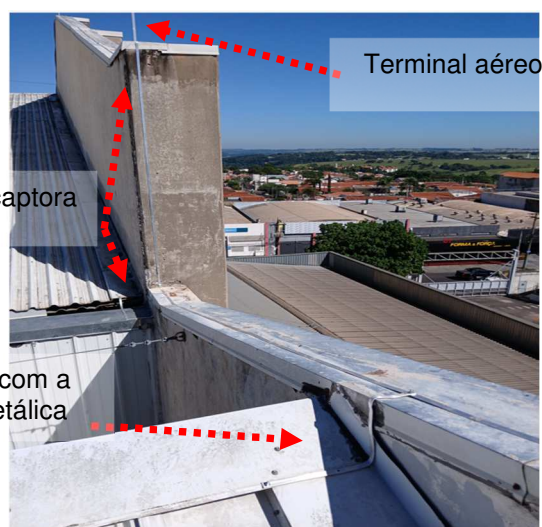
Figuras 128 e 129: Malha captora construída em perfil de alumínio secção #70mm 2 .
