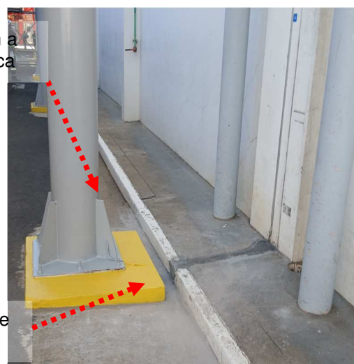
Figuras 13 e 14: Interligação entre a base do pilar do pipe-rack com a malha existente.
