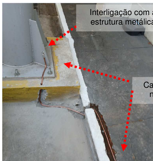
Figuras 11 e 12: Interligação entre a base do pilar do pipe-rack com a malha existente.
