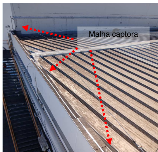
Figuras 98 e 99: Malha captora construída em perfil de alumínio secção #70mm 2 .
