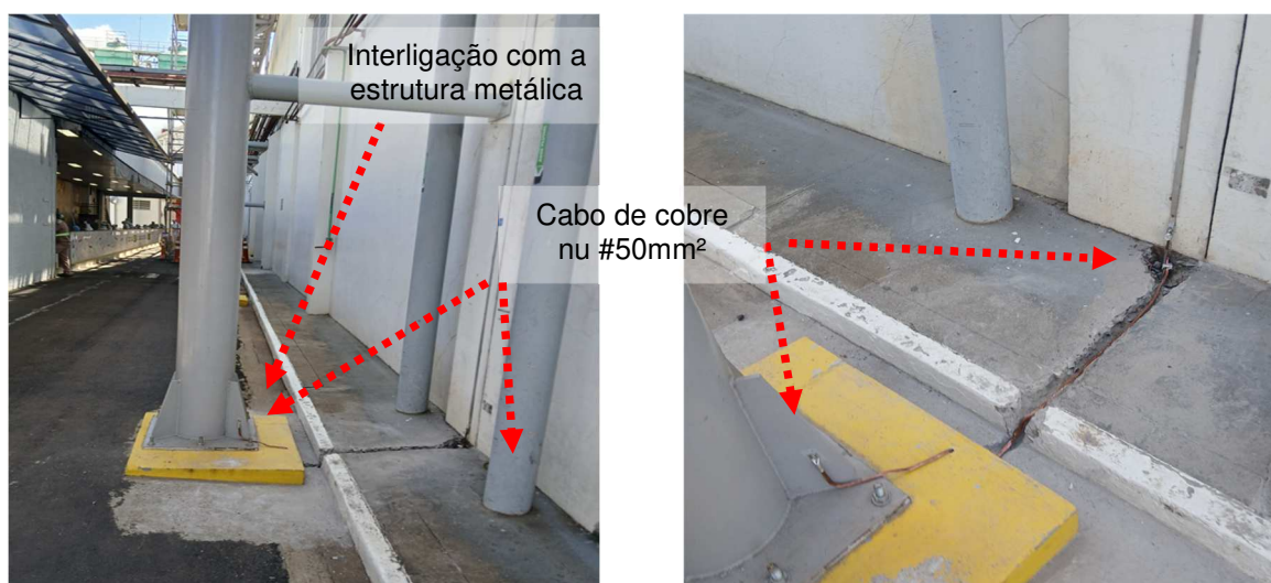
Figuras 07 e 08: Interligação entre a base do pilar do pipe-rack com a malha existente.
