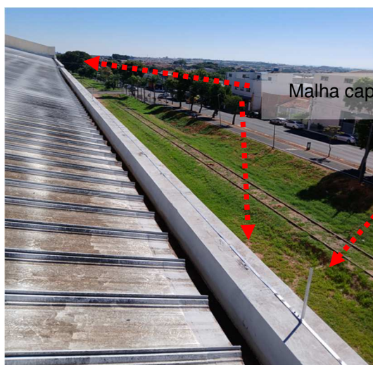
Figuras 140 e 141: Malha captora construída em perfil de alumínio seção #70mm².
