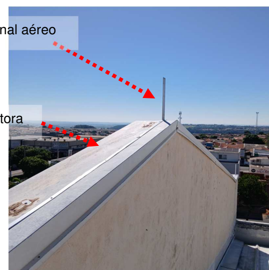
Figuras 130 e 131: Malha captora construída em perfil de alumínio secção #70mm 2 .
