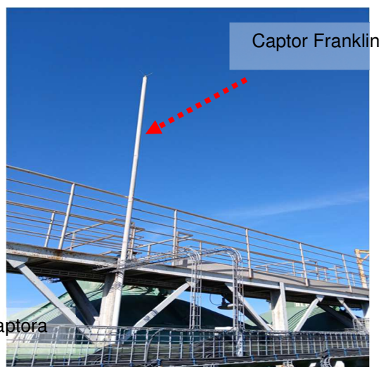
Figuras 62 e 63: Malha captora construída em perfil de alumínio secção #70mm 2 .
