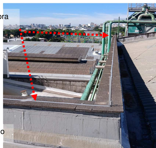
Figuras 52 e 53: Malha captora construída em perfil de alumínio secção #70mm 2 .
