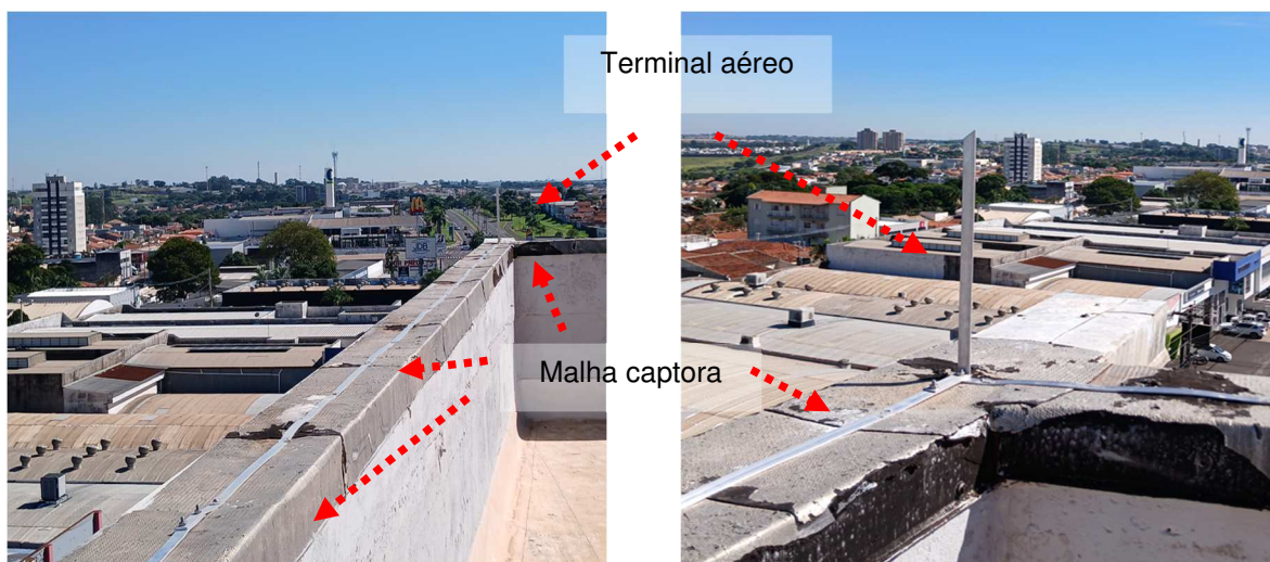
Figuras 116 e 117: Malha captora construída em perfil de alumínio secção #70mm².
