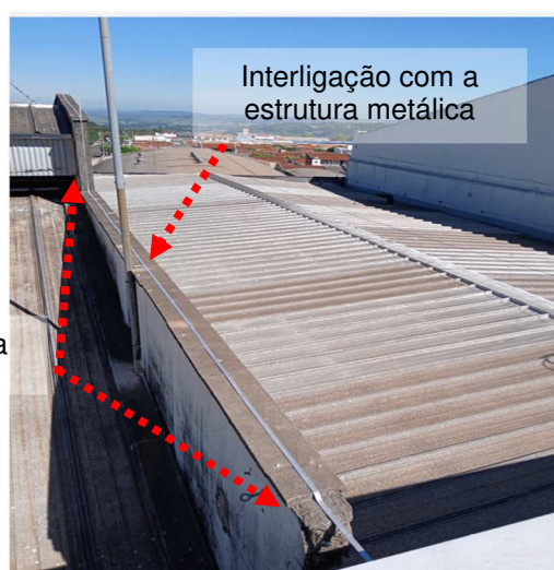
Figuras 94 e 95: Malha captora construída em perfil de alumio secção #70mm 2 .
