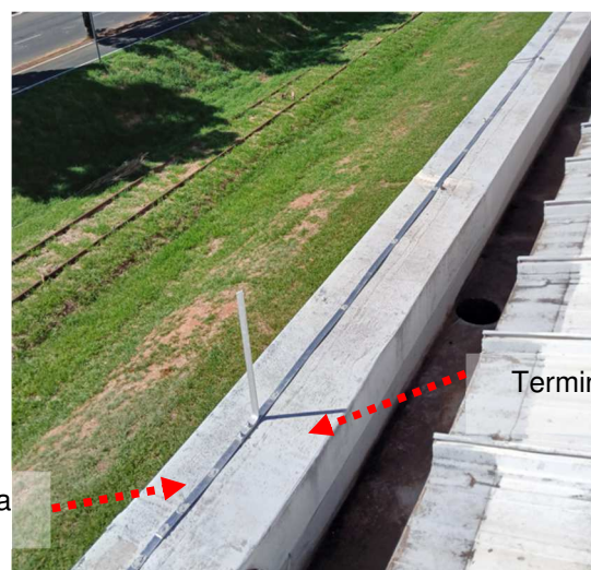
Figuras 142 e 143: Malha captora construída em perfil de alumínio seção #70mm².
