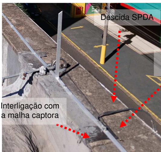
Figuras 158 e 159: Substituição conectores com proteção com galvanizador a frio.
