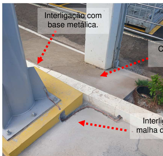
Figuras 03 e 04: Interligação entre a base do pilar do pipe-rack com a malha existente.
