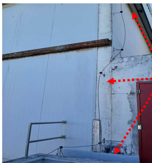
Figuras 20 e 21 Interligação construída em desnível da altura da malha captora.
