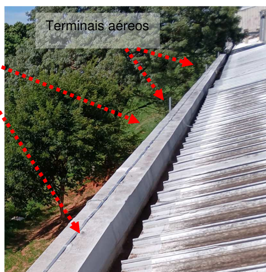
Figuras 138 e 139: Malha captora construída em perfil de alumínio secção #70mm².
