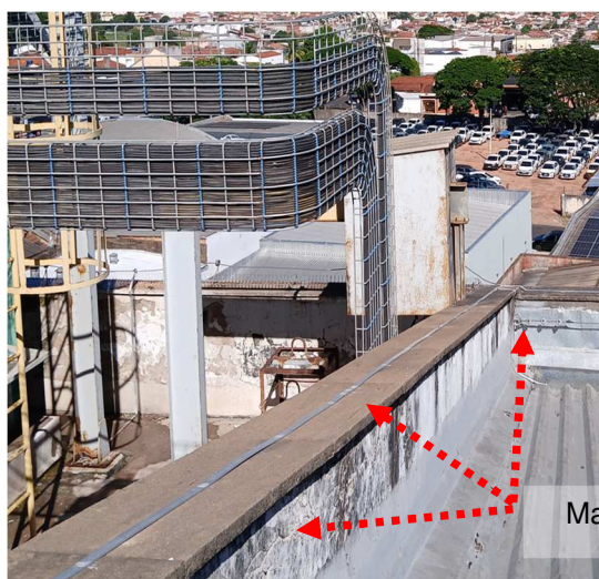
Figuras 62 e 63: Malha captora construída em perfil de alumínio secção #70mm 2 .
