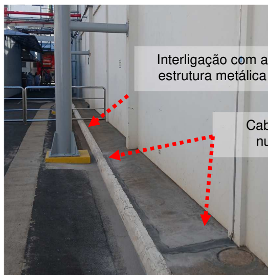
Figuras 15 e 16: Interligação entre a base do pilar do pipe-rack com a malha existente.
