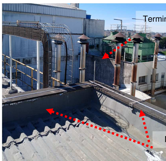
Figuras 50 e 51: Malha captora construída em perfil de alumínio secção #70mm 2 .
