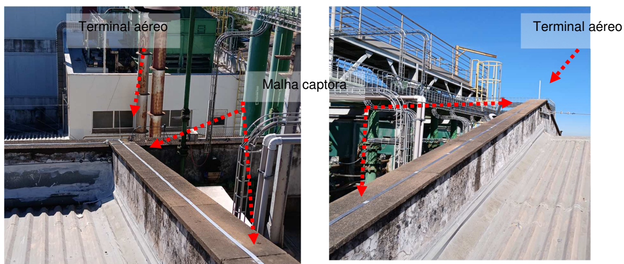
Figuras 58 e 59 Malha captora construída em perfil de alumínio seção #70mm².
