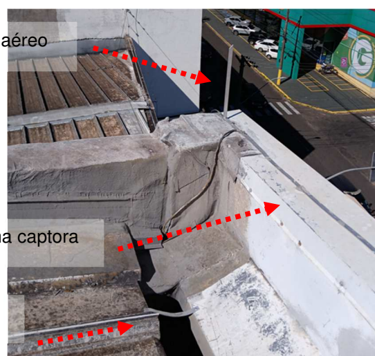
Figuras 106 e 107: Malha captora construída em perfil de alumínio secção #70mm 2 .
