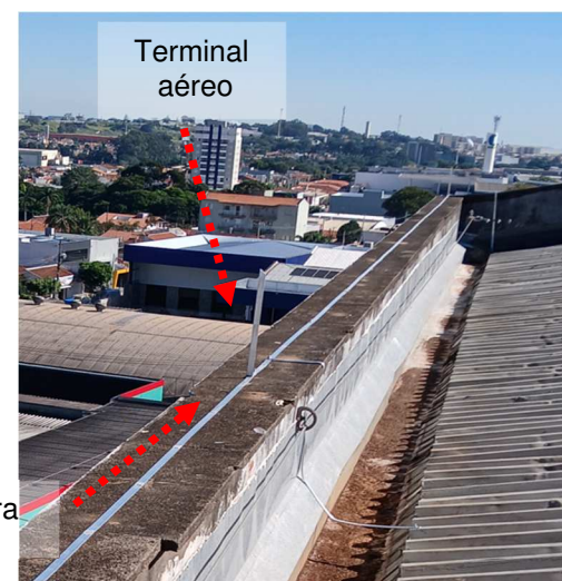
Figuras 34 e 35: Malha captora construída em perfil de alumínio secção #70mm².
