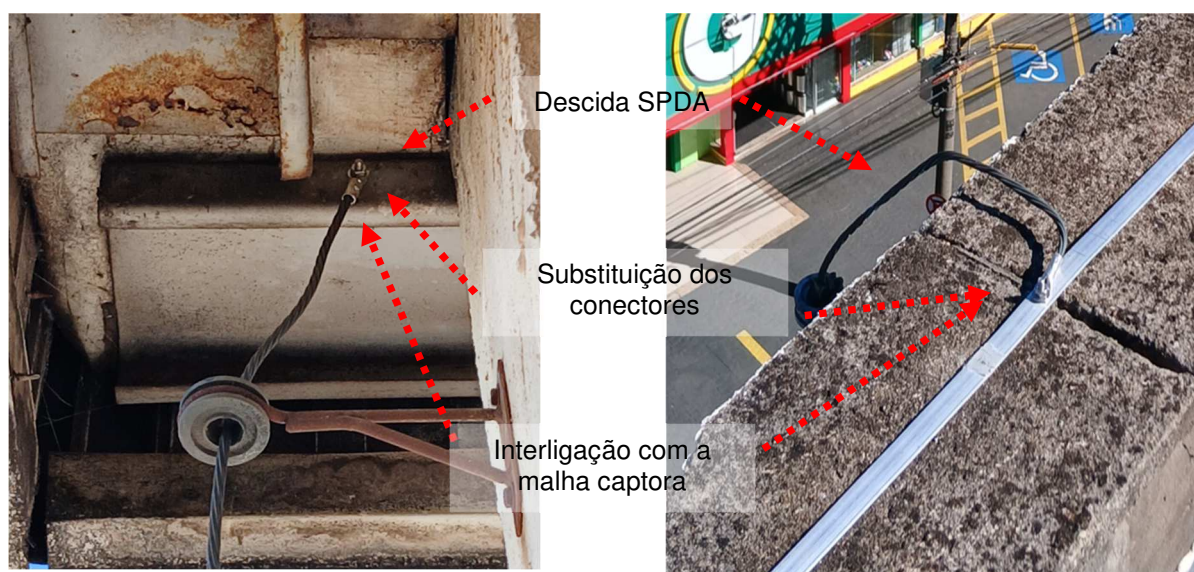
Figuras 154 e 155: Substituição conectores com proteção com galvanizador a frio.
