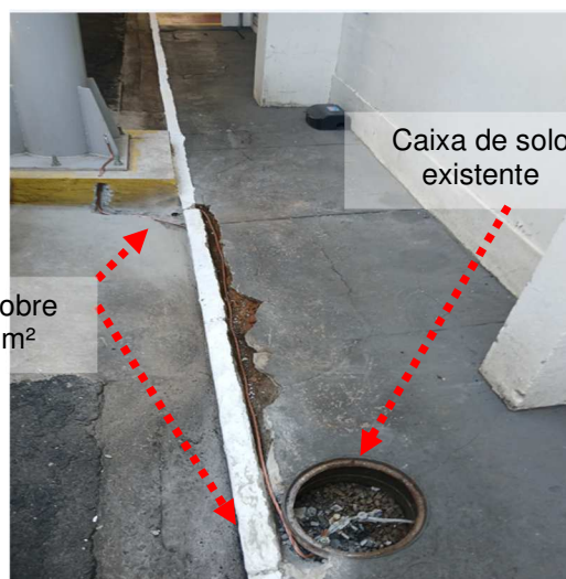
Figuras 11 e 12: Interligação entre a base do pilar do pipe-rack com a malha existente.
