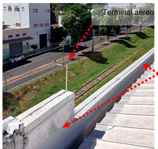
Figuras 134 e 135: Malha captora construída em perfil de alumínio secção #70mm².
