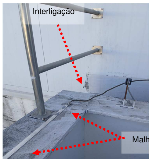
Figuras 22 e 23: Malha captora construída em perfil de alumínio secção #70mm 2 .
