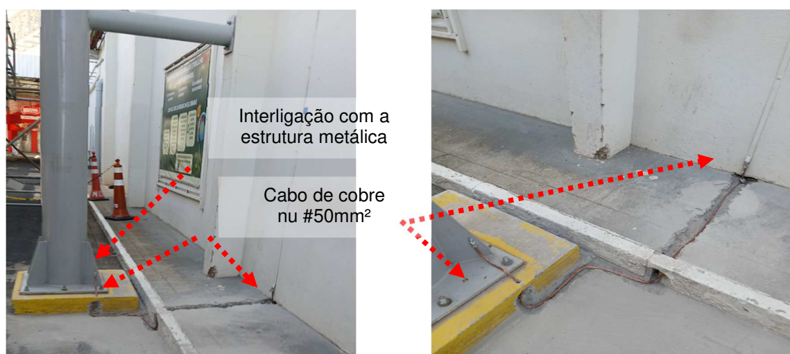
Figuras 09 e 10: Interligação entre a base do pilar do pipe-rack com a malha existente.
