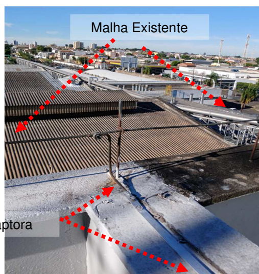
Figuras 30 e 31: Malha captora construída em perfil de alumínio secção #70mm 2 .
