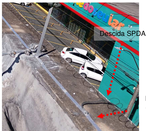
Figuras 160 e 161: Substituição conectores com proteção com galvanizador a frio.
