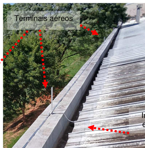
Figuras 140 e 141: Malha captora construída em perfil de alumínio seção #70mm².
