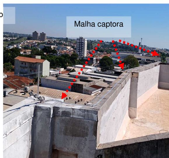
Figuras 114 e 115: Malha captora construída em perfil de valumio secção #70mm².
