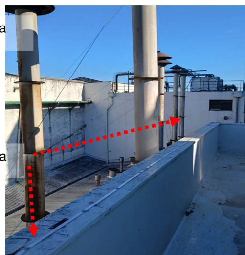
Figuras 28 e 29: Malha captora construída em perfil de alumínio secção #70mm 2 .
