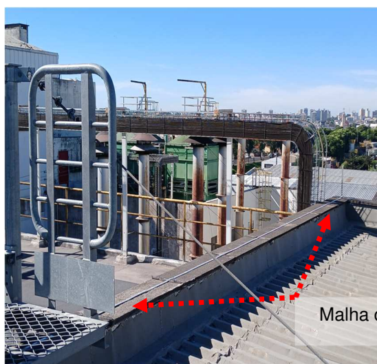
Figuras 46 e 47: Malha captora construída em perfil de alumínio secção #70mm 2 .
